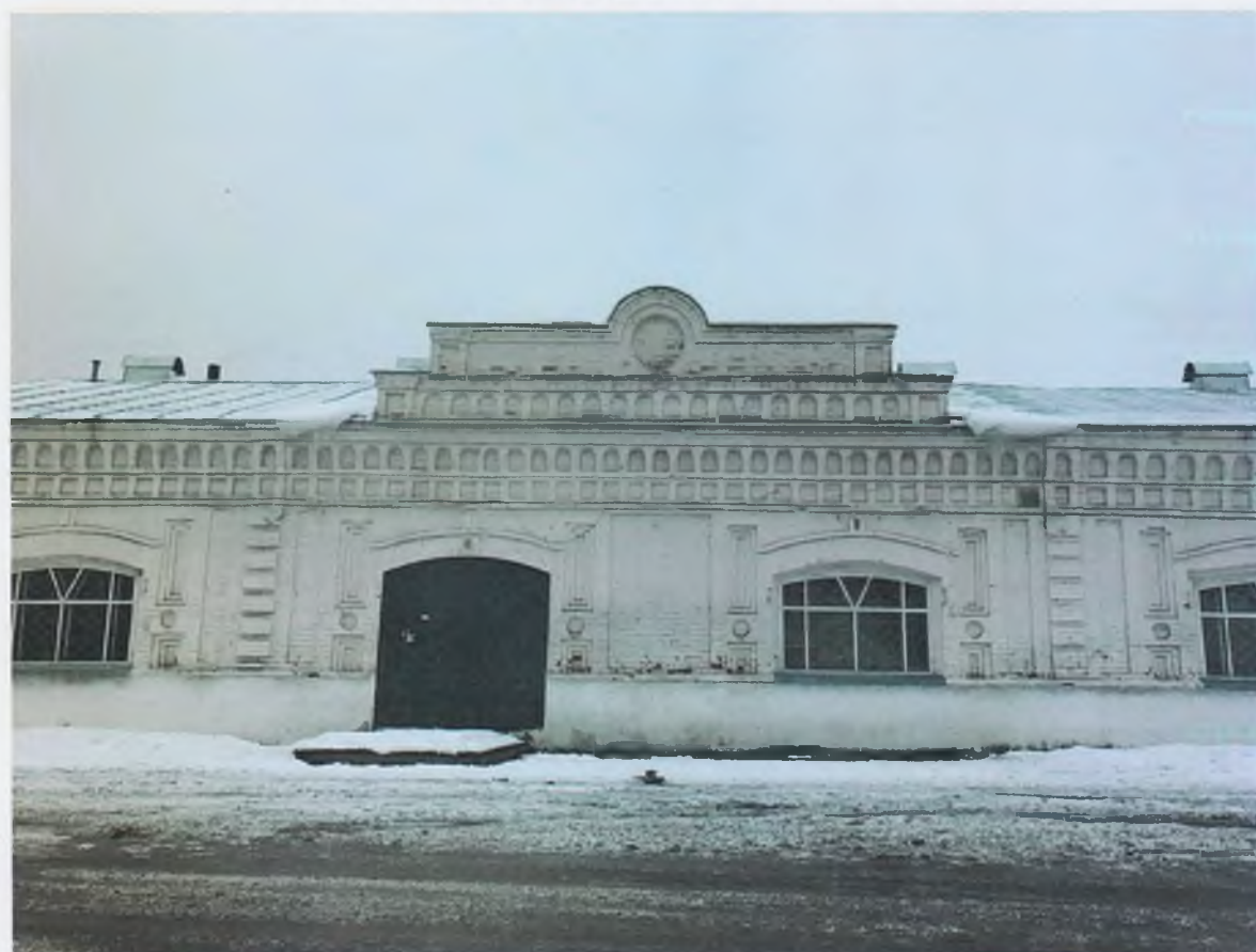
4. Северный корпус торговых рядов. Фрагмент фасада.
