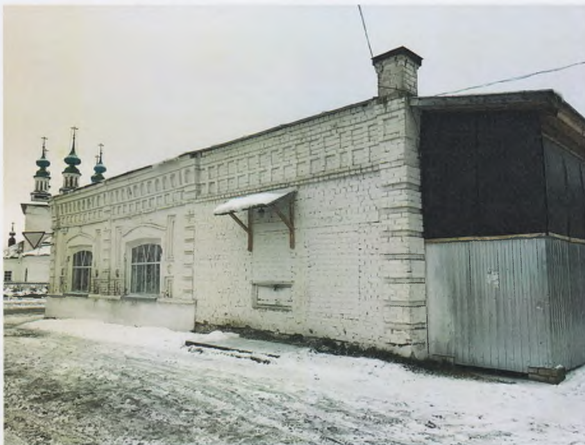
5. Северный корпус торговых рядов. Вид с юго-востока.
