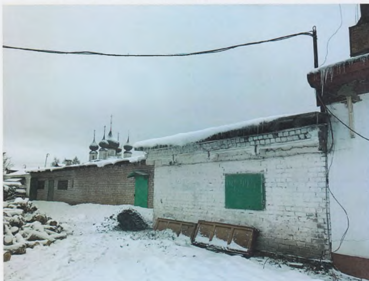
6. Северный корпус торговых рядов. Вид с северо-востока.
