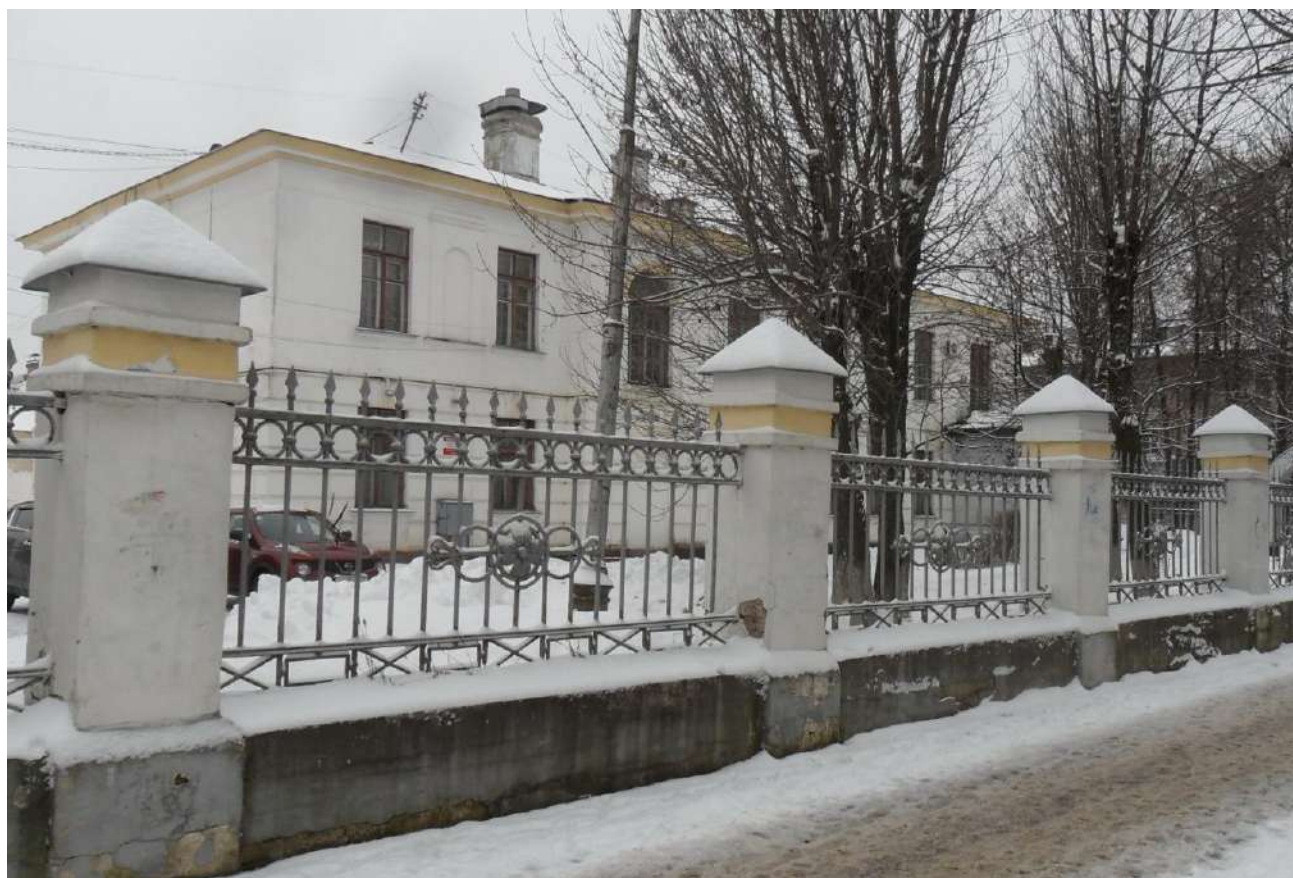
Фото 17. Ограда по ул. Парижской коммуны
