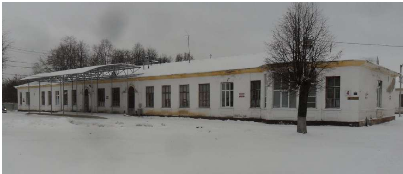
Фото 10. Корпус № 4. Северный фасад
