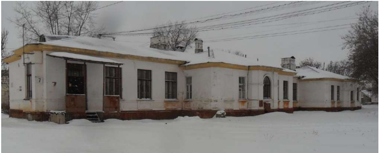
Фото 7. Корпус № 7. Северный фасад
