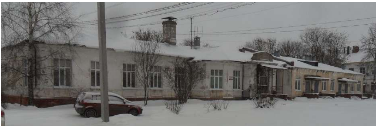
Фото 6. Корпус № 5. Северный фасад
