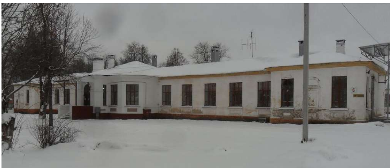
Фото 11. Корпус № 6. Северный фасад
