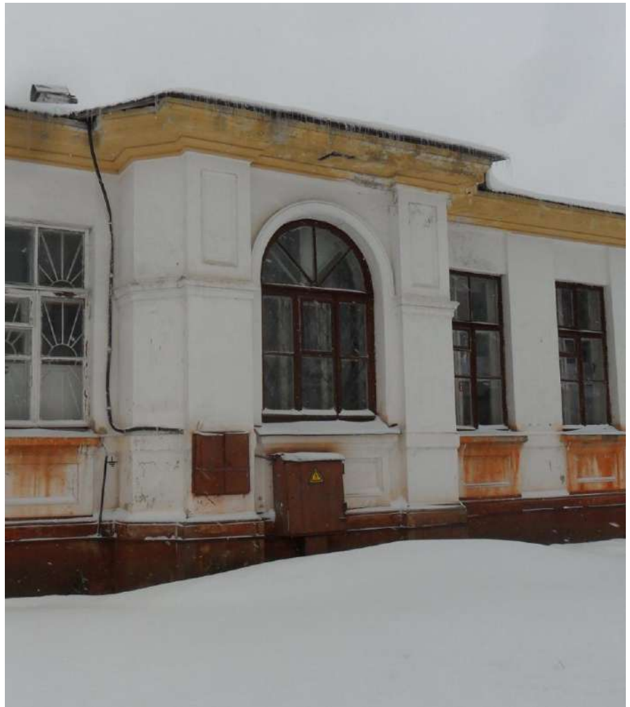
Фото 9. Фрагмент фасада корпуса № 7
