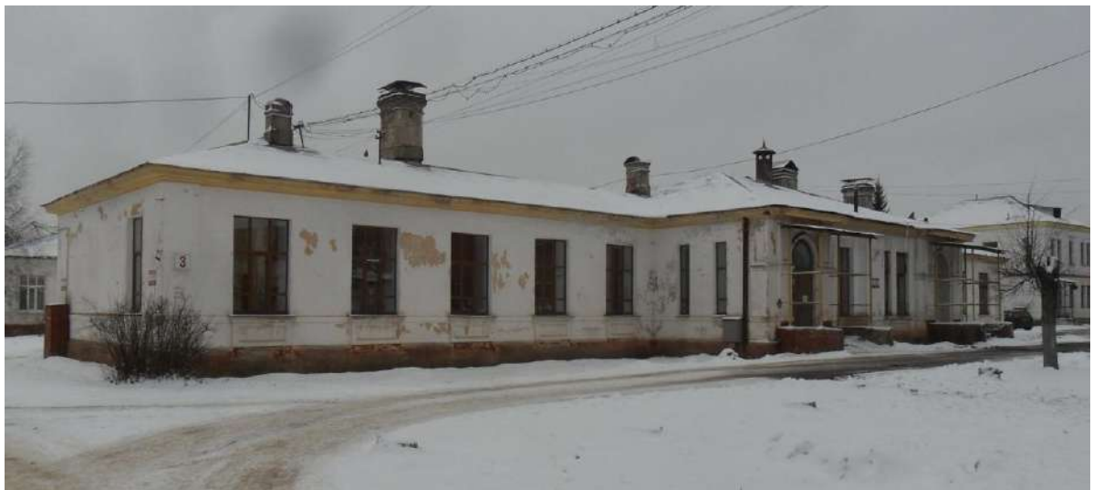
Фото 5. Корпус № 3. Северный фасад
