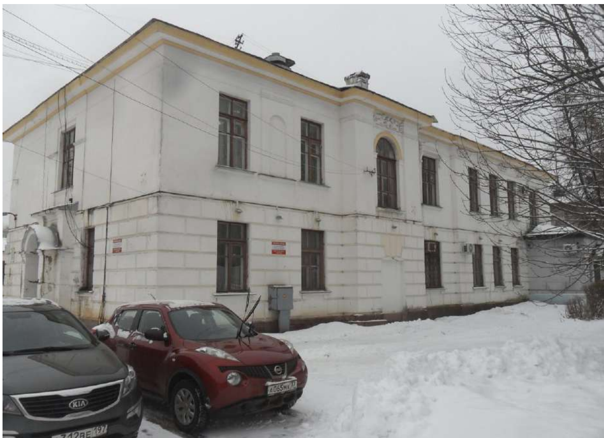
Фото 1. Административно-служебный корпус № 1. Северный фасад
