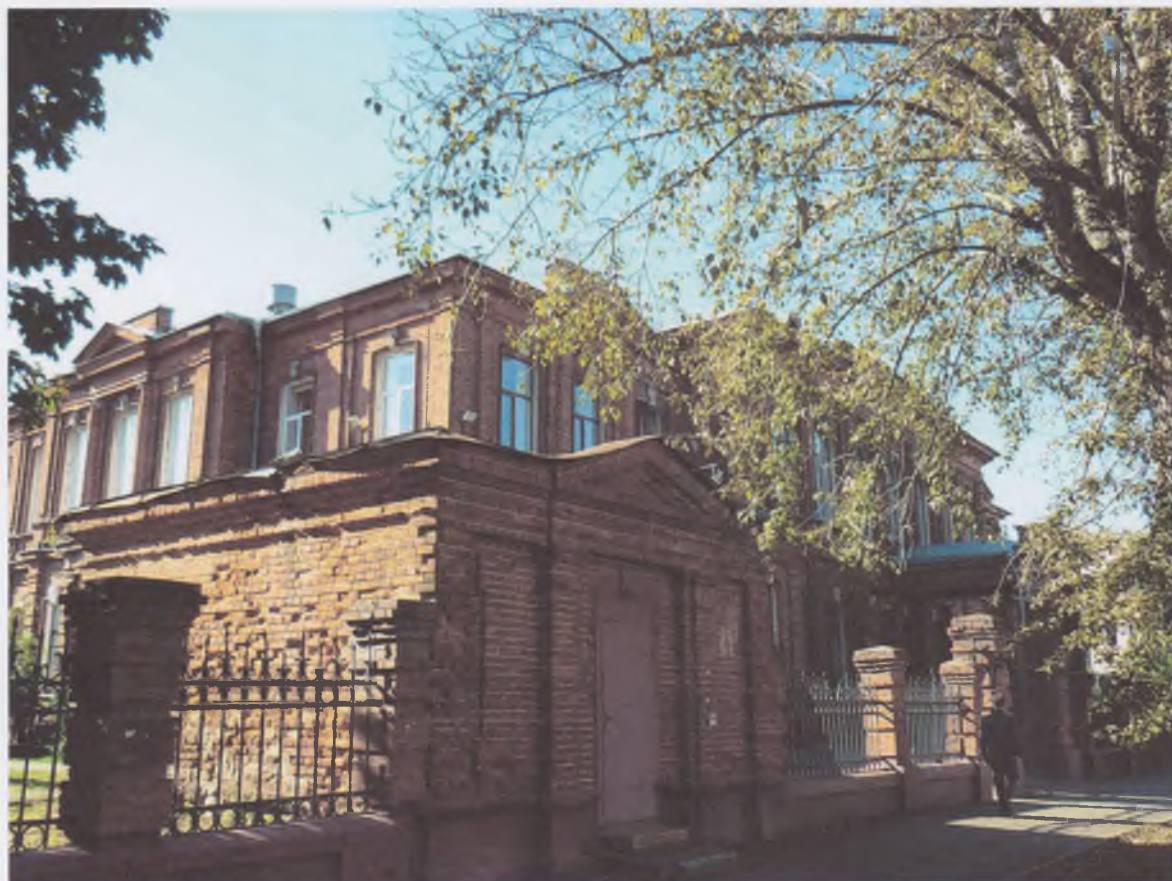
12. Сторожка. Вид с востока
