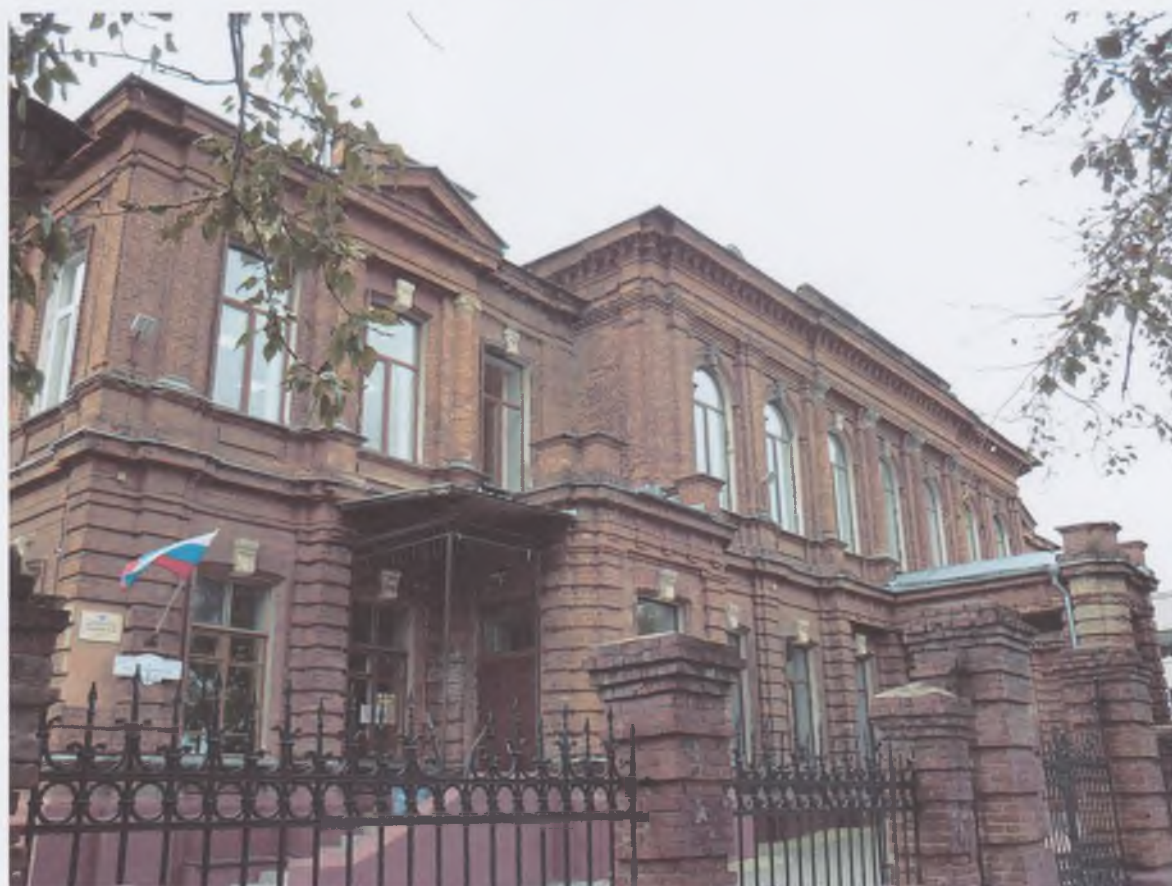
13. Центральная часть здания. Вид с востока
