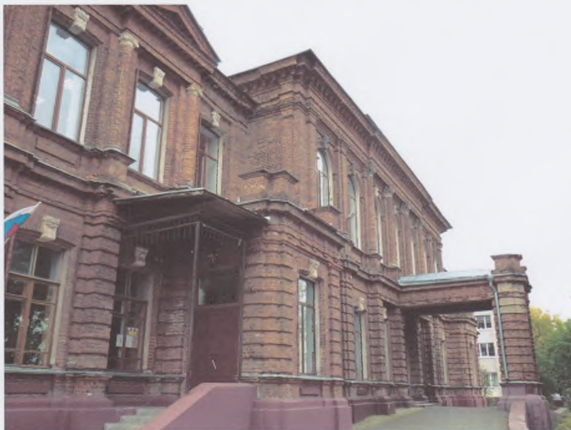
3. Центральная часть здания. Вид с востока
