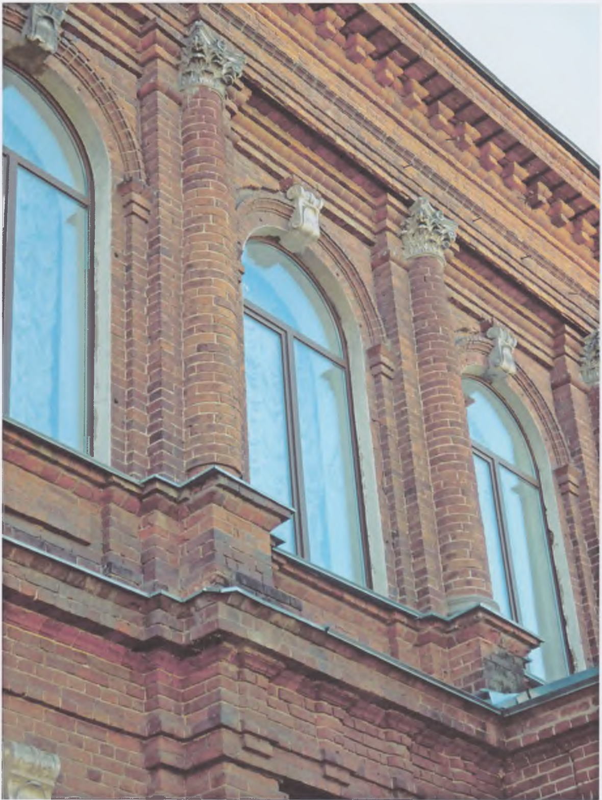
5. Фрагмент центрального ризалита
