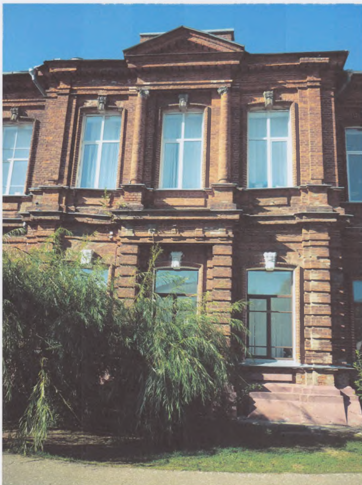
11. Фрагмент бокового фасада
