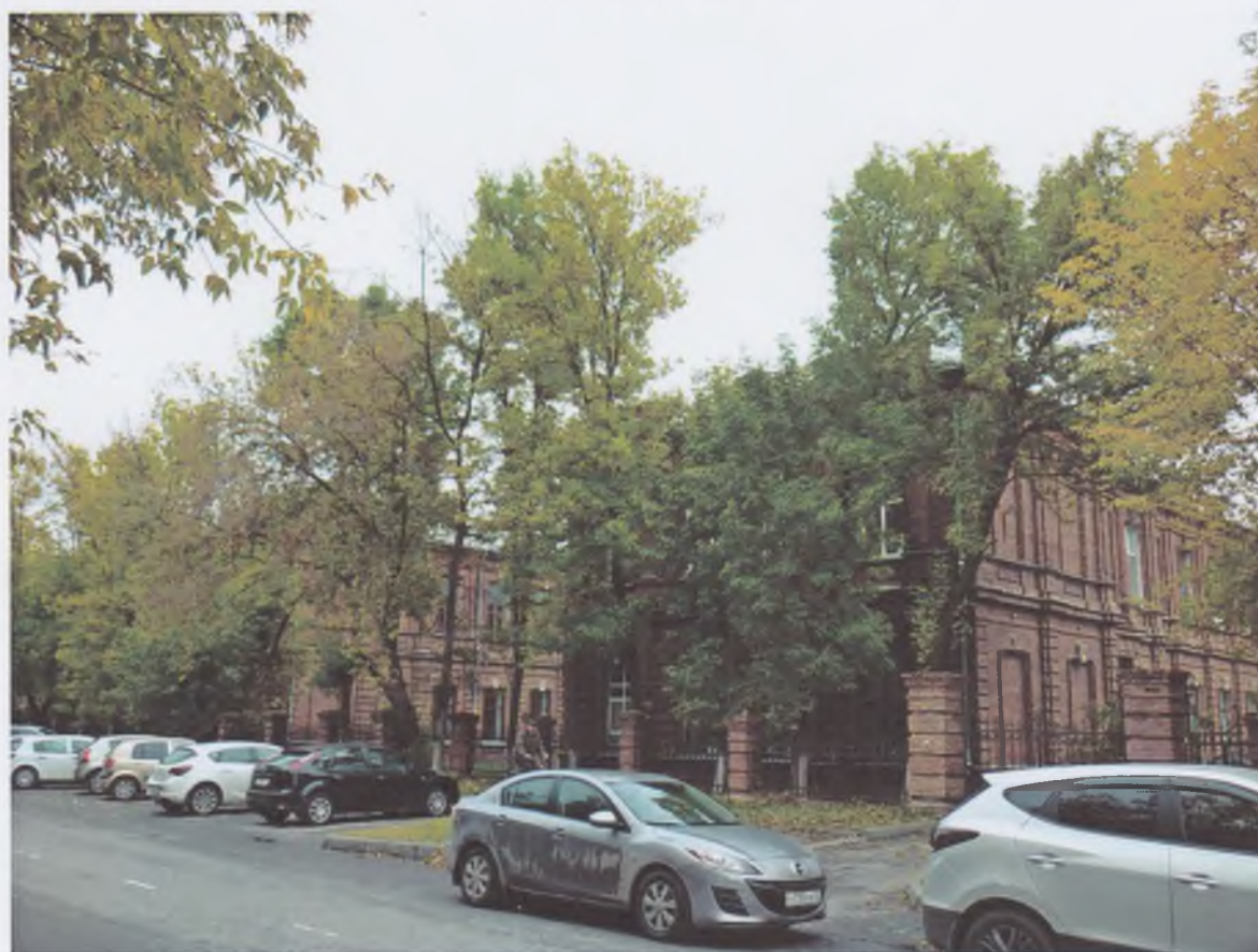
8. Задний фасад. Вид с юга
