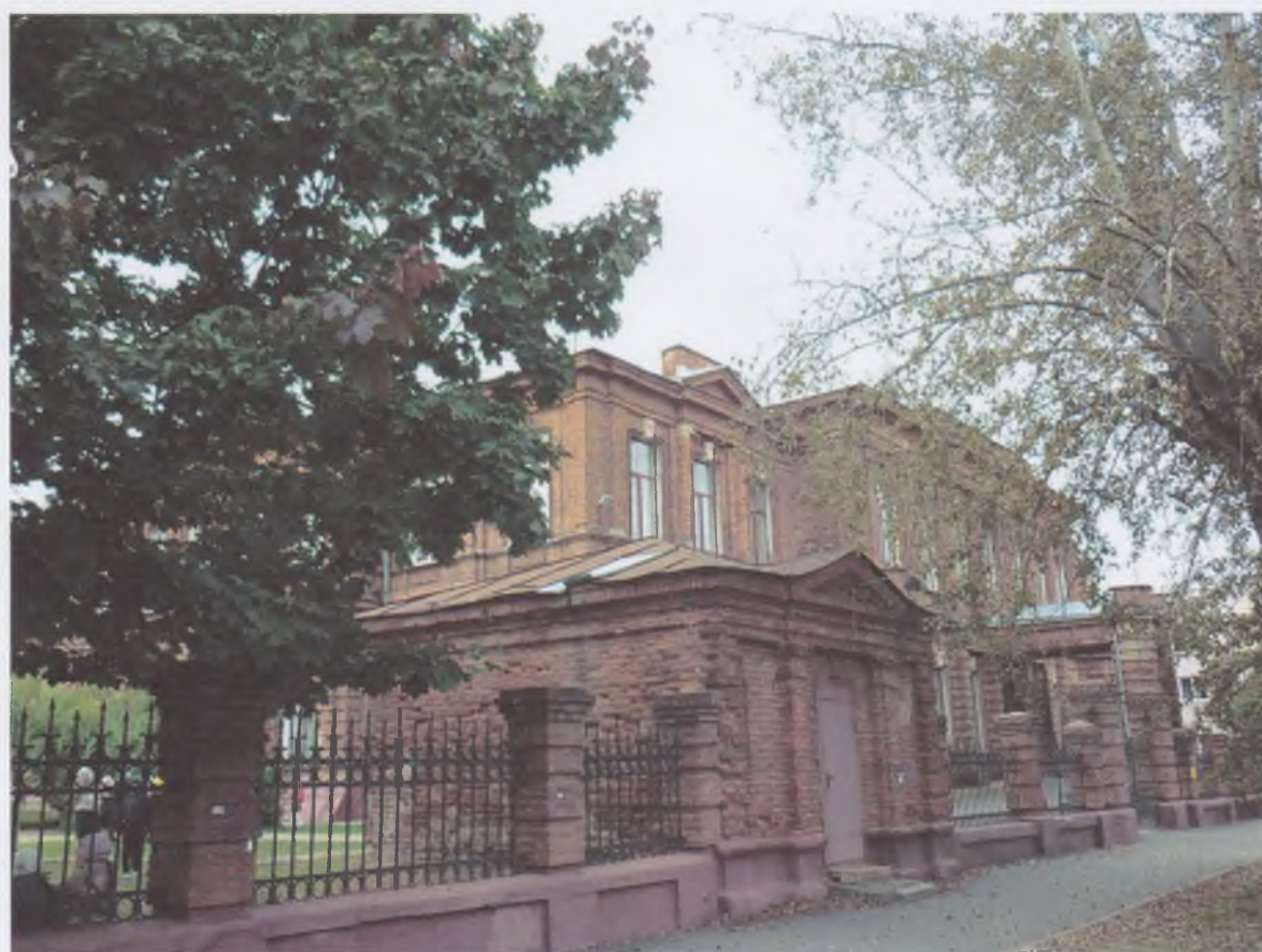
4. Общий вид здания с востока
