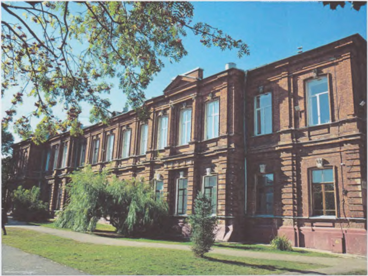
9. Боковой фасад. Вид с востока
