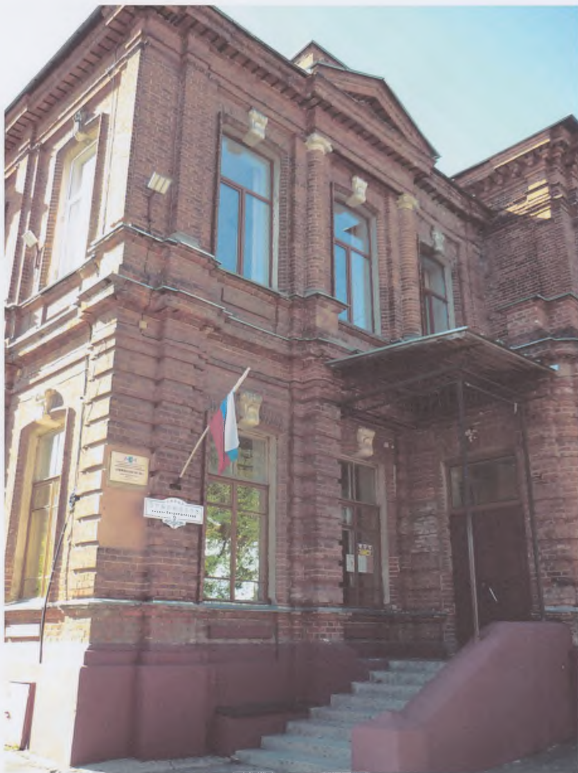
6. Фрагмент главного фасада. Вид с востока
