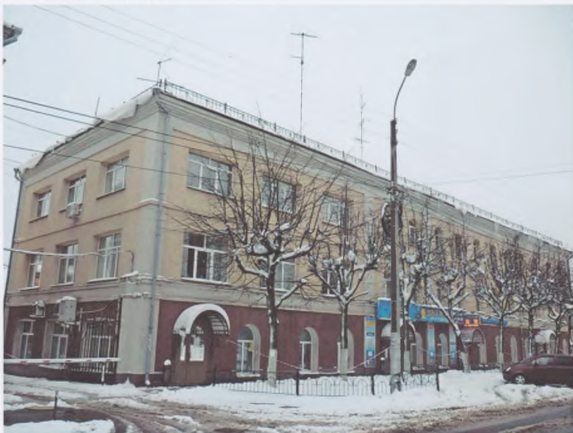
7. Западный корпус (литер В).. Вид с востока
