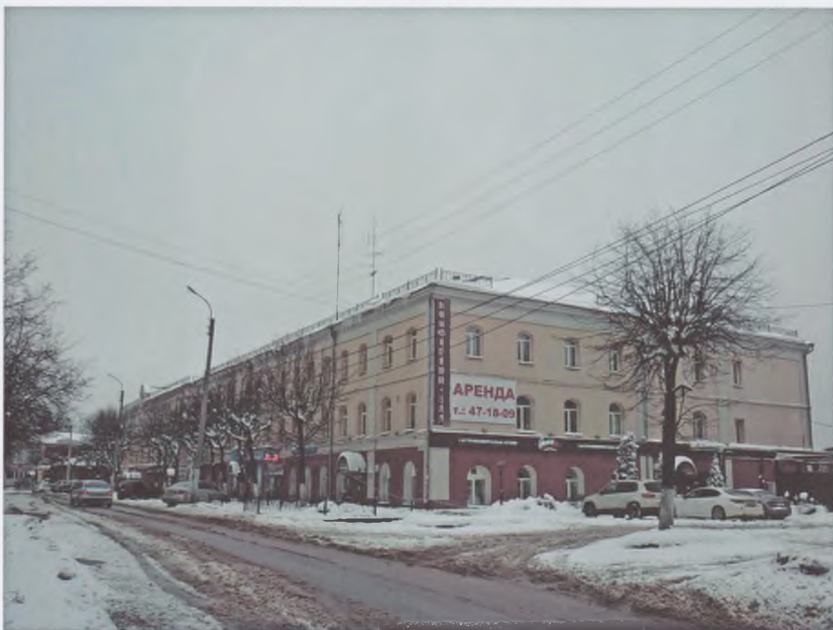
4. Общий вид фабрики с севера
