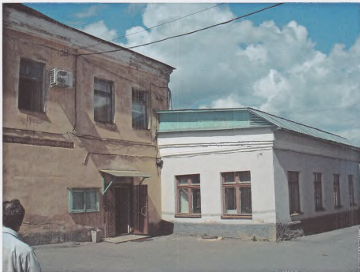
11. Пристройки. Восточные фасады (д. 13, Литер Б1, Б2)
