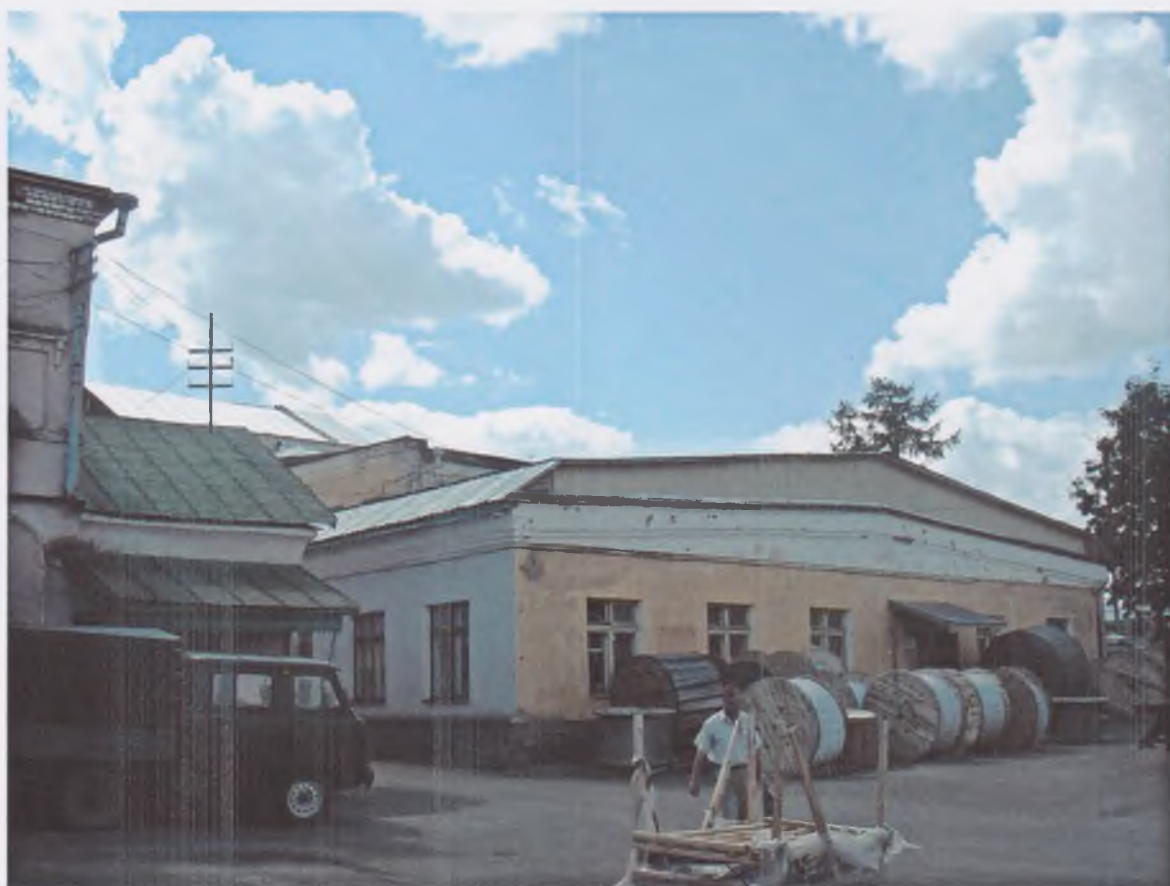
12. Пристройки. Северные фасады (д. 13, Литер А2, Б2)
