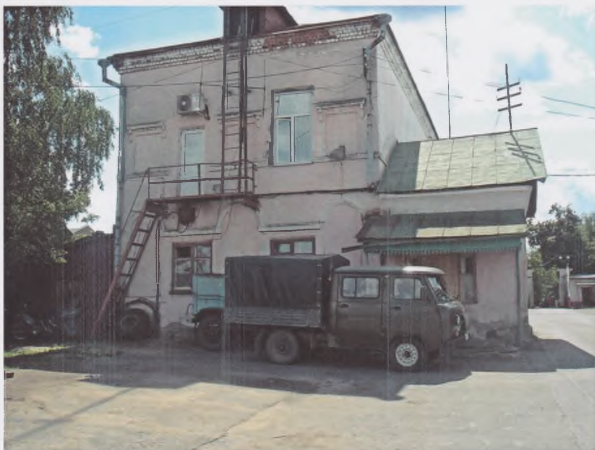
10. Склады. Северный фасад. (д. 13, Литер А1, А2)
