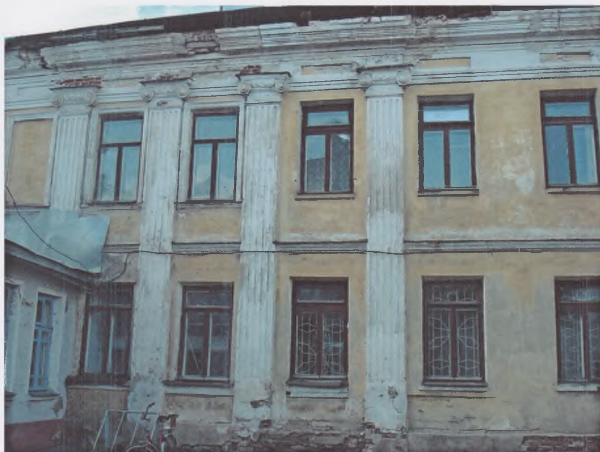
4. Жилой дом. Восточный фасад (д. 11, Литер Б)
