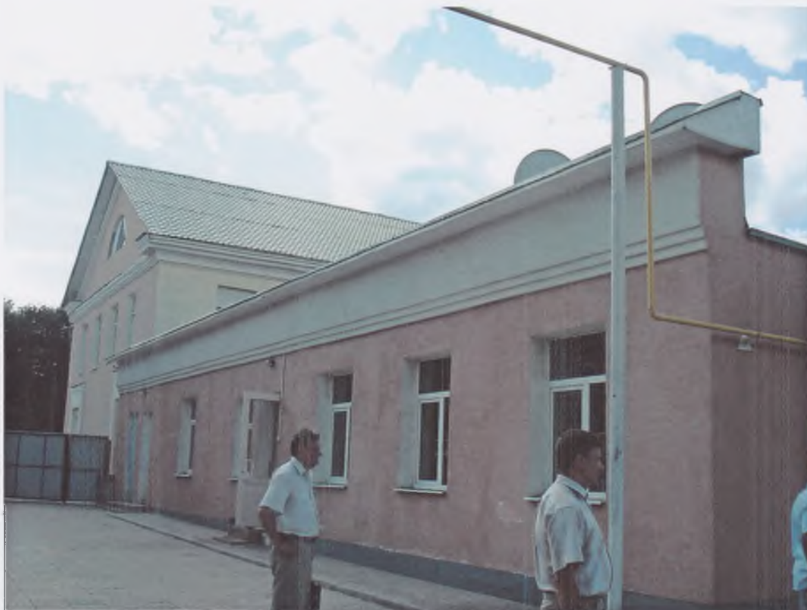
7. Склады. Восточный фасад (д. 13, Литер А5)
