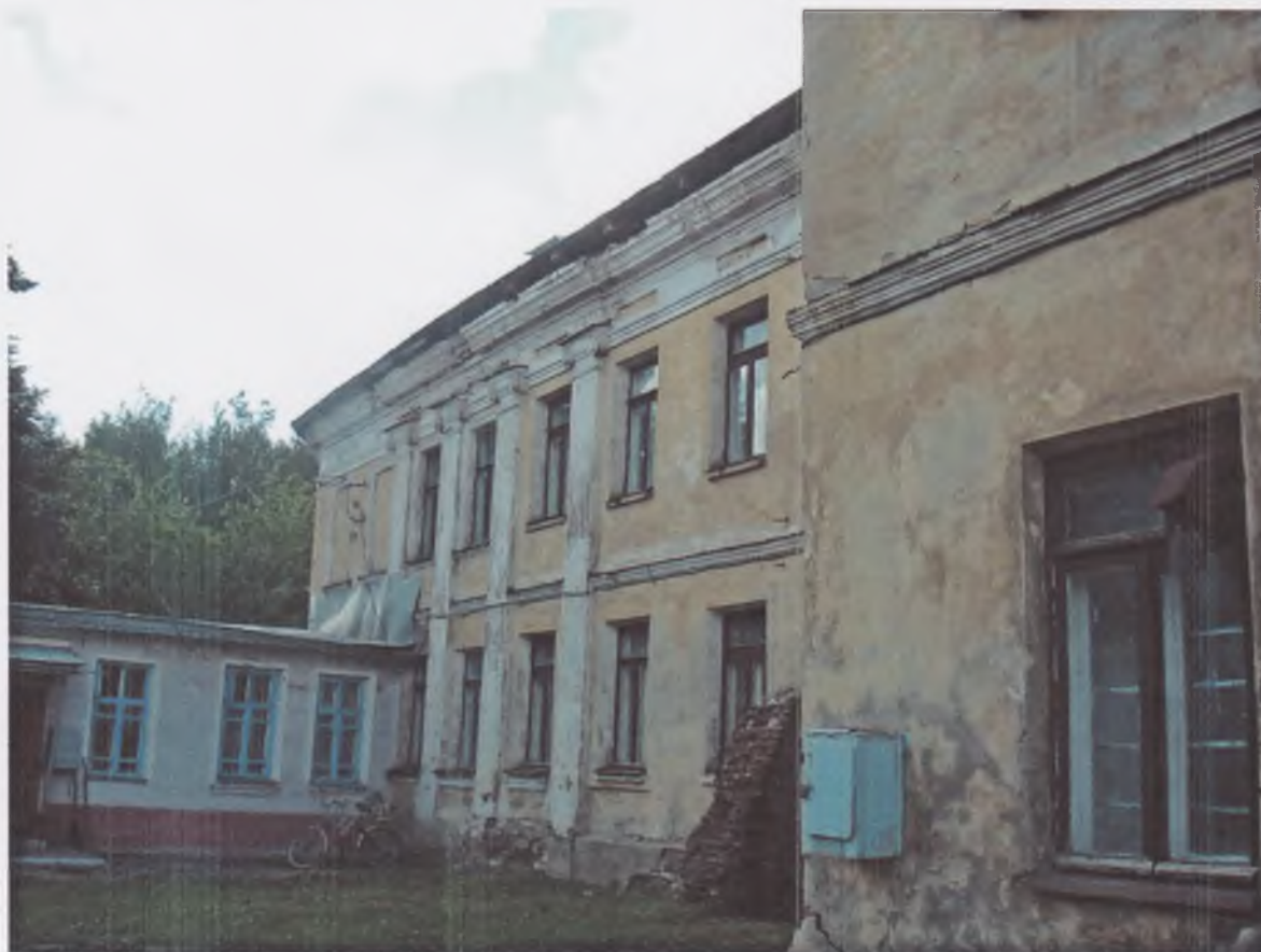
3. Жилой дом. Восточный фасад (д. 11, Литер Б) и пристройка (д. 13, Лит. Б5)
