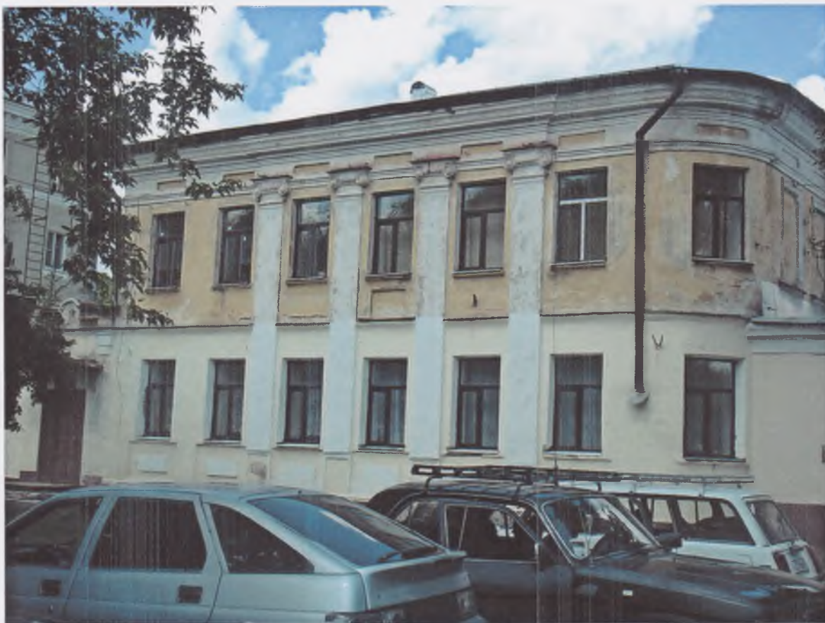
1. Жилой дом (д. 11, Литер Б). Главный фасад
