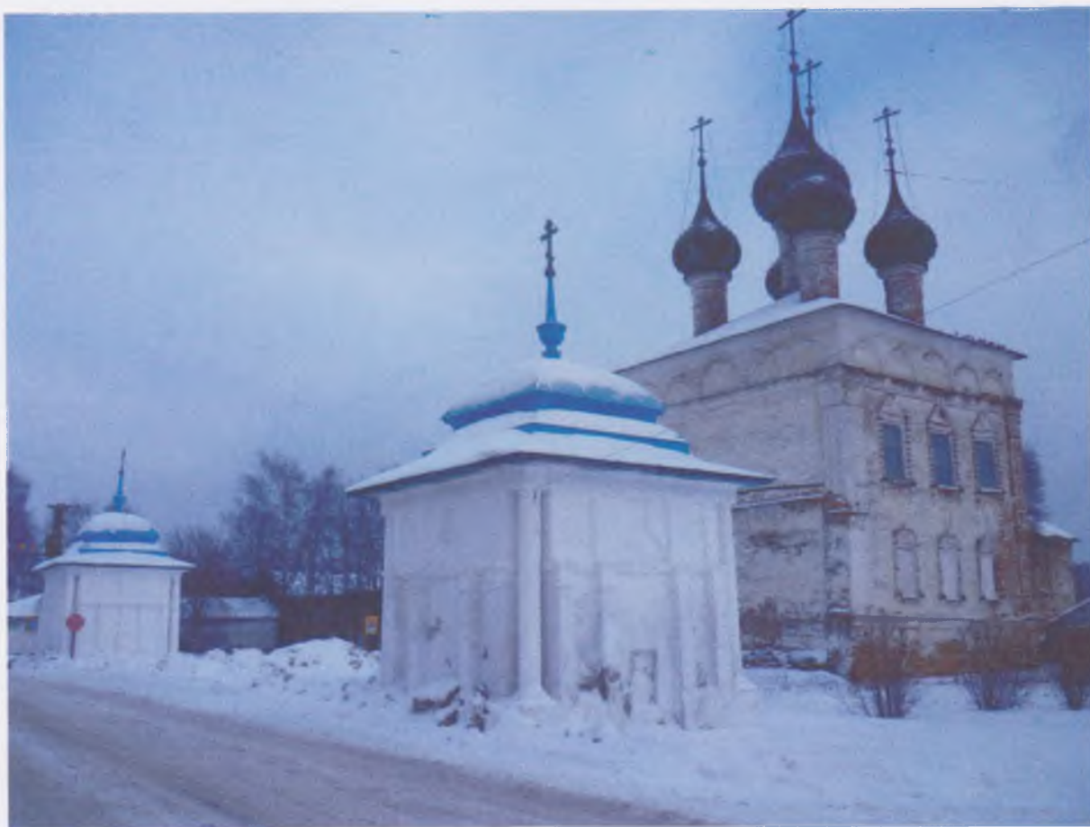
Вид с юго-запада.
