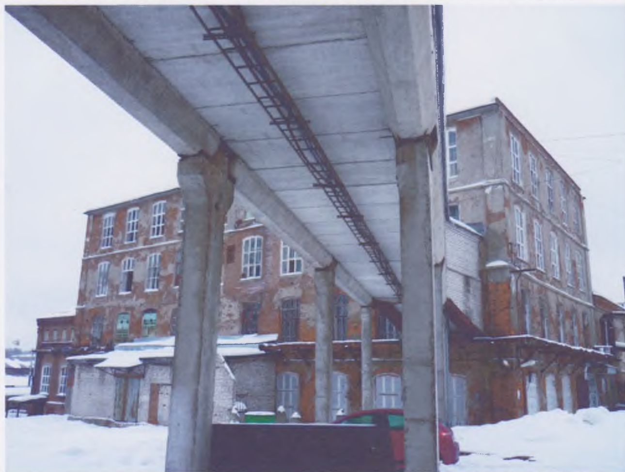
Старый ткацкий корпус (Лит. В2). Западный фасад.
