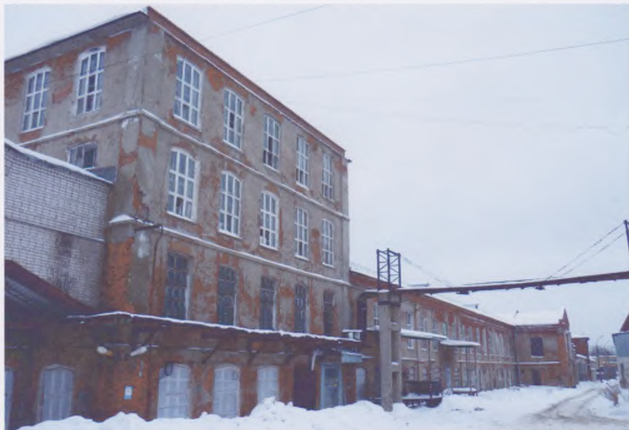
Старый ткацкий корпус (Лит. В, В2). Южный фасад.
