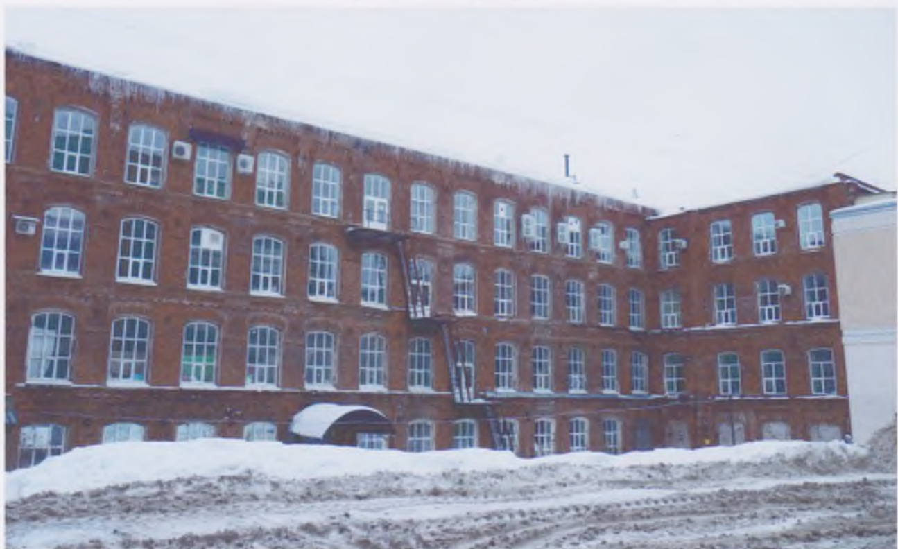
Общий вид южного фасада.
