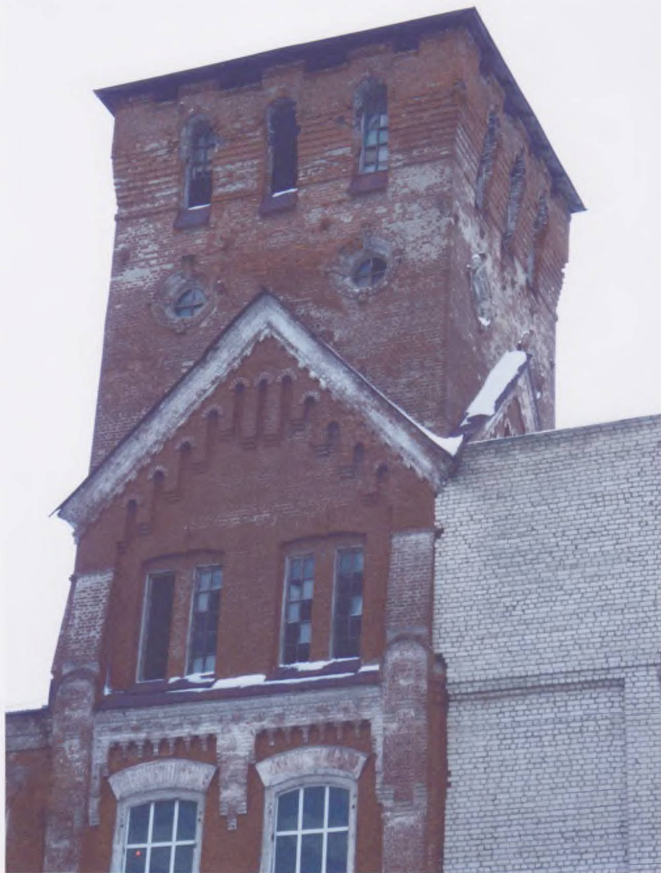
Прядильный корпус. Водонапорная башня.
