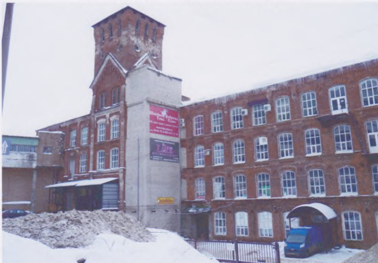
Южный фасад с водонапорной башней.
