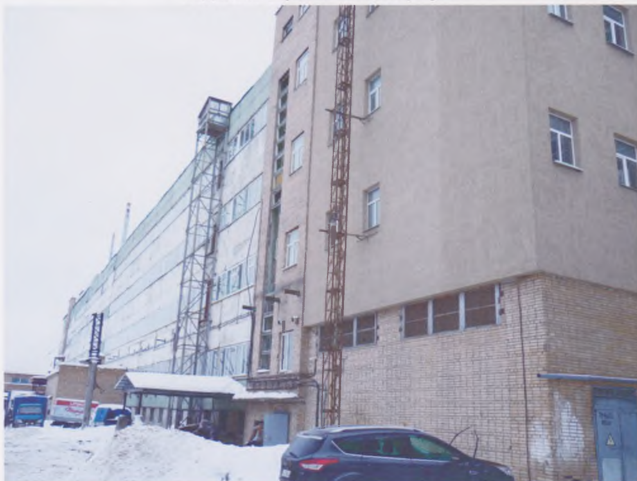
Прядильный корпус (новая пристройка (Лит. Б1)).
