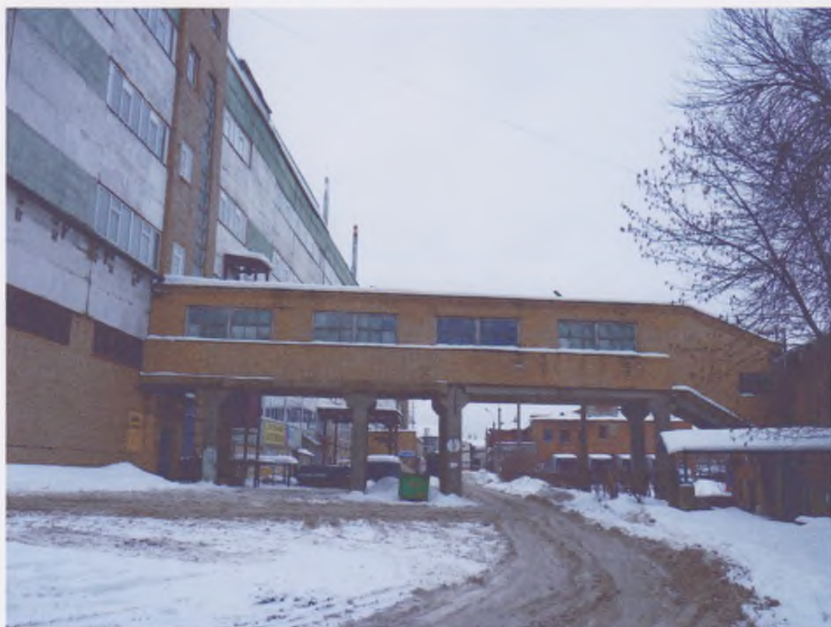
Прядильный корпус. Новая пристройка к северному фасаду (Лит. Б1).
