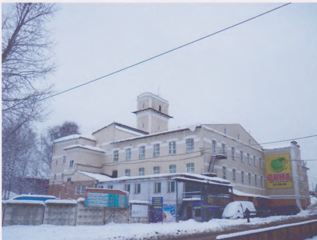
Фабрика Товарищества мануфактур наследников Н.Ф. Зубкова (Ивановская обл., г. Иваново, ул. Фабричный проезд, д. 6.) Вид со стороны Фабричного проезда.
