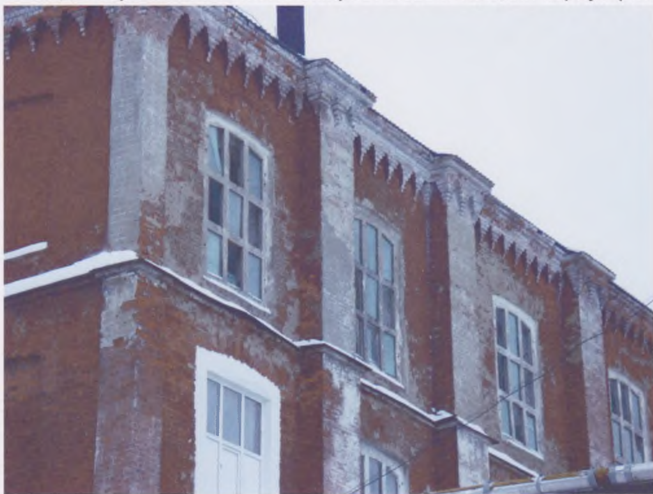
Западный фасад. Фрагмент.
