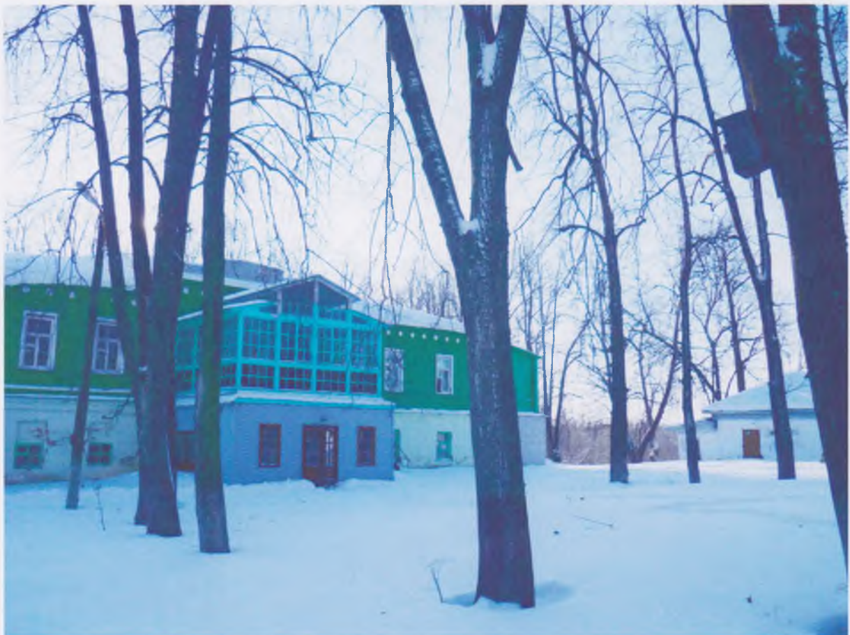
Главный дом и голубятня. Вид с севера.
