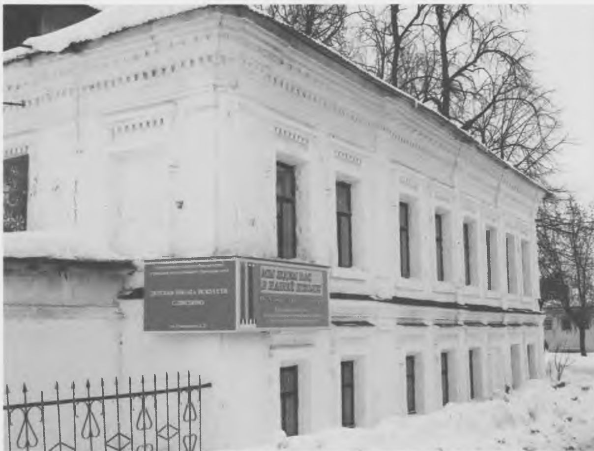
Вид с северо-запада.
