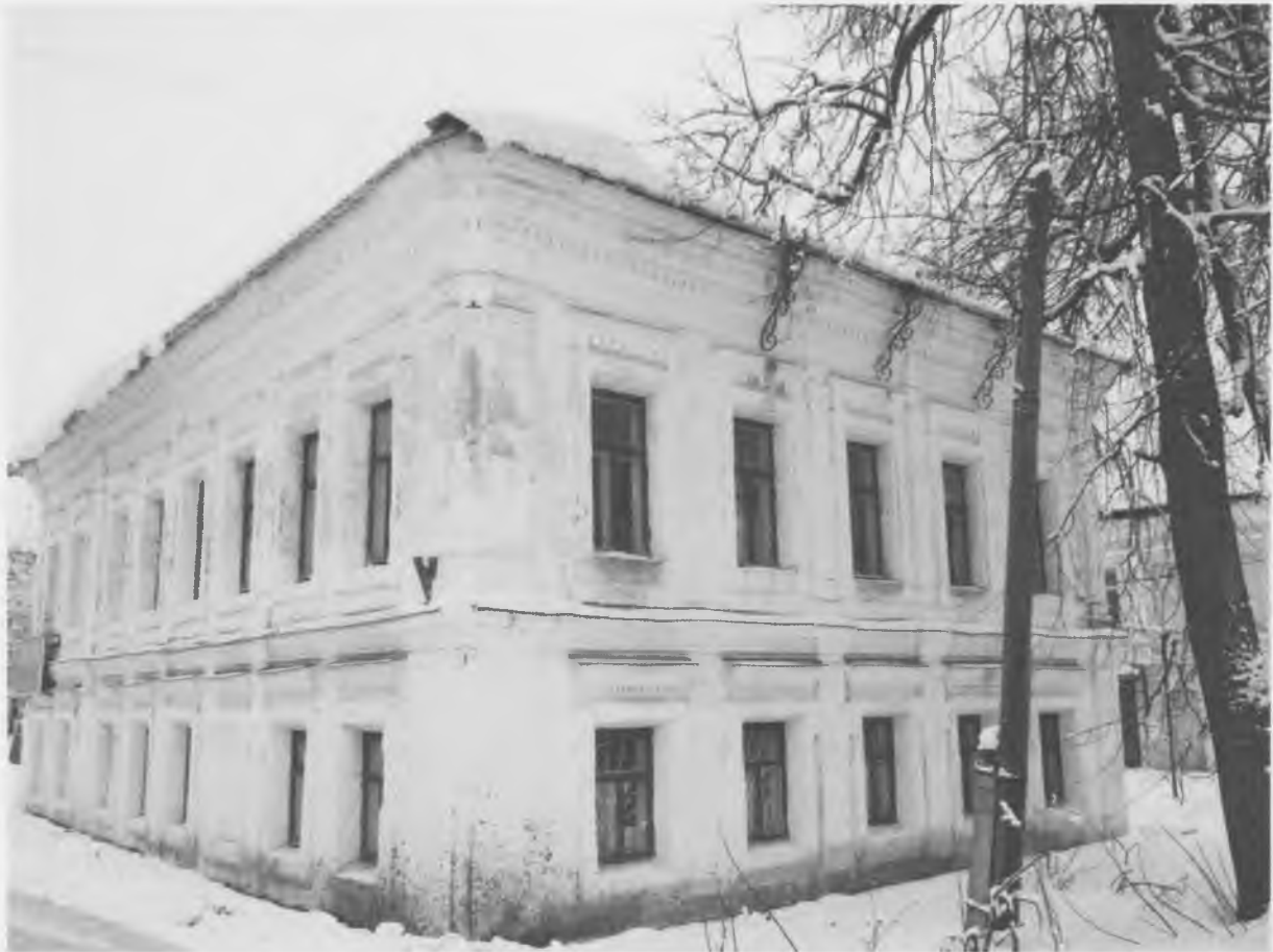
Вид с юго-запада.
