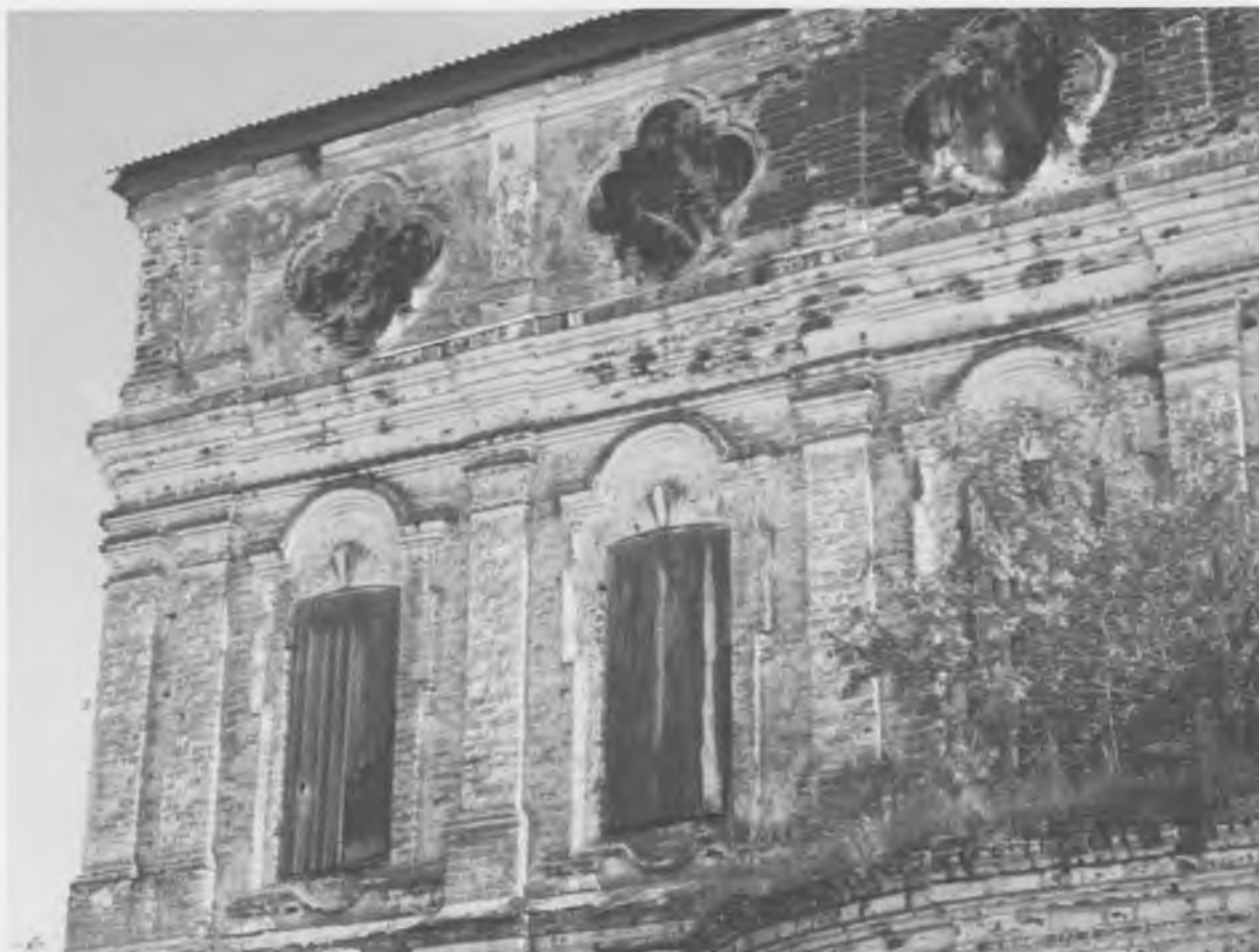
Церковь Михаила Архангела. Фрагмент фасада.
