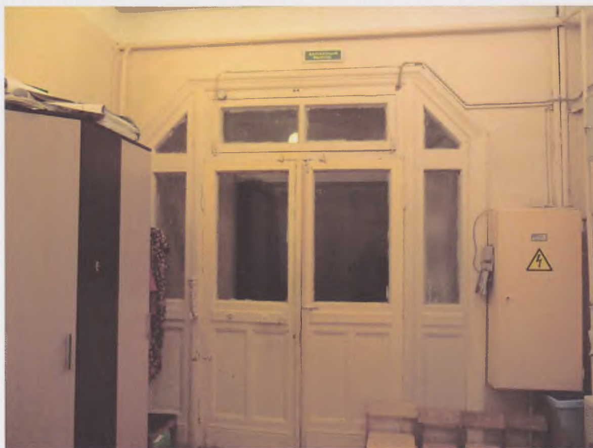
9. Двери напротив главного входа в здание
