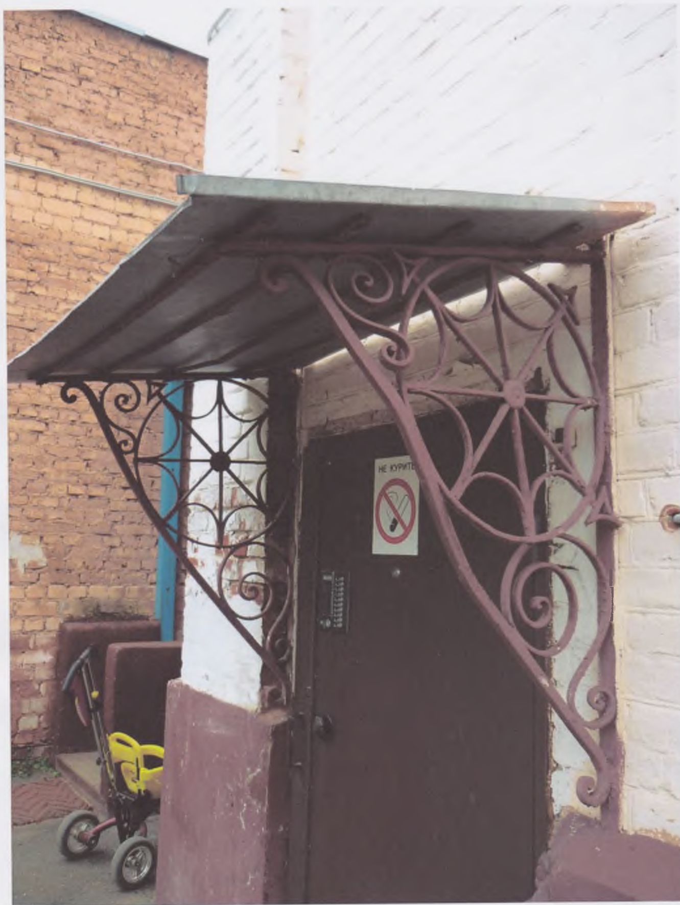
10. Металлический зонт над входом со стороны двора
