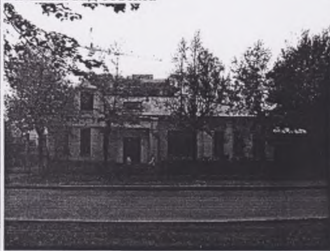
Внешний вид объекта
