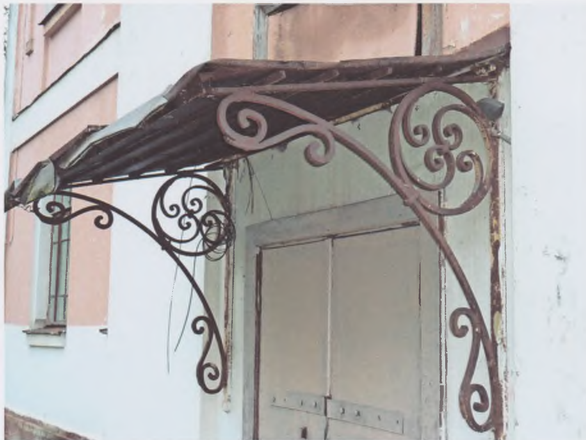
7. Зонт над входом со стороны двора
