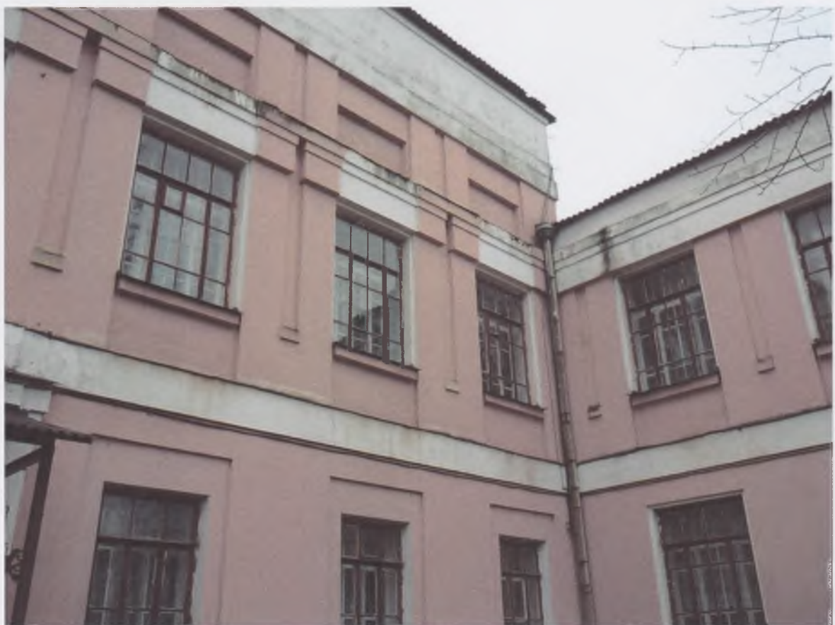
6. Фрагмент главного фасада
