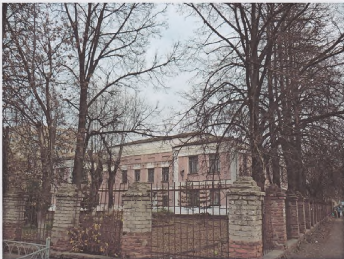
3. Общий вид здания с запада
