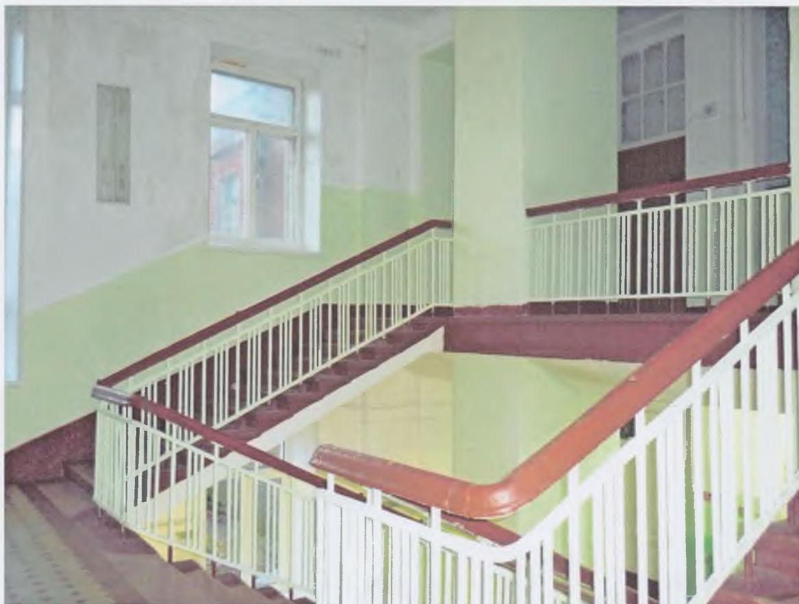
7. Парадная лестница, вид с междуэтажной площадки
