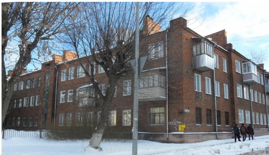
Фото 9. Дом № 14/1 по ул. Крутицкой. Вид с перекрестка ул. Пушкина и Крутицкой
