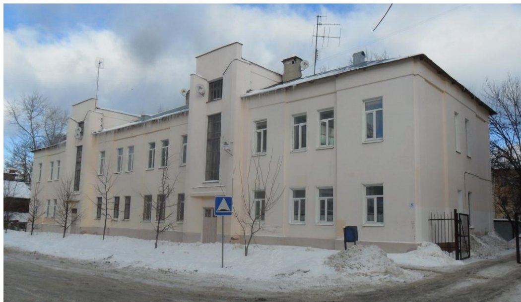
Фото 1. Главный фасад 10-квартирного дома
