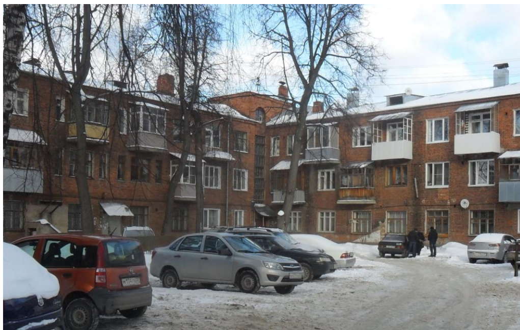
Фото 11. Дом № 14/1 по ул. Крутицкой. Дворовые фасады.
