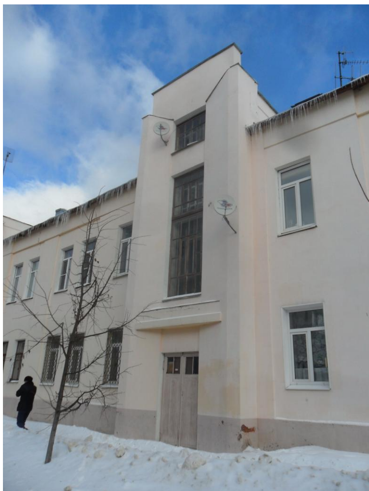
Фото 2. Блок лестничной клетки главного фасада 10-квартирного дома
