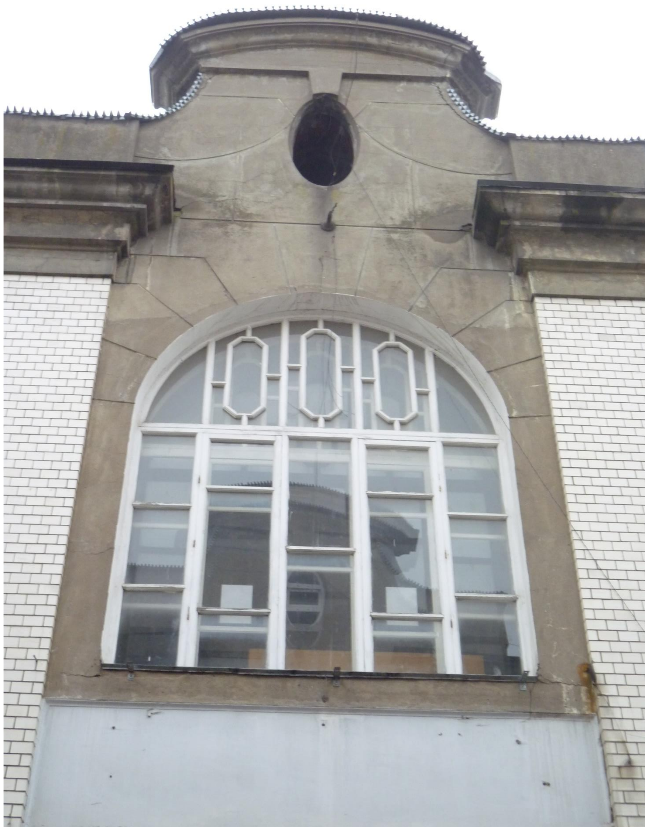
7. Восточный корпус. Расстекловка окна лестничной клетки. Фото 4.07.2025 г. А.М. Тихомиров
