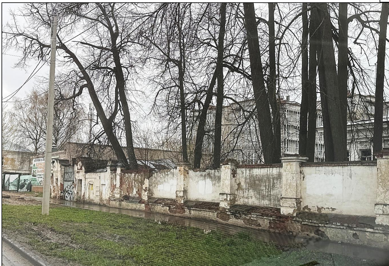
Рисунок 31: Ограда Усадьбы А.И. Гарелина, середина XIX в. – 1890 г. (Ивановская область, г. Иваново, Володиной ул., 4). На заднем плане справа объект культурного наследия регионального значения «Старый дом» усадьбы А.И. Гарелина, середина XIX в. – 1890 г.» (Ивановская область, г. Иваново, Володиной ул., 4), слева (по центру) возводимый многоквартирный жилой дом по адресу: Ивановская область, г. Иваново, ул. Володиной, д. 8 А
