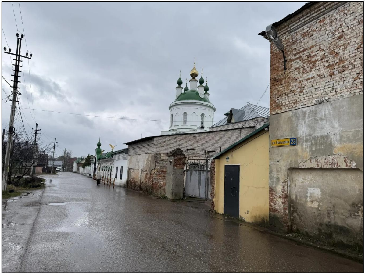
Рисунок 24: Объект культурного наследия местного (муниципального) значения «Ильинская слобода, 1840-е – 1910-е гг.» (Ивановская область, г. Иваново, Кольцова ул., Володиной ул.), комплекс храма пророка Ильи
