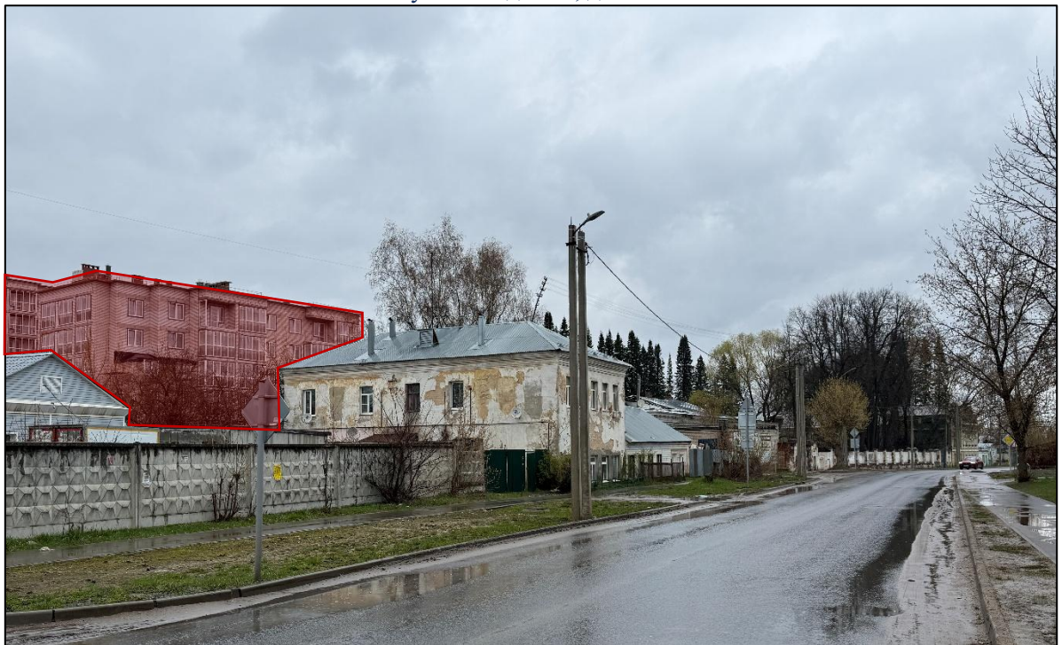
Рисунок 15: Слева на заднем плане возводимый многоквартирный жилой дом по адресу: Ивановская область, г. Иваново, ул. Володиной, д. 8 А, вид с улицы Володиной
