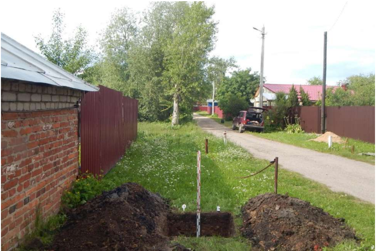
Рис. 34. Иваново, между ул. Кирпичной и ул. Некрасова. Общий вид с юга выкопанного шурфа № 3.
