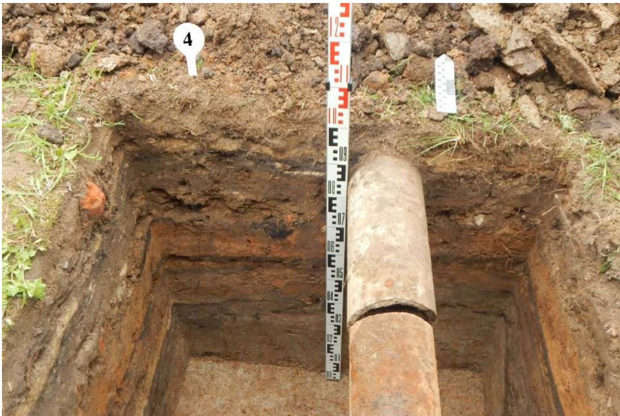
Рис. 40. Иваново, между ул. Кирпичной и ул. Некрасова. Шурф №4, профиль северного борта, вид с юга.
