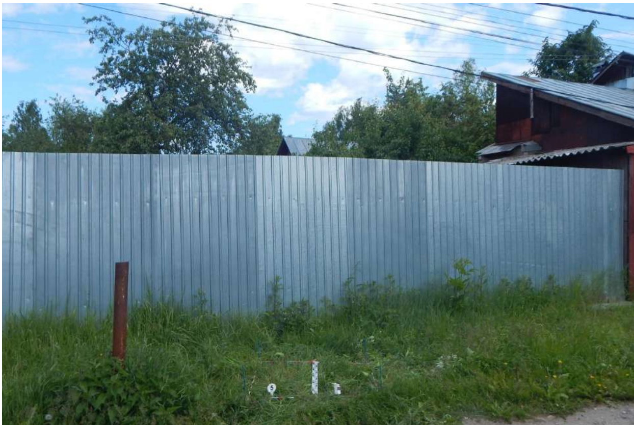
Рис. 46. Иваново, между ул. Кирпичной и ул. Некрасова. Шурф № 5, разметка и общий вид с юга.
