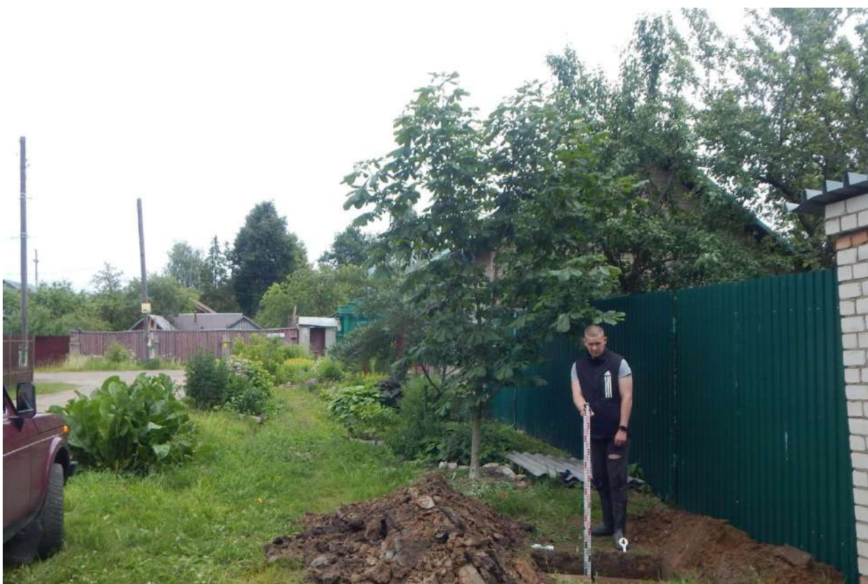
Рис. 41. Иваново, между ул. Кирпичной и ул. Некрасова. Общий вид с юга выкопанного шурфа № 4.
