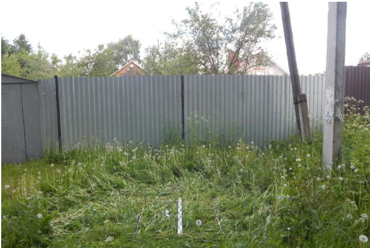
Рис. 18. Иваново, между ул. Кирпичной и ул. Некрасова. Шурф № 1, разметка и общий вид с юга.
