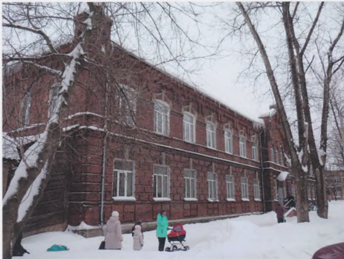
1. Главный фасад, вид с севера
