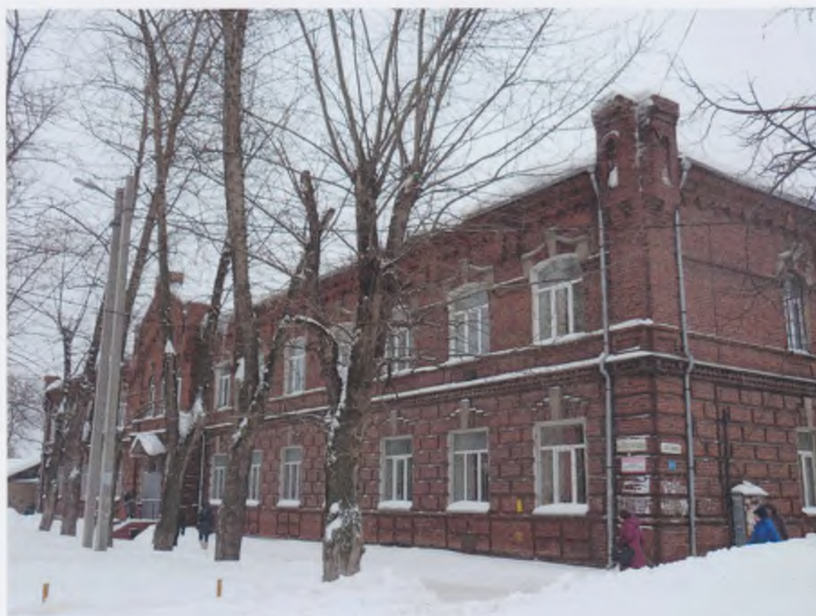
2. Главный фасад, вид с запада
