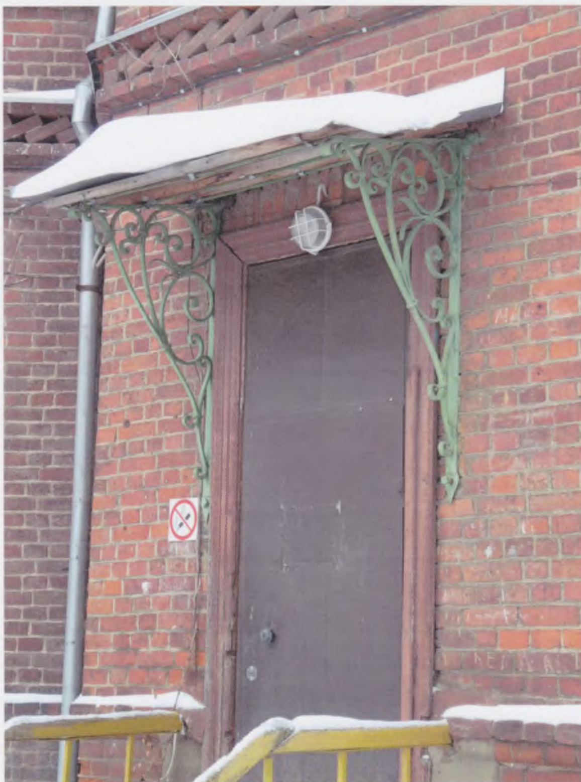
6. Зонт над входом
