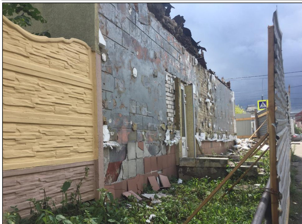
Рис. 1 и 2 Нежилое здание по адресу: г. Иваново, ул. Смирнова, д. 1. Автор фотографии и дата выполнения: А.Ф. Мартынов, 26.07.2023
