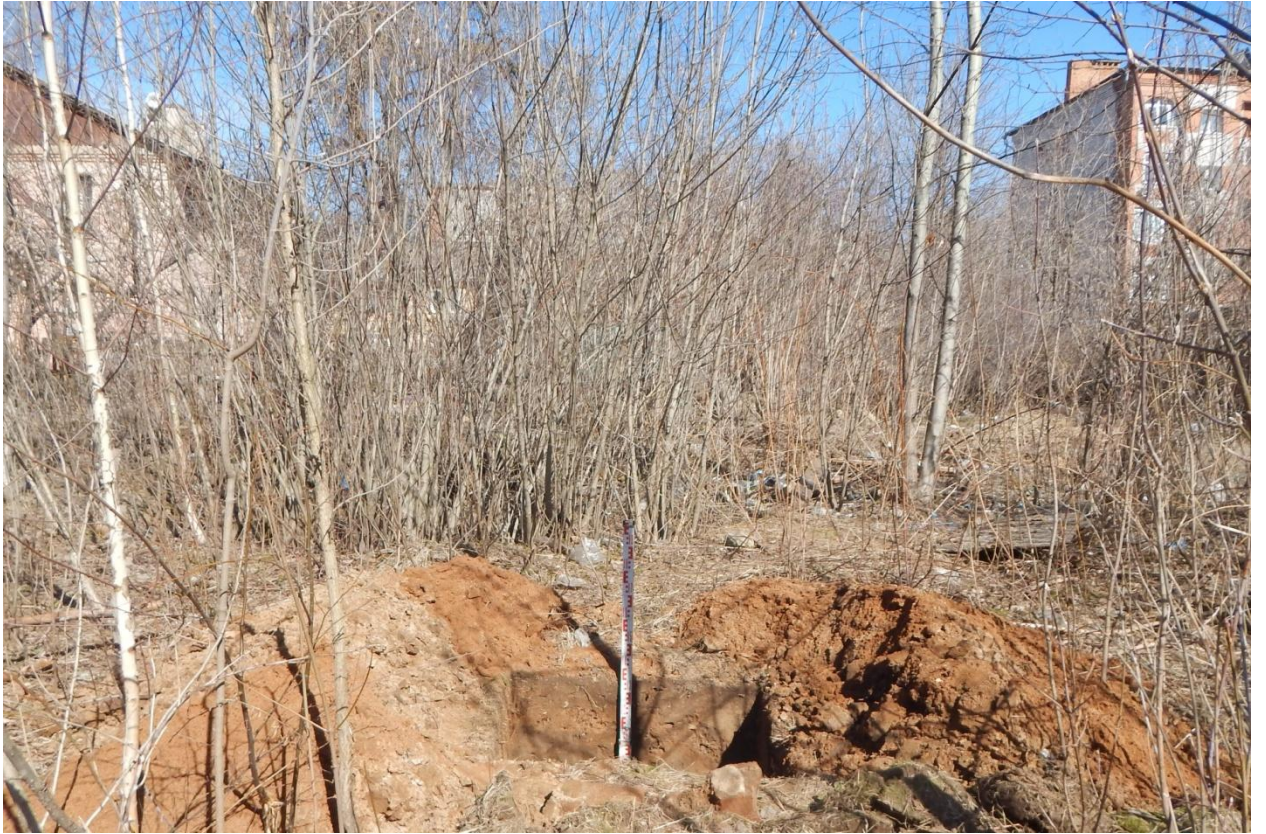
Рис. 18. Иваново, ул. Герцена, 16/23. Общий вид выкопанного шурфа с юга.
