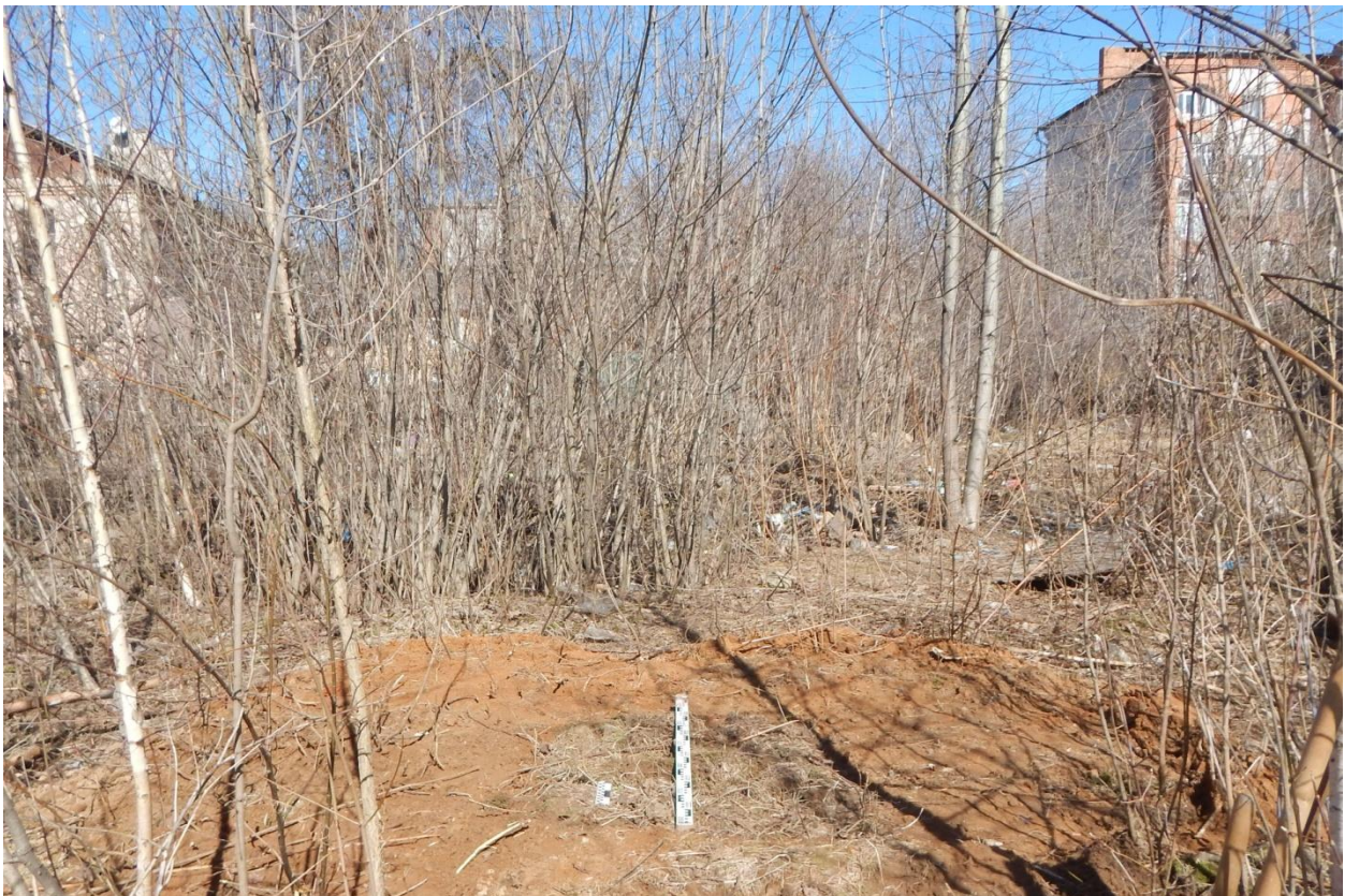
Рис. 19. Иваново, ул. Герцена, 16/23. Разведочный шурф, рекультивация, вид с юга.
