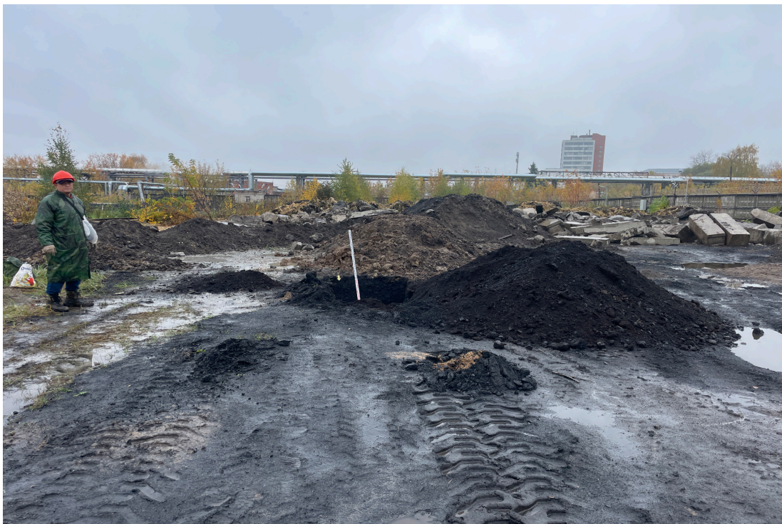
Рис. 36. Объект: «Строительство водогрейной котельной 400Гкал/час на территории Ивановской ТЭЦ-2», расположенной по адресу: РФ, Ивановская обл., г. Иваново, ул. Суворова, 76. Общий вид с С на шурф 3.
