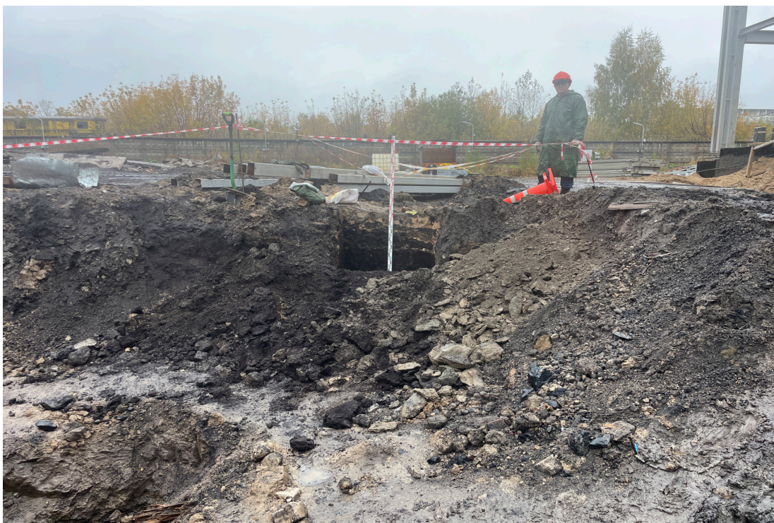
Рис. 27. Объект: «Строительство водогрейной котельной 400Гкал/час на территории Ивановской ТЭЦ-2», расположенной по адресу: РФ, Ивановская обл., г. Иваново, ул. Суворова, 76. Общий вид с В на шурф 1.
