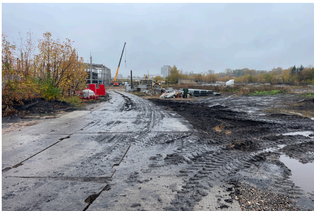
Рис. 19. Объект: «Строительство водогрейной котельной 400Гкал/час на территории Ивановской ТЭЦ-2», расположенной по адресу: РФ, Ивановская обл., г. Иваново, ул. Суворова, 76. Вид из тф 4 на Ю.
