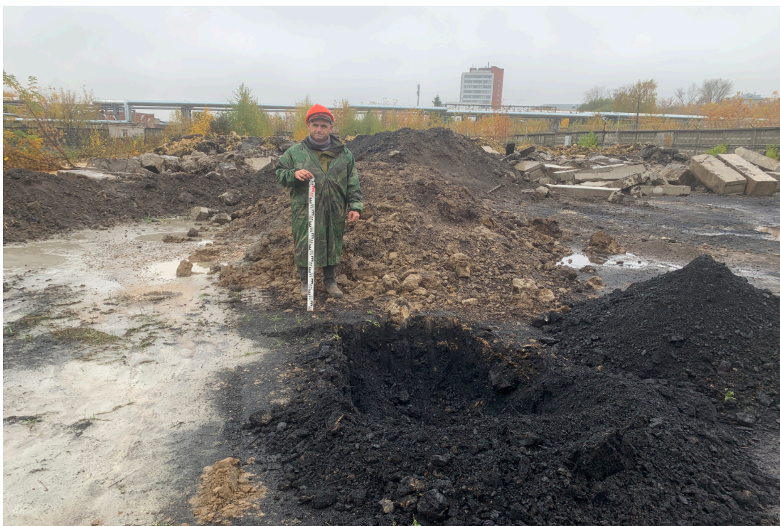
Рис. 33. Объект: «Строительство водогрейной котельной 400Гкал/час на территории Ивановской ТЭЦ-2», расположенной по адресу: РФ, Ивановская обл., г. Иваново, ул. Суворова, 76. Вид с С на разбивку шурфа 3.
