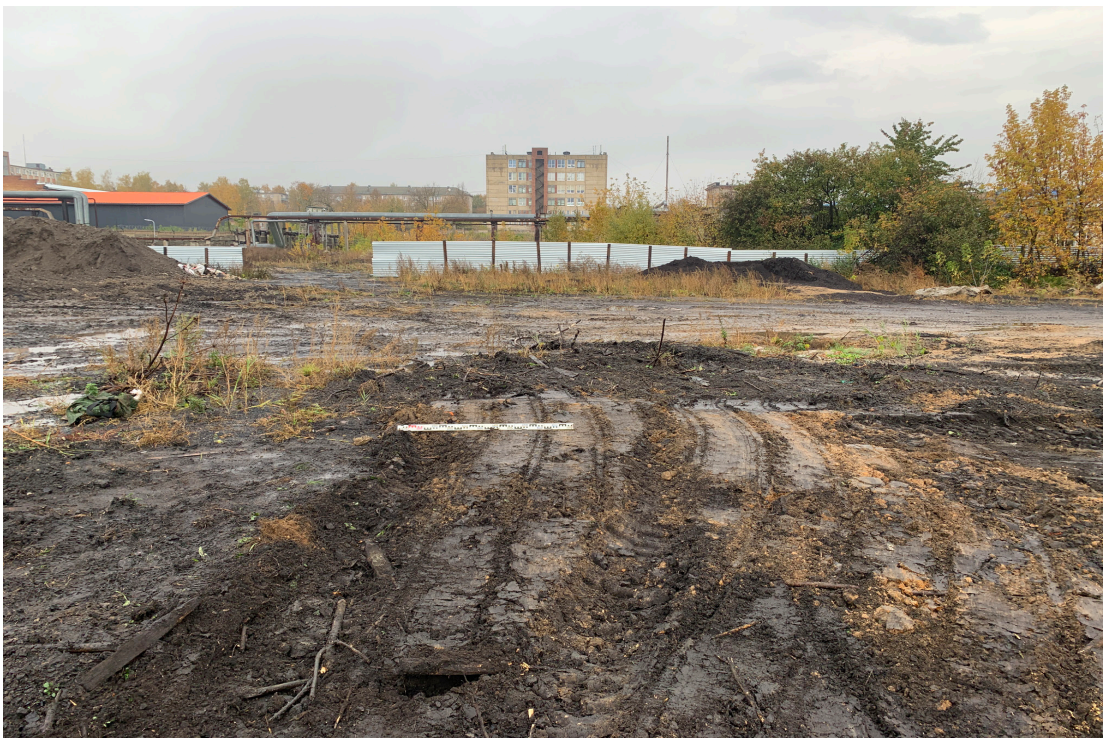
Рис. 41. Объект: «Строительство водогрейной котельной 400Гкал/час на территории Ивановской ТЭЦ-2», расположенной по адресу: РФ, Ивановская обл., г. Иваново, ул. Суворова, 76. Вид с Ю на рекультивацию шурфа 4.
