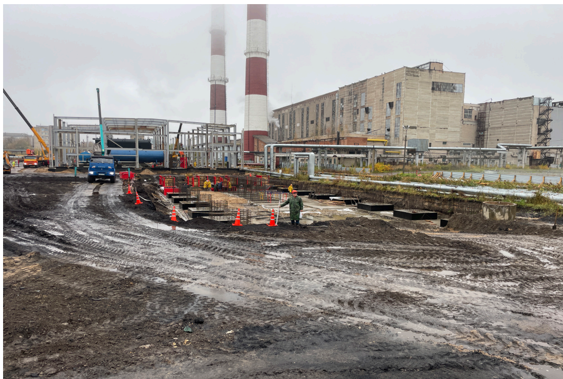
Рис. 13. Объект: «Строительство водогрейной котельной 400Гкал/час на территории Ивановской ТЭЦ-2», расположенной по адресу: РФ, Ивановская обл., г. Иваново, ул. Суворова, 76. Вид из тф 2 на С.
