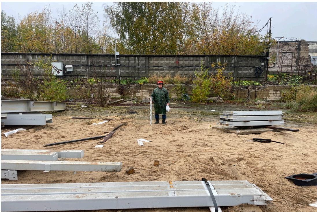
Рис. 28. Объект: «Строительство водогрейной котельной 400Гкал/час на территории Ивановской ТЭЦ-2», расположенной по адресу: РФ, Ивановская обл., г. Иваново, ул. Суворова, 76. Вид с В на разбивку шурфа 2.
