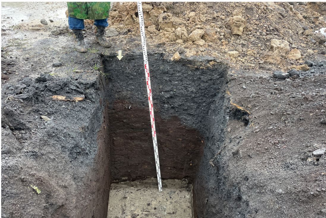
Рис. 34. Объект: «Строительство водогрейной котельной 400Гкал/час на территории Ивановской ТЭЦ-2», расположенной по адресу: РФ, Ивановская обл., г. Иваново, ул. Суворова, 76. Вид с С на стенку шурфа 3.
