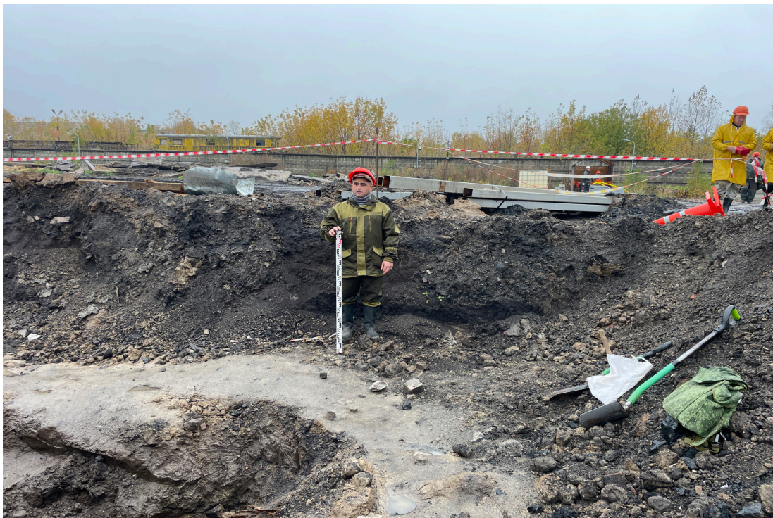
Рис. 24. Объект: «Строительство водогрейной котельной 400Гкал/час на территории Ивановской ТЭЦ-2», расположенной по адресу: РФ, Ивановская обл., г. Иваново, ул. Суворова, 76. Вид с В на разбивку шурфа 1.
