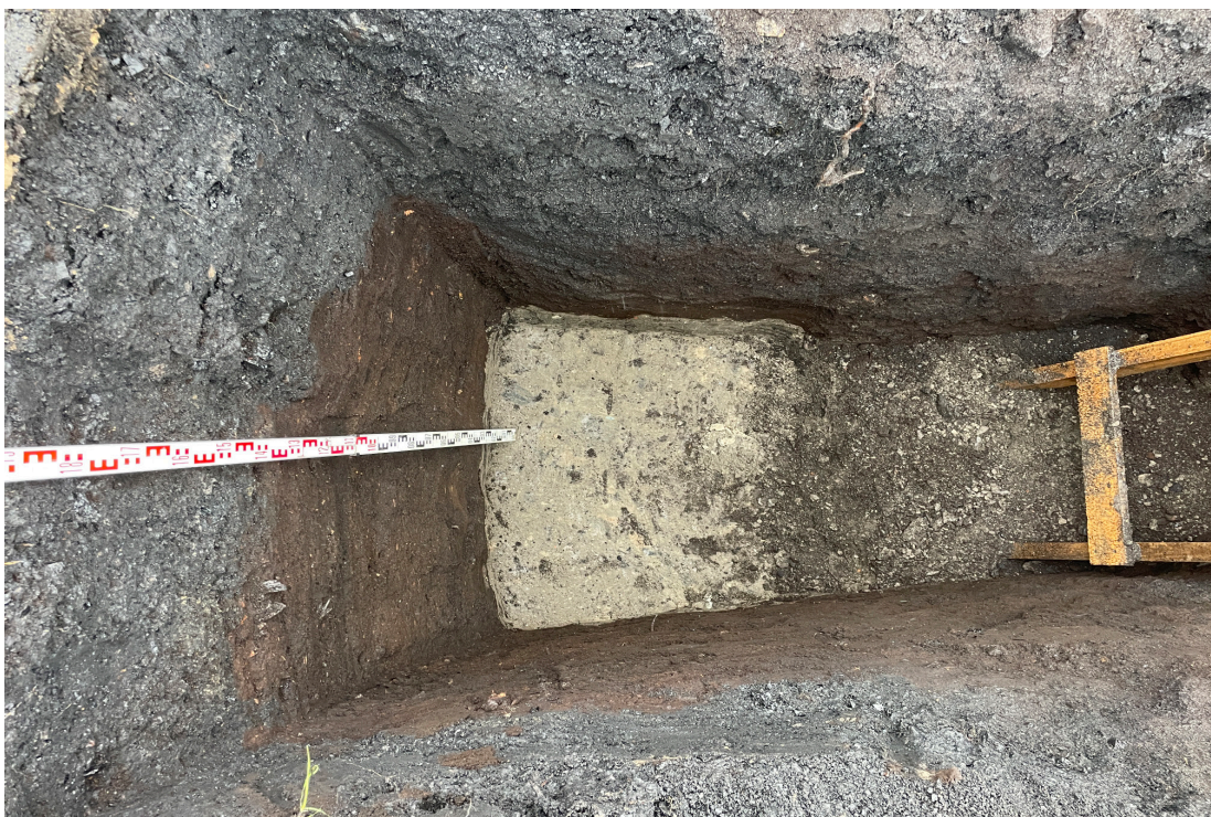
Рис. 35. Объект: «Строительство водогрейной котельной 400Гкал/час на территории Ивановской ТЭЦ-2», расположенной по адресу: РФ, Ивановская обл., г. Иваново, ул. Суворова, 76. Вид на дно шурфа 3.
