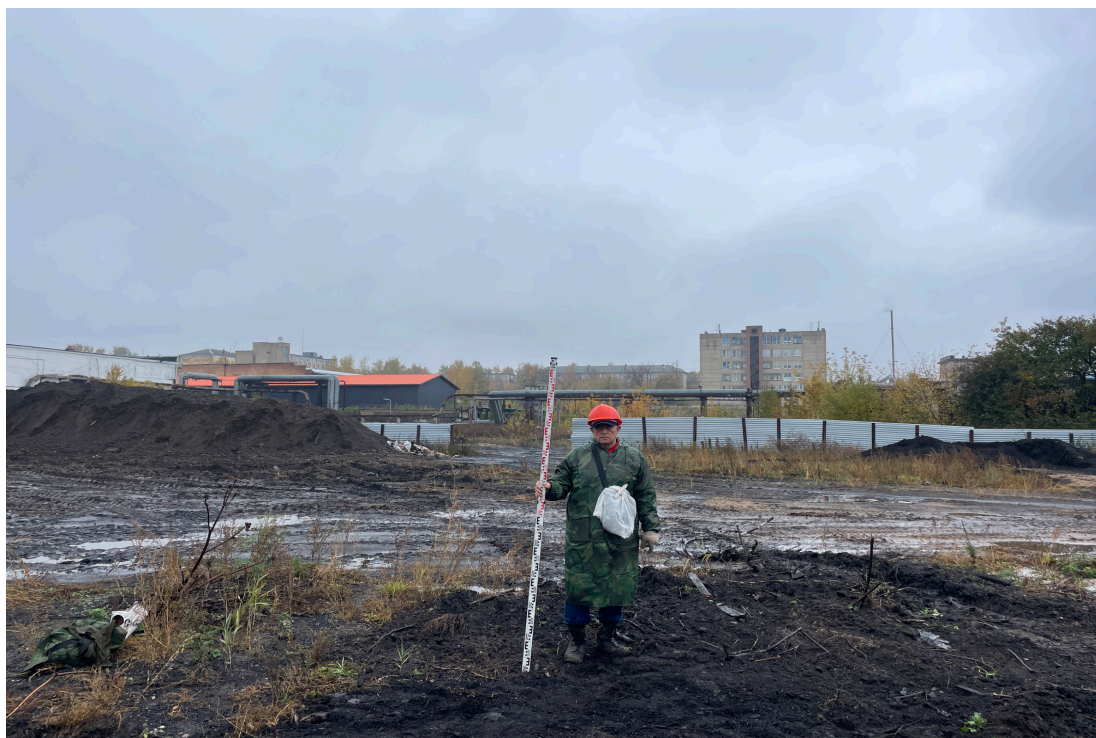
Рис. 38. Объект: «Строительство водогрейной котельной 400Гкал/час на территории Ивановской ТЭЦ-2», расположенной по адресу: РФ, Ивановская обл., г. Иваново, ул. Суворова, 76. Вид с Ю на разбивку шурфа 4.
