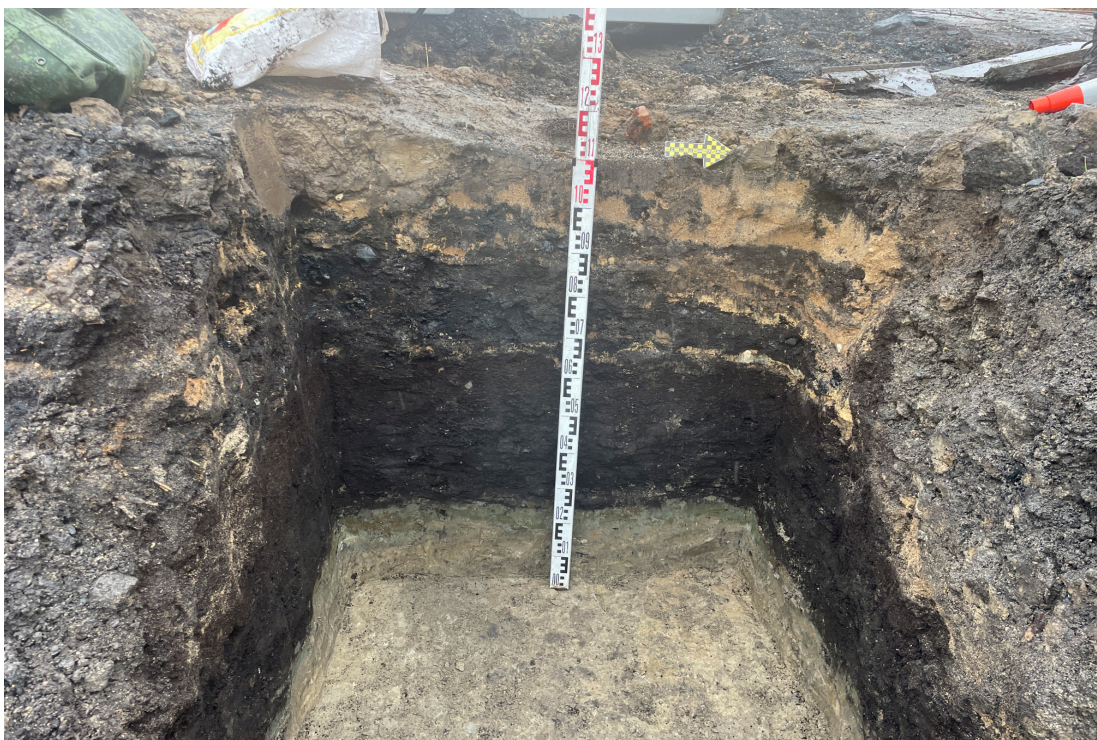
Рис. 25. Объект: «Строительство водогрейной котельной 400Гкал/час на территории Ивановской ТЭЦ-2», расположенной по адресу: РФ, Ивановская обл., г. Иваново, ул. Суворова, 76. Вид с В на стенку шурфа 1.
