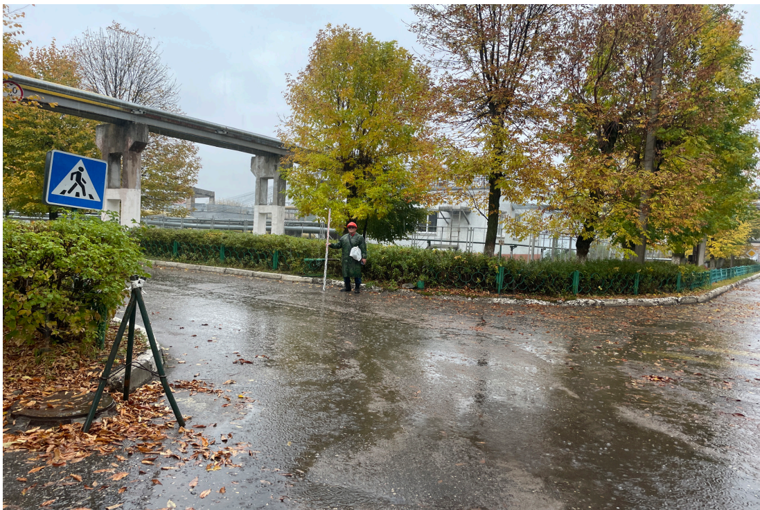
Рис. 22. Объект: «Строительство водогрейной котельной 400Гкал/час на территории Ивановской ТЭЦ-2», расположенной по адресу: РФ, Ивановская обл., г. Иваново, ул. Суворова, 76. Вид из тф 6 на СВ.
