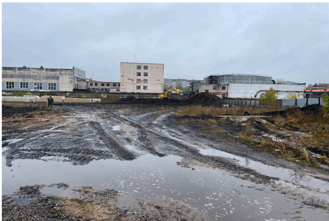
Рис. 17. Объект: «Строительство водогрейной котельной 400Гкал/час на территории Ивановской ТЭЦ-2», расположенной по адресу: РФ, Ивановская обл., г. Иваново, ул. Суворова, 76. Вид из тф 4 на 3.
