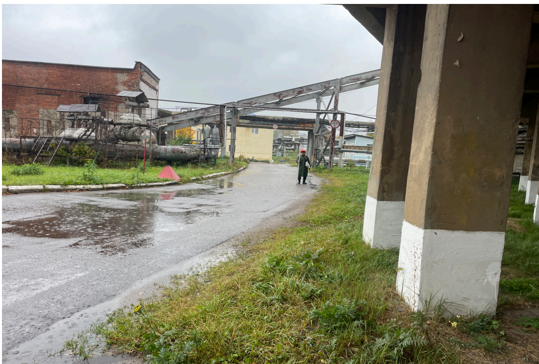
Рис. 21. Объект: «Строительство водогрейной котельной 400Гкал/час на территории Ивановской ТЭЦ-2», расположенной по адресу: РФ, Ивановская обл., г. Иваново, ул. Суворова, 76. Вид из тф 5 на С.
