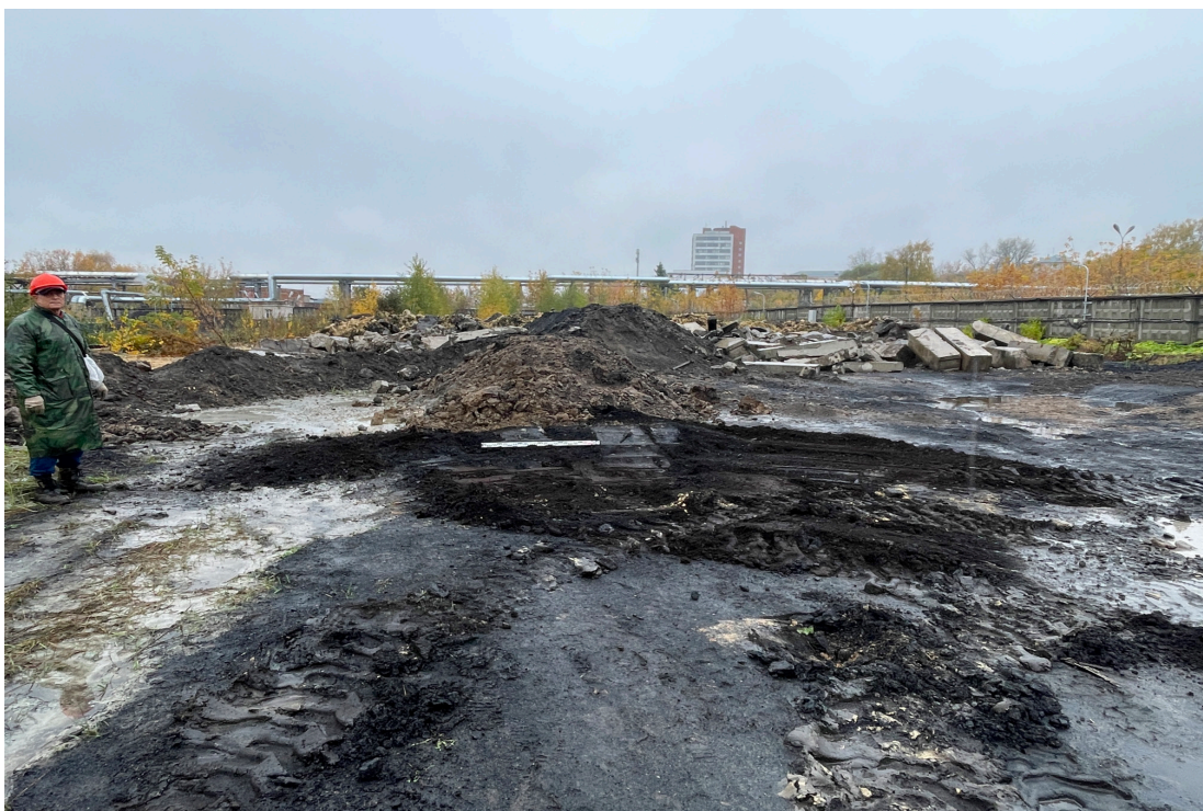
Рис. 37. Объект: «Строительство водогрейной котельной 400Гкал/час на территории Ивановской ТЭЦ-2», расположенной по адресу: РФ, Ивановская обл., г. Иваново, ул. Суворова, 76. Вид с С на рекультивацию шурфа 3.
