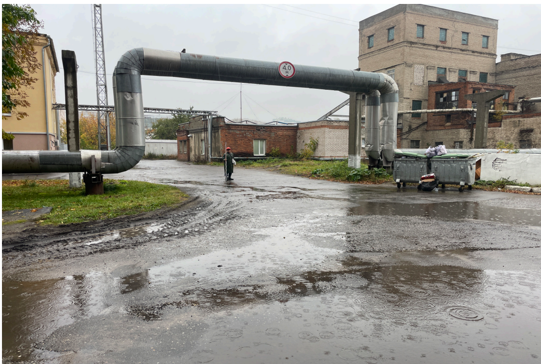
Рис. 20. Объект: «Строительство водогрейной котельной 400Гкал/час на территории Ивановской ТЭЦ-2», расположенной по адресу: РФ, Ивановская обл., г. Иваново, ул. Суворова, 76. Вид из тф 5 на 3.
