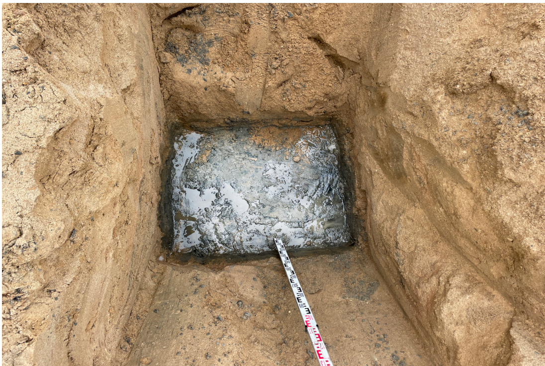
Рис. 30. Объект: «Строительство водогрейной котельной 400Гкал/час на территории Ивановской ТЭЦ-2», расположенной по адресу: РФ, Ивановская обл., г. Иваново, ул. Суворова, 76. Вид на дно шурфа 2.
