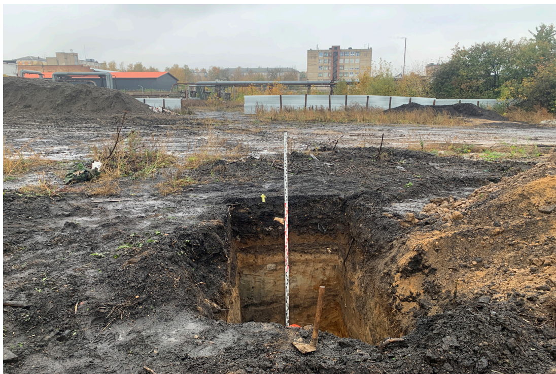
Рис. 39. Объект: «Строительство водогрейной котельной 400Гкал/час на территории Ивановской ТЭЦ-2», расположенной по адресу: РФ, Ивановская обл., г. Иваново, ул. Суворова, 76. Вид с Ю на стенку шурфа 4.
