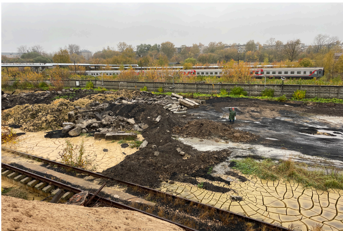
Рис. 15. Объект: «Строительство водогрейной котельной 400Гкал/час на территории Ивановской ТЭЦ-2», расположенной по адресу: РФ, Ивановская обл., г. Иваново, ул. Суворова, 76. Вид из тф 3 на ЮЗ.
