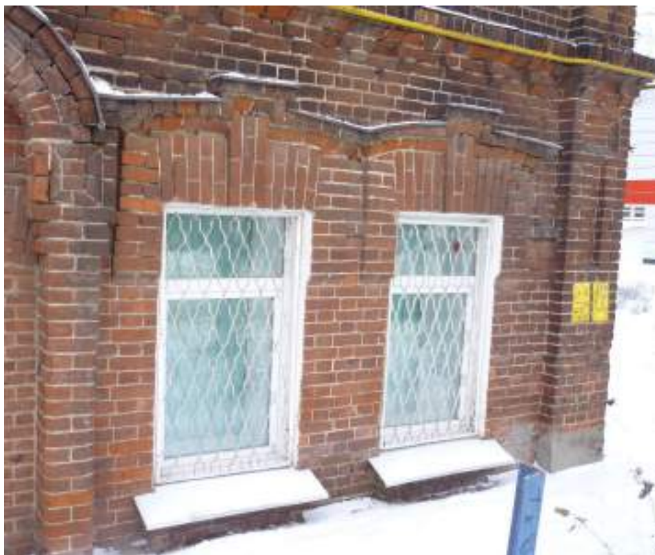
5. Окна первого этажа
