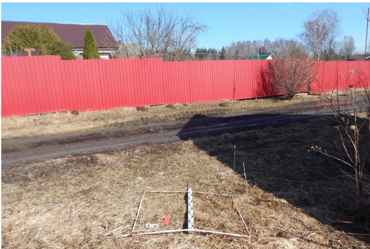
Рис. 132. Ивановская область, Ивановский район, с. Озёрный, распределительный газопровод. Шурф № 13, разметка и общий вид с юга.
