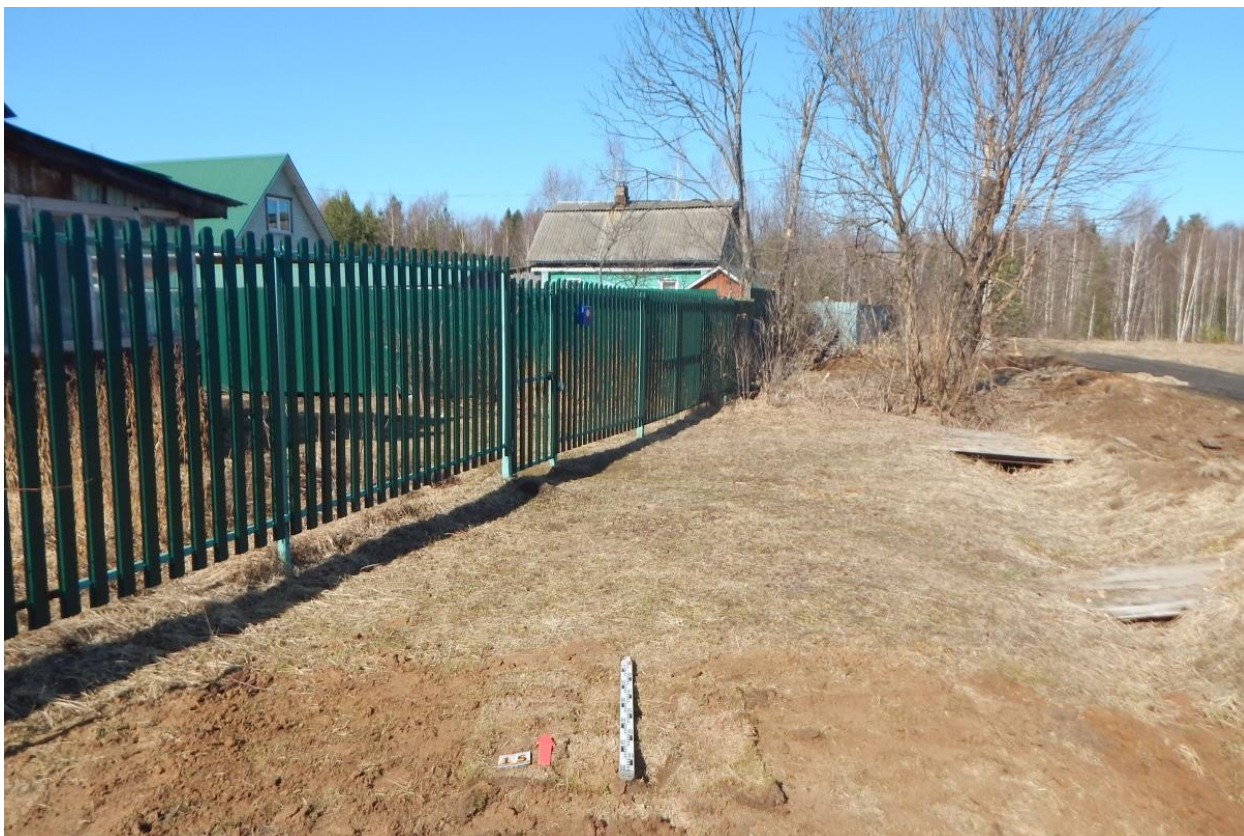
Рис. 145. Ивановская область, Ивановский район, с. Озёрный, распределительный газопровод. Шурф № 15, рекультивация, вид с юга.
