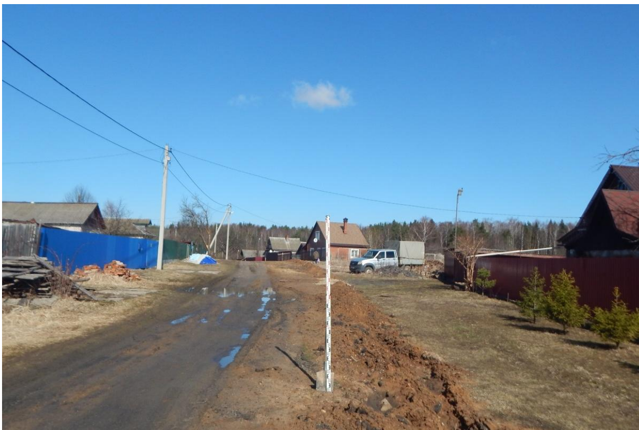
Рис. 66. Ивановская область, Ивановский район, с. Озёрный, распределительный газопровод. Общий вид с юга. Точка фотофиксации 13.
