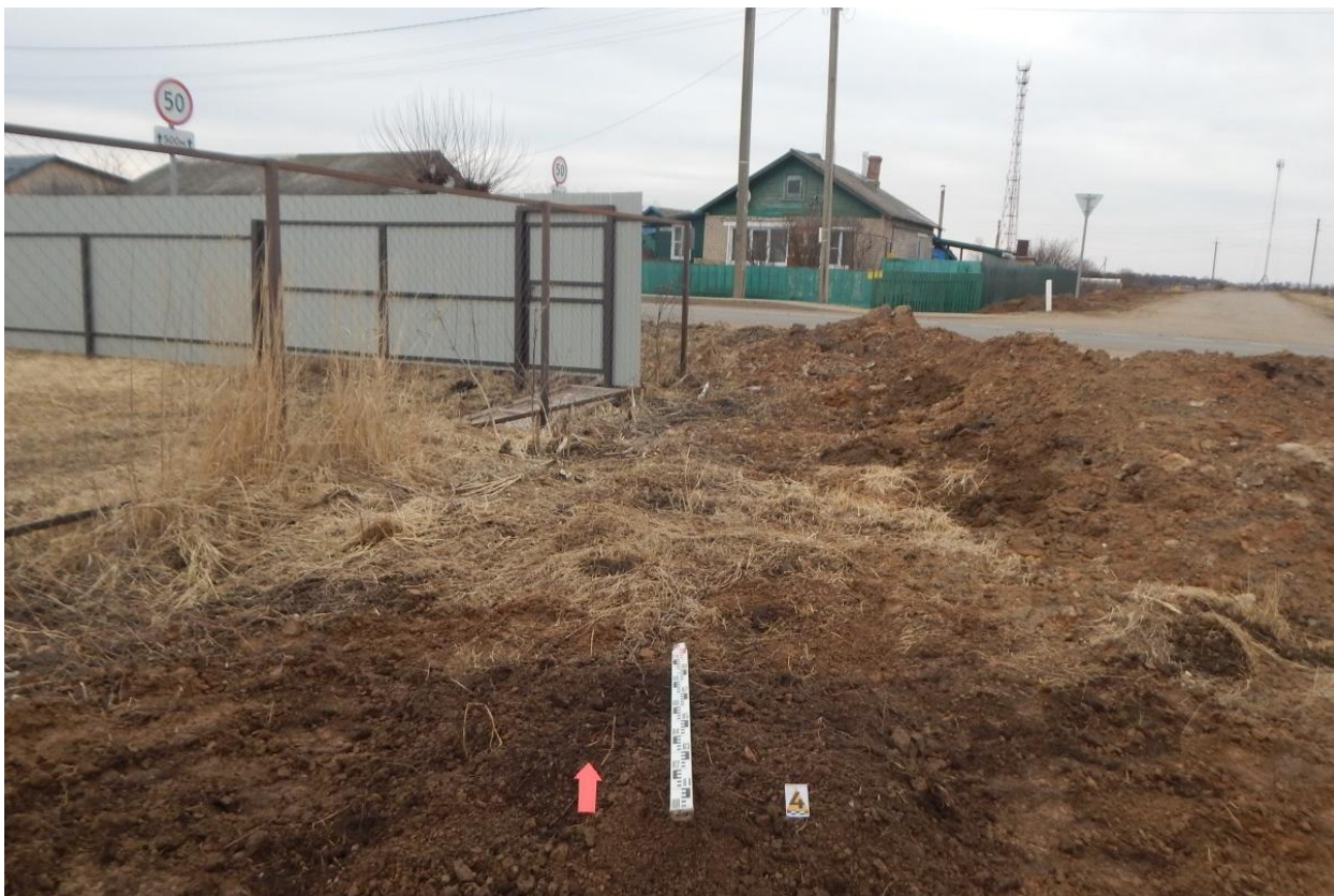
Рис. 91. Ивановская область, Ивановский район, с. Озёрный, распределительный газопровод. Шурф № 4, рекультивация, вид с юга.
