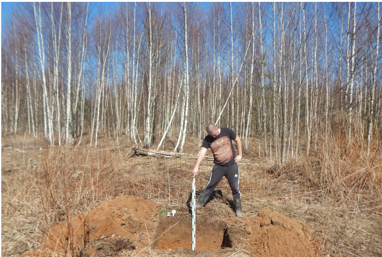
Рис. 187. Ивановская область, Ивановский район, д. Каликино, распределительный газопровод. Общий вид с юга выкопанного шурфа № 5.
