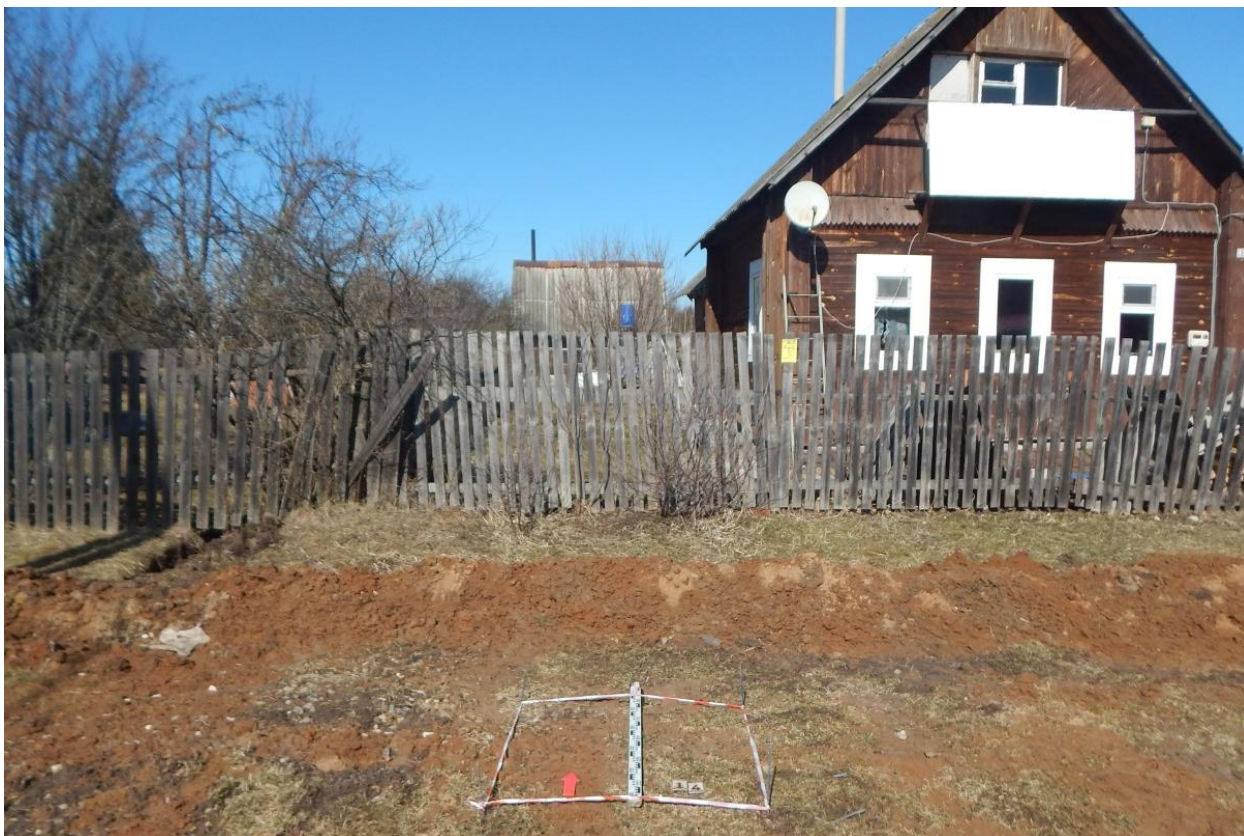
Рис. 137. Ивановская область, Ивановский район, с. Озёрный, распределительный газопровод. Шурф № 14, разметка и общий вид с юга.
