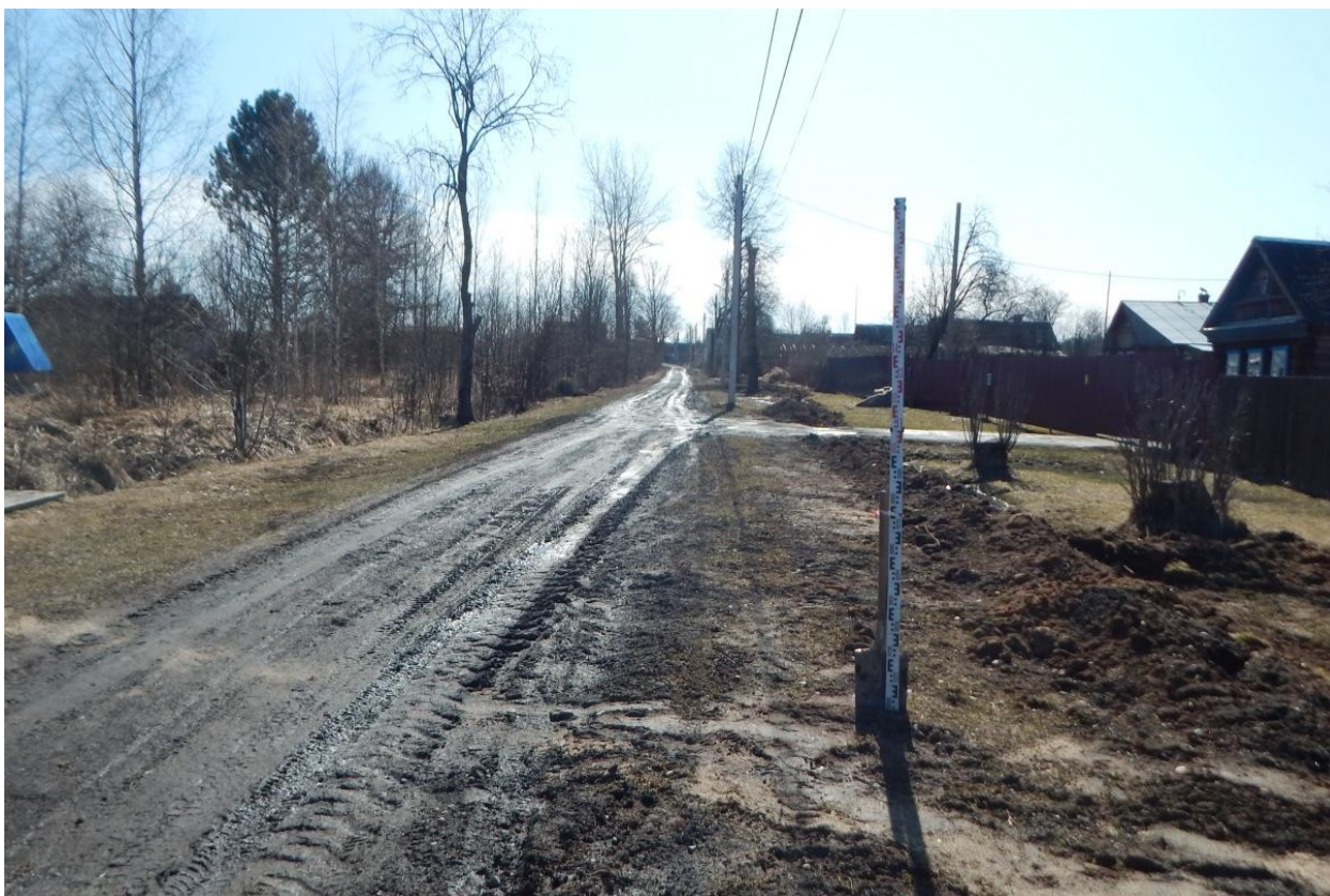
Рис. 70. Ивановская область, Ивановский район, с. Озёрный, распределительный газопровод. Общий вид с северо-северо-востока. Точка фотофиксации 15.
