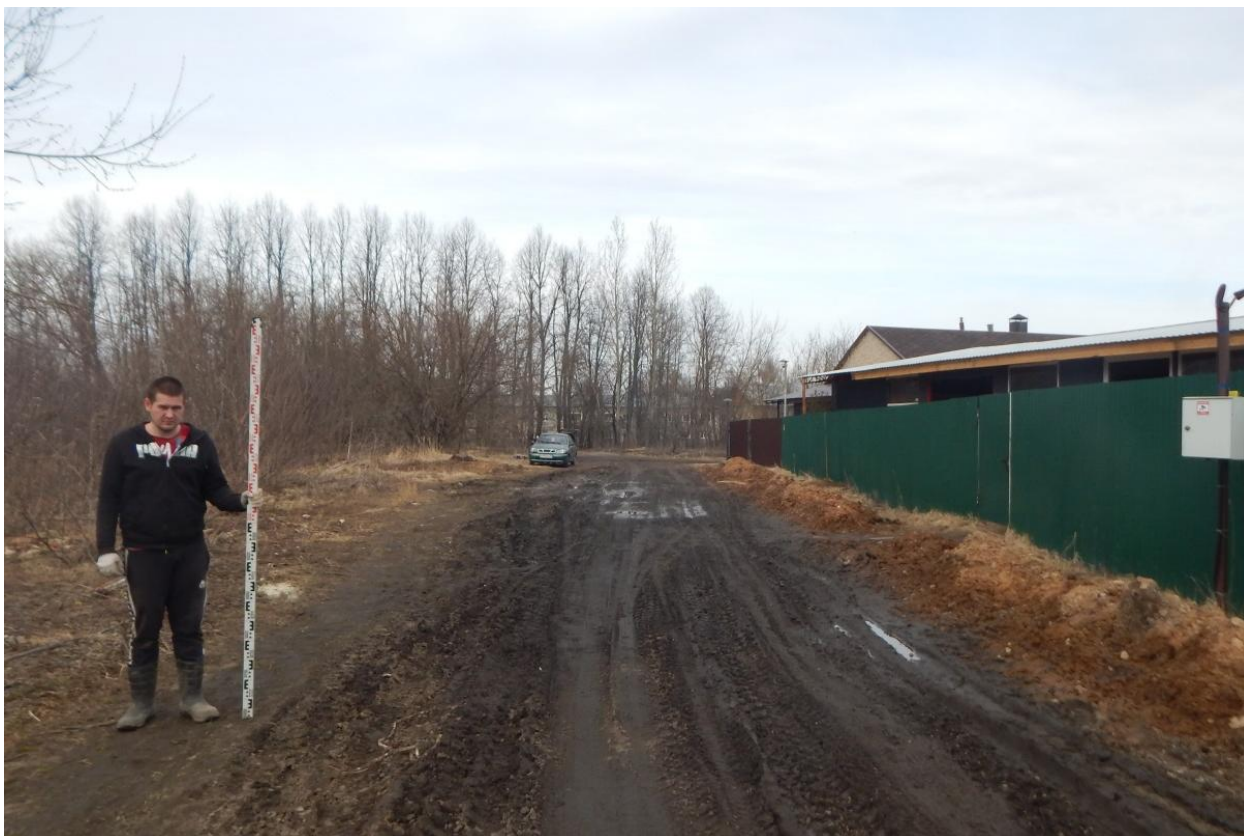
Рис. 49. Ивановская область, Ивановский район, с. Озёрный, распределительный газопровод. Общий вид с юга. Точка фотофиксации 6.
