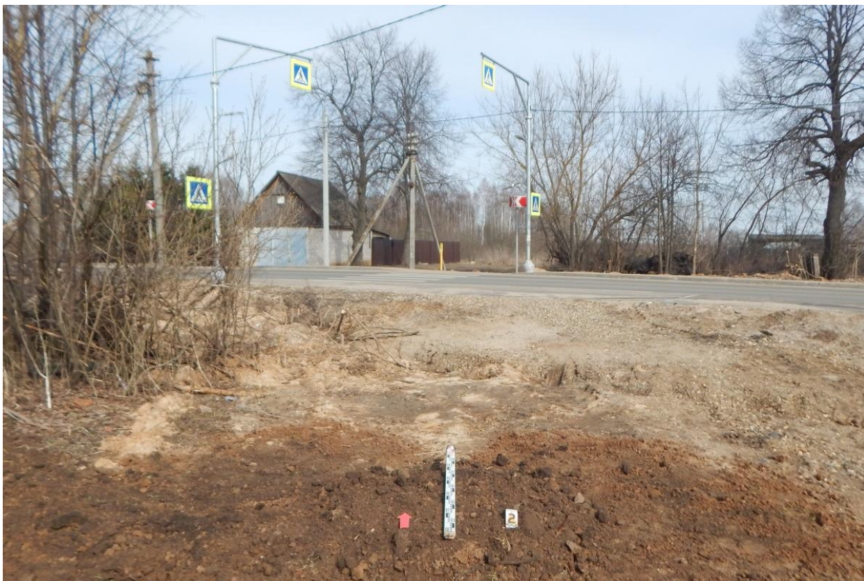
Рис. 81. Ивановская область, Ивановский район, с. Озёрный, распределительный газопровод. Шурф № 2, рекультивация, вид с юга.
