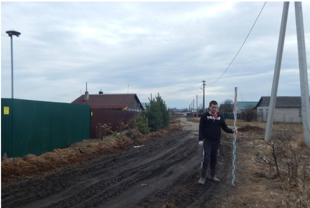
Рис. 48. Ивановская область, Ивановский район, с. Озёрный, распределительный газопровод. Общий вид с северо-запада. Точка фотофиксации 6.
