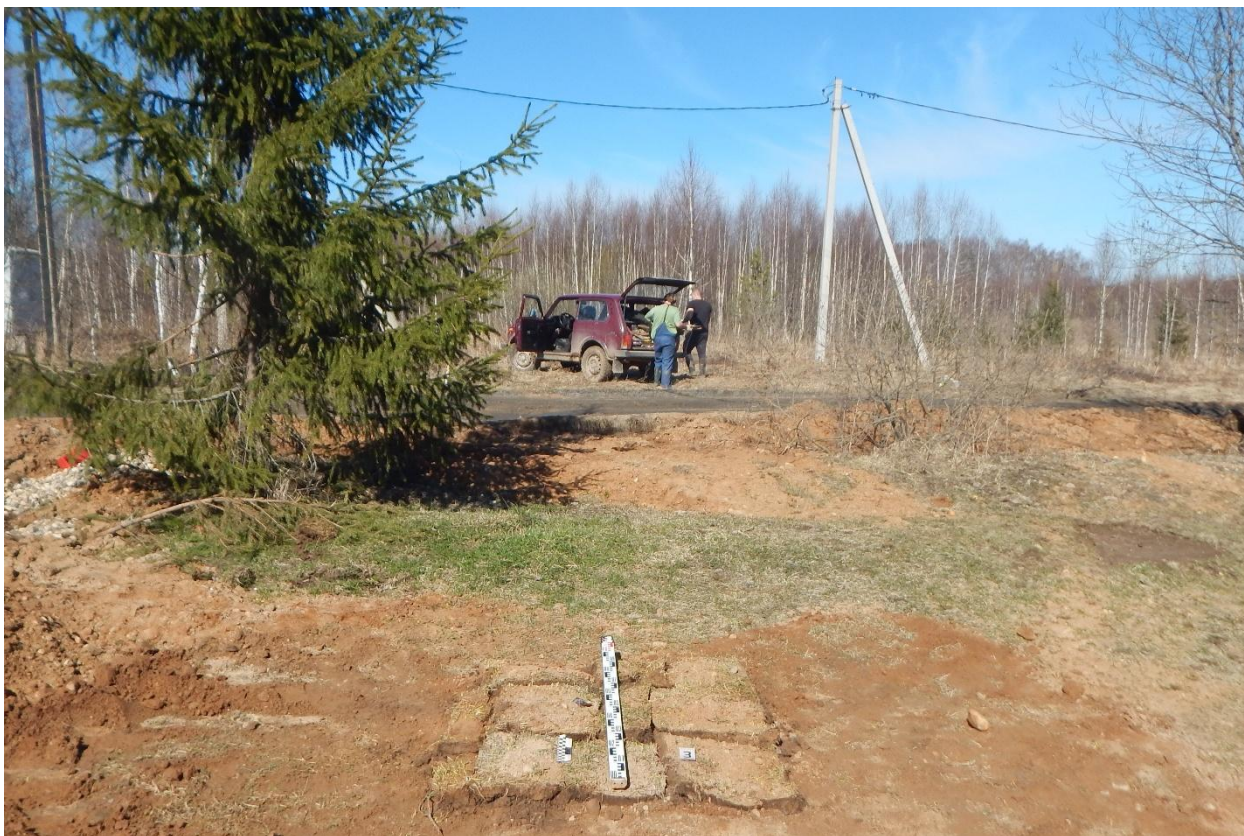
Рис. 178. Ивановская область, Ивановский район, д. Каликино, распределительный газопровод. Шурф № 3, рекультивация, вид с юга.
