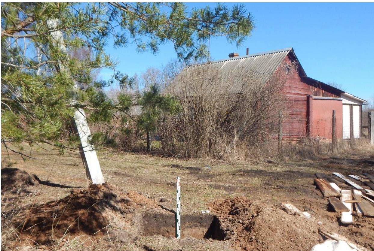
Рис. 172. Ивановская область, Ивановский район, д. Каликино, распределительный газопровод. Общий вид с юга выкопанного шурфа № 2.
