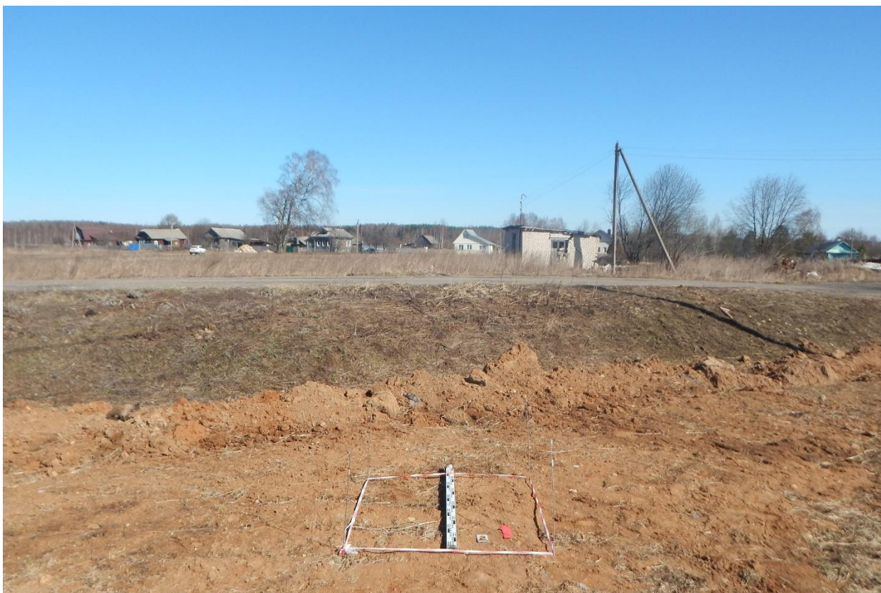
Рис. 221. Ивановская область, Ивановский район, д. Максаки, распределительный газопровод. Шурф № 2, разметка и общий вид с юга.
