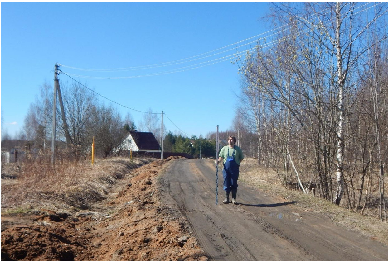
Рис. 159. Ивановская область, Ивановский район, д. Каликино, распределительный газопровод. Общий вид с востока. Точка фотофиксации 3.
