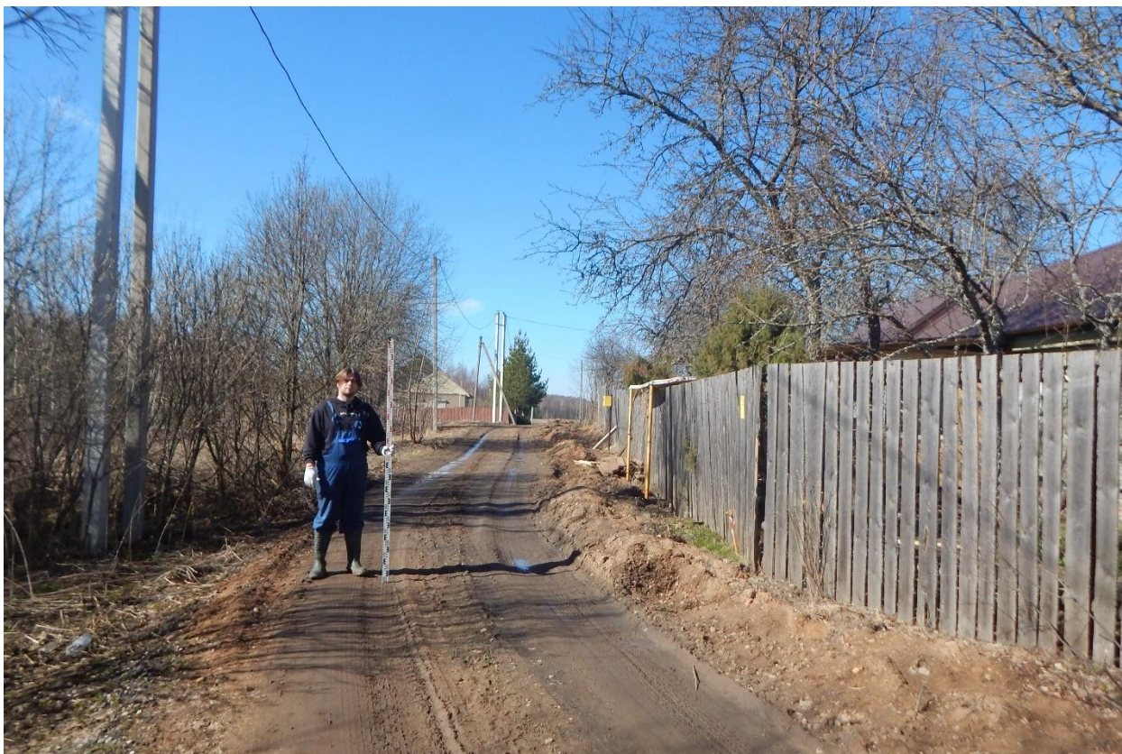
Рис. 156. Ивановская область, Ивановский район, д. Каликино, распределительный газопровод. Общий вид с юго-юго-запада. Точка фотофиксации 2.
