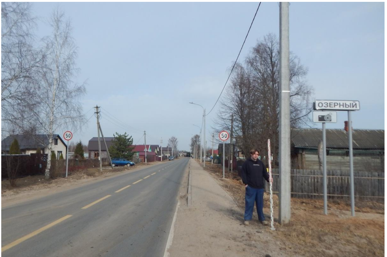
Рис. 36. Ивановская область, Ивановский район, с. Озёрный, распределительный газопровод. Общий вид с юго-востока. Точка фотофиксации 1.
