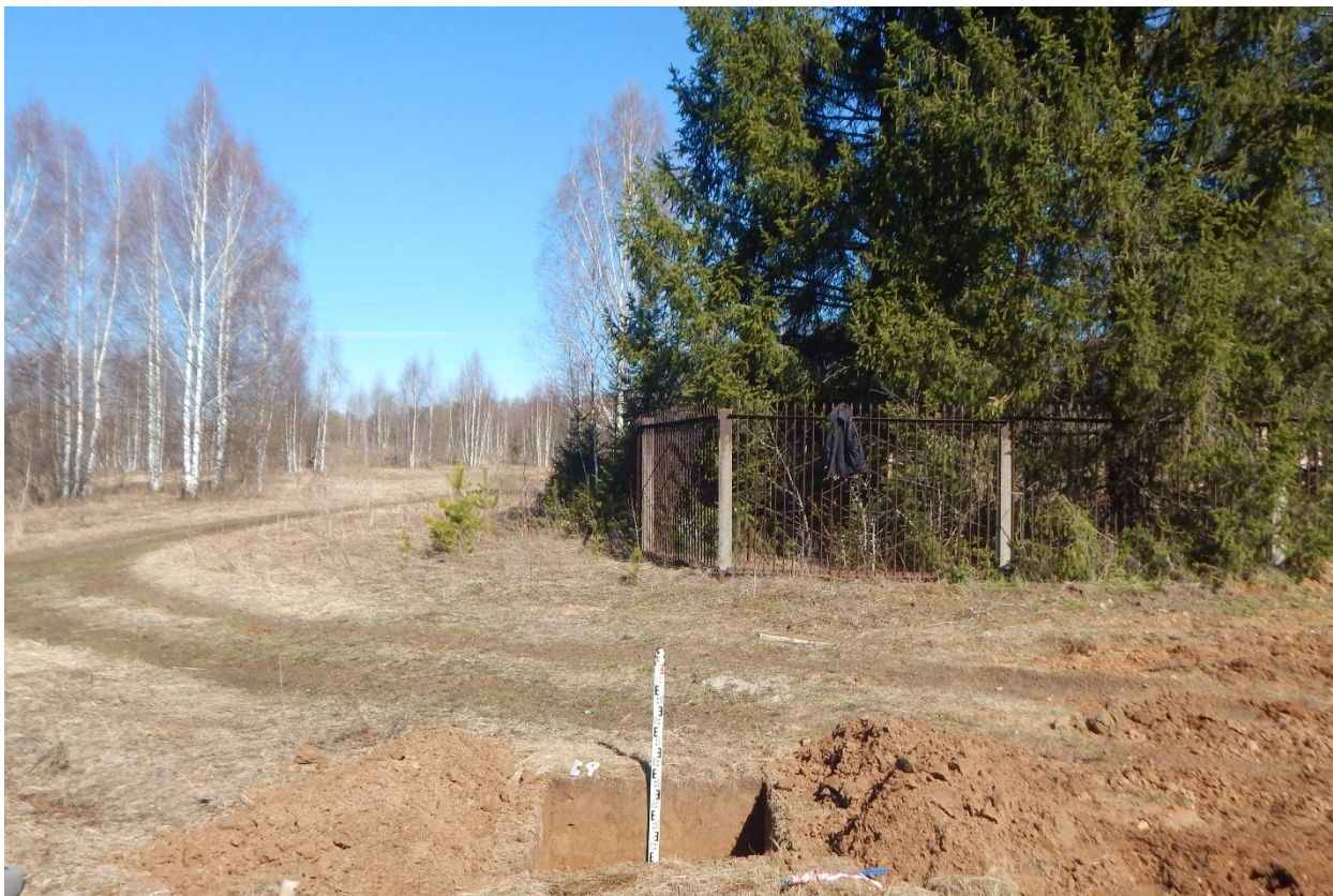
Рис. 167. Ивановская область, Ивановский район, д. Каликино, распределительный газопровод. Общий вид с юга выкопанного шурфа № 1.
