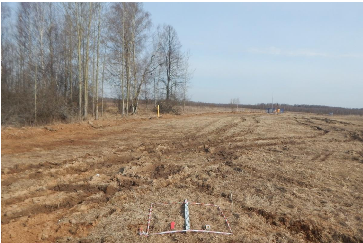
Рис. 82. Ивановская область, Ивановский район, с. Озёрный, распределительный газопровод. Шурф № 3, разметка и общий вид с юга.
