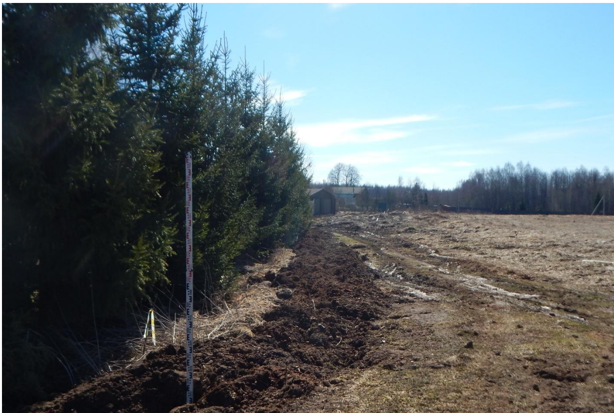
Рис. 161. Ивановская область, Ивановский район, д. Каликино, распределительный газопровод. Общий вид с северо-запада. Точка фотофиксации 4.
