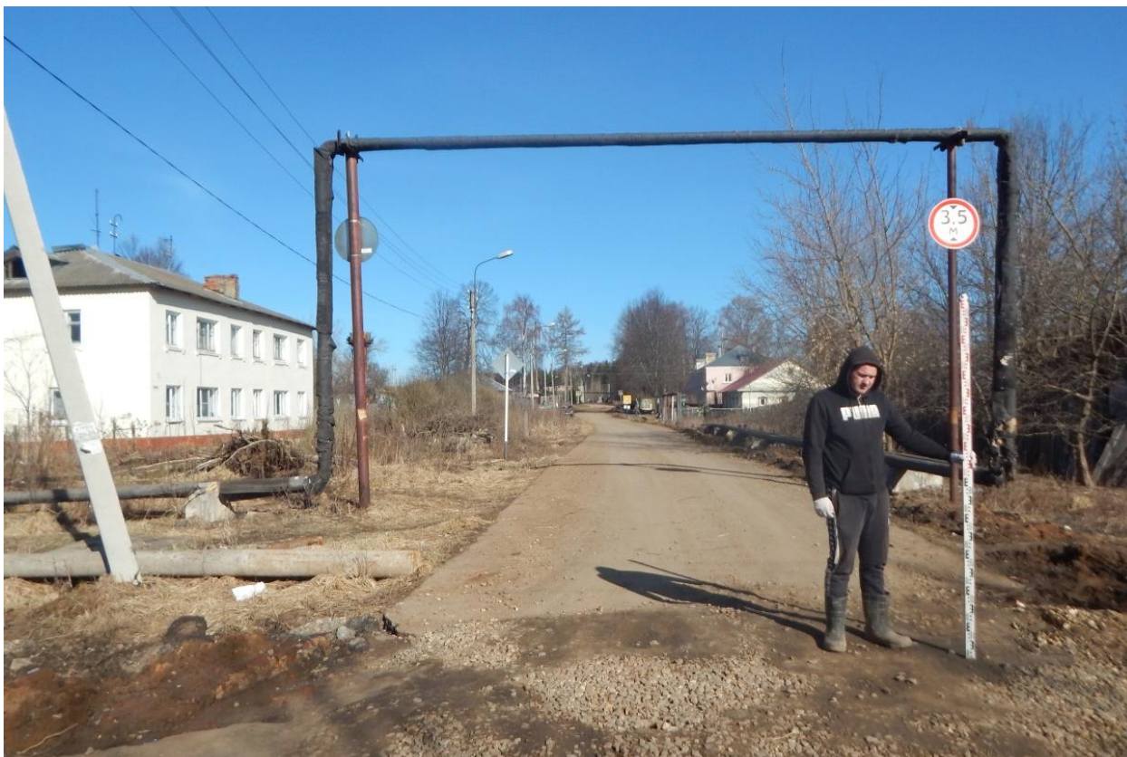
Рис. 61. Ивановская область, Ивановский район, с. Озёрный, распределительный газопровод. Общий вид с юго-юго-востока. Точка фотофиксации 11.
