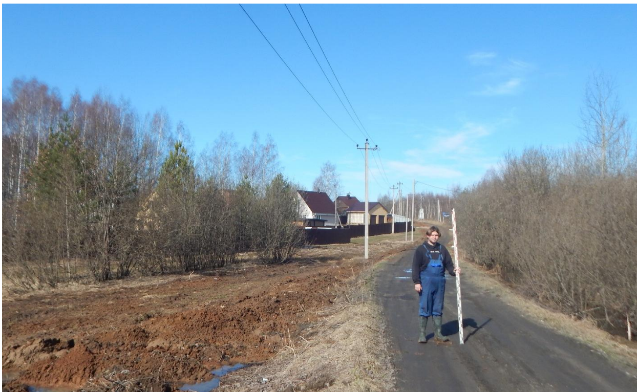
Рис. 154. Ивановская область, Ивановский район, д. Каликино, распределительный газопровод. Общий вид с востока-юго-востока. Точка фотофиксации 1.
