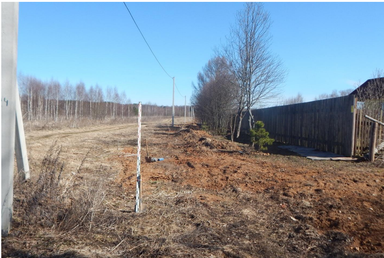
Рис. 209. Ивановская область, Ивановский район, д. Максаки, распределительный газопровод. Общий вид с юго-запада. Точка фотофиксации 3.
