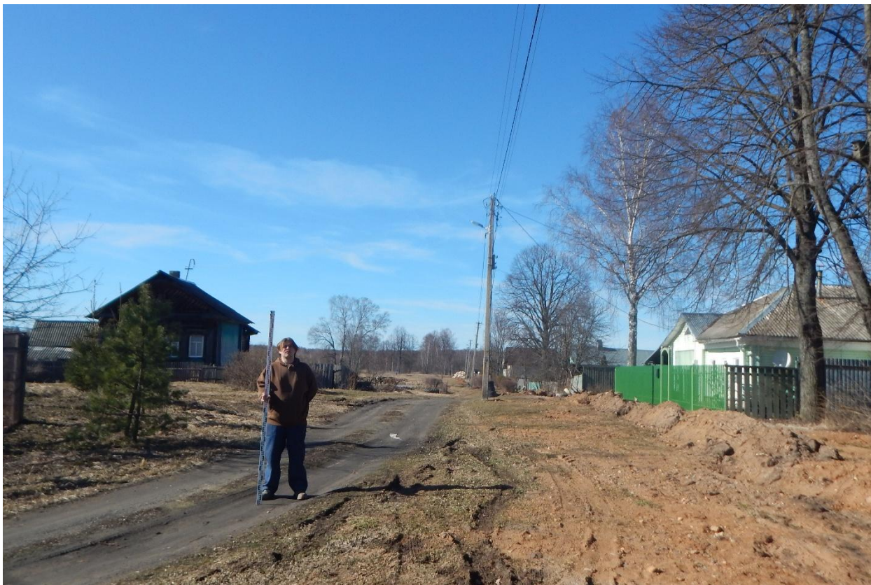
Рис. 211. Ивановская область, Ивановский район, д. Максаки, распределительный газопровод. Общий вид с юго-востока. Точка фотофиксации 4.
