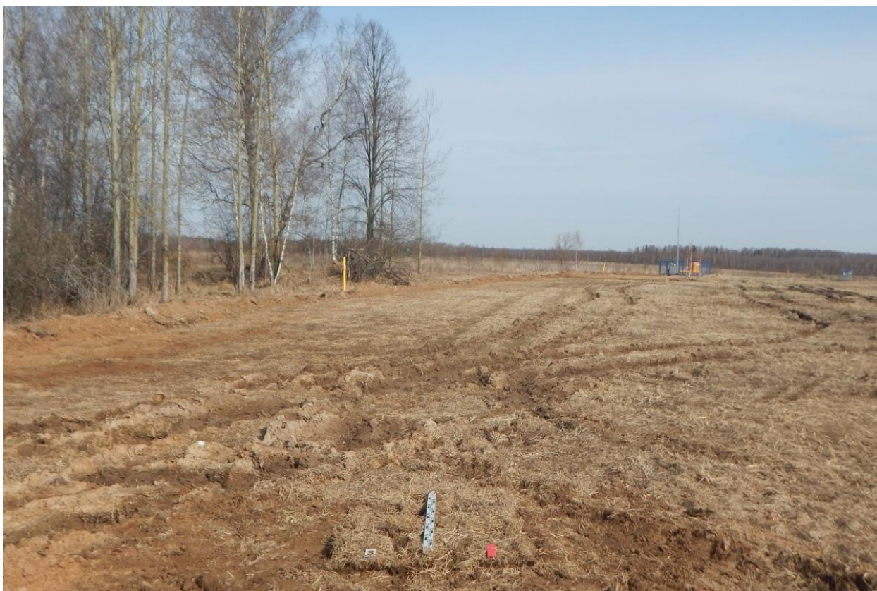
Рис. 86. Ивановская область, Ивановский район, с. Озёрный, распределительный газопровод. Шурф № 3, рекультивация, вид с юга.
