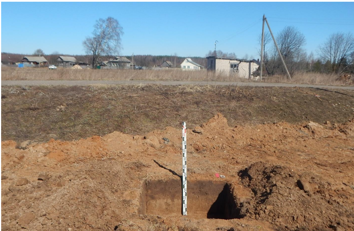
Рис. 224. Ивановская область, Ивановский район, д. Максаки, распределительный газопровод. Общий вид с юга выкопанного шурфа № 2.
