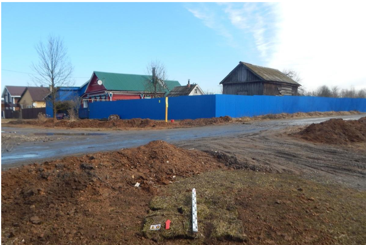
Рис. 121. Ивановская область, Ивановский район, с. Озёрный, распределительный газопровод. Шурф № 10, рекультивация, вид с юга.
