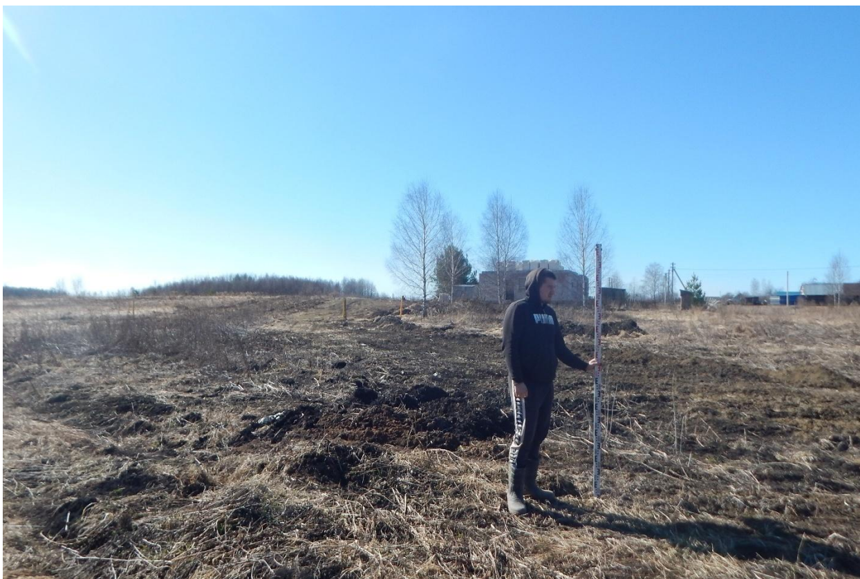
Рис. 215. Ивановская область, Ивановский район, д. Максаки, распределительный газопровод. Общий вид с востока. Точка фотофиксации 6.
