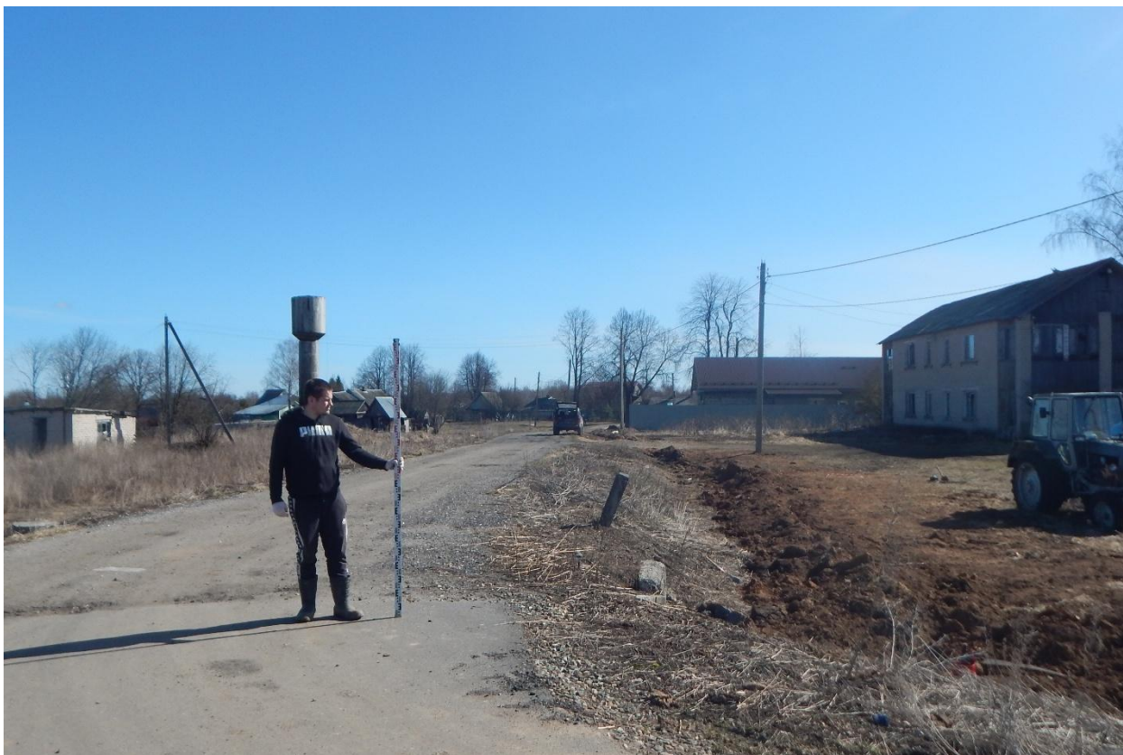
Рис. 208. Ивановская область, Ивановский район, д. Макасы, распределительный газопровод. Общий вид с запада. Точка фотофиксации 2.
