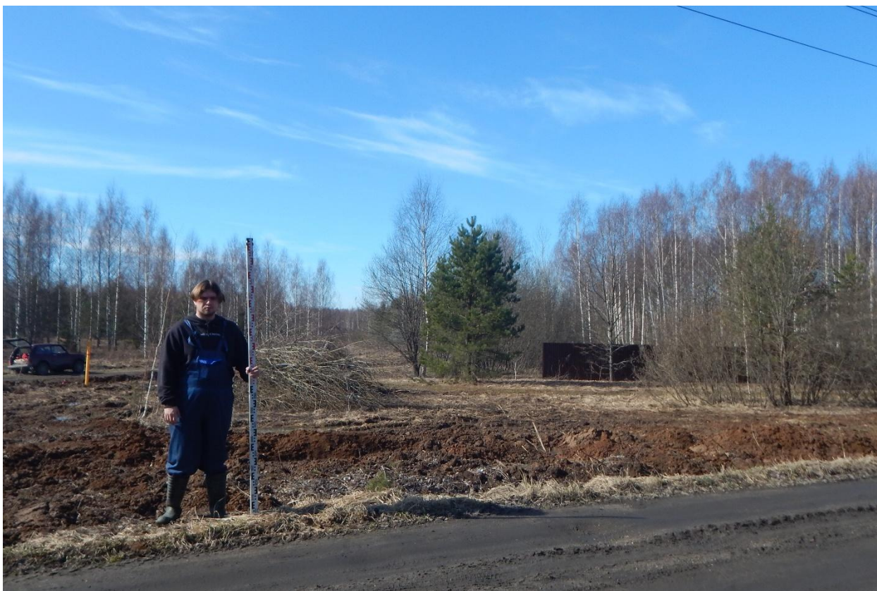
Рис. 153. Ивановская область, Ивановский район, д. Каликино, распределительный газопровод. Общий вид с северо-северо-востока. Точка фотофиксации 1.
