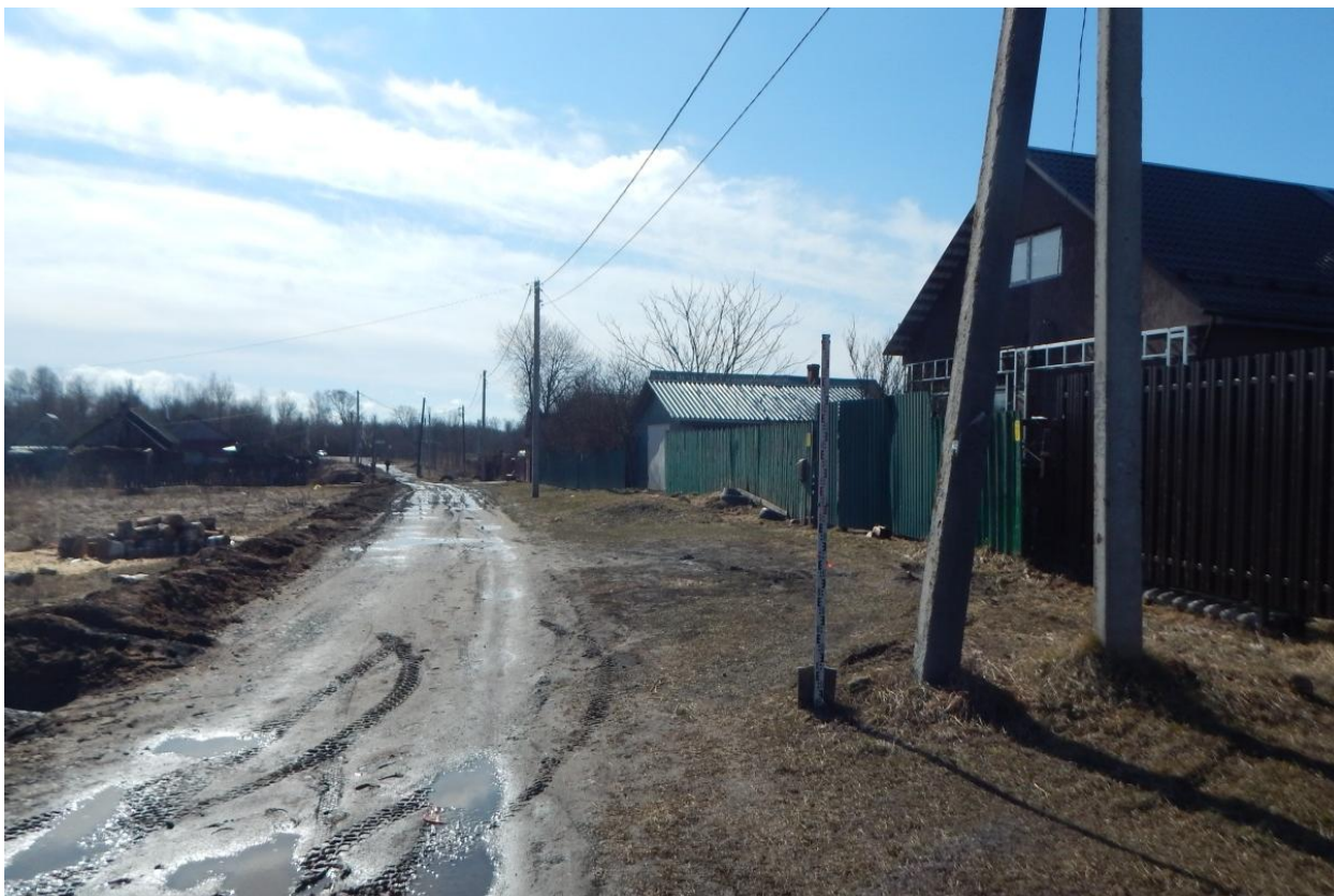
Рис. 65. Ивановская область, Ивановский район, с. Озёрный, распределительный газопровод. Общий вид с севера. Точка фотофиксации 13.
