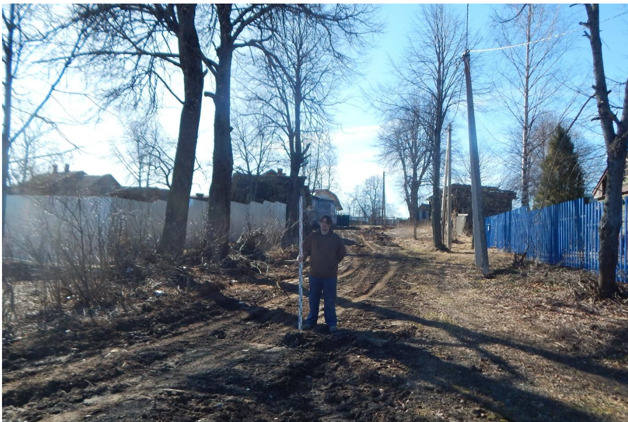
Рис. 214. Ивановская область, Ивановский район, д. Максаки, распределительный газопровод. Общий вид с востока. Точка фотофиксации 5.
