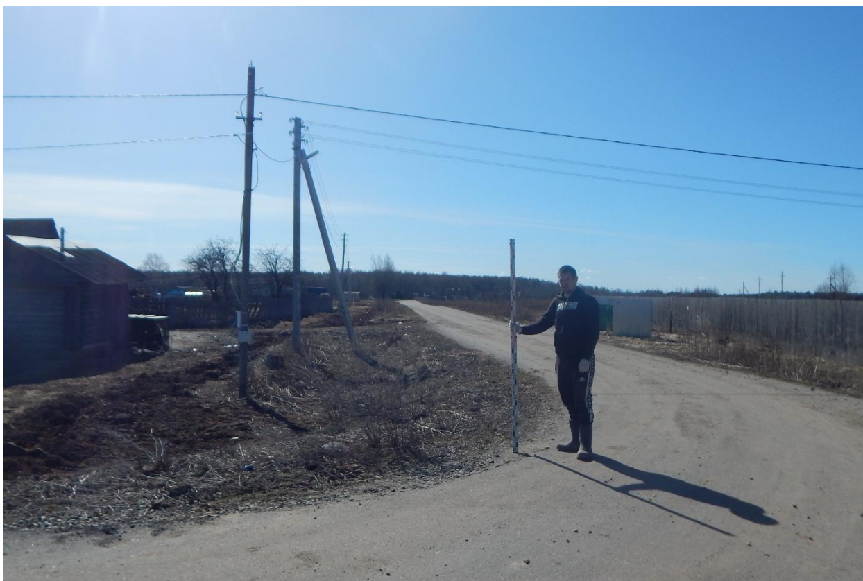
Рис. 207. Ивановская область, Ивановский район, д. Макасы, распределительный газопровод. Общий вид с севера. Точка фотофиксации 2.
