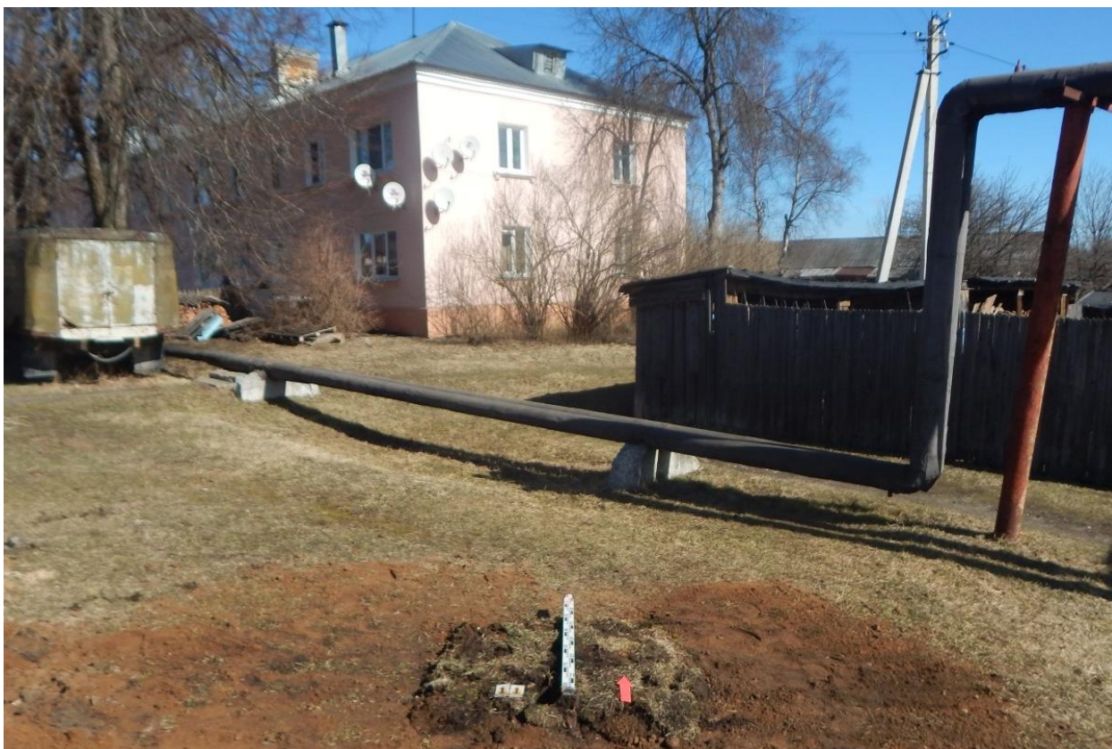
Рис. 126. Ивановская область, Ивановский район, с. Озёрный, распределительный газопровод. Шурф № 11, рекультивация, вид с юга.
