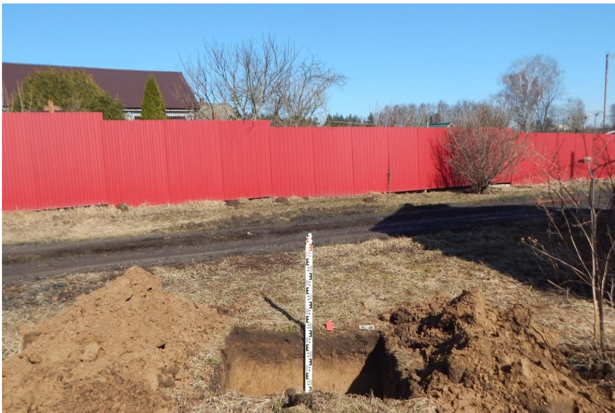
Рис. 135. Ивановская область, Ивановский район, с. Озёрный, распределительный газопровод. Общий вид с юга выкопанного шурфа № 13.
