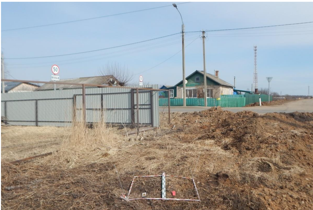
Рис. 87. Ивановская область, Ивановский район, с. Озёрный, распределительный газопровод. Шурф № 4, разметка и общий вид с юга.
