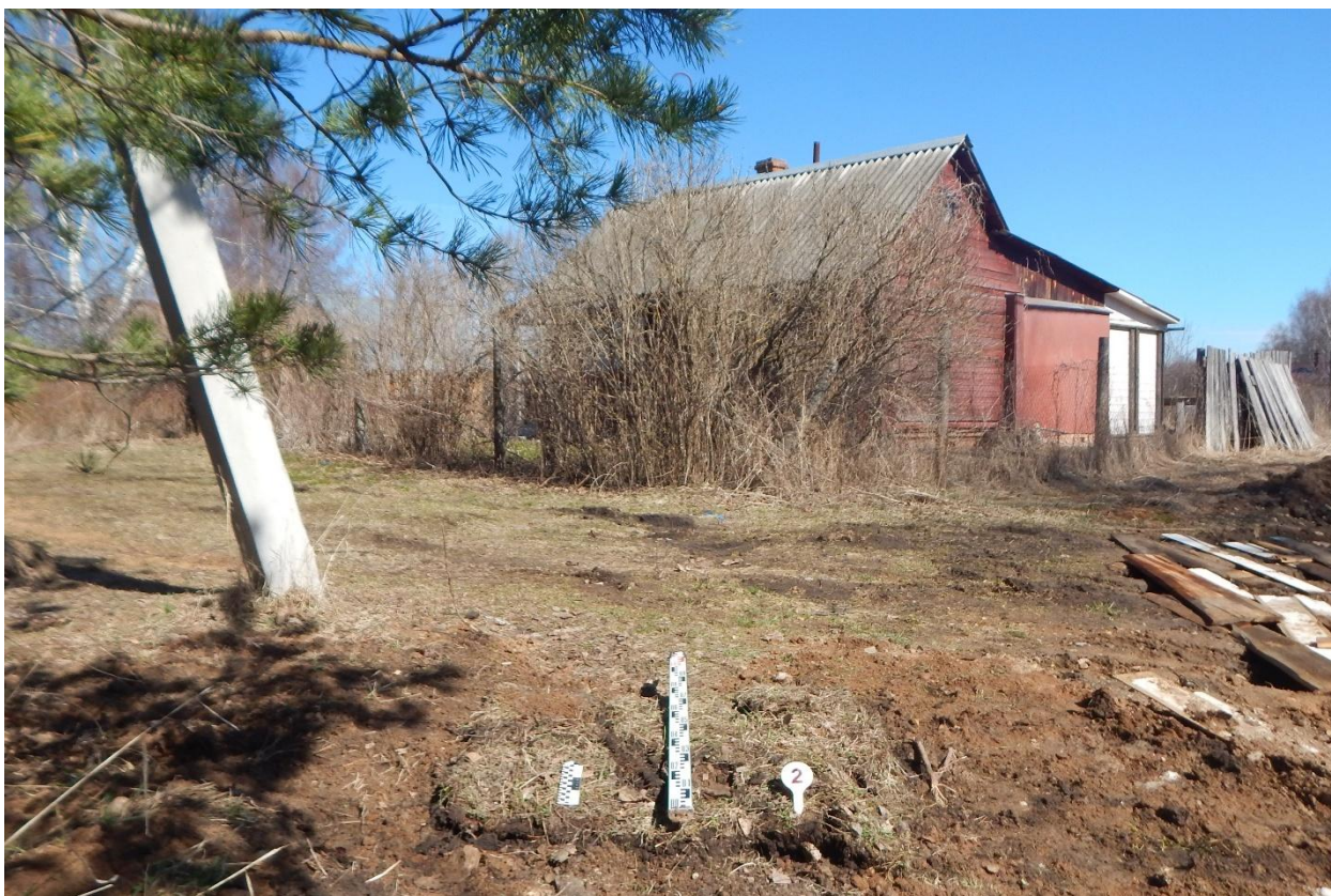
Рис. 173. Ивановская область, Ивановский район, д. Каликино, распределительный газопровод. Шурф № 2, рекультивация, вид с юга.
