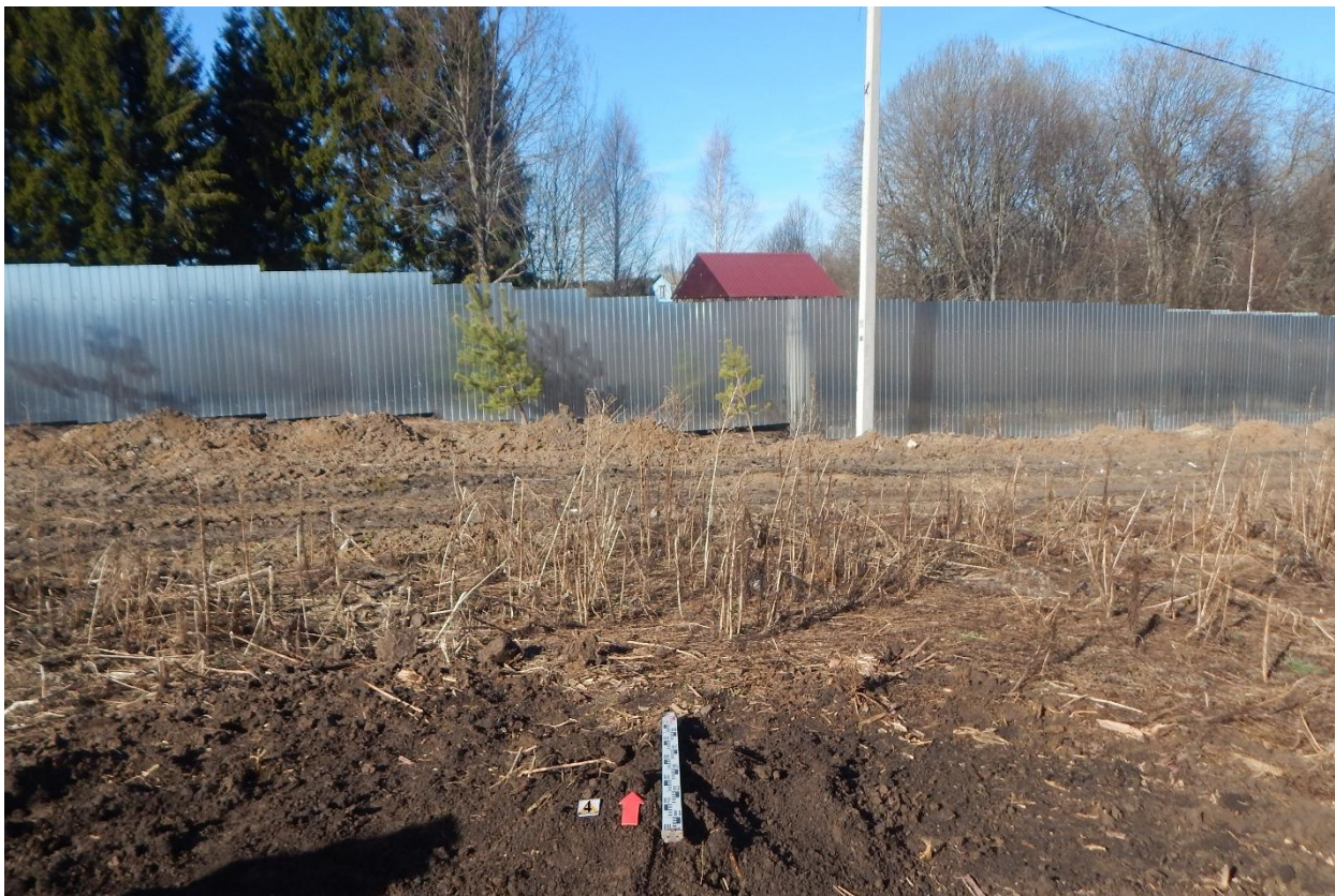
Рис. 235. Ивановская область, Ивановский район, д. Максаки, распределительный газопровод. Шурф № 4, рекультивация, вид с юга.
