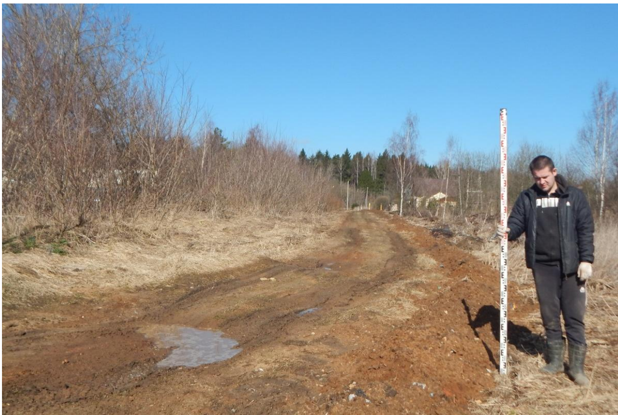
Рис. 63. Ивановская область, Ивановский район, с. Озёрный, распределительный газопровод. Общий вид с юго-юго-востока. Точка фотофиксации 12.
