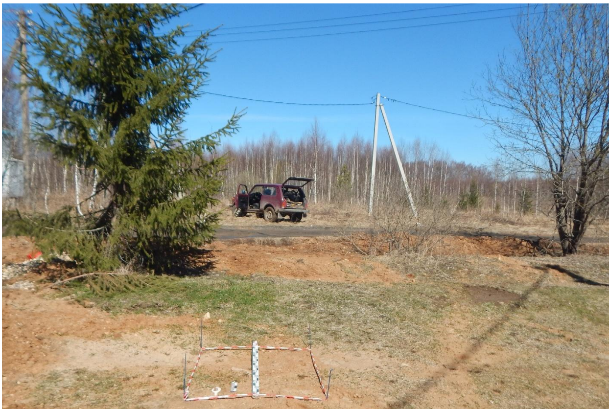
Рис. 174. Ивановская область, Ивановский район, д. Каликино, распределительный газопровод. Шурф № 3, разметка и общий вид с юга.
