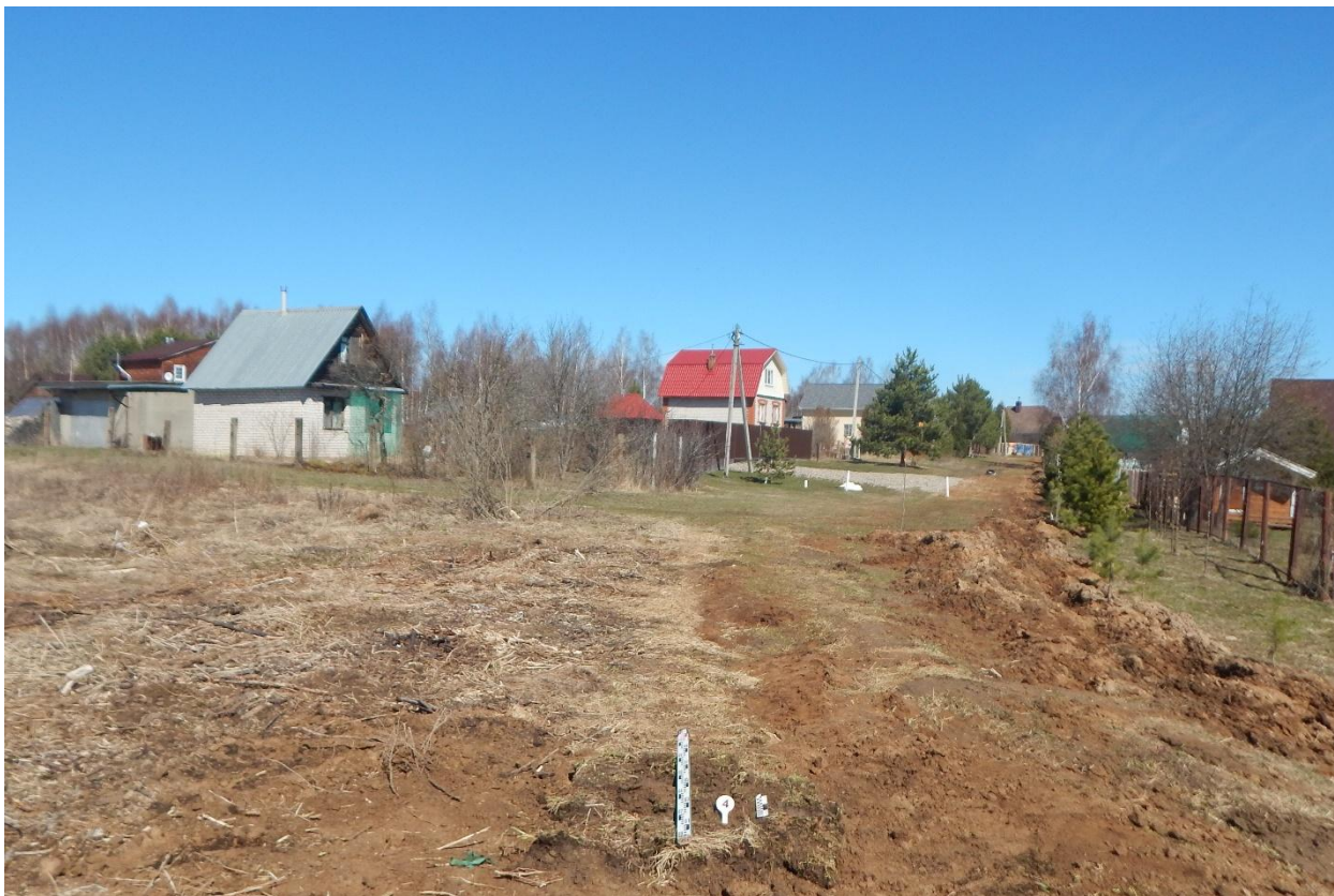
Рис. 183. Ивановская область, Ивановский район, д. Каликино, распределительный газопровод. Шурф № 4, рекультивация, вид с юга.
