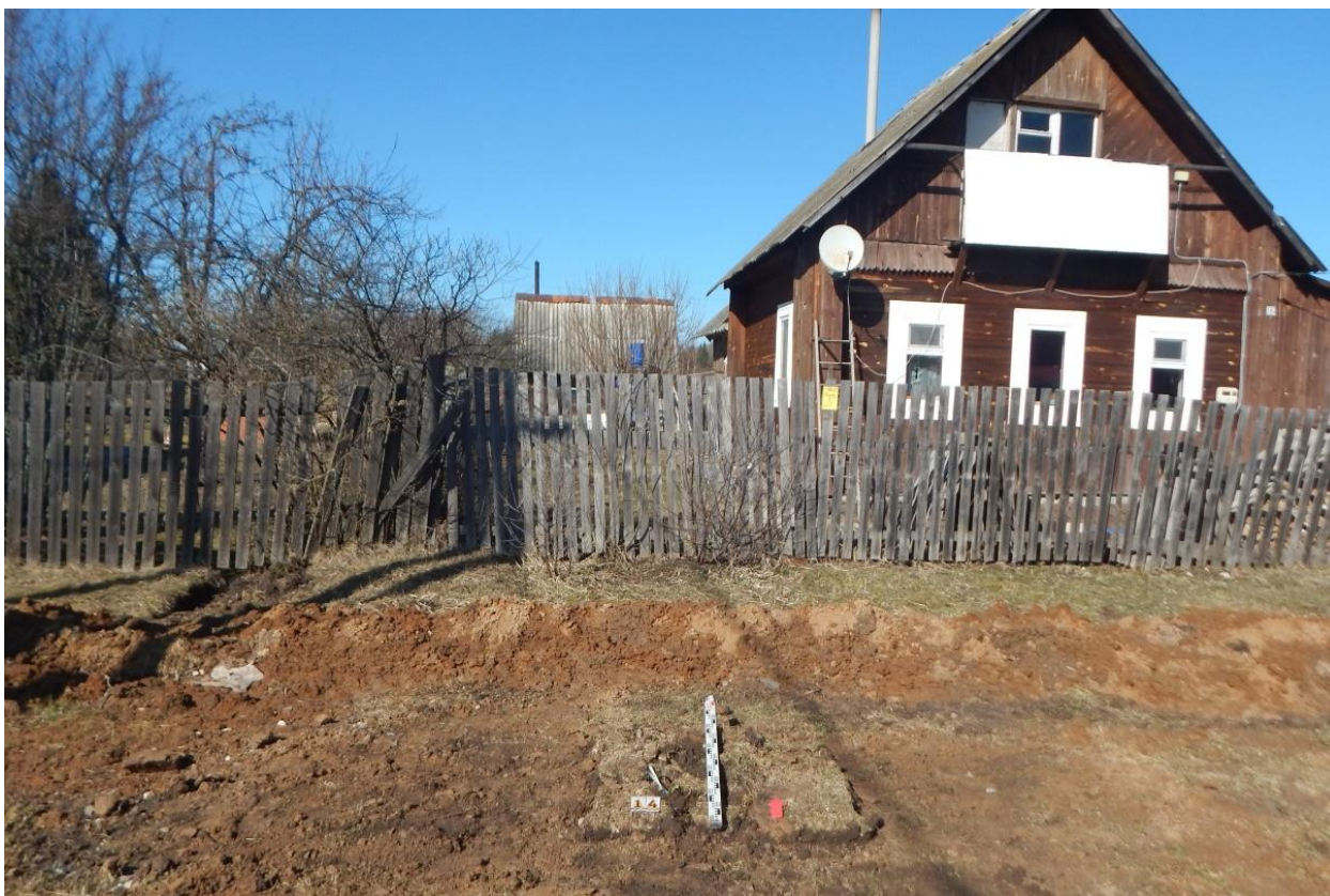
Рис. 140. Ивановская область, Ивановский район, с. Озёрный, распределительный газопровод. Шурф № 14, рекультивация, вид с юга.
