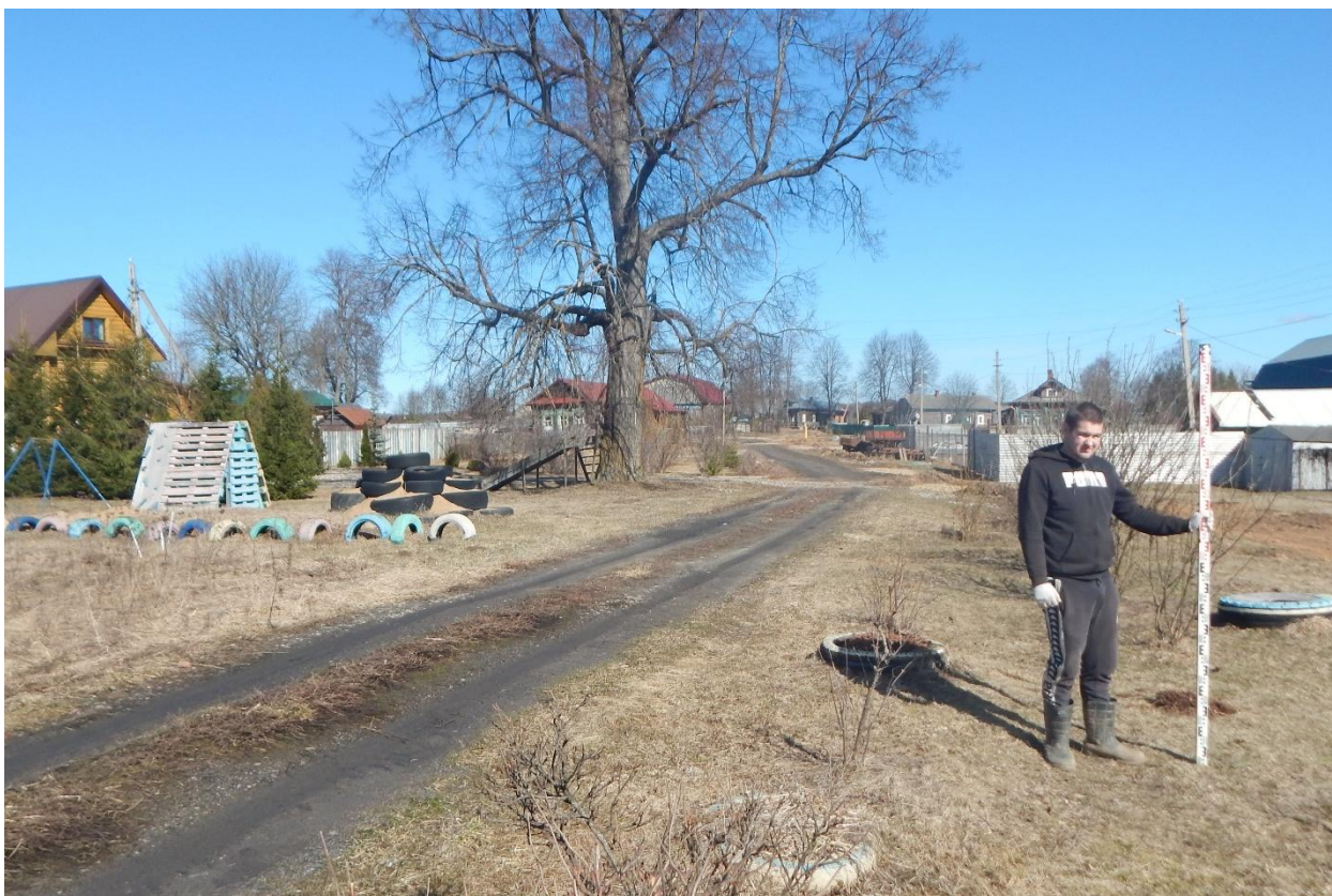
Рис. 206. Ивановская область, Ивановский район, д. Максаки, распределительный газопровод. Общий вид с юга. Точка фотофиксации 1.
