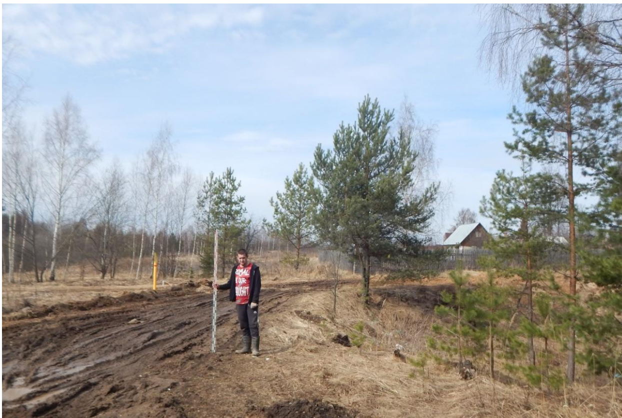
Рис. 47. Ивановская область, Ивановский район, с. Озёрный, распределительный газопровод. Общий вид с юго-востока. Точка фотофиксации 5.
