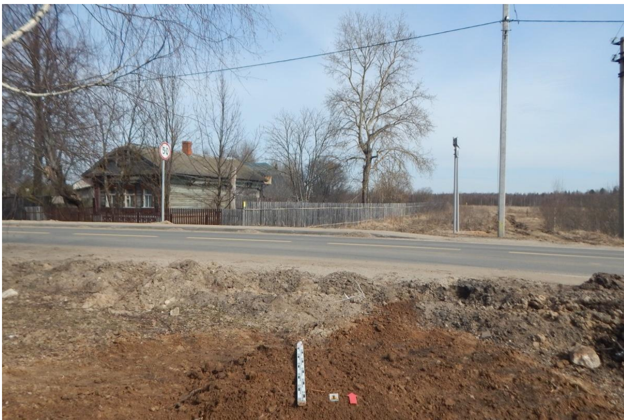
Рис. 76. Ивановская область, Ивановский район, с. Озёрный, распределительный газопровод. Шурф № 1, рекультивация, вид с юга.
