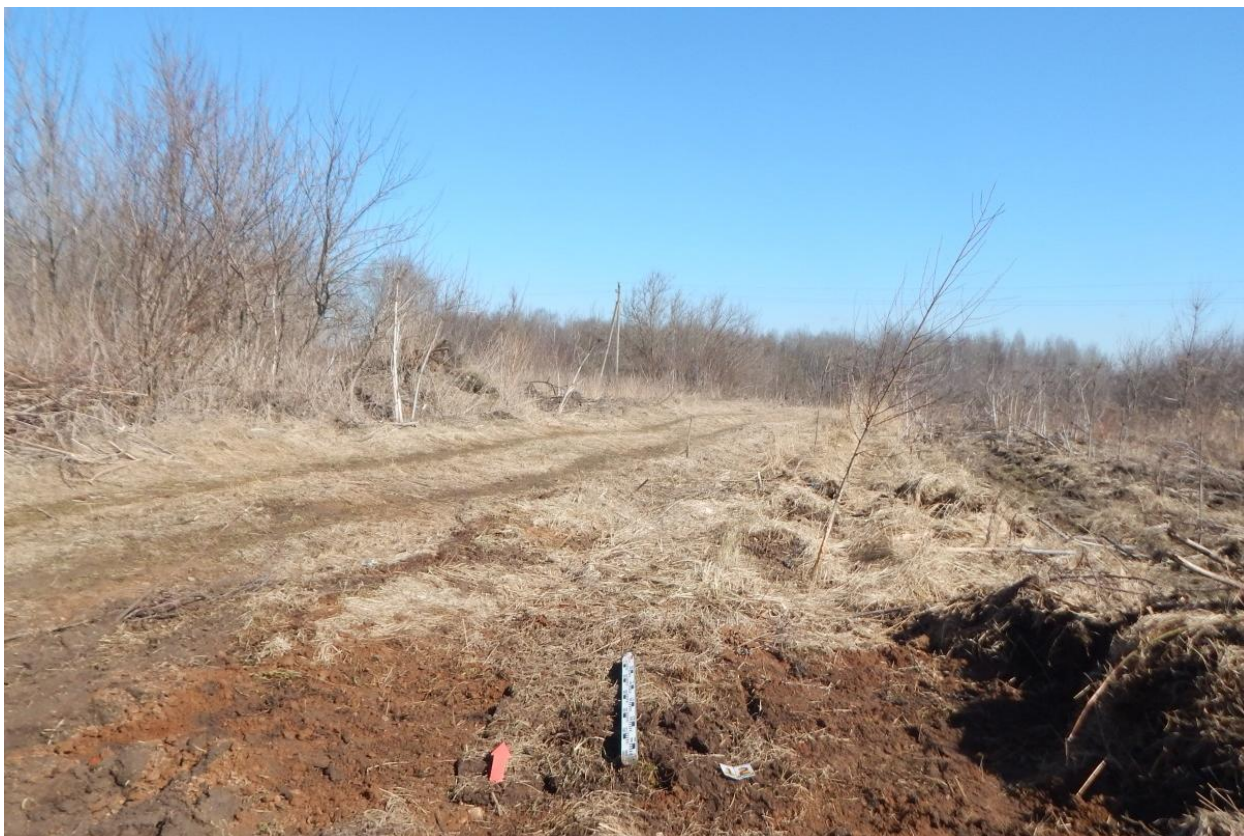
Рис. 131. Ивановская область, Ивановский район, с. Озёрный, распределительный газопровод. Шурф № 12, рекультивация, вид с юга.
