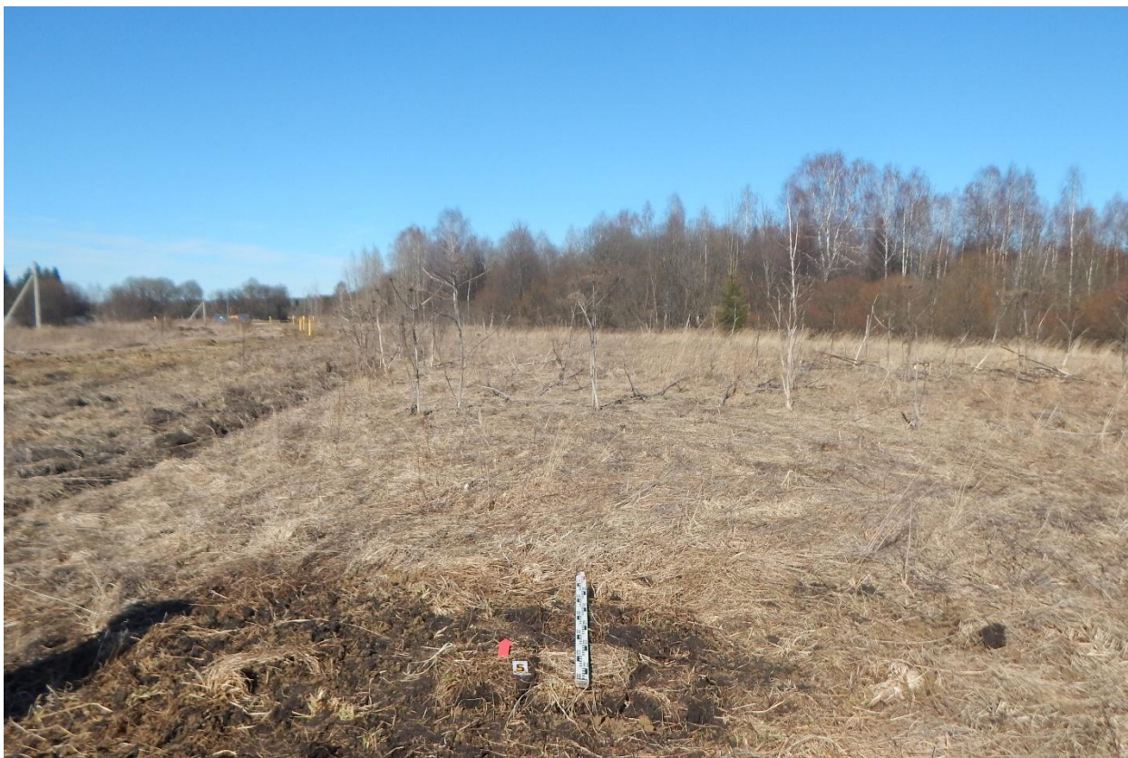
Рис. 240. Ивановская область, Ивановский район, д. Максаки, распределительный газопровод. Шурф № 5, рекультивация, вид с юга.
