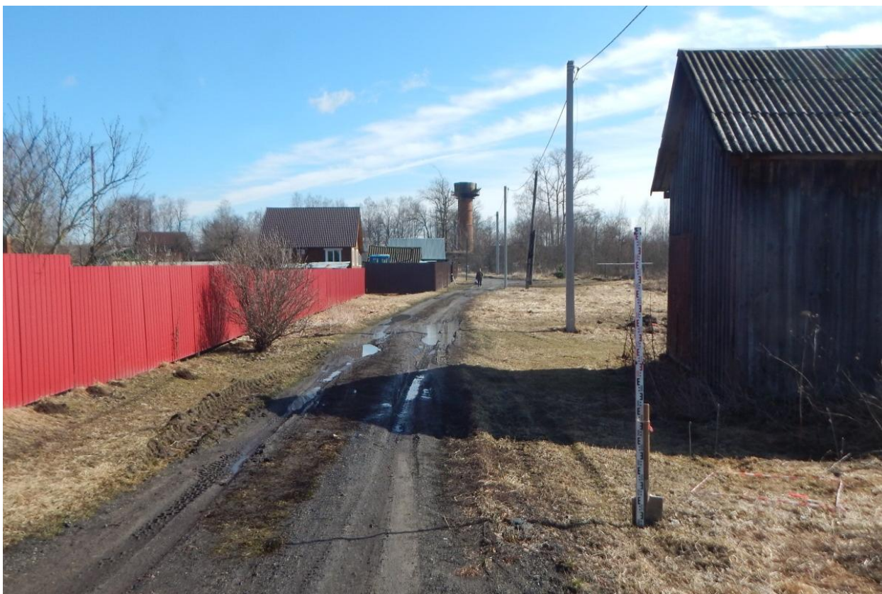
Рис. 64. Ивановская область, Ивановский район, с. Озёрный, распределительный газопровод. Общий вид с запада. Точка фотофиксации 13.
