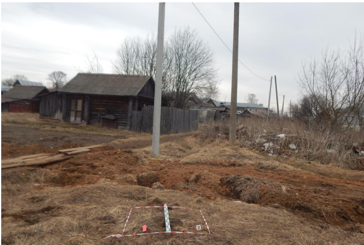
Рис. 102. Ивановская область, Ивановский район, с. Озёрный, распределительный газопровод. Шурф № 7, разметка и общий вид с юга.
