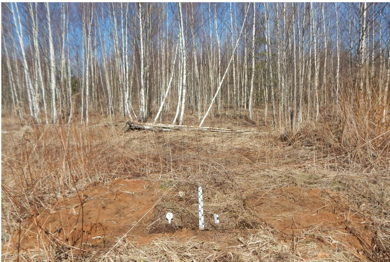
Рис. 188. Ивановская область, Ивановский район, д. Каликино, распределительный газопровод. Шурф № 5, рекультивация, вид с юга.
