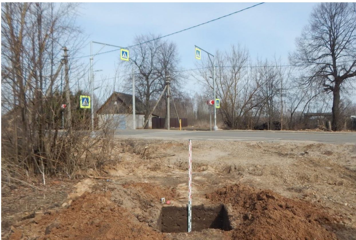
Рис. 80. Ивановская область, Ивановский район, с. Озёрный, распределительный газопровод. Общий вид с юга выкопанного шурфа № 2.
