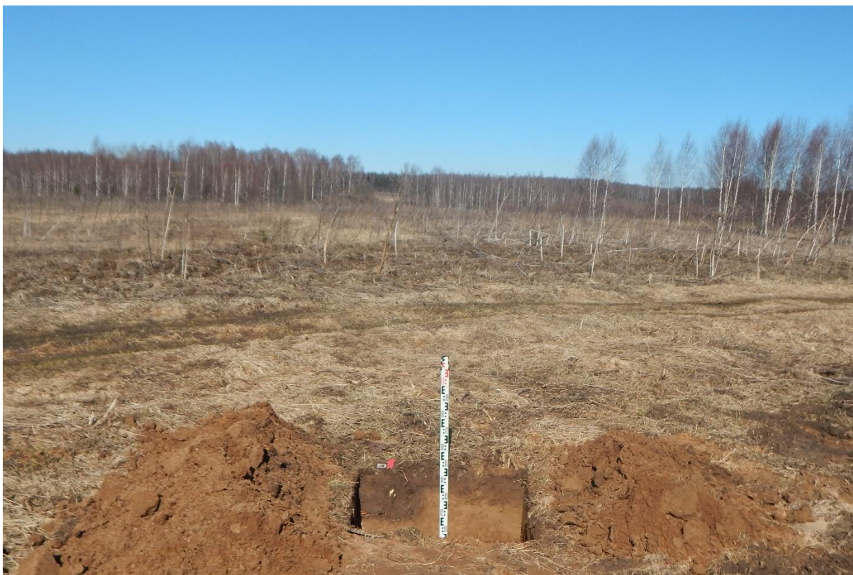
Рис. 229. Ивановская область, Ивановский район, д. Максаки, распределительный газопровод. Общий вид с юга выкопанного шурфа № 3.
