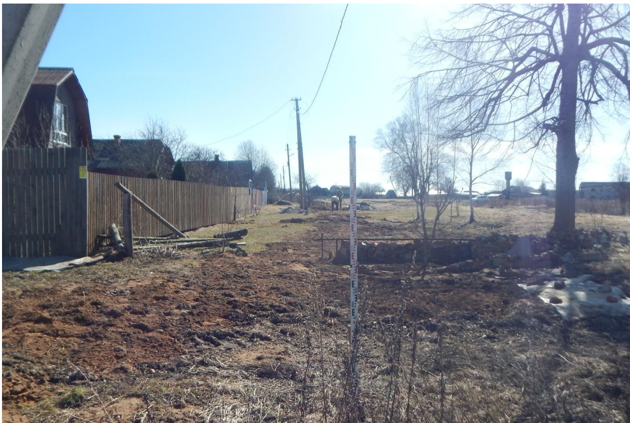
Рис. 210. Ивановская область, Ивановский район, д. Максаки, распределительный газопровод. Общий вид с северо-запада. Точка фотофиксации 3.
