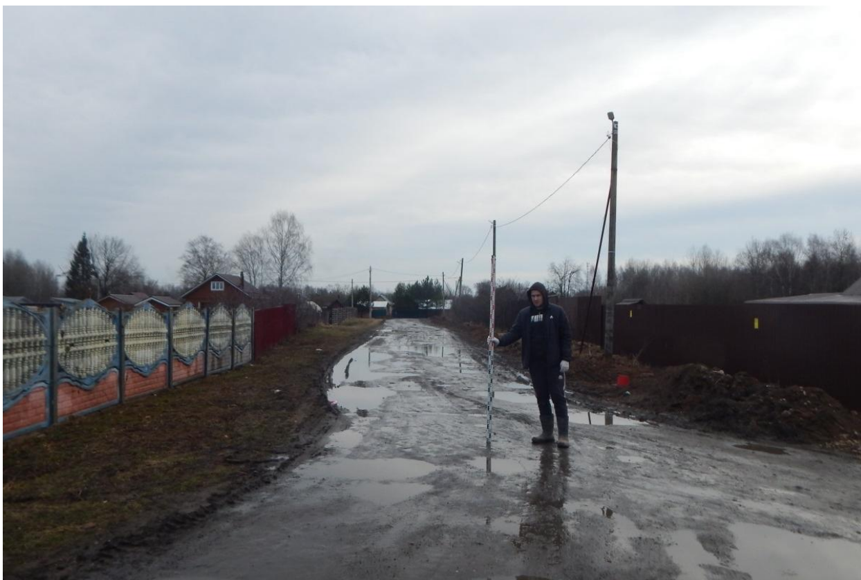
Рис. 56. Ивановская область, Ивановский район, с. Озёрный, распределительный газопровод. Общий вид с запада. Точка фотофиксации 9.
