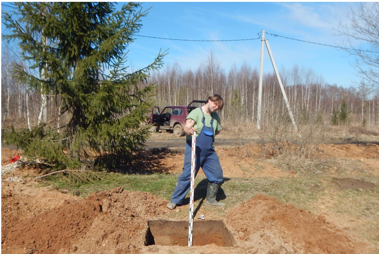
Рис. 177. Ивановская область, Ивановский район, д. Каликино, распределительный газопровод. Общий вид с юга выкопанного шурфа № 3.
