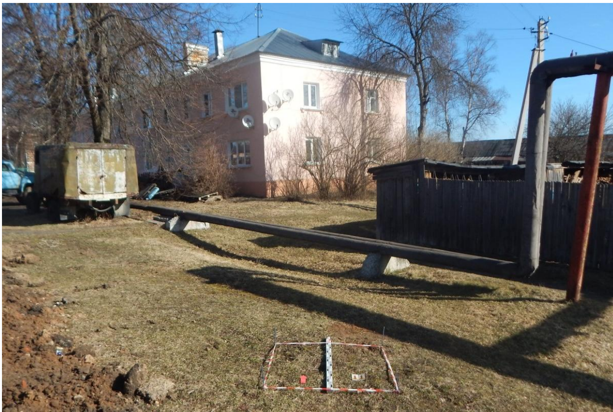
Рис. 122. Ивановская область, Ивановский район, с. Озёрный, распределительный газопровод. Шурф № 11, разметка и общий вид с юга.
