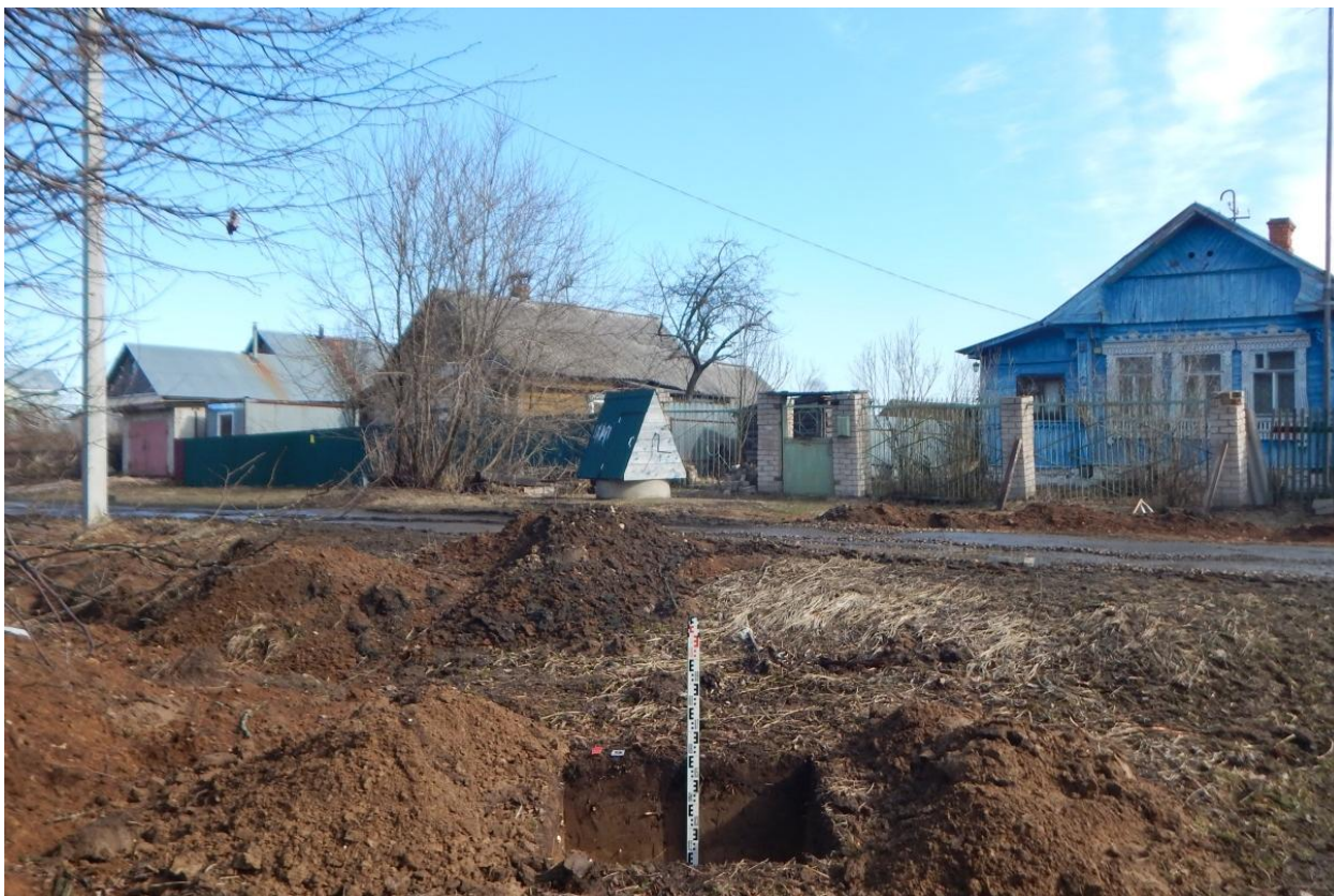
Рис. 115. Ивановская область, Ивановский район, с. Озёрный, распределительный газопровод. Общий вид с юга выкопанного шурфа № 9.
