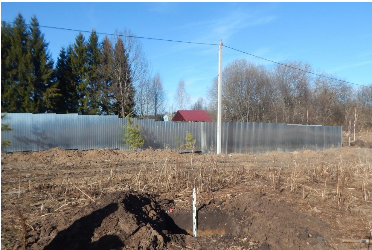
Рис. 234. Ивановская область, Ивановский район, д. Максаки, распределительный газопровод. Общий вид с юга выкопанного шурфа № 4.
