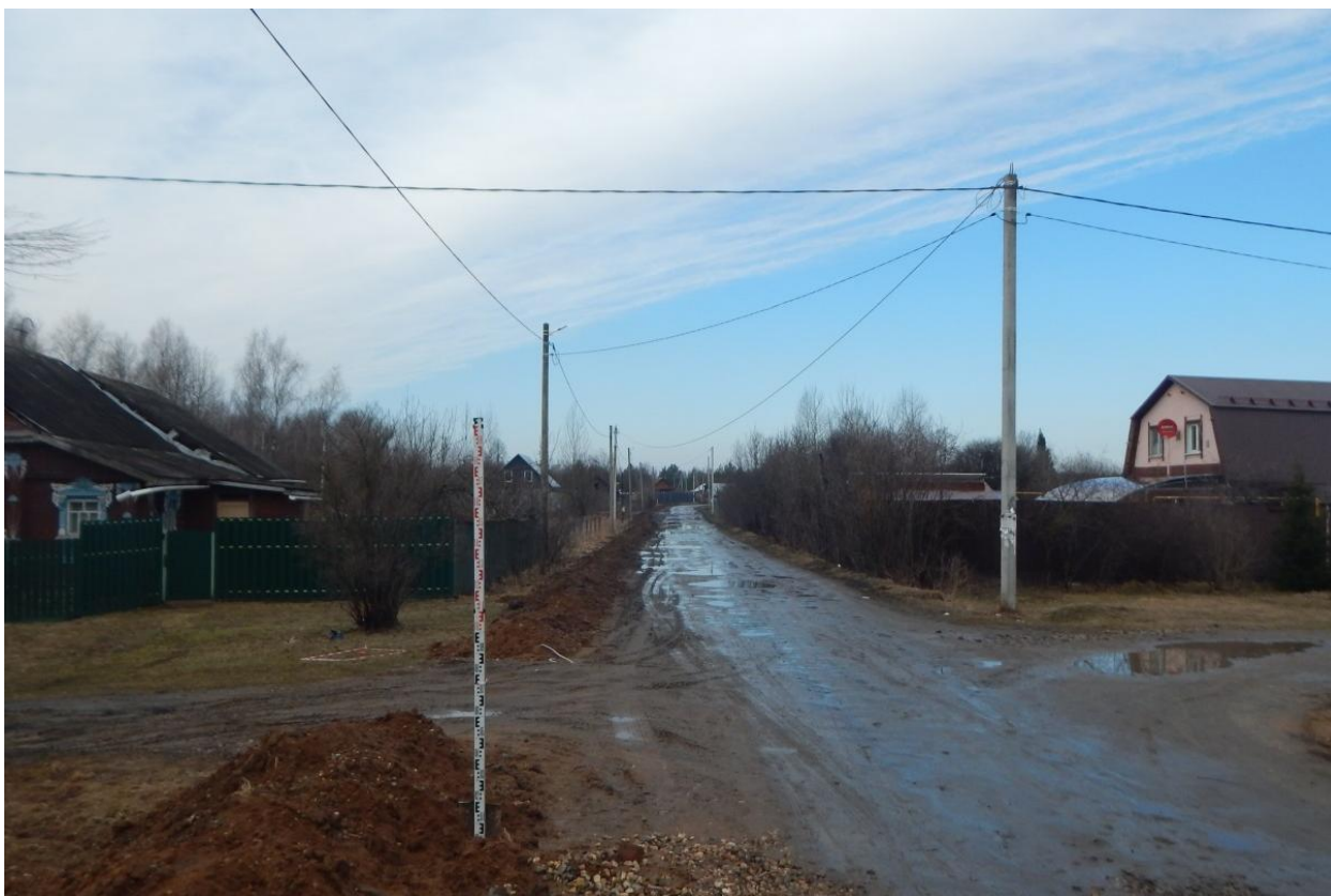
Рис. 58. Ивановская область, Ивановский район, с. Озёрный, распределительный газопровод. Общий вид с востока-юго-востока. Точка фотофиксации 10.
