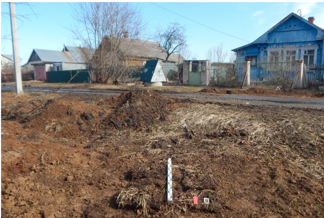
Рис. 116. Ивановская область, Ивановский район, с. Озёрный, распределительный газопровод. Шурф № 9, рекультивация, вид с юга.
