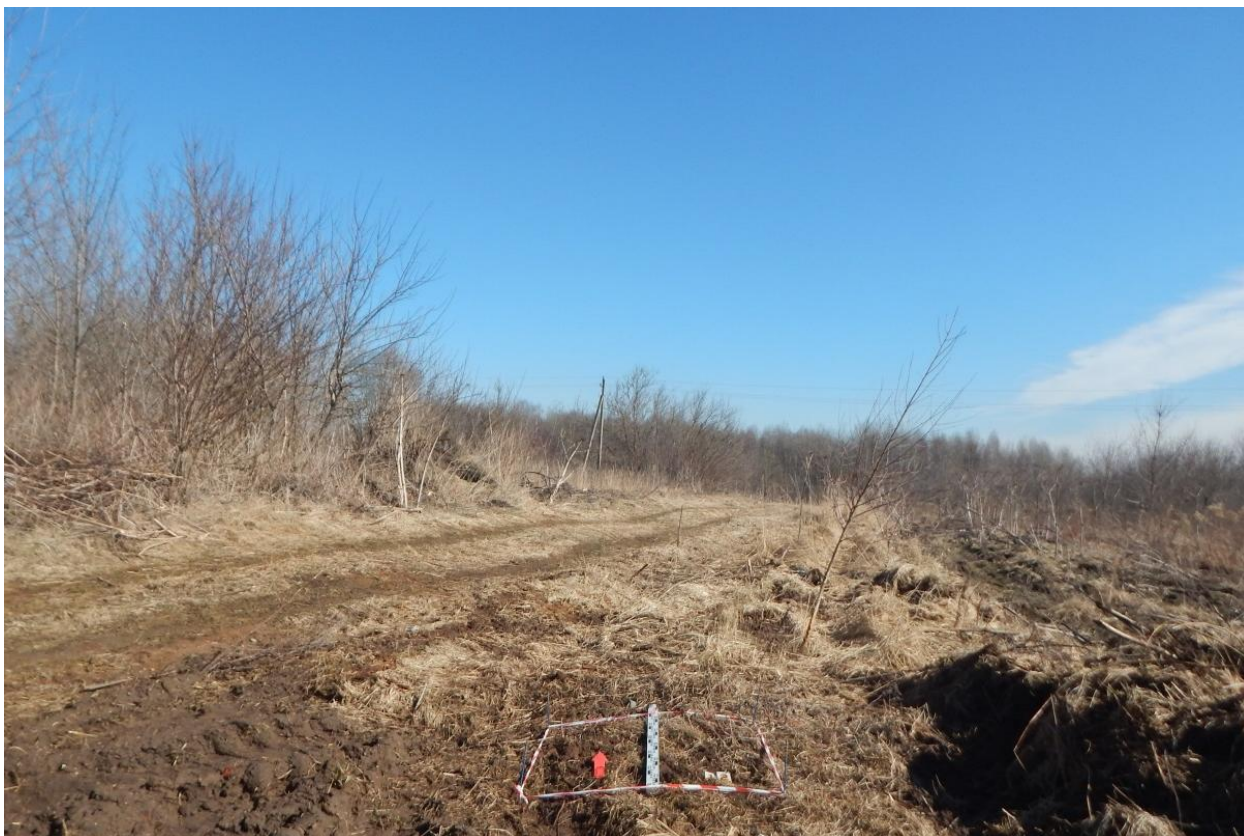
Рис. 127. Ивановская область, Ивановский район, с. Озёрный, распределительный газопровод. Шурф № 12, разметка и общий вид с юга.
