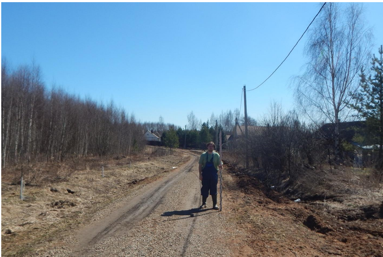
Рис. 162. Ивановская область, Ивановский район, д. Каликино, распределительный газопровод. Общий вид с северо-запада. Точка фотофиксации 5.
