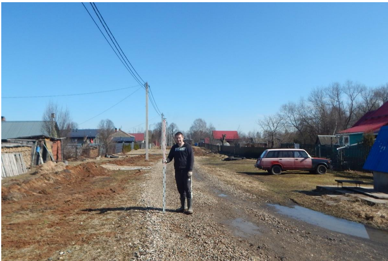
Рис. 67. Ивановская область, Ивановский район, с. Озёрный, распределительный газопровод. Общий вид с запада. Точка фотофиксации 14.
