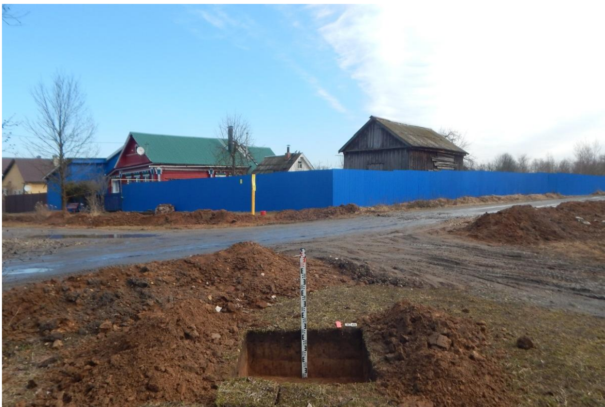
Рис. 120. Ивановская область, Ивановский район, с. Озёрный, распределительный газопровод. Общий вид с юга выкопанного шурфа № 10.
