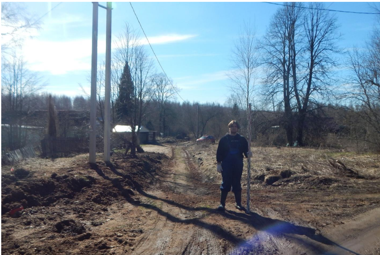
Рис. 155. Ивановская область, Ивановский район, д. Каликино, распределительный газопровод. Общий вид с северо-запада. Точка фотофиксации 2.
