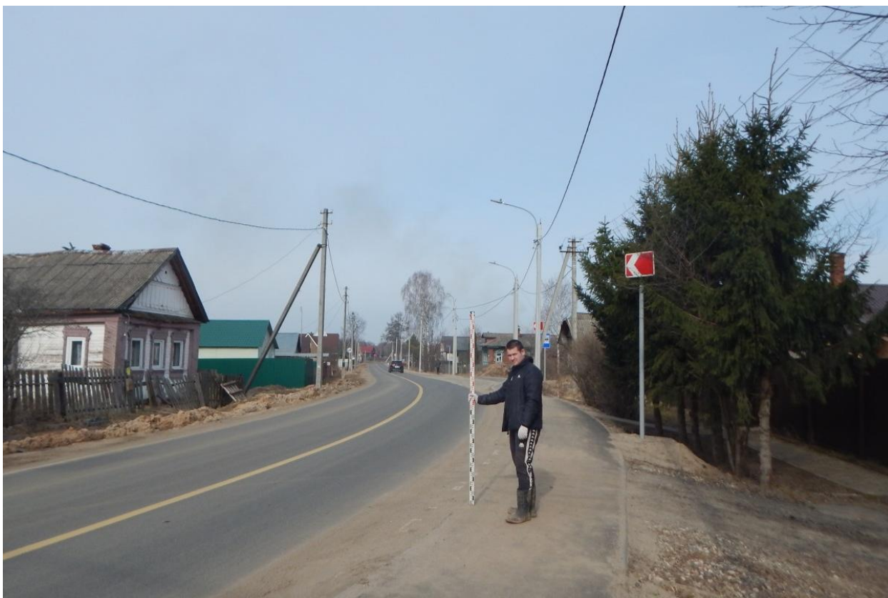
Рис. 38. Ивановская область, Ивановский район, с. Озёрный, распределительный газопровод. Общий вид с юго-востока. Точка фотофиксации 2.
