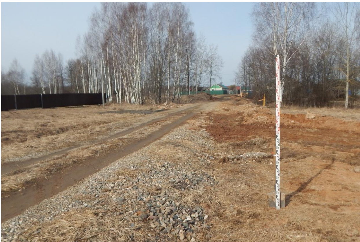
Рис. 39. Ивановская область, Ивановский район, с. Озёрный, распределительный газопровод. Общий вид с юго-востока. Точка фотофиксации 3.
