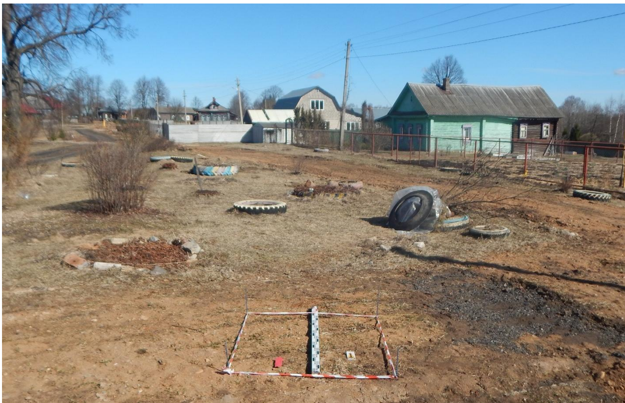
Рис. 216. Ивановская область, Ивановский район, д. Максаки, распределительный газопровод. Шурф №1, разметка и общий вид с юга.
