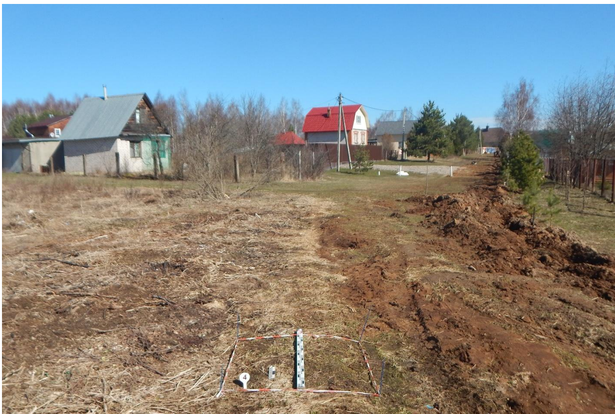
Рис. 179. Ивановская область, Ивановский район, д. Каликино, распределительный газопровод. Шурф № 4, разметка и общий вид с юга.
