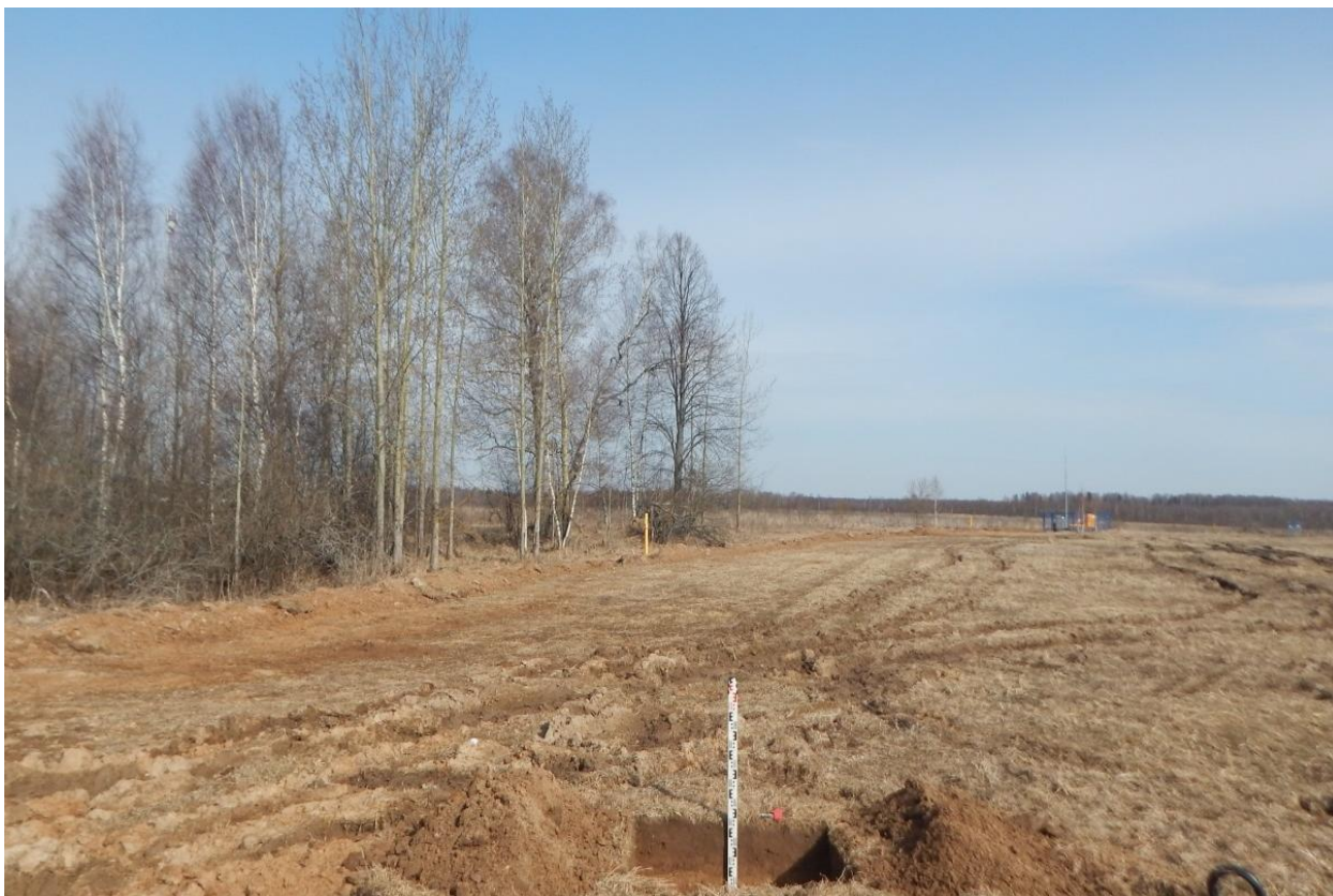
Рис. 85. Ивановская область, Ивановский район, с. Озёрный, распределительный газопровод. Общий вид с юга выкопанного шурфа № 3.
