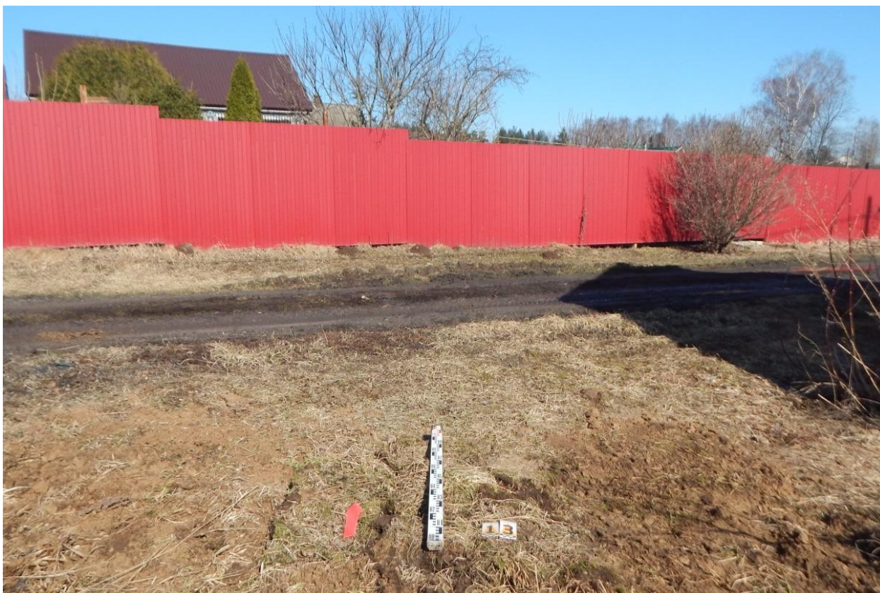
Рис. 136. Ивановская область, Ивановский район, с. Озёрный, распределительный газопровод. Шурф № 13, рекультивация, вид с юга.
