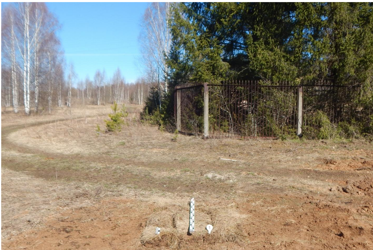
Рис. 168. Ивановская область, Ивановский район, д. Каликино, распределительный газопровод. Шурф № 1, рекультивация, вид с юга.
