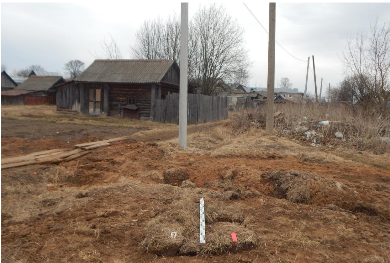
Рис. 106. Ивановская область, Ивановский район, с. Озёрный, распределительный газопровод. Шурф № 7, рекультивация, вид с юга.
