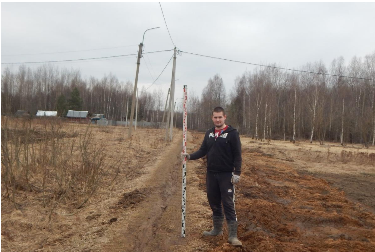
Рис. 51. Ивановская область, Ивановский район, с. Озёрный, распределительный газопровод. Общий вид с северо-востока. Точка фотофиксации 7.
