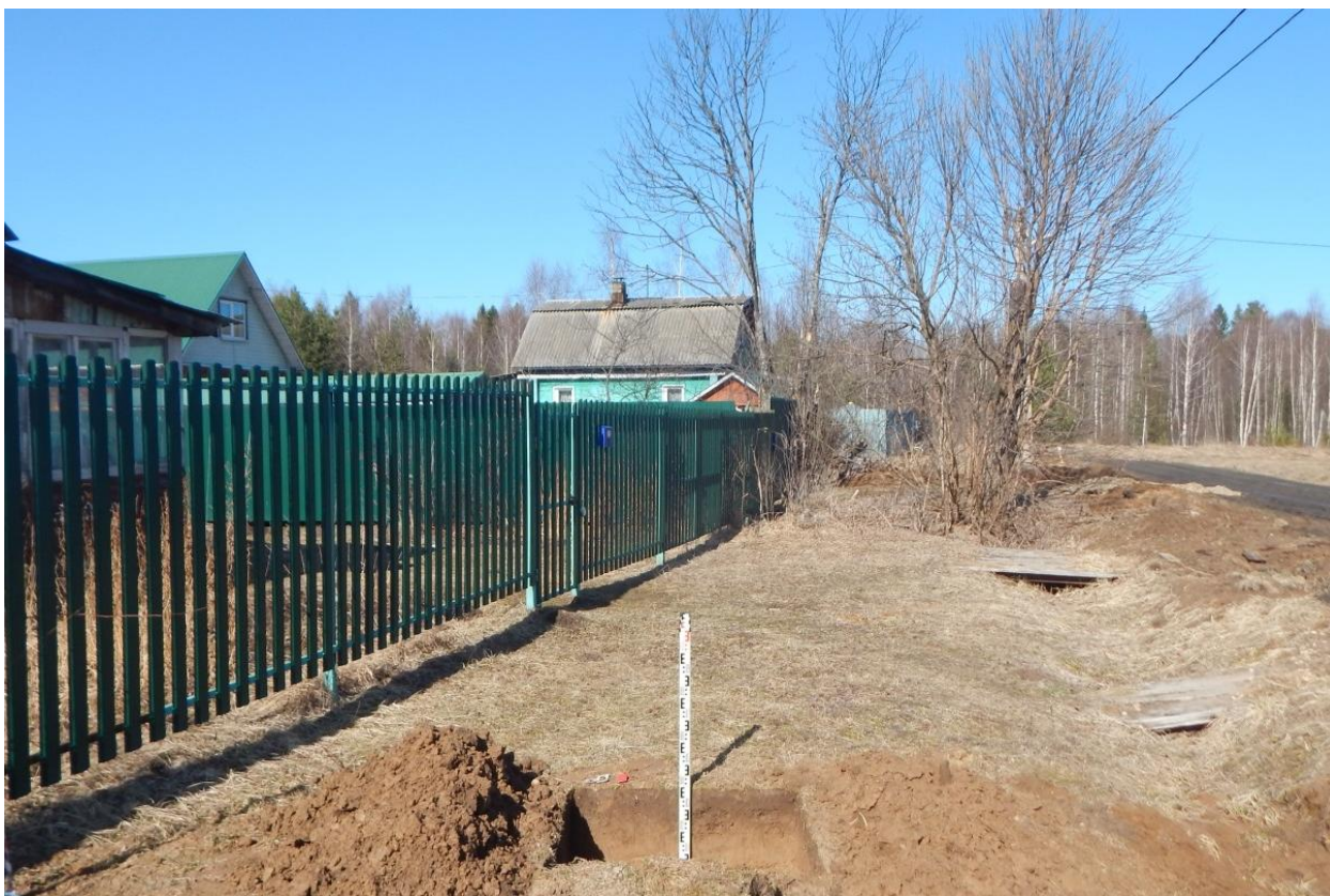
Рис. 144. Ивановская область, Ивановский район, с. Озёрный, распределительный газопровод. Общий вид с юга выкопанного шурфа № 15.
