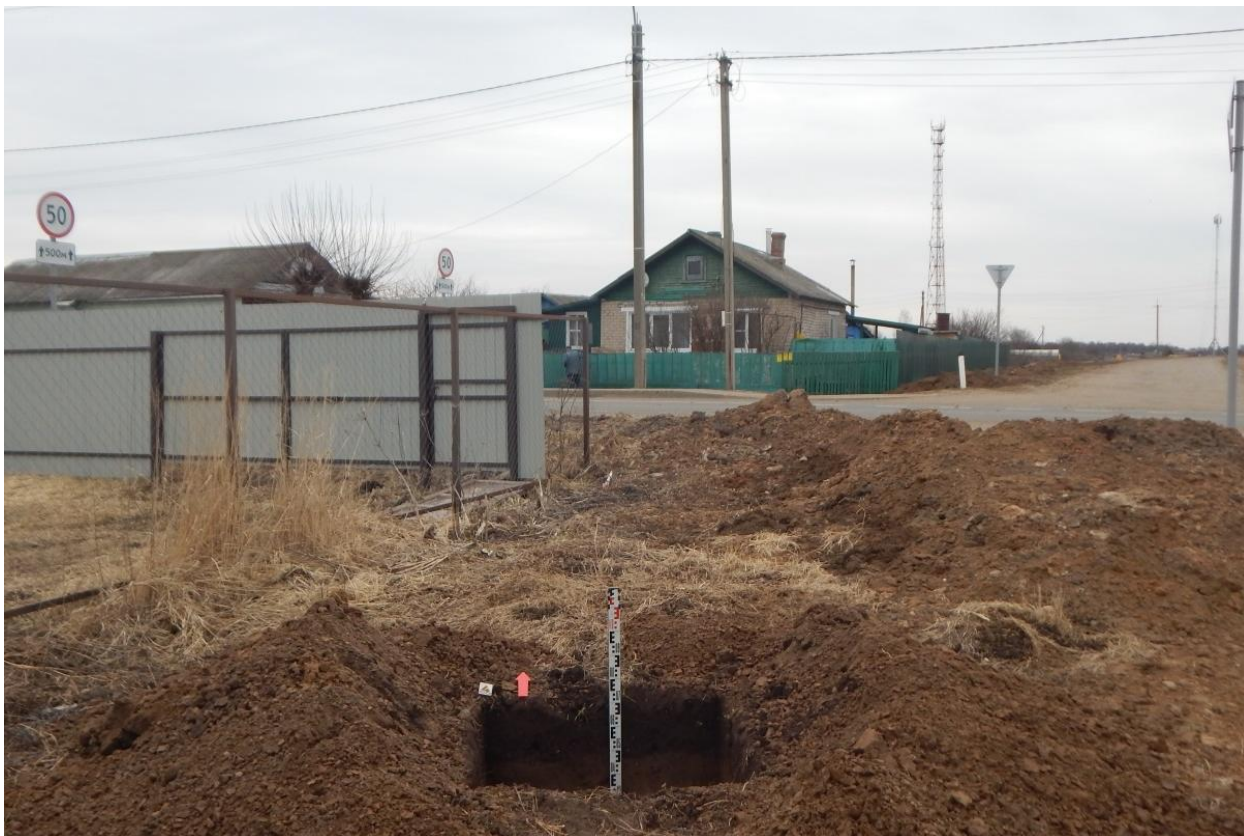
Рис. 90. Ивановская область, Ивановский район, с. Озёрный, распределительный газопровод. Общий вид с юга выкопанного шурфа № 4.
