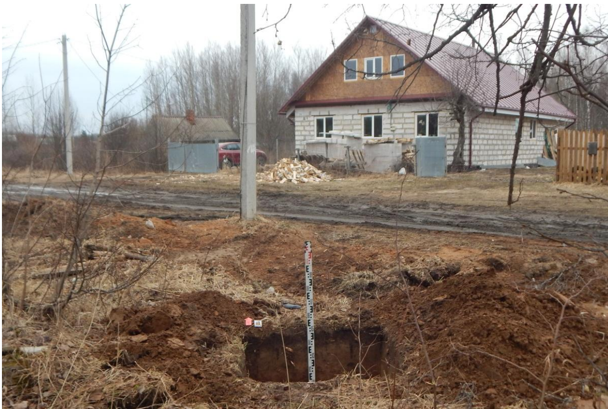
Рис. 110. Ивановская область, Ивановский район, с. Озёрный, распределительный газопровод. Общий вид с юга выкопанного шурфа № 8.
