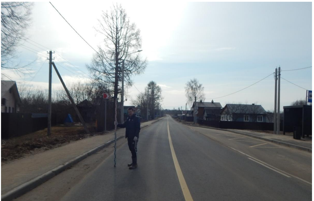
Рис. 37. Ивановская область, Ивановский район, с. Озёрный, распределительный газопровод. Общий вид с северо-запада. Точка фотофиксации 2.
