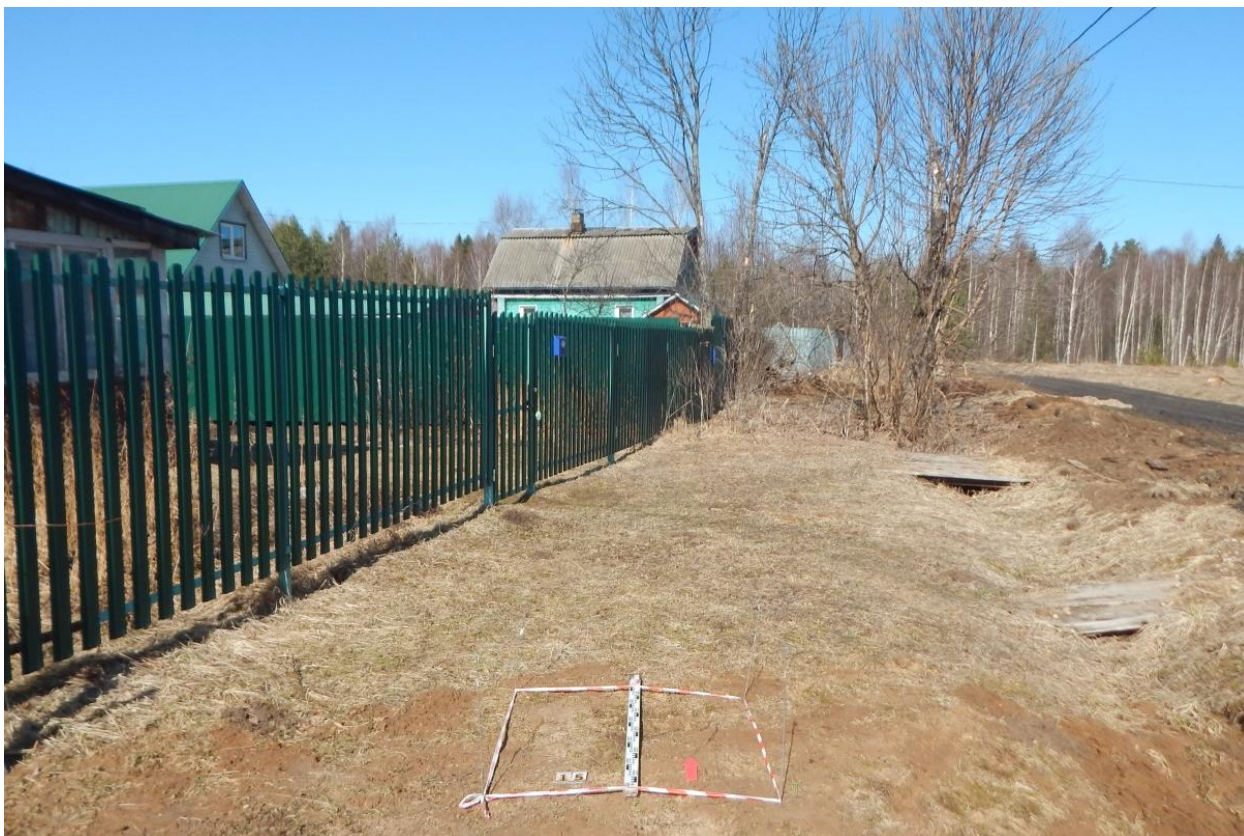
Рис. 141. Ивановская область, Ивановский район, с. Озёрный, распределительный газопровод. Шурф № 15, разметка и общий вид с юга.
