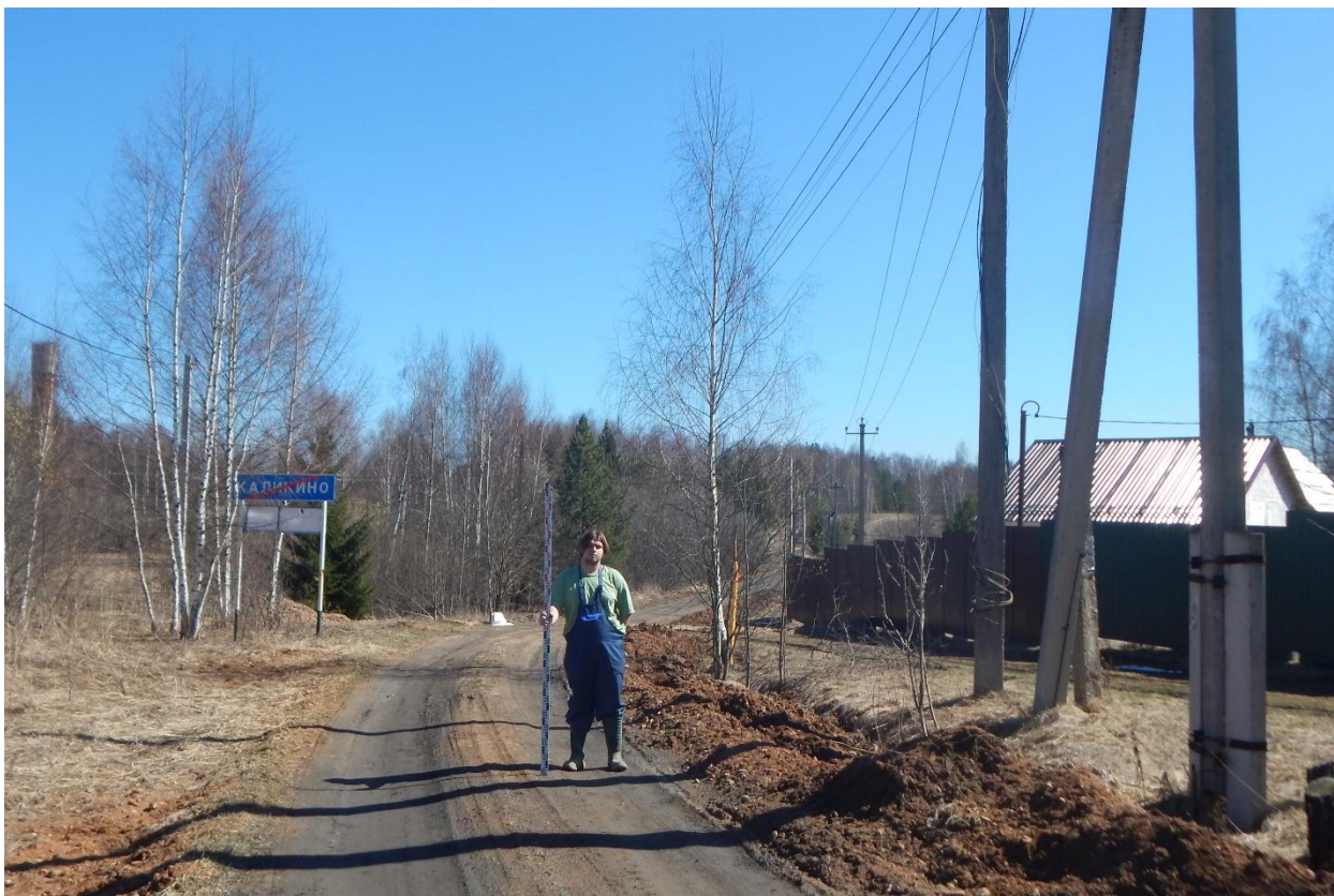
Рис. 158. Ивановская область, Ивановский район, д. Каликино, распределительный газопровод. Общий вид с запада. Точка фотофиксации 3.
