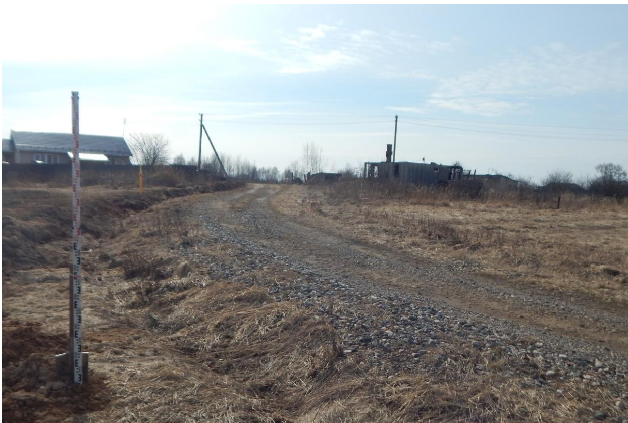
Рис. 40. Ивановская область, Ивановский район, с. Озёрный, распределительный газопровод. Общий вид с северо-запада. Точка фотофиксации 3.
