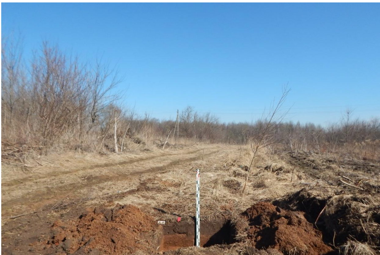
Рис. 130. Ивановская область, Ивановский район, с. Озёрный, распределительный газопровод. Общий вид с юга выкопанного шурфа № 12.
