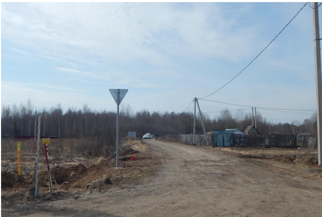
Рис. 44. Ивановская область, Ивановский район, с. Озёрный, распределительный газопровод. Общий вид с северо-востока. Точка фотофиксации 4.
