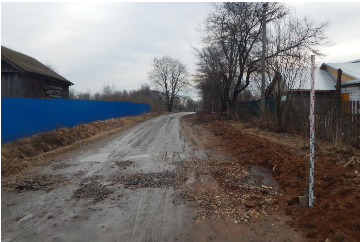
Рис. 57. Ивановская область, Ивановский район, с. Озёрный, распределительный газопровод. Общий вид с запада. Точка фотофиксации 10.
