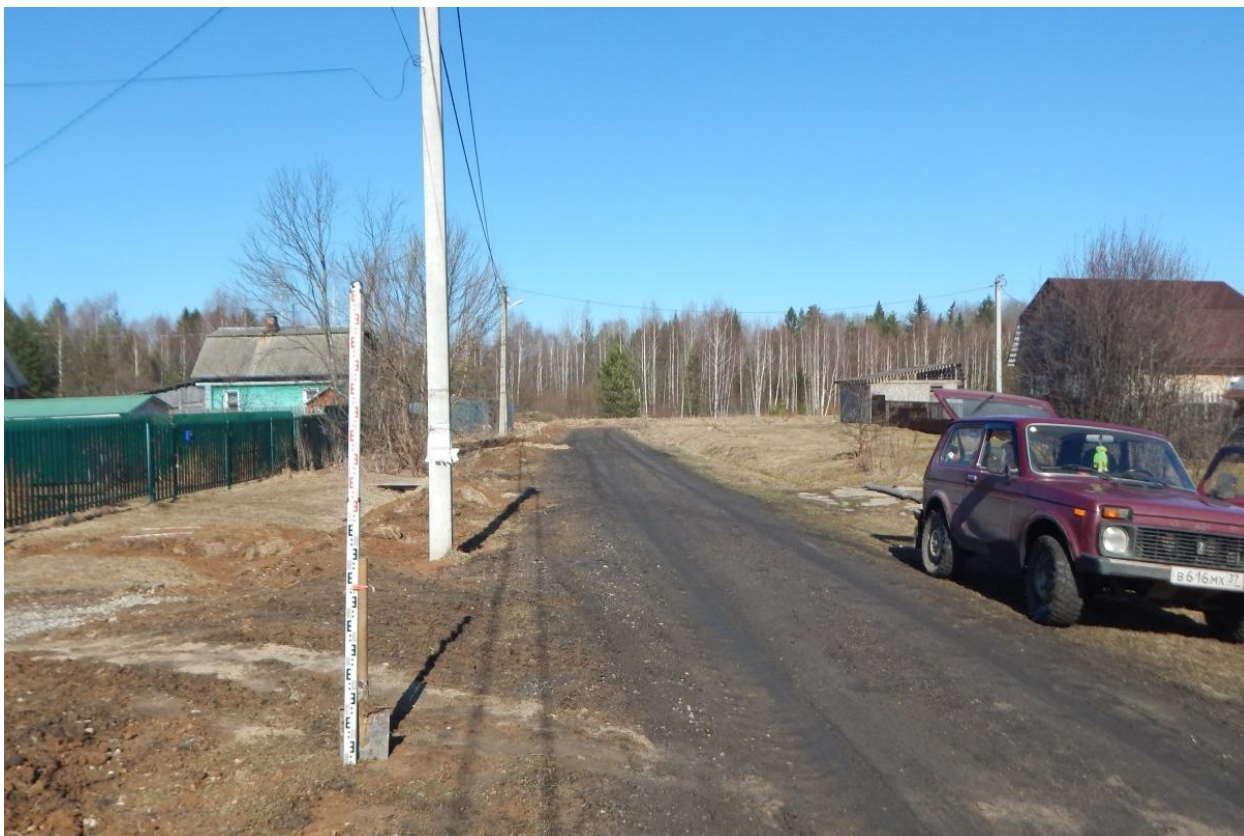
Рис. 71. Ивановская область, Ивановский район, с. Озёрный, распределительный газопровод. Общий вид с юго-юго-запада. Точка фотофиксации 15.
