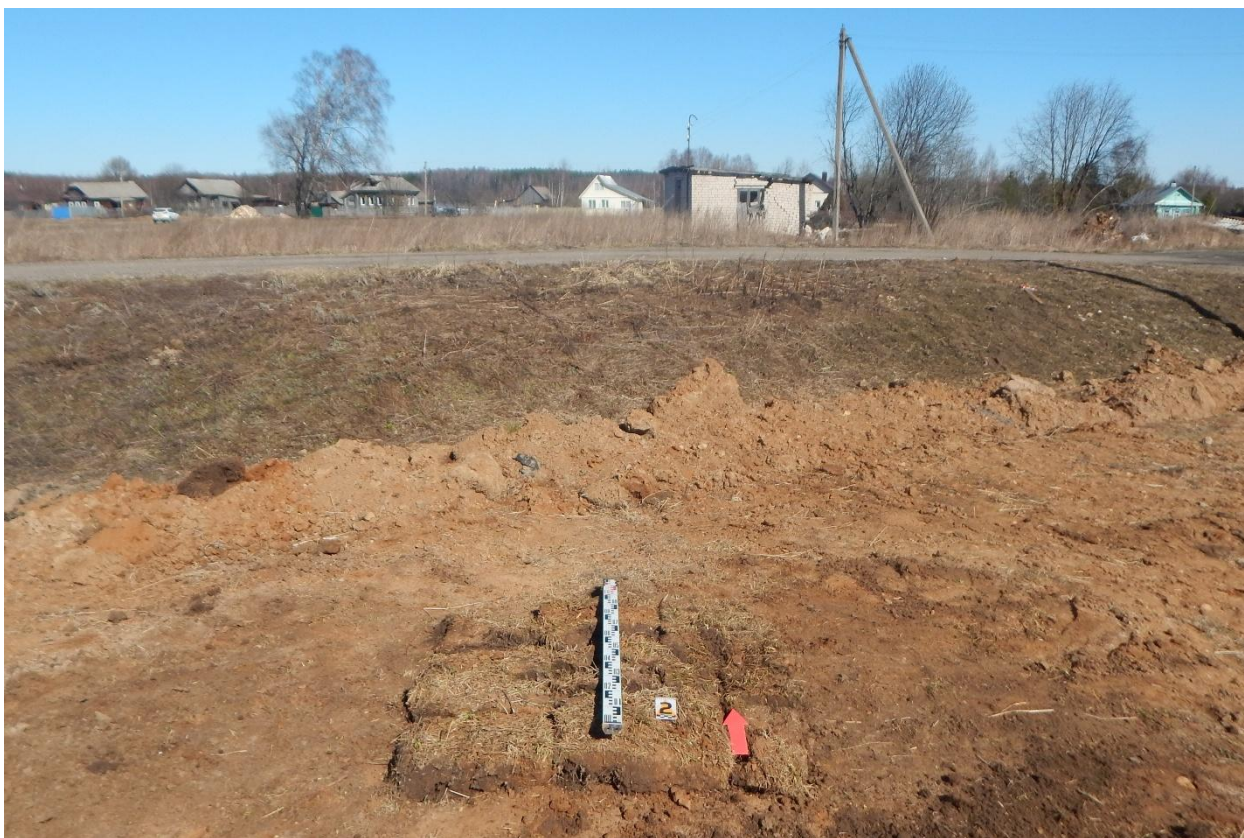
Рис. 225. Ивановская область, Ивановский район, д. Максаки, распределительный газопровод. Шурф № 2, рекультивация, вид с юга.
