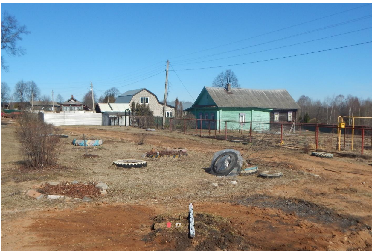
Рис. 220. Ивановская область, Ивановский район, д. Макаси, распределительный газопровод. Шурф № 1, рекультивация, вид с юга.
