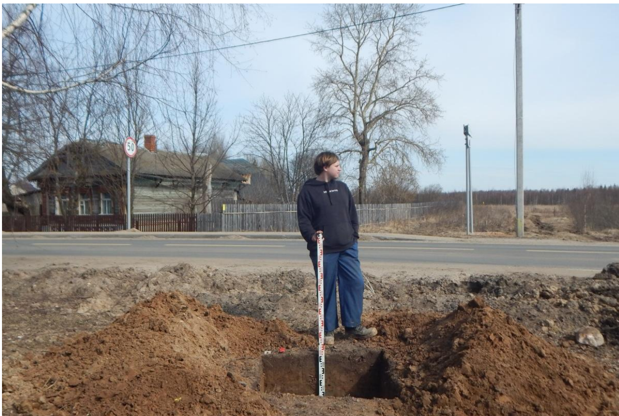
Рис. 75. Ивановская область, Ивановский район, с. Озёрный, распределительный газопровод. Общий вид с юга выкопанного шурфа № 1.
