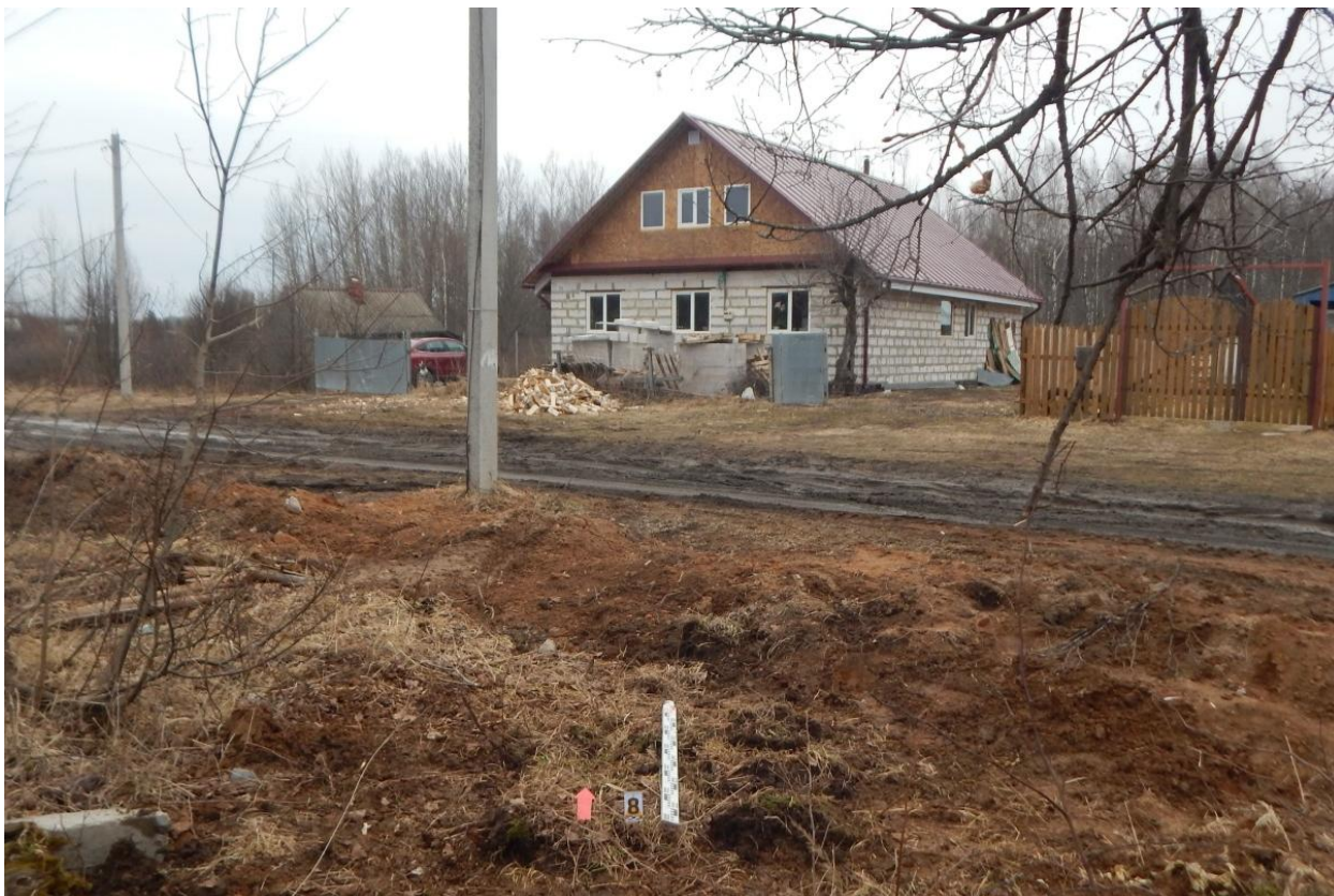
Рис. 111. Ивановская область, Ивановский район, с. Озёрный, распределительный газопровод. Шурф № 8, рекультивация, вид с юга.
