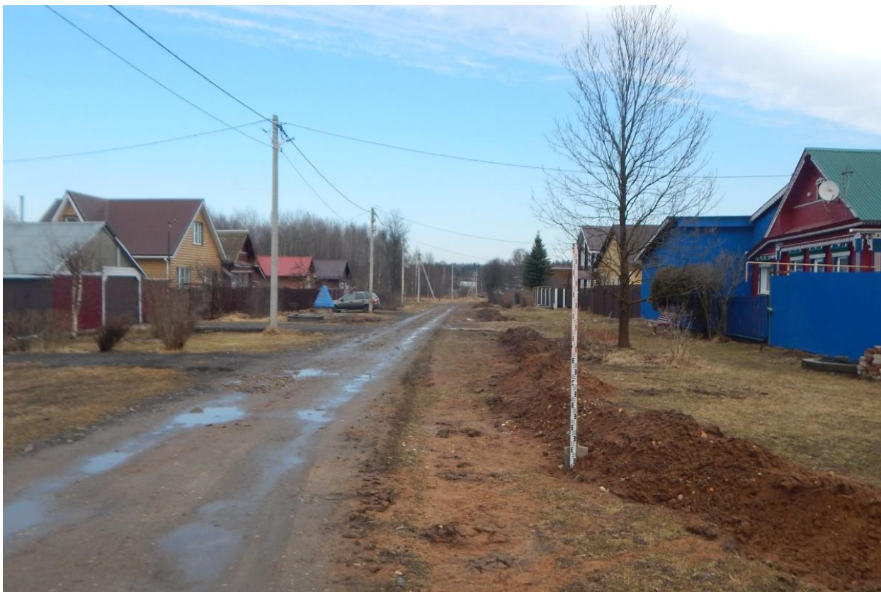
Рис. 59. Ивановская область, Ивановский район, с. Озёрный, распределительный газопровод. Общий вид с юга. Точка фотофиксации 10.
