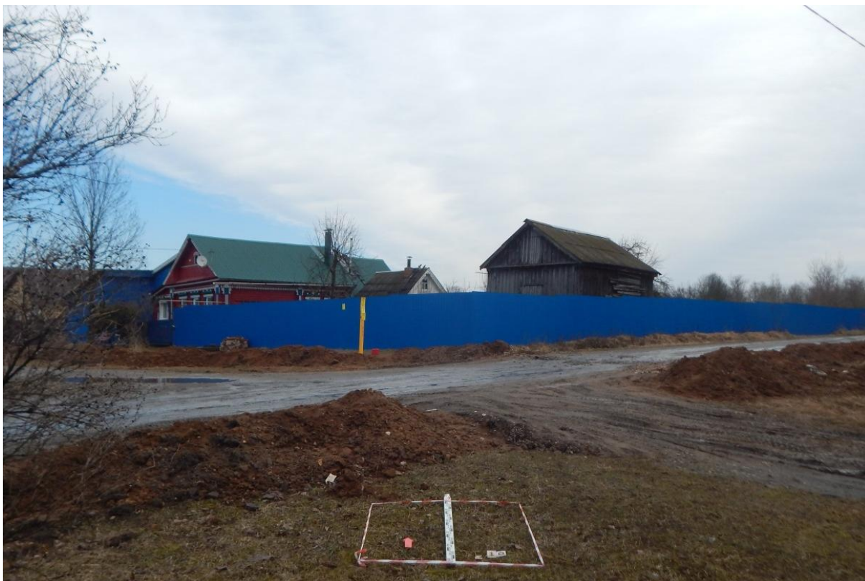
Рис. 117. Ивановская область, Ивановский район, с. Озёрный, распределительный газопровод. Шурф № 10, разметка и общий вид с юга.
