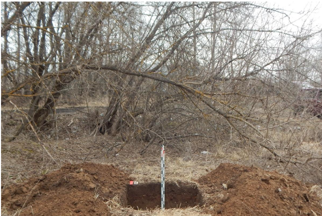
Рис. 100. Ивановская область, Ивановский район, с. Озёрный, распределительный газопровод. Общий вид с юга выкопанного шурфа № 6.
