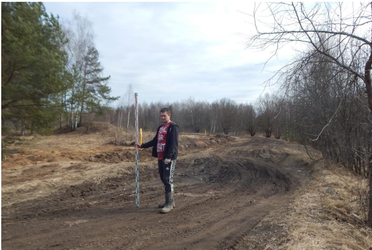
Рис. 46. Ивановская область, Ивановский район, с. Озёрный, распределительный газопровод. Общий вид с северо-востока. Точка фотофиксации 5.
