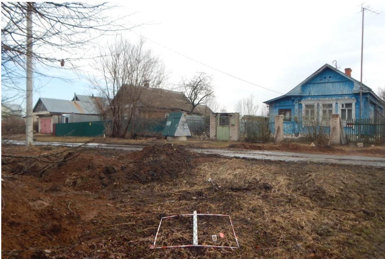
Рис. 112. Ивановская область, Ивановский район, с. Озёрный, распределительный газопровод. Шурф № 9, разметка и общий вид с юга.
