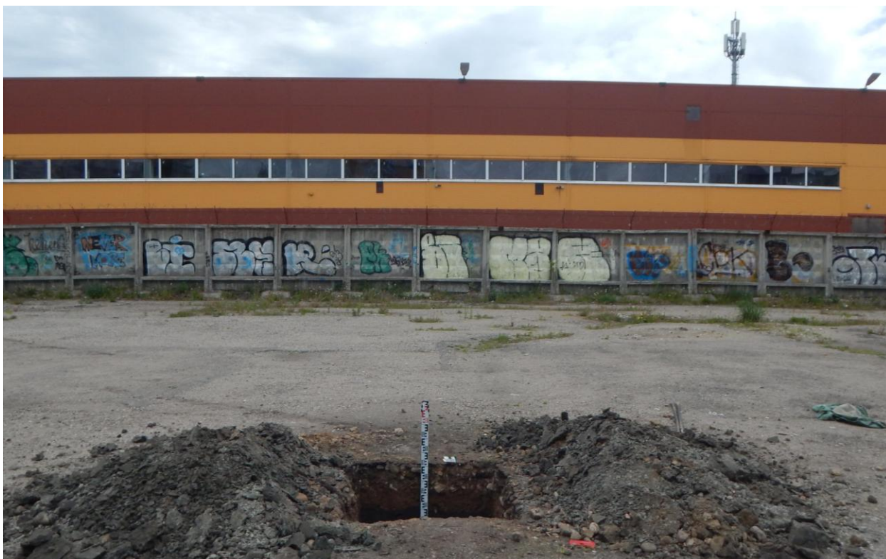
Рис. 16. Ивановская область, г. Иваново, пр. Текстильщиков, 41. Общий вид с запада выкопанного шурфа.
