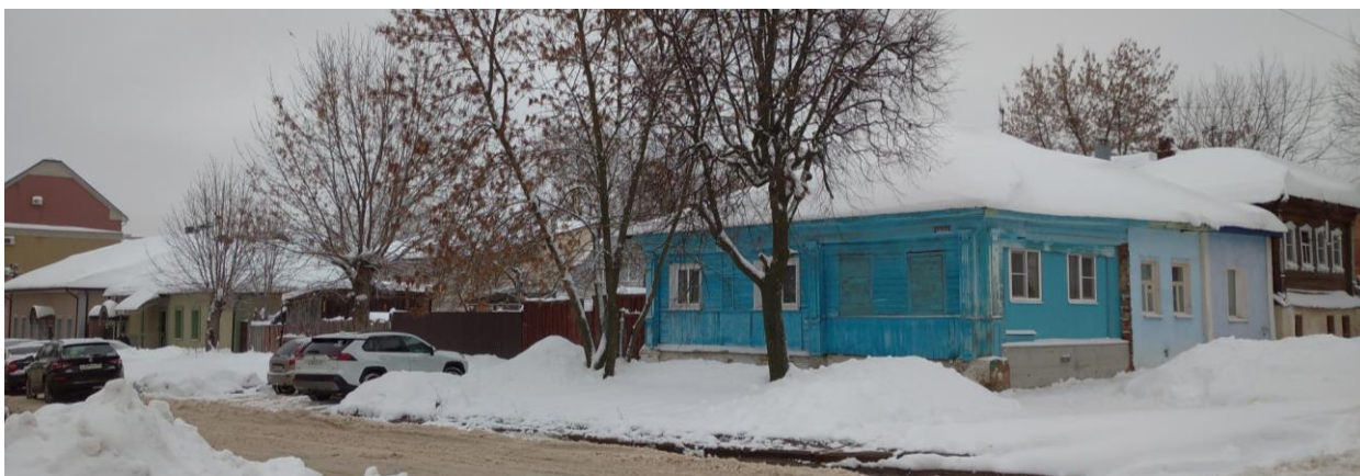
Рис. 15. Вид перекрестка ул. Московской с ул. Пророкова (слева – ул. Московская, справа – ул. Пророкова)
