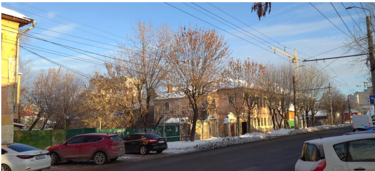
Рис. 4. Вид участка улицы Смирнова 10 Августа на дома №№ 15, 17
