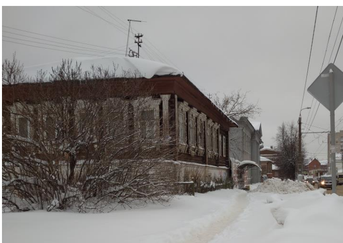
Рис. 19. Вид улицы Пророкова у перекрестка с ул. Смирнова (дом № 17/6), вдали – дом по ул. Лежневская, 4.
