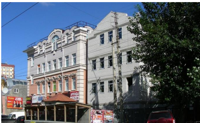
Рис. 29. Дома №№ 7 (слева) и 9 в процессе строительства. 2013 г.
