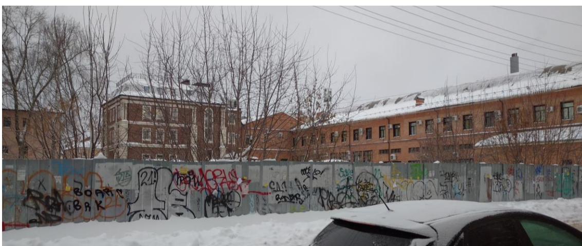
Рис. 21. Вид улицы Красногвардейской восточнее дома № 11 по ул. Смирнова (пустырь). На заднем плане видна застройка по ул. Смирнова.
