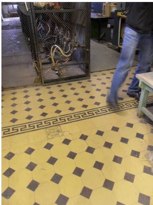
Фото 53. Метлахская плитка на полу в электростанции
