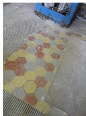
Фото 12. Прядильный корпус. Метлахская плитка блока электростанции.
