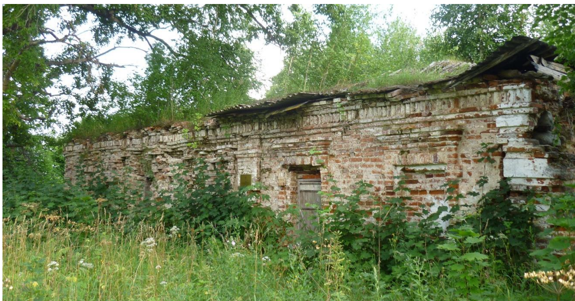
1. Северный фасад. Фото 21 июля 2026 г. А.М. Тихомиров
