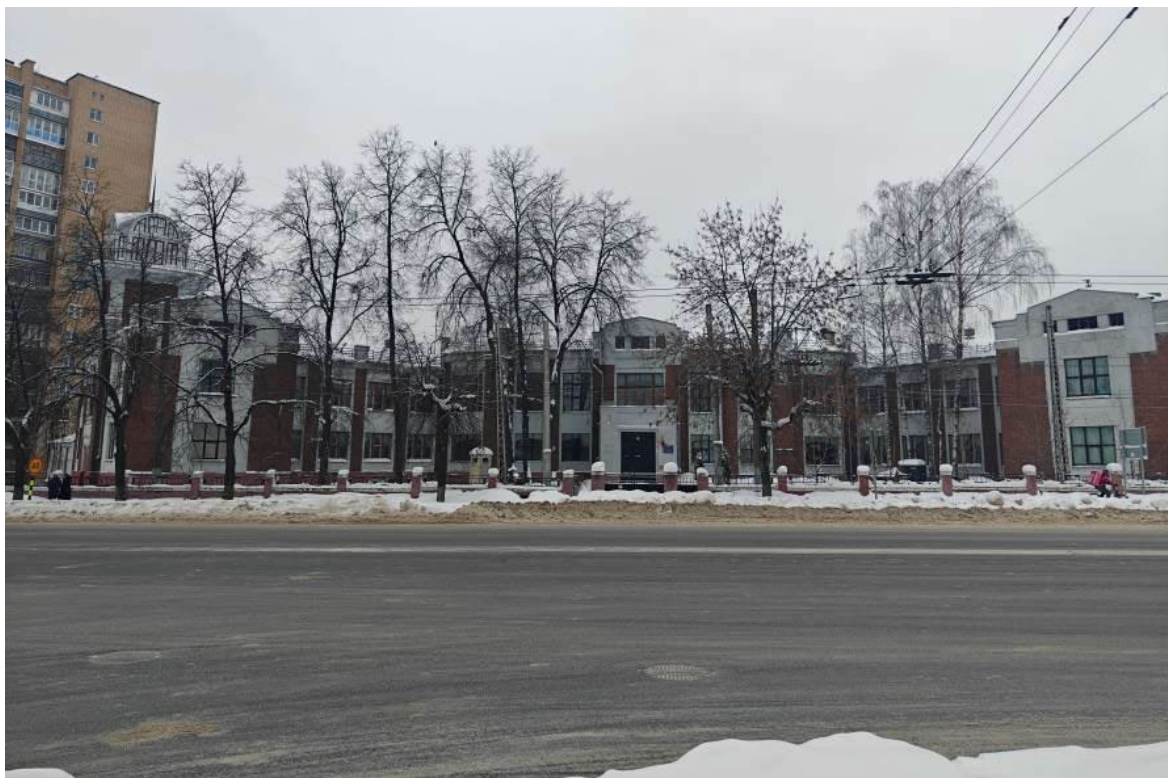
Фото 1. Общий вид Объекта с проспекта Ленина.
