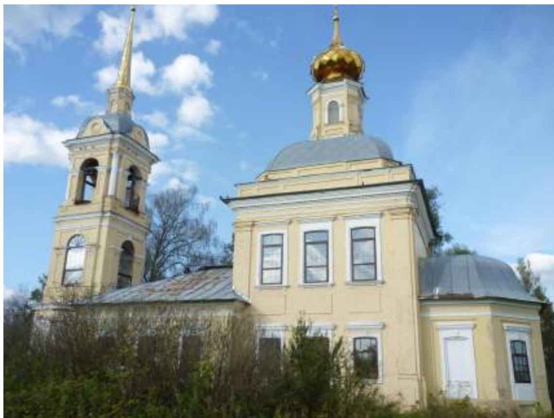
2. Казанская церковь. Вид с юга.
