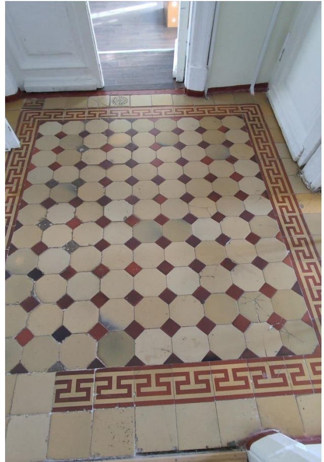
10. Кафельный пол в помещении вестибюля 2-го этажа
