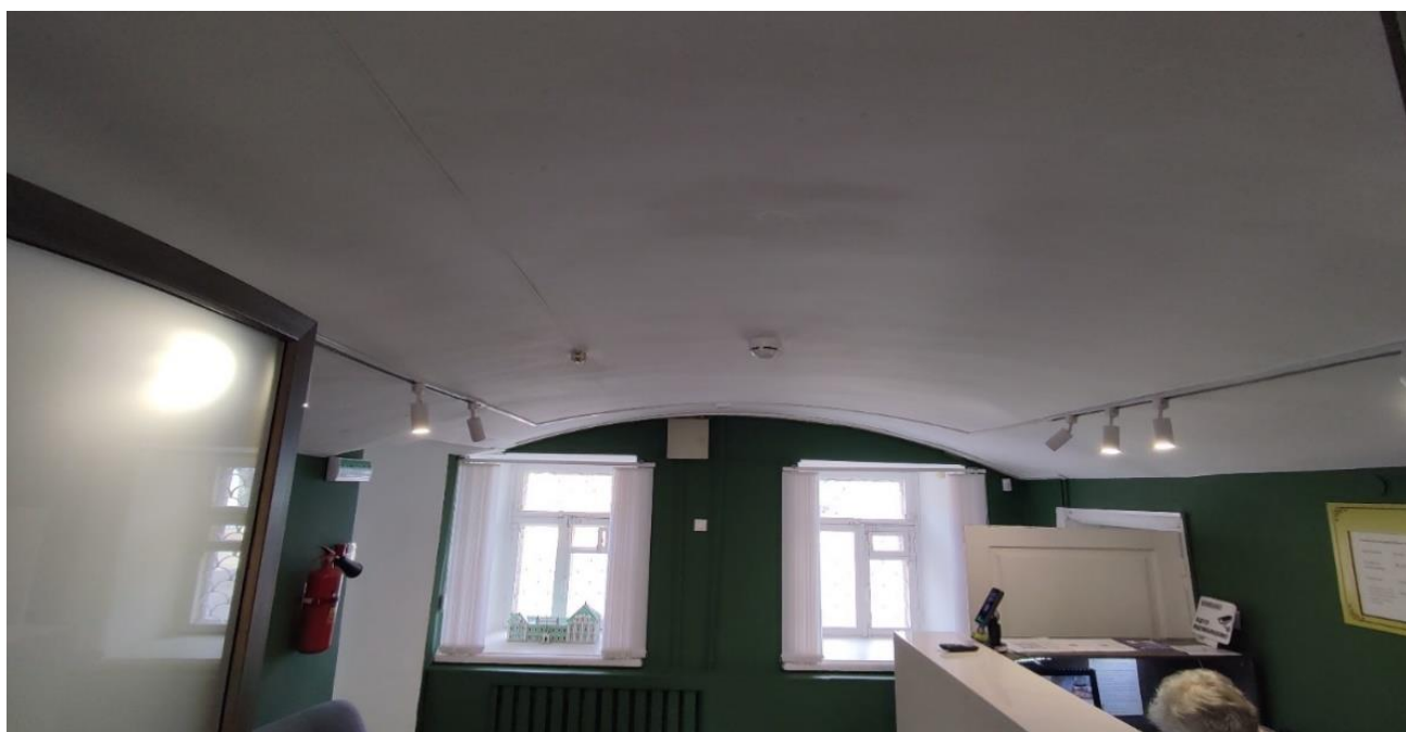
13. Помещение со сводами на 1-ом этаже
