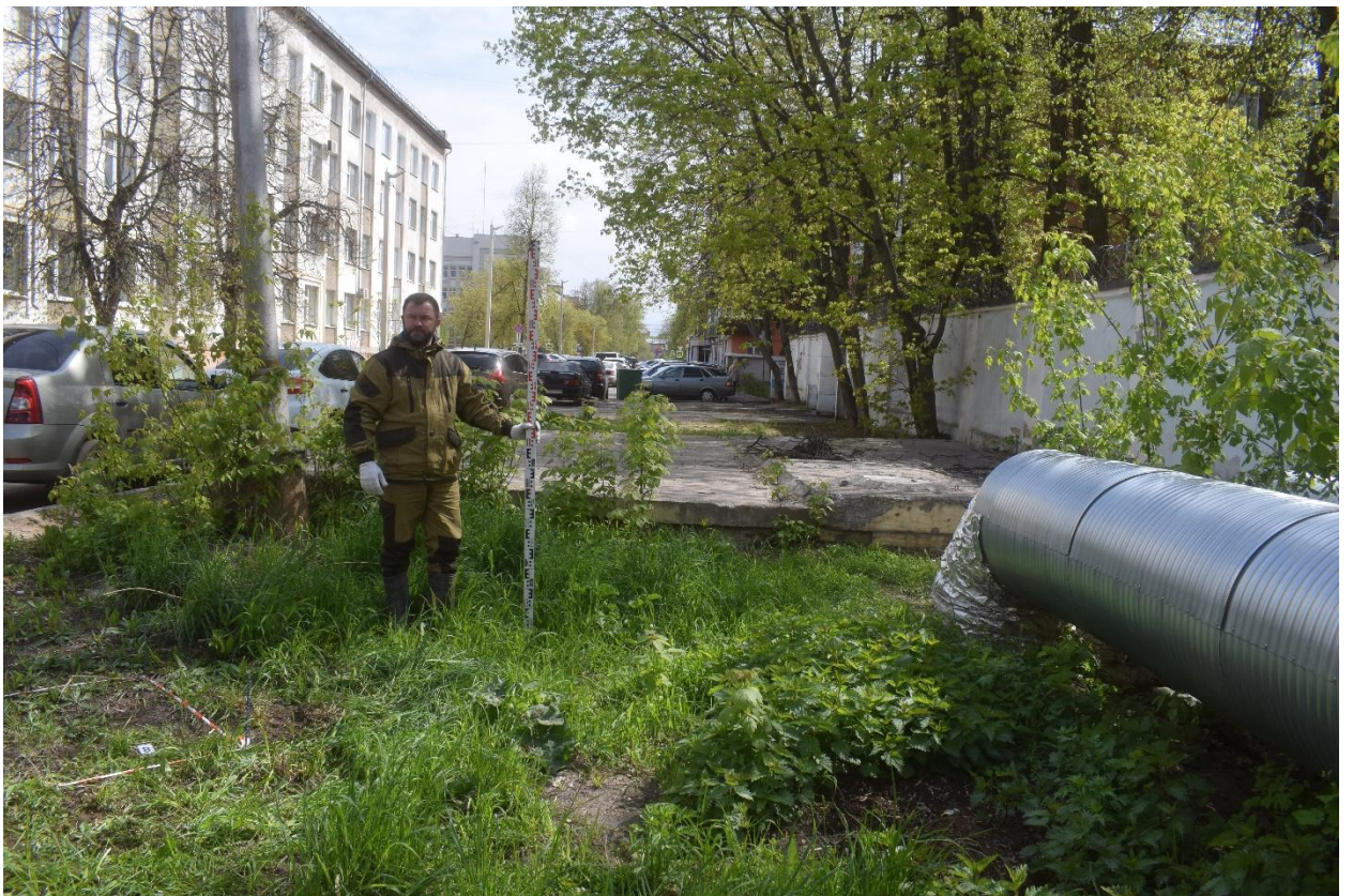
Рис. 52. Ивановская область, г. Иваново, линейный объект под размещение УДС. Общий вид с запада-юго-запада, съёмка от шурфа № 7.
