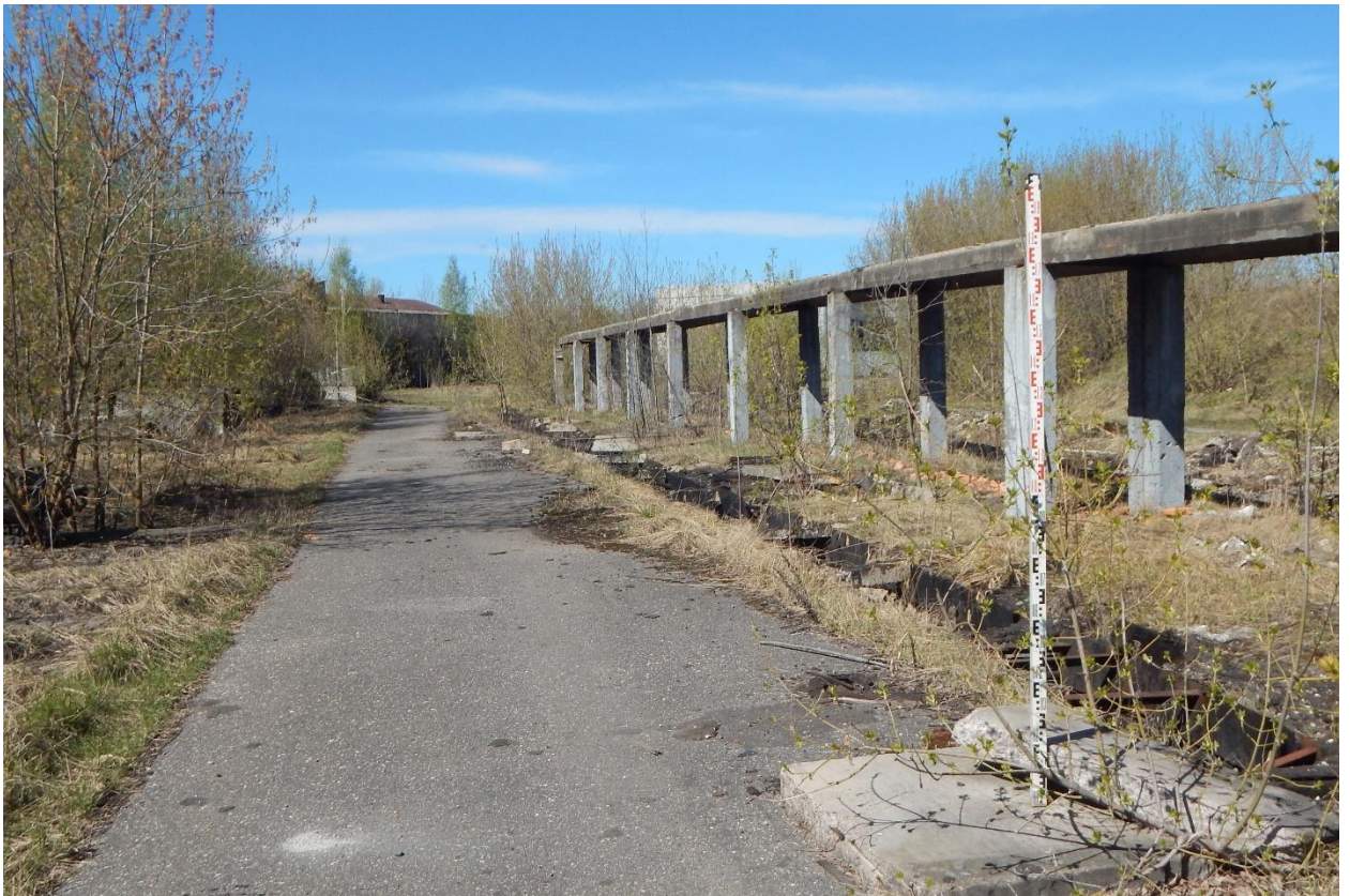
Рис. 23. Ивановская область, г. Иваново, линейный объект под размещение УДС. Точка фотофиксации 4, вид с юго-востока.
