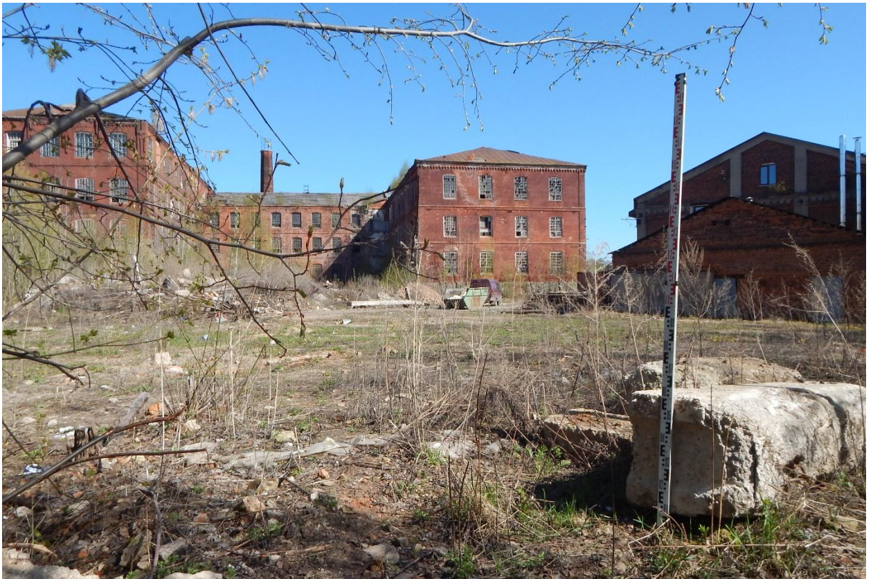
Рис. 45. Ивановская область, г. Иваново, линейный объект под размещение УДС. Точка фотофиксации 10, вид с запада.
