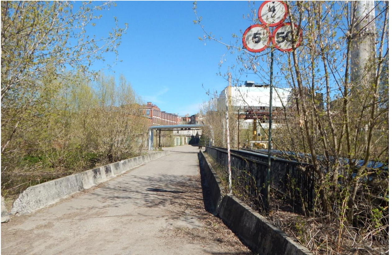
Рис. 43. Ивановская область, г. Иваново, линейный объект под размещение УДС. Точка фотофиксации 8, вид с юго-запада.
