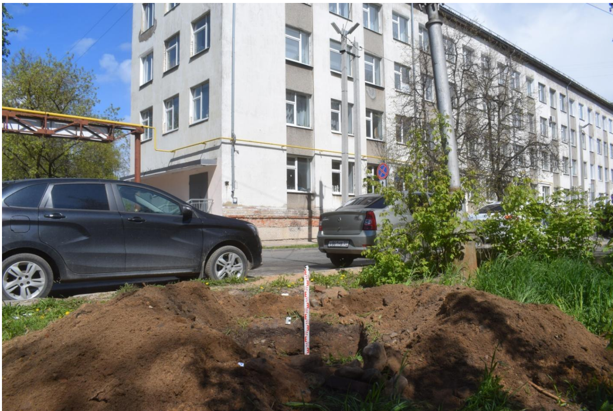
Рис. 55. Ивановская область, г. Иваново, линейный объект под размещение УДС. Общий вид выкопанного шурфа № 7 с юга.
