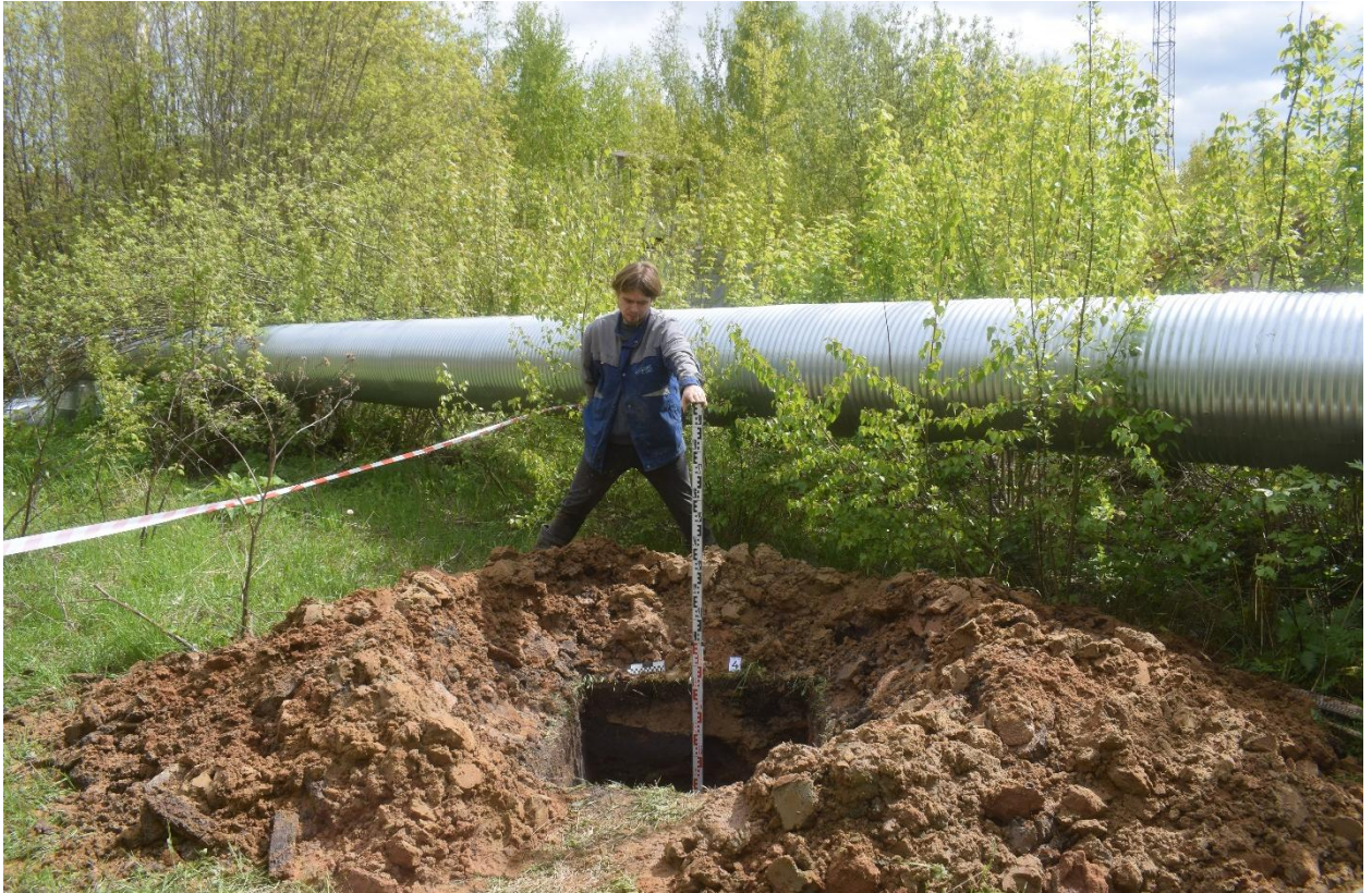
Рис. 37. Ивановская область, г. Иваново, линейный объект под размещение УДС. Общий вид с запада выкопанного шурфа № 4.
