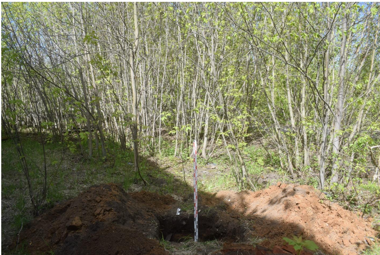
Рис. 33. Ивановская область, г. Иваново, линейный объект под размещение УДС. Общий вид с юга выкопанного шурфа № 3.
