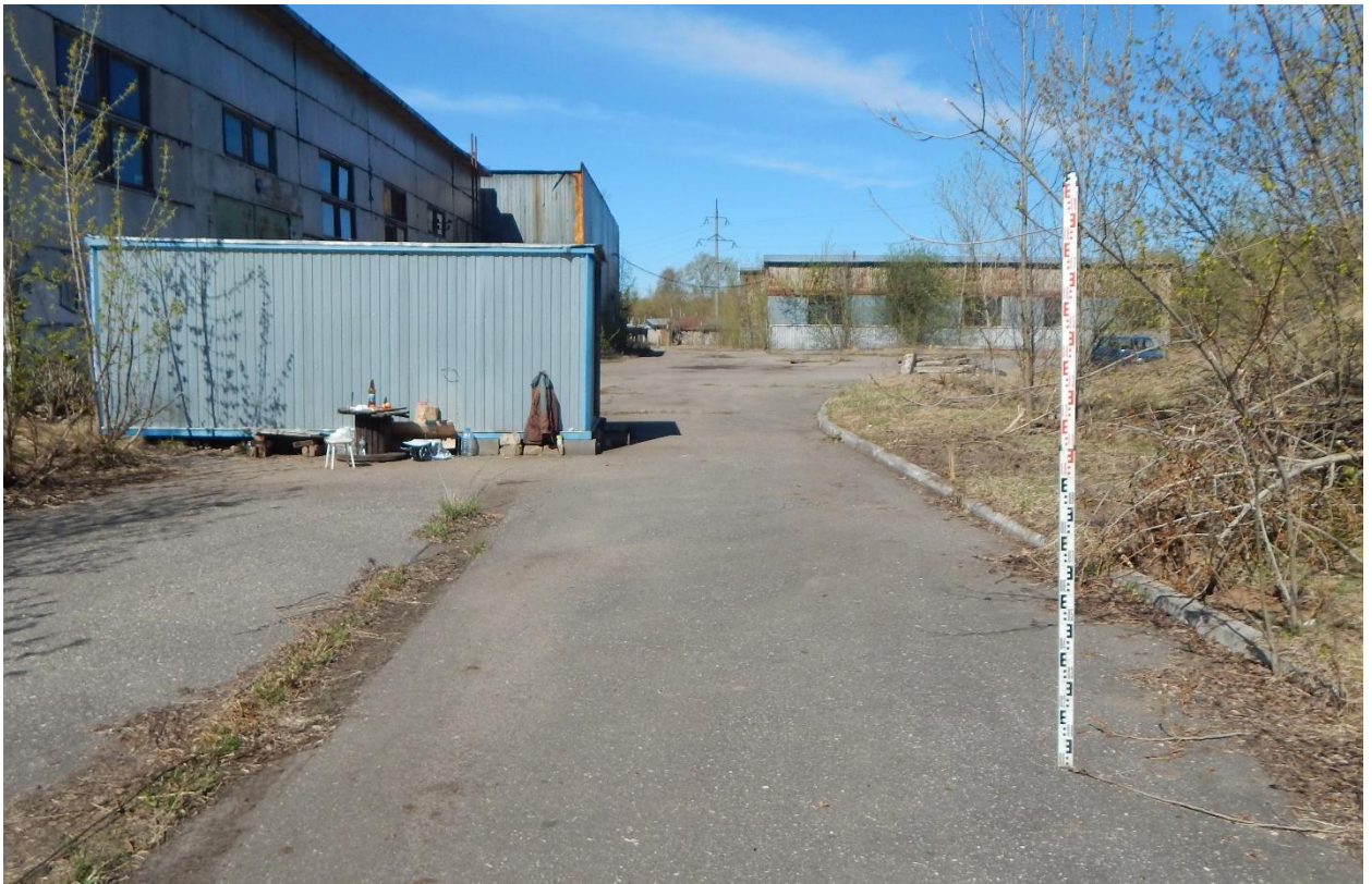
Рис. 17. Ивановская область, г. Иваново, линейный объект под размещение УДС. Точка фотофиксации 2. Вид с юга.
