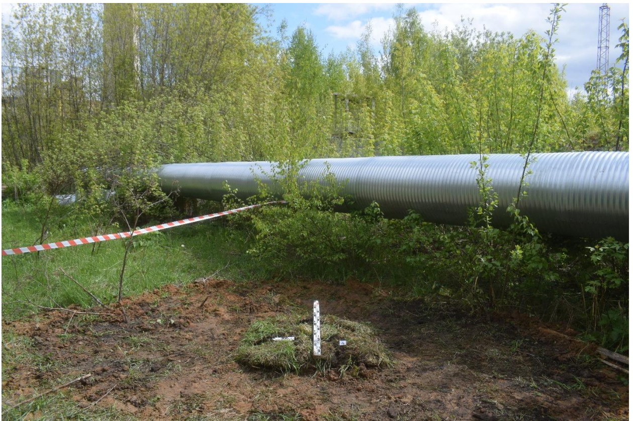
Рис. 38. Ивановская область, г. Иваново, линейный объект под размещение УДС. Шурф № 4, рекультивация, вид с запада.
