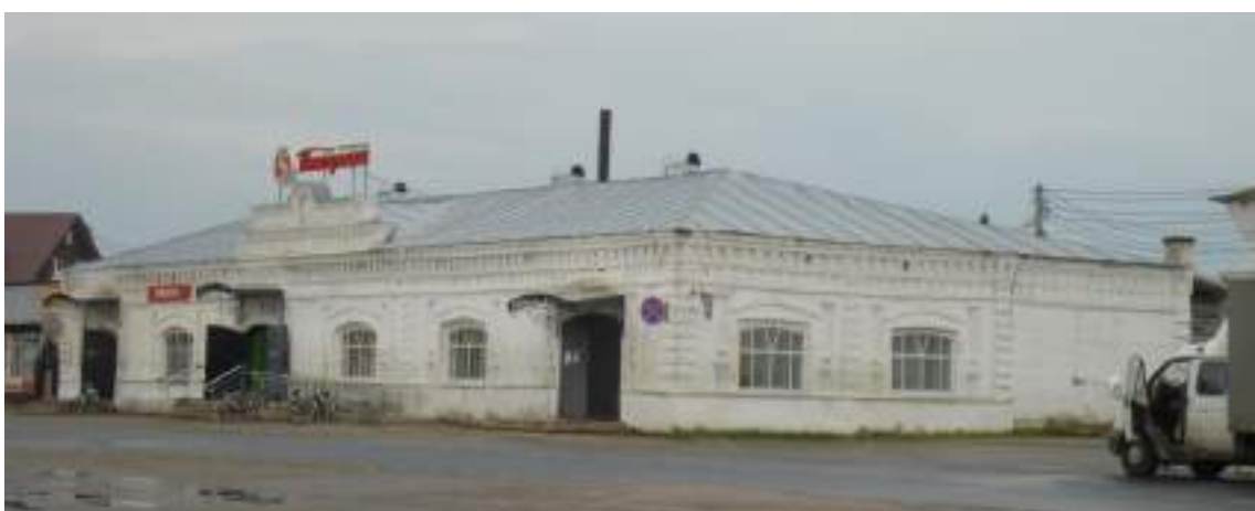
16. Северный корпус торговых рядов (Ул. Красноармейская, 1, лит. Б)
