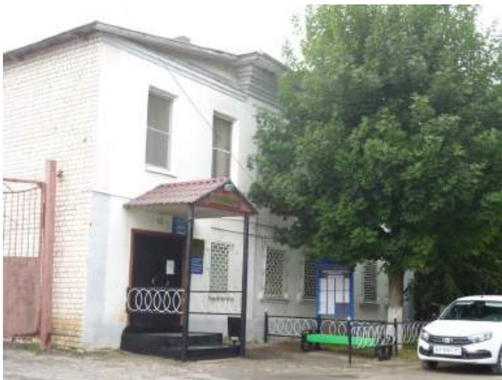
26. Городская ратуша (Ул. Островского, 2).
