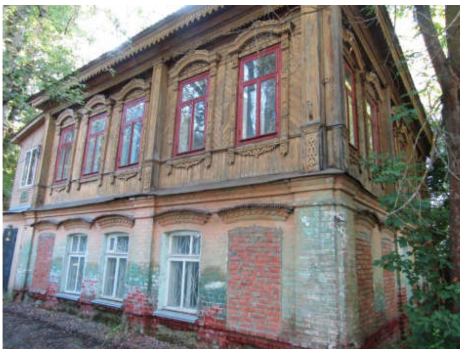
Фото 2. Вид с западной стороны
