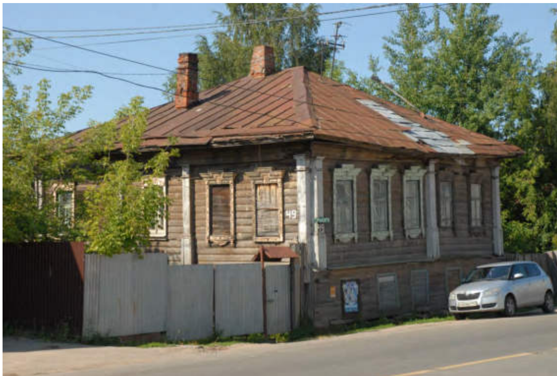
Фото 1. Общий вид с восточной стороны
