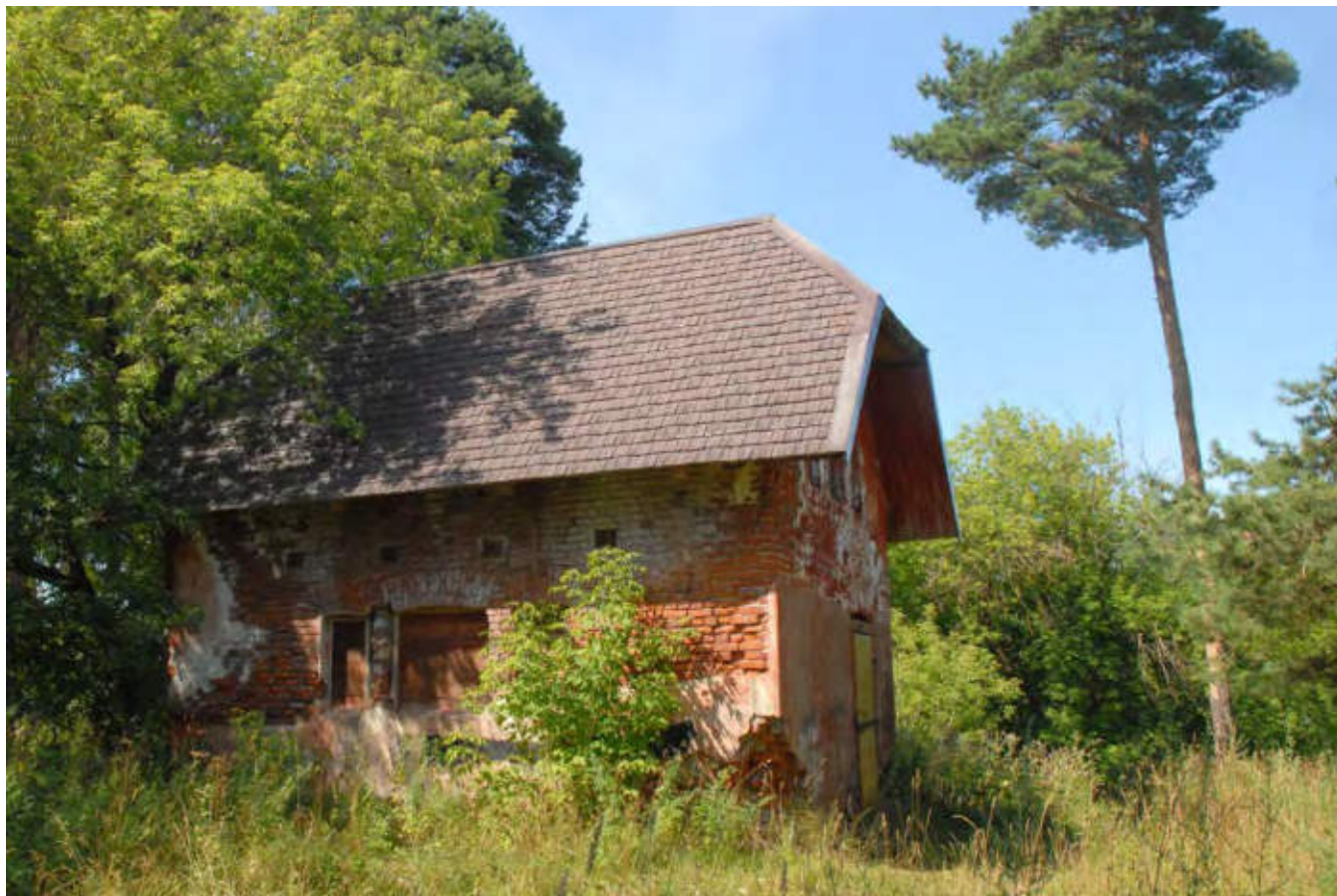
Фото 1. Общий вид с восточной стороны
