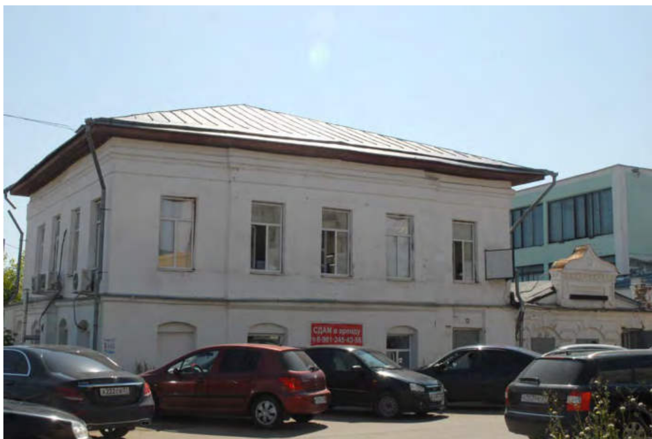
Фото 2. Вид с западной стороны
