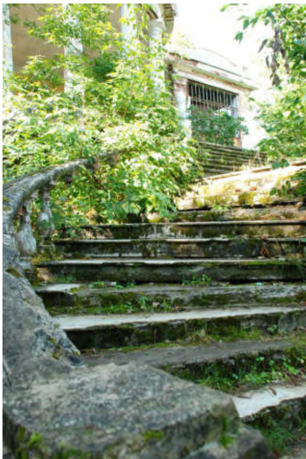
Фото 1. Вид на лестницу с северной стороны
