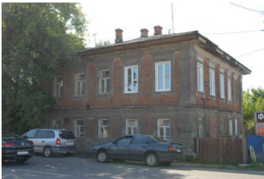
Фото 1. Вид с севера
