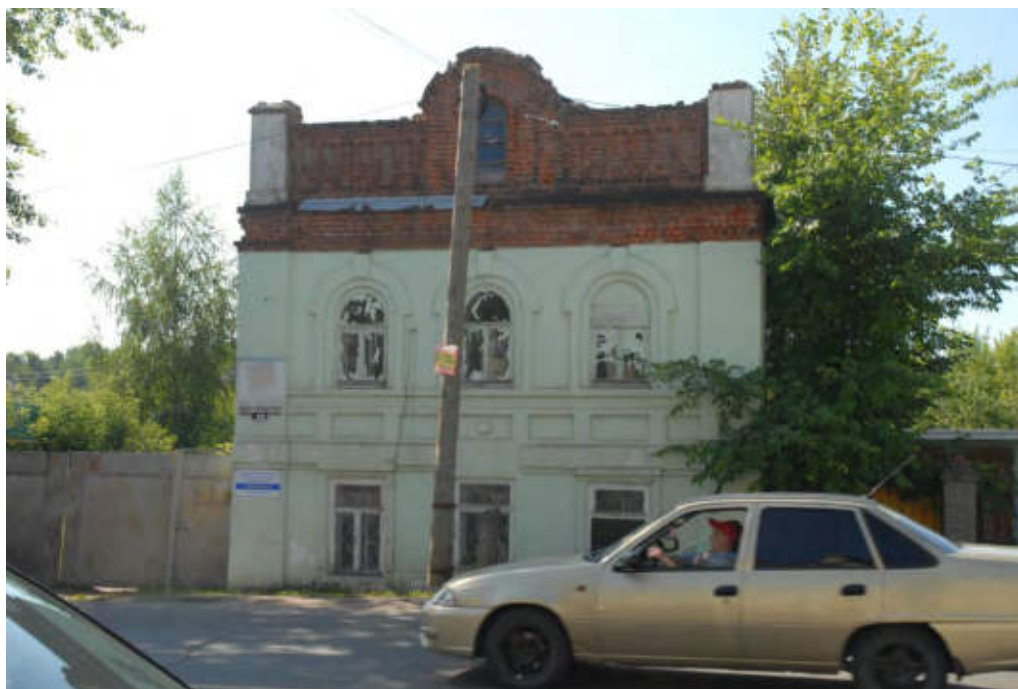
Фото 1. Вид с севера
