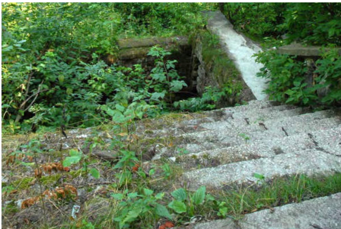
Фото 2. Вид на лестницу с южной стороны
