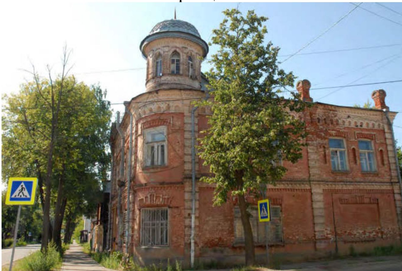
Фото 1. Вид с северной стороны
