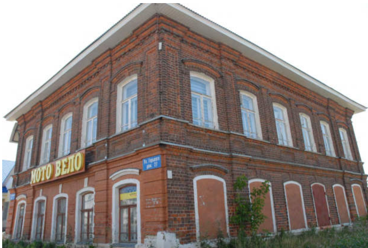
Фото 2. Вид с северо-западной стороны
