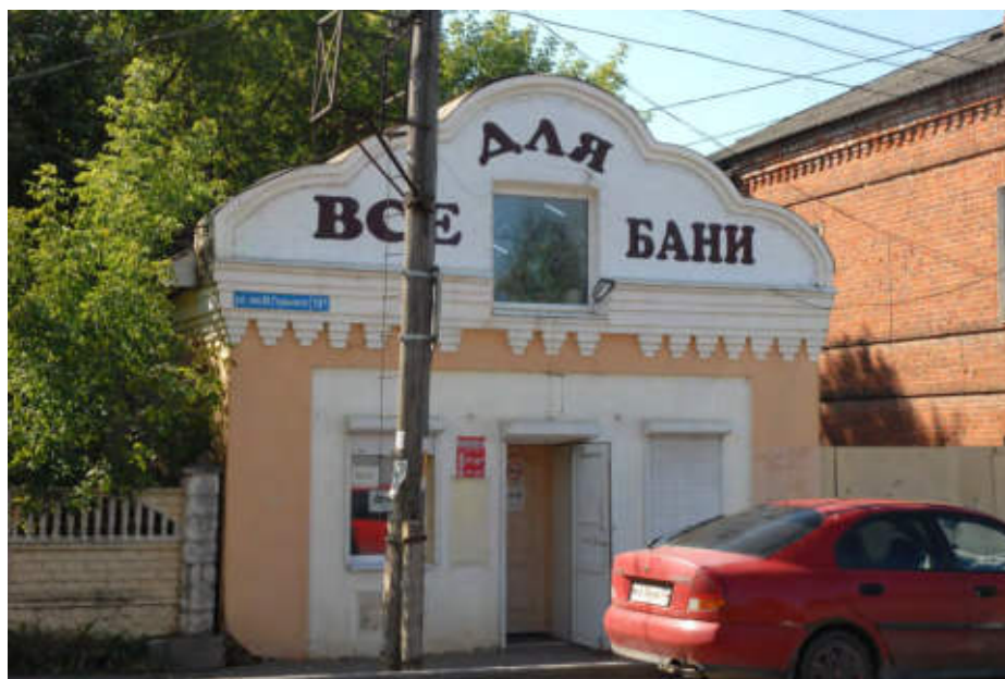
Фото 1. Вид с северной стороны
