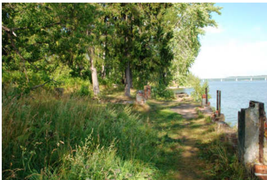
Фото 1. Вид на подпорную стенку набережной
