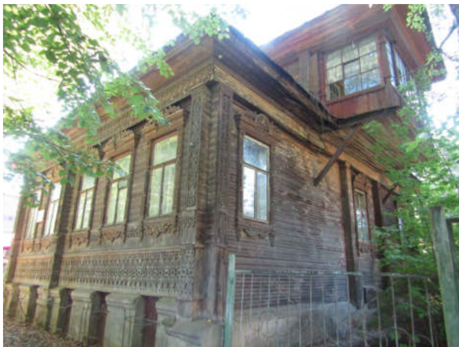
Фото 1. Вид с западной стороны
