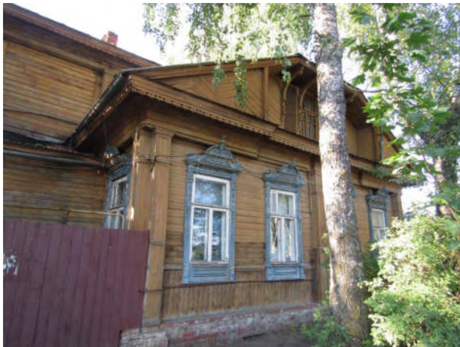
Фото 1. Общий вид с южной стороны
