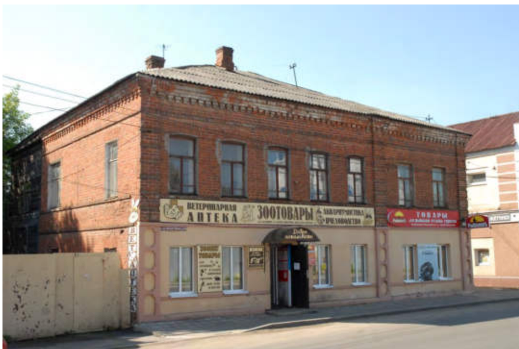
Фото 1. Вид с северной стороны
