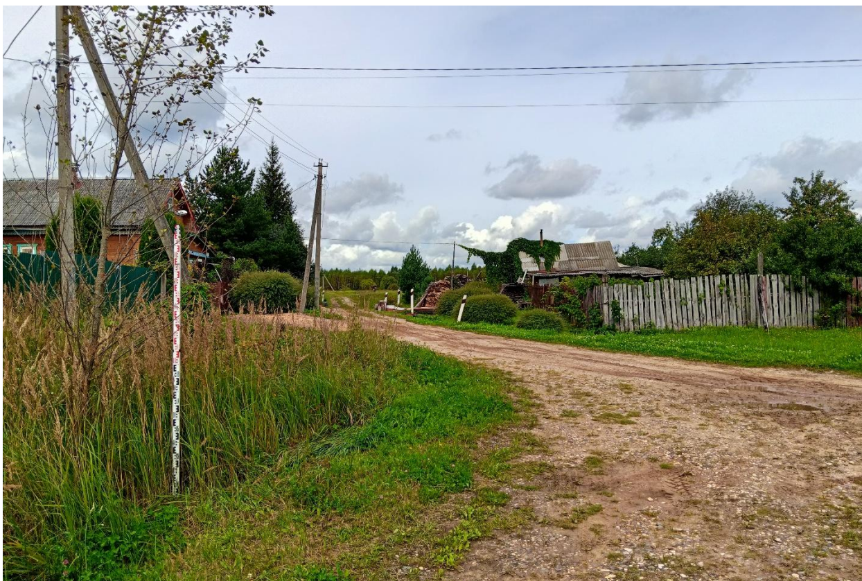
Рис. 58. Ивановская область, Лежневский район, д. Перепечино Большое, газопроводы. Общий вид с юго-востока изучаемой территории. Точка фотофиксации 2.
