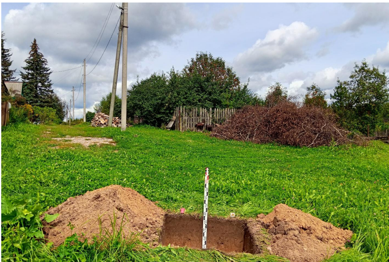
Рис. 76. Ивановская область, Лежневский район, д. Перепечиное Большое, газопроводы. Общий вид с юга выкопанного шурфа № 2.
