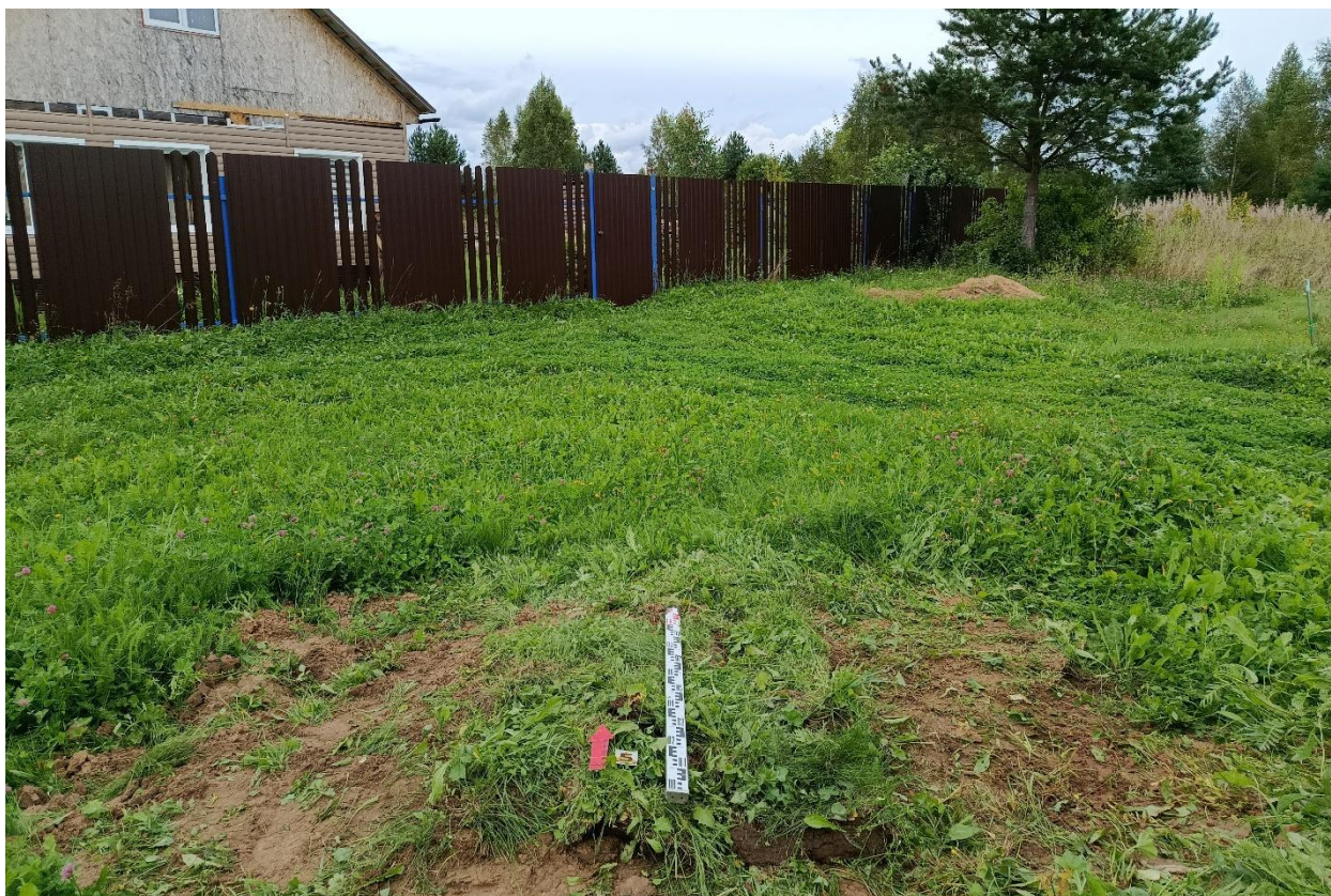
Рис. 92. Ивановская область, Лежневский район, д. Перепечино Большое, газопроводы. Шурф № 5, рекультивация, вид с юга.
