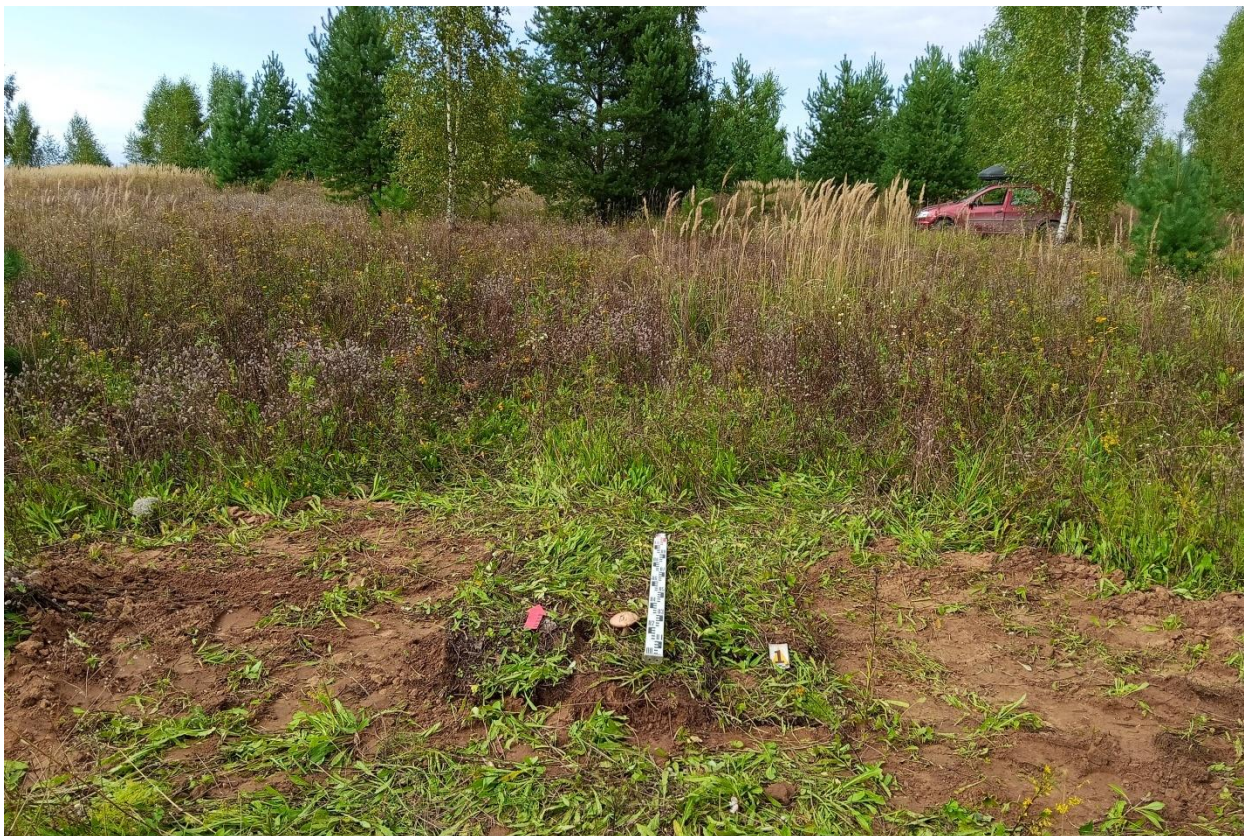
Рис. 27. Ивановская область, Лежневский район, д. Сабуриха, газопроводы. Шурф № 1, рекультивация, вид с юга.
