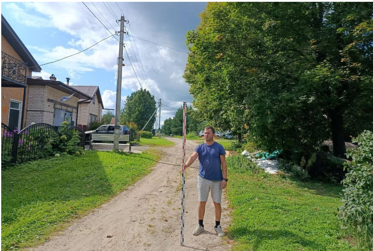
Рис. 17. Ивановская область, Лежневский район, д. Сабуриха, газопроводы. Общий вид с востока-северо-востока изучаемой территории. Точка фотофиксации 3.
