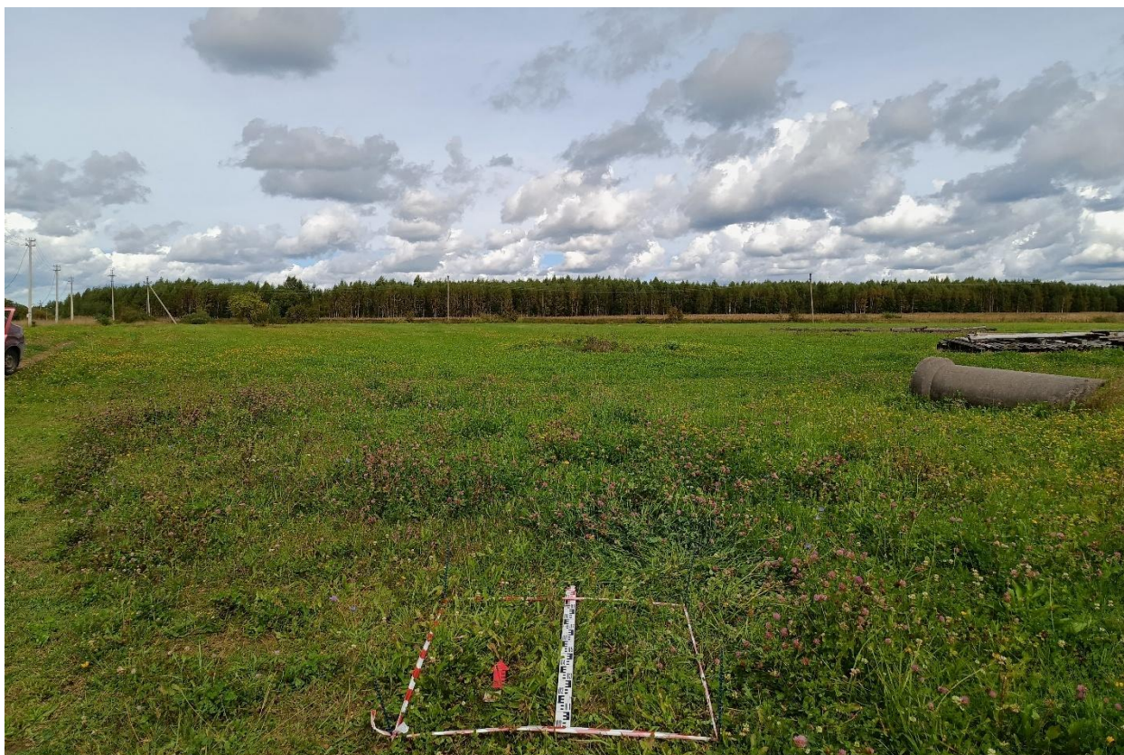
Рис. 68. Ивановская область, Лежневский район, д. Перепечи́но Большо́е, газопроводы. Шурф № 1, разметка и общий вид с юга.
