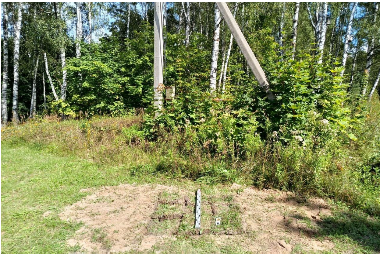
Рис. 37. Ивановская область, Лежневский район, д. Сабуриха, газопроводы. Шурф № 3, рекультивация, вид с юга.
