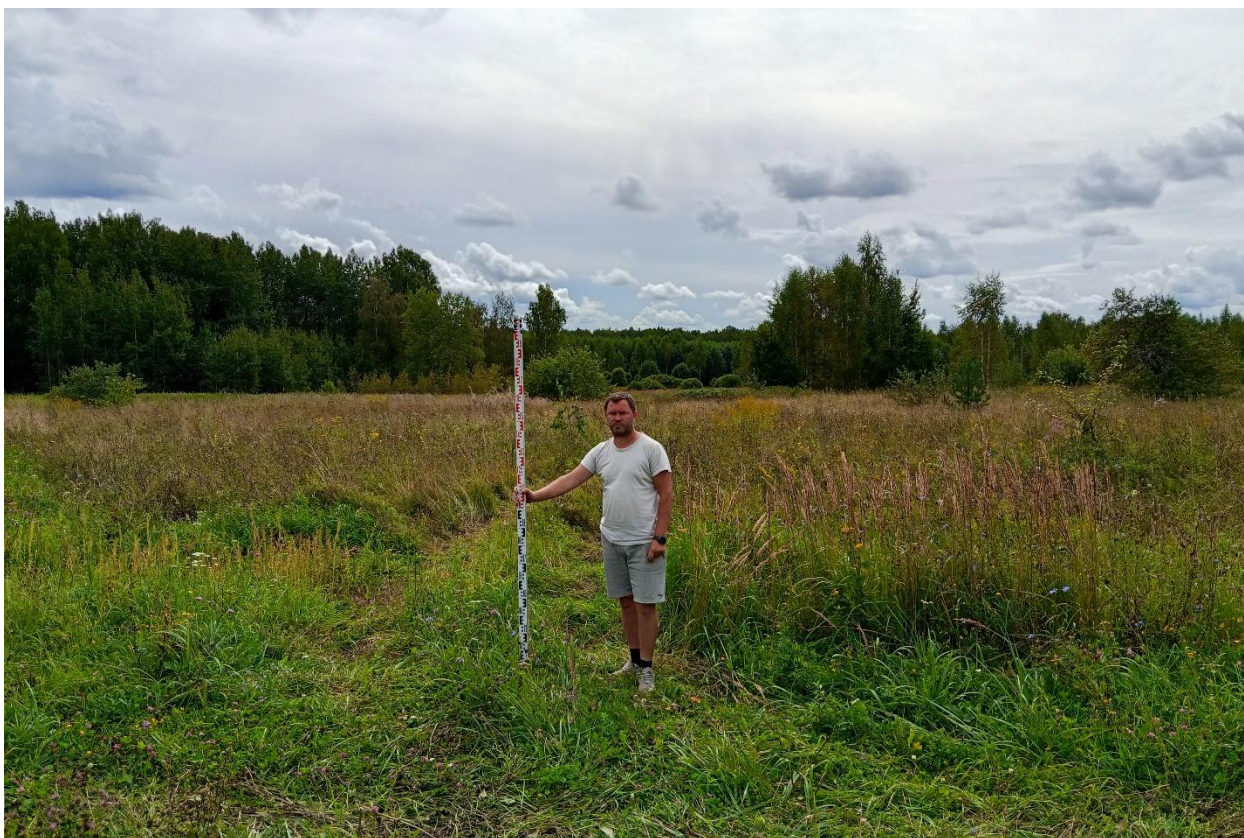
Рис. 67. Ивановская область, Лежневский район, д. Перепечи́но Большо́е, газопроводы. Общий вид с северо-запада изучаемой территории. Точка фотофиксации 8.
