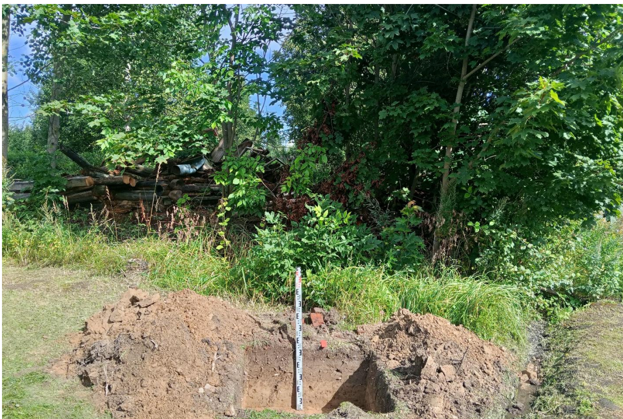
Рис. 41. Ивановская область, Лежневский район, д. Сабуриха, газопроводы. Общий вид с юга выкопанного шурфа № 4.
