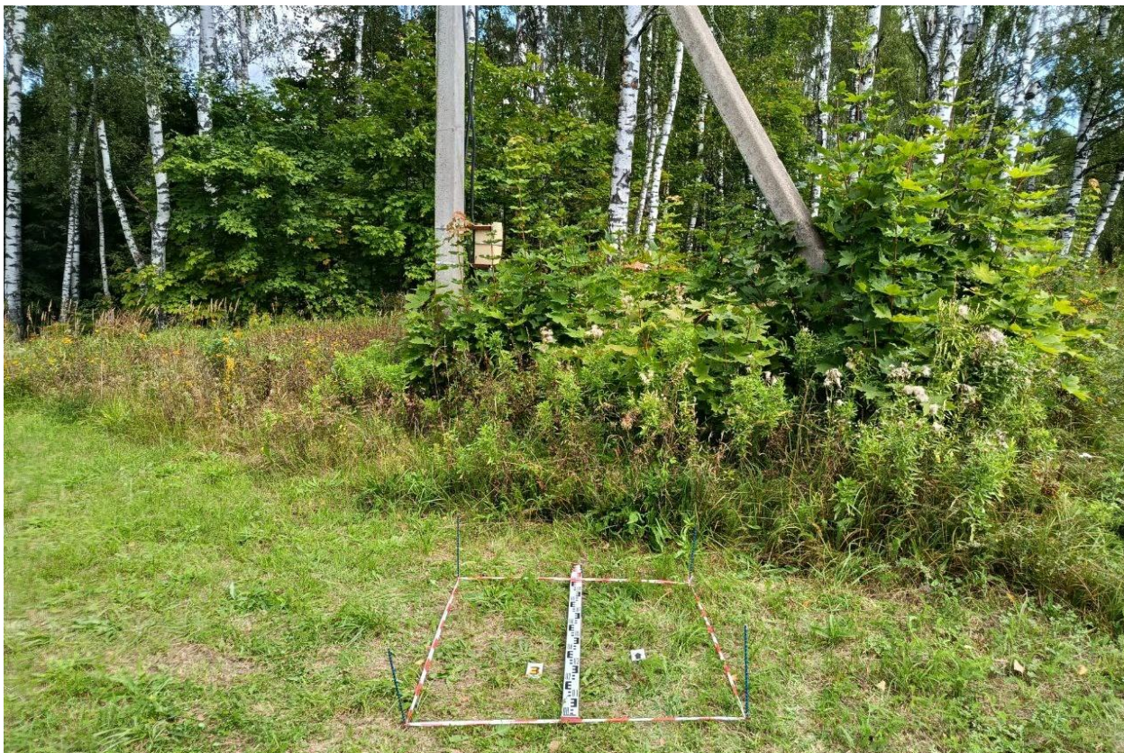
Рис. 33. Ивановская область, Лежневский район, д. Сабуриха, газопроводы. Шурф № 3, разметка и общий вид с юга.
