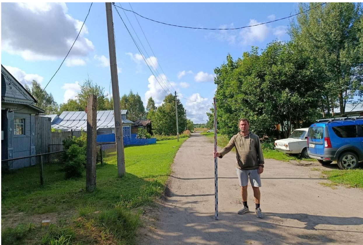
Рис. 16. Ивановская область, Лежневский район, д. Сабуриха, газопроводы. Общий вид с северо-востока изучаемой территории. Точка фотофиксации 2.
