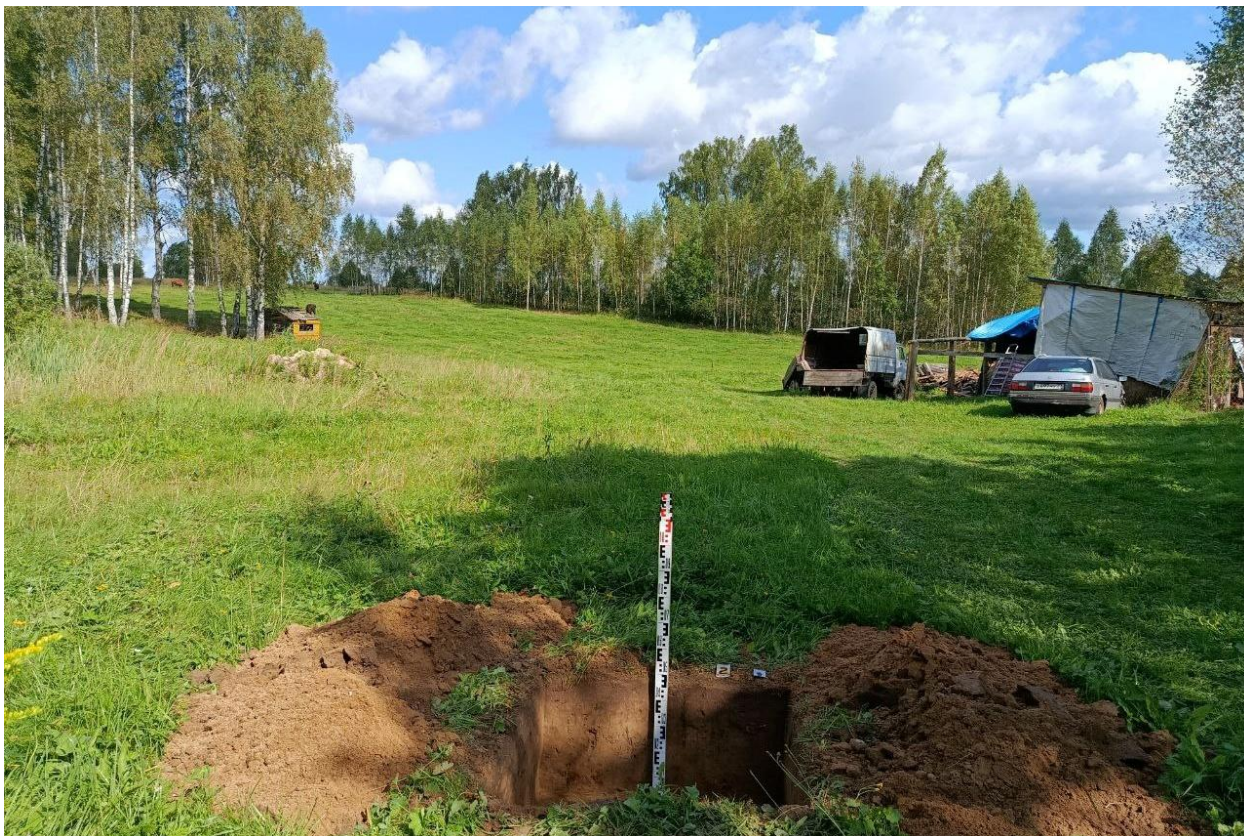
Рис. 31. Ивановская область, Лежневский район, д. Сабуриха, газопроводы. Общий вид с юга выкопанного шурфа № 2.
