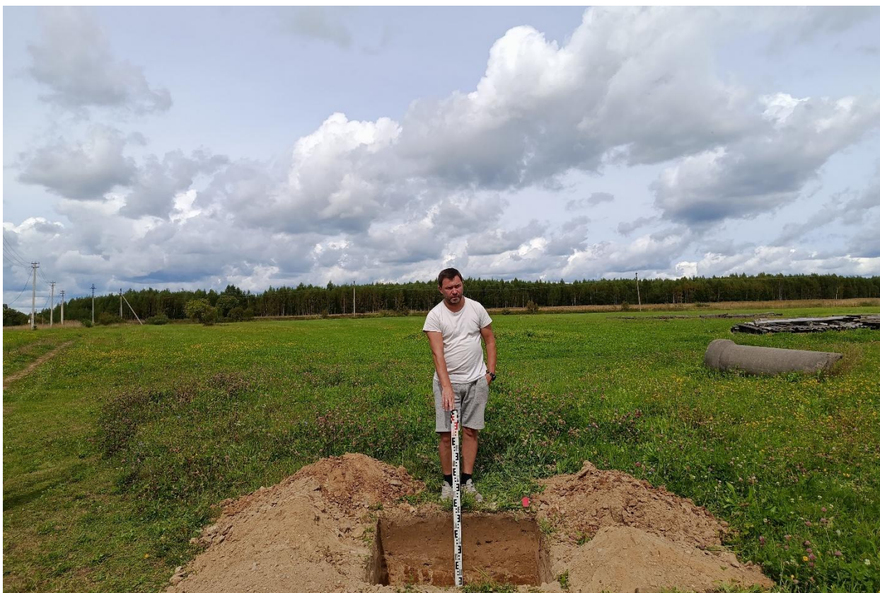
Рис. 71. Ивановская область, Лежневский район, д. Перепечиное Большое, газопроводы. Общий вид с юга выкопанного шурфа № 1.
