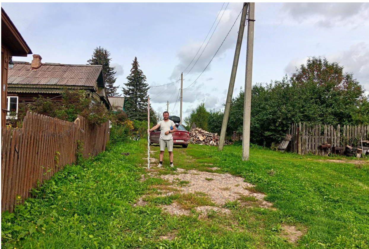
Рис. 60. Ивановская область, Лежневский район, д. Перепечи́но Большо́е, газопроводы. Общий вид с юга изучаемой территории. Точка фотофиксации 3.
