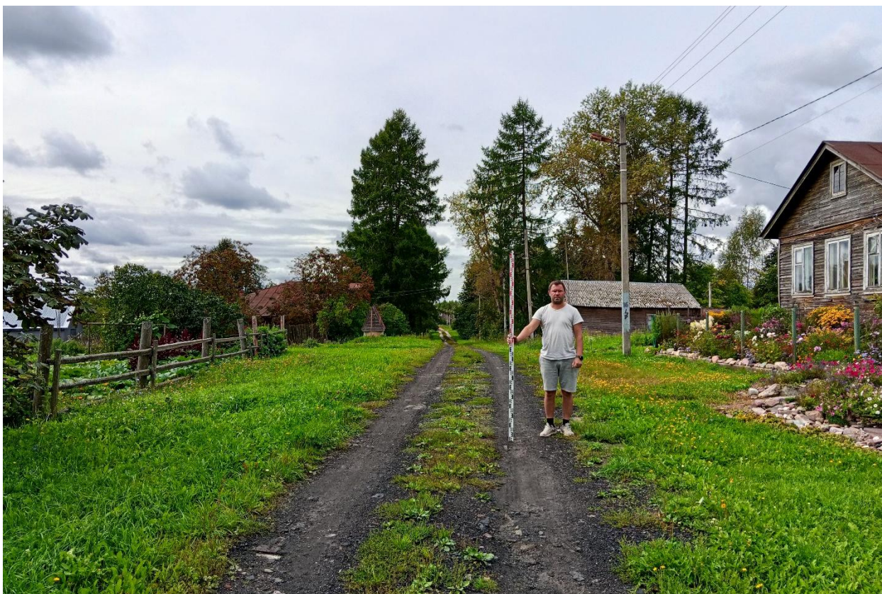
Рис. 61. Ивановская область, Лежневский район, д. Перепечи́но Большо́е, газопроводы. Общий вид с востока изучаемой территории. Точка фотофиксации 4.
