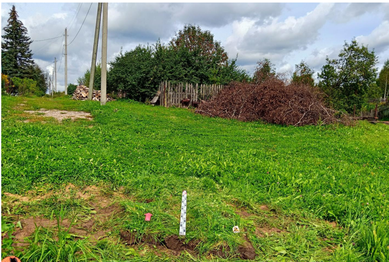
Рис. 77. Ивановская область, Лежневский район, д. Перепечиное Большое, газопроводы. Шурф № 2, рекультивация, вид с юга.
