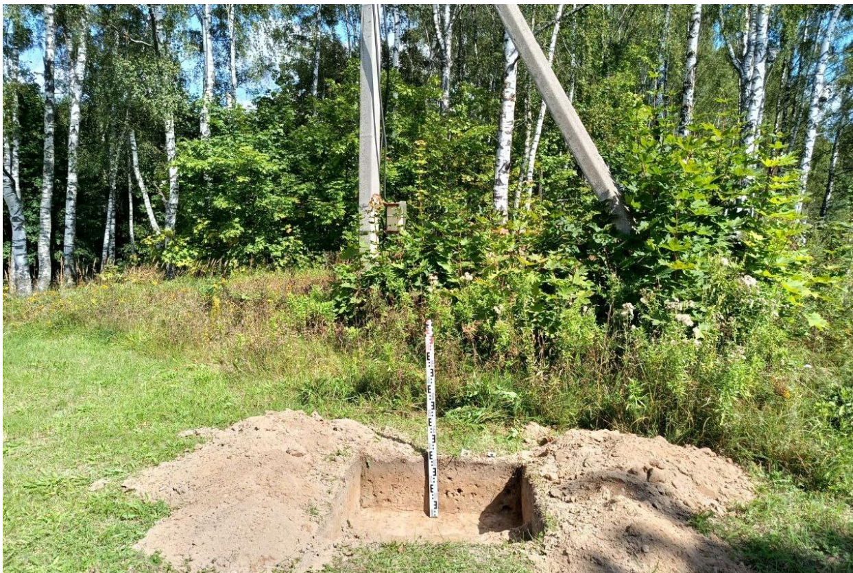
Рис. 36. Ивановская область, Лежневский район, д. Сабуриха, газопроводы. Общий вид с юга выкопанного шурфа № 3.
