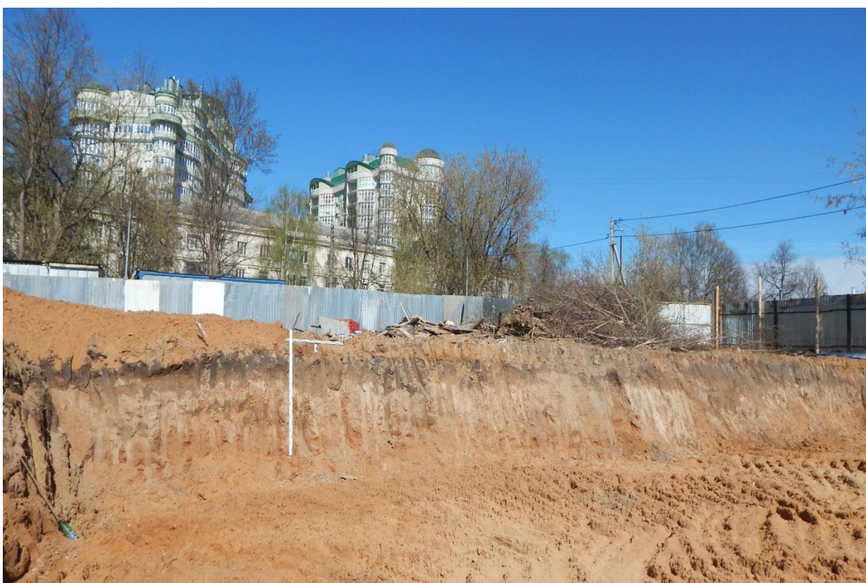
Рис. 25. г. Иваново, ул. Народная, участок к/н 37:24:010146:199. Зачистка № 2, разметка и общий вид с юга.
