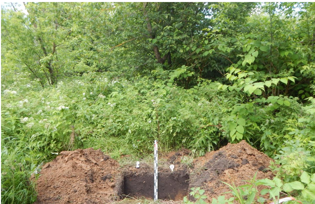
Рис. 22. Ивановская область, г. Кинешма, объект: «Строительство централизованной системы водоотведения». Общий вид с юга выкопанного шурфа № 2.
