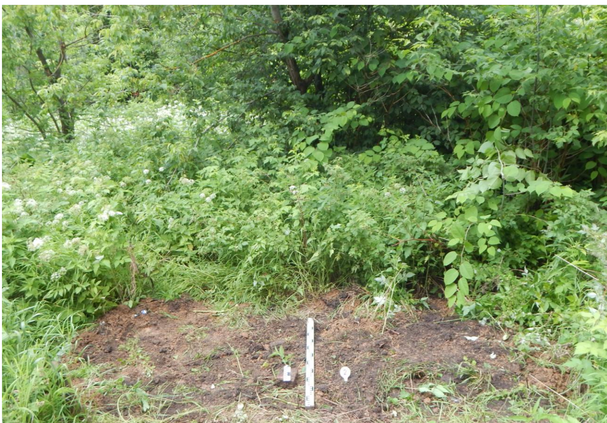
Рис. 23. Ивановская область, г. Кинешма, объект: «Строительство централизованной системы водоотведения». Шурф № 2, рекультивация, вид с юга.
