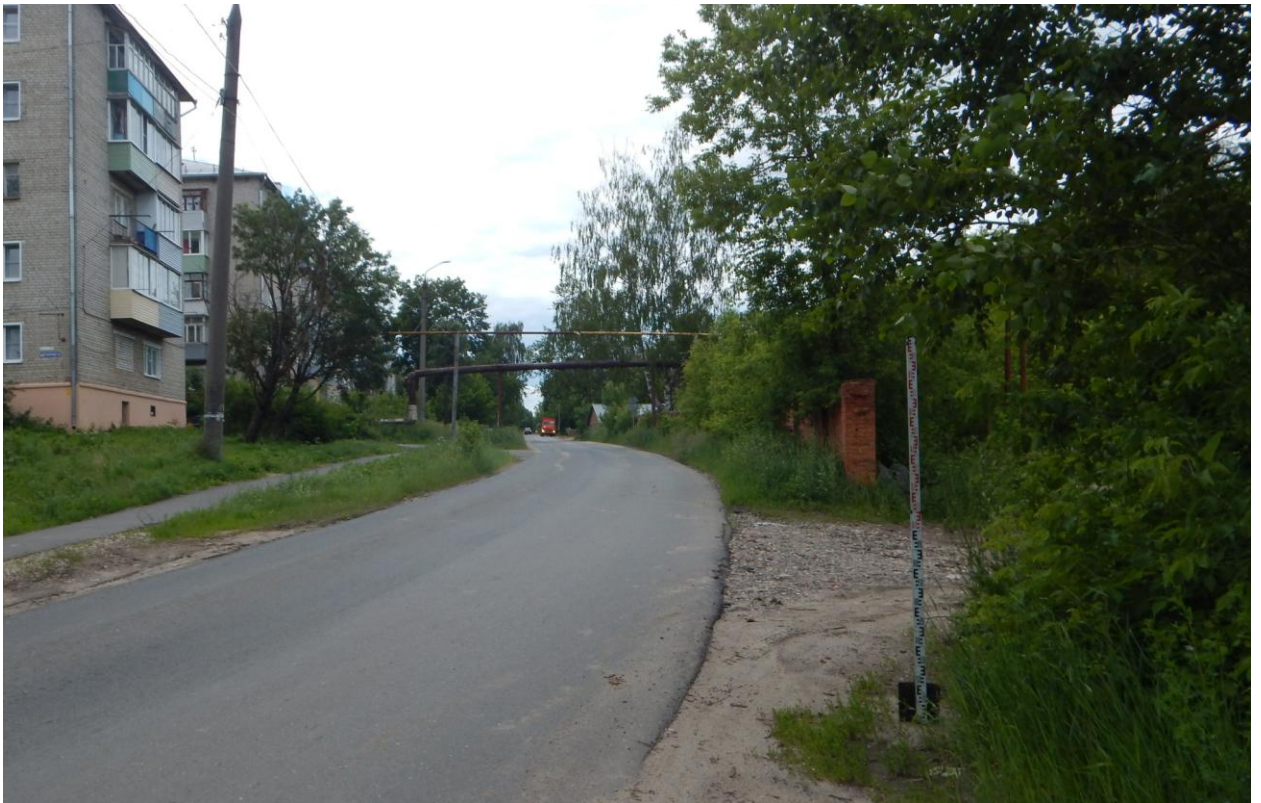
Рис. 13. Ивановская область, г. Кинешма, объект: «Строительство централизованной системы водоотведения». Общий вид линейного объекта с юго-запада. Точка фотофиксации 4.
