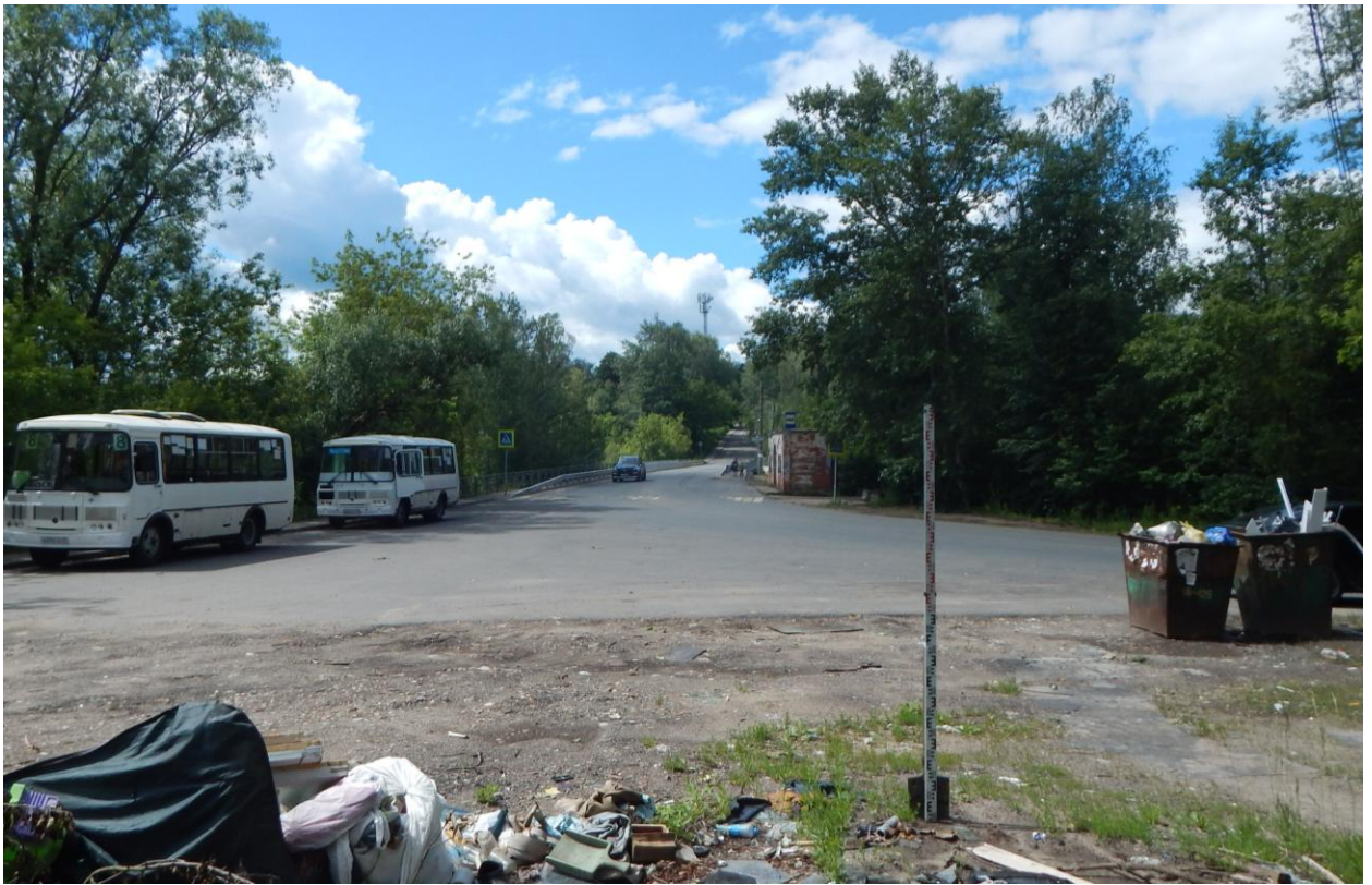
Рис. 10. Ивановская область, г. Кинешма, объект: «Строительство централизованной системы водоотведения». Общий вид линейного объекта с северо-востока. Точка фотофиксации 1.
