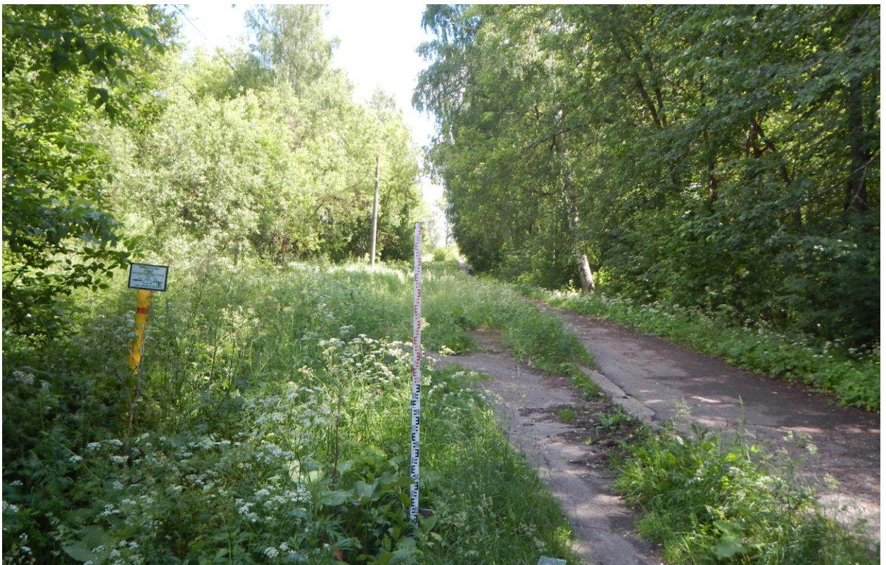
Рис. 11. Ивановская область, г. Кинешма, объект: «Строительство централизованной системы водоотведения». Общий вид линейного объекта с запада-юго-запада. Точка фотофиксации 2.
