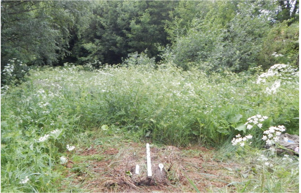
Рис. 18. Ивановская область, г. Кинешма, объект: «Строительство централизованной системы водоотведения». Шурф № 1, рекультивация, вид с юга.
