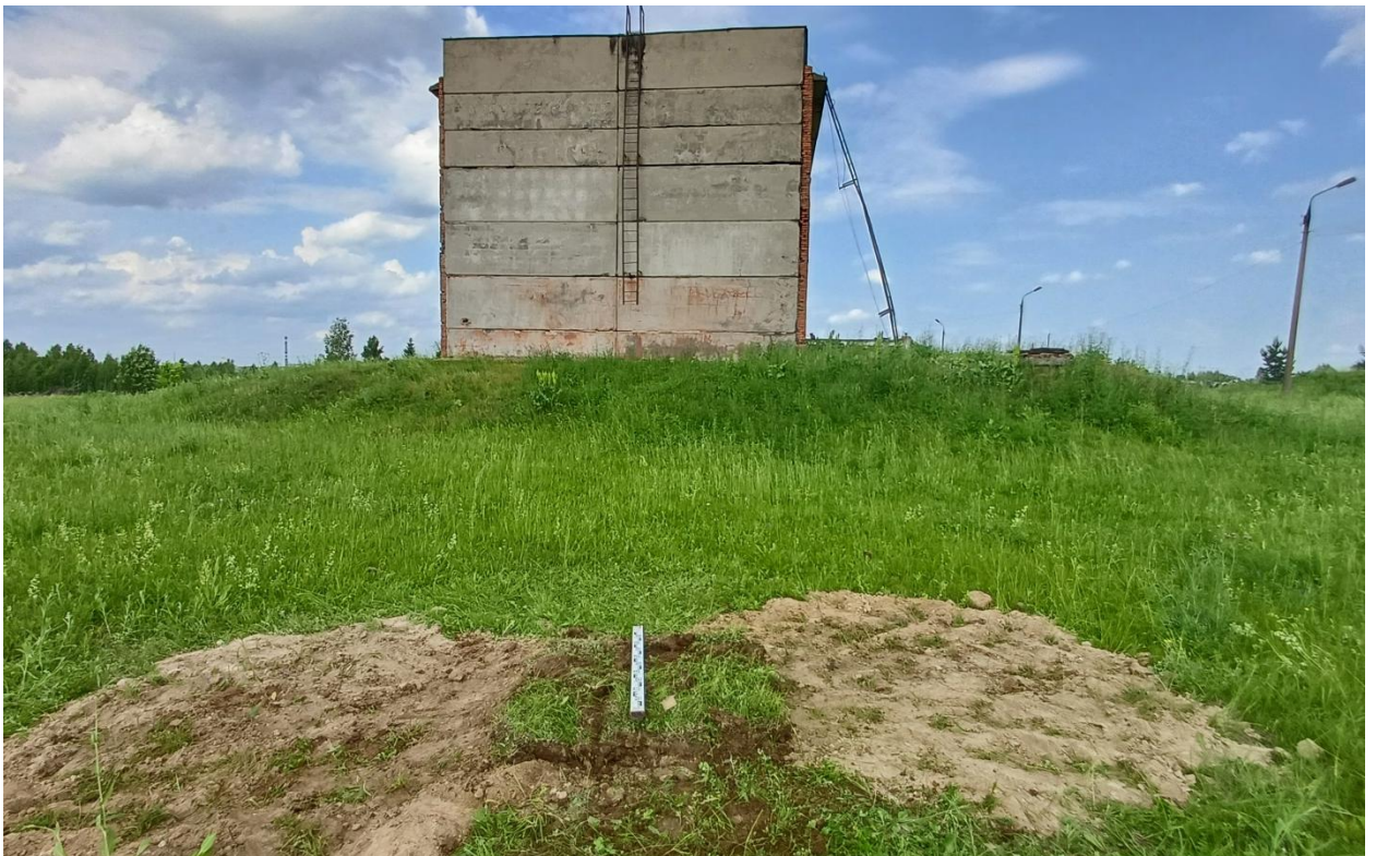
Рис. 16. Ивановская область, Шуйский район, объект «Реконструкция очистных сооружений» в районе д. Змеево. Разведочный шурф, рекультивация, вид с юго-юго-запада.
