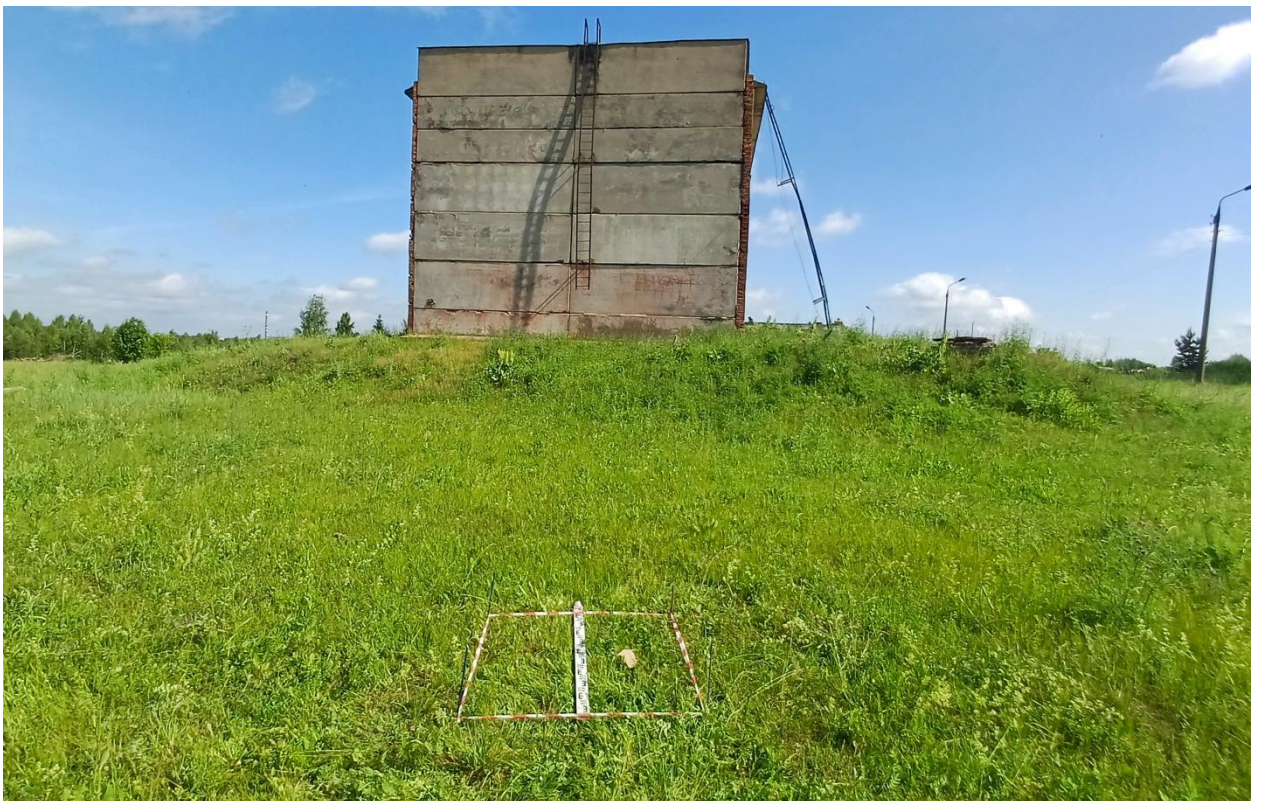
Рис. 12. Ивановская область, Шуйский район, объект «Реконструкция очистных сооружений» в районе д. Змеево. Разведочный шурф, разметка и общий вид с юго-юго-запада.
