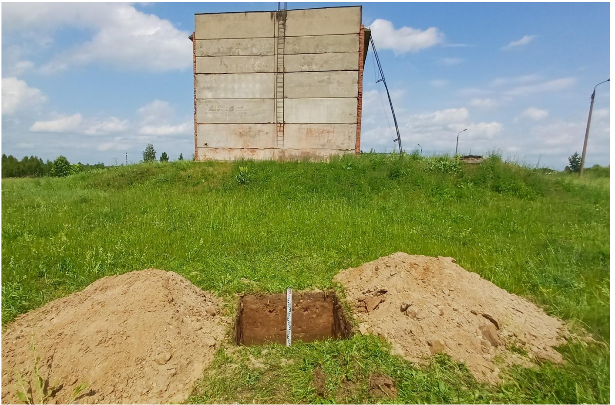
Рис. 15. Ивановская область, Шуйский район, объект «Реконструкция очистных сооружений» в районе д. Змеево. Общий вид выкопанного разведочного шурфа с юго-юго-запада.
