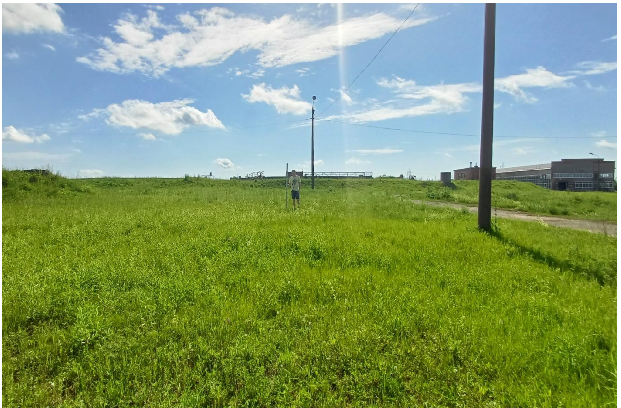
Рис. 10. Ивановская область, Шуйский район, объект «Реконструкция очистных сооружений» в районе д. Змеево. Общий вид на участок работ с северо-северо-запада. Точка фотофиксации 1.
