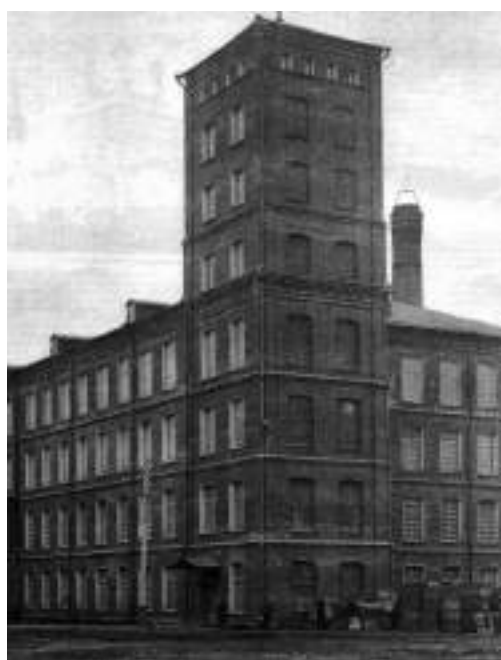
Рис. 11. Прядильный корпус с юга. Фото 1896 г.
