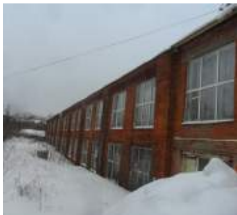
Рис. 36. Западный фасад северной части отделочного корпуса
