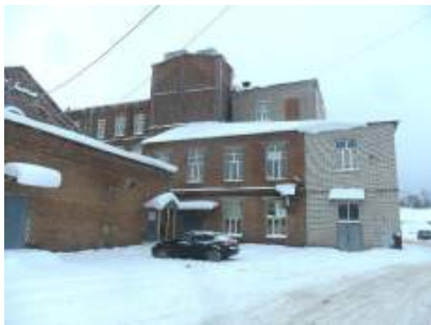
Рис. 17. Прядильный корпус с северо-востока с пристройками 1970-90-х гг.
