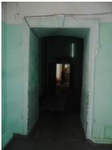
Рис. 23. Обрамление дверного проема на лестнично-лифтовой узел
