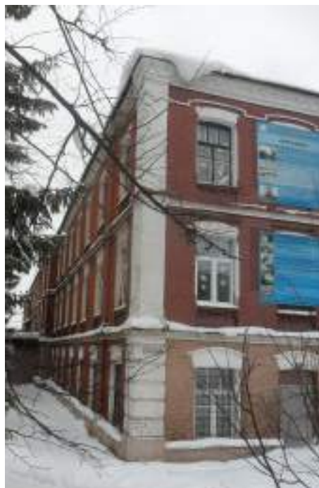
Рис.74, 75. Семейная рабочая казарма Фрагменты фасадов
