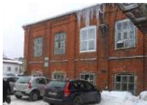
Рис. 67. Юго-западный фасад юго-западного блока, в котором размещена урна с прахом М.К.Кочетовой. Современное фото.
