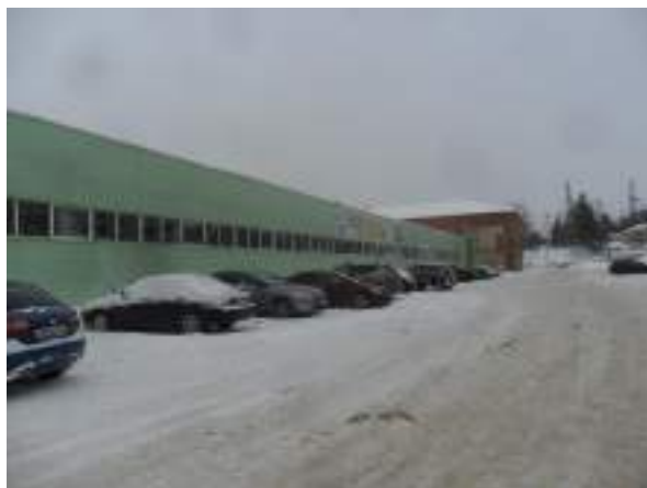
Рис. 33. Юго-западный фасад ткацкого корпуса
