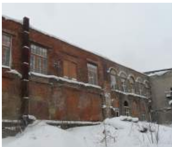
Рис. 42. Фрагмент западного фасада отделочного корпуса. Современное фото.
