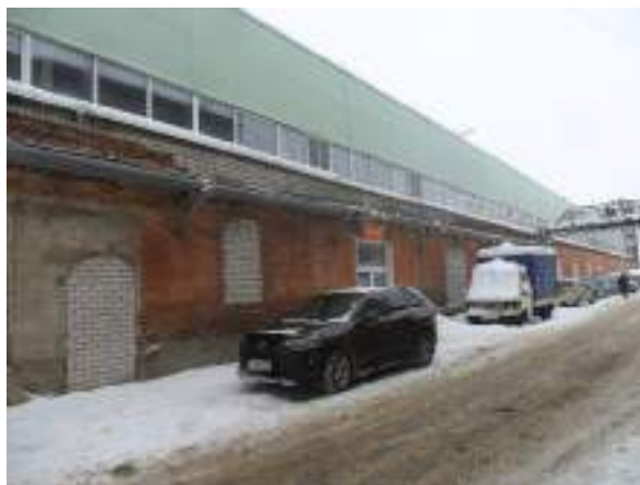
Рис. 34. Северо-западный фасад ткацкого корпуса
