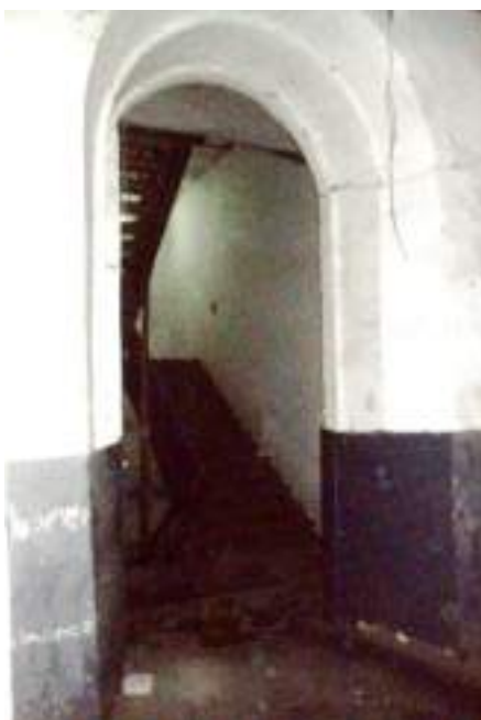
Рис. 47. Вход на лестницу
