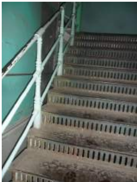
Рис. 20. Пролет одной из лестниц
