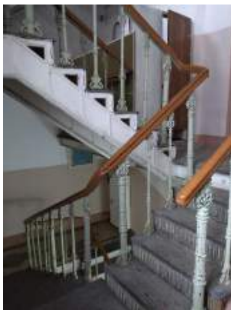
Рис.85. Металлическая лестница в театральном блоке
