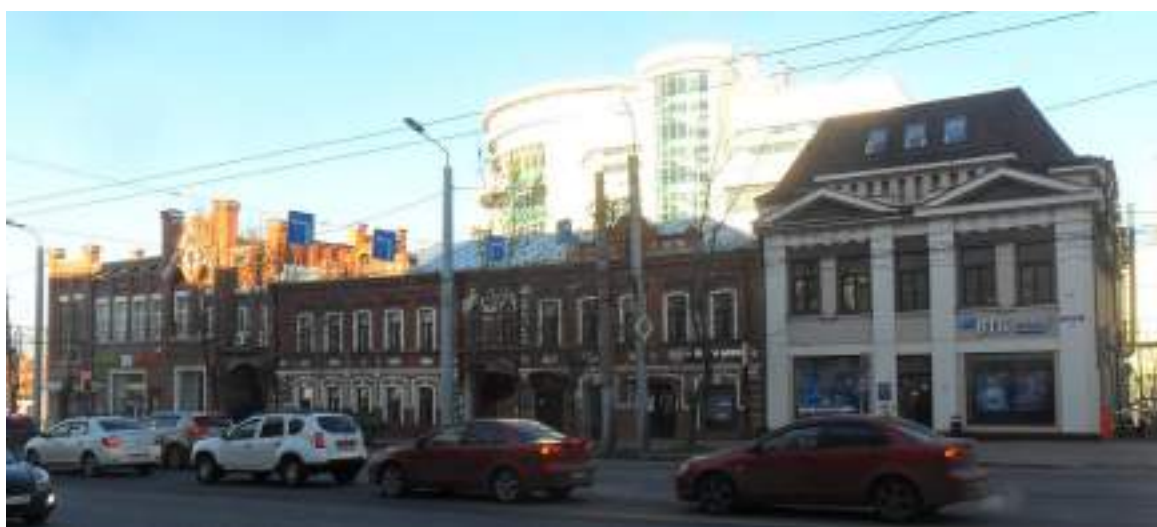
Фото 6. Общий вид северной стороны проспекта в завершающей части Слева – дом № 40, далее – 38, 36 и пр.
