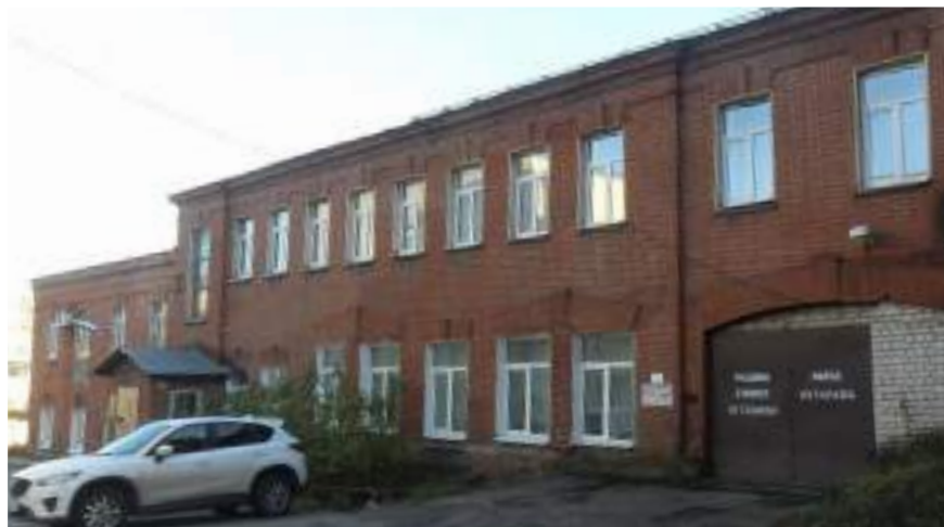
Фото 30. Дом № 16. Задняя пристройка.
