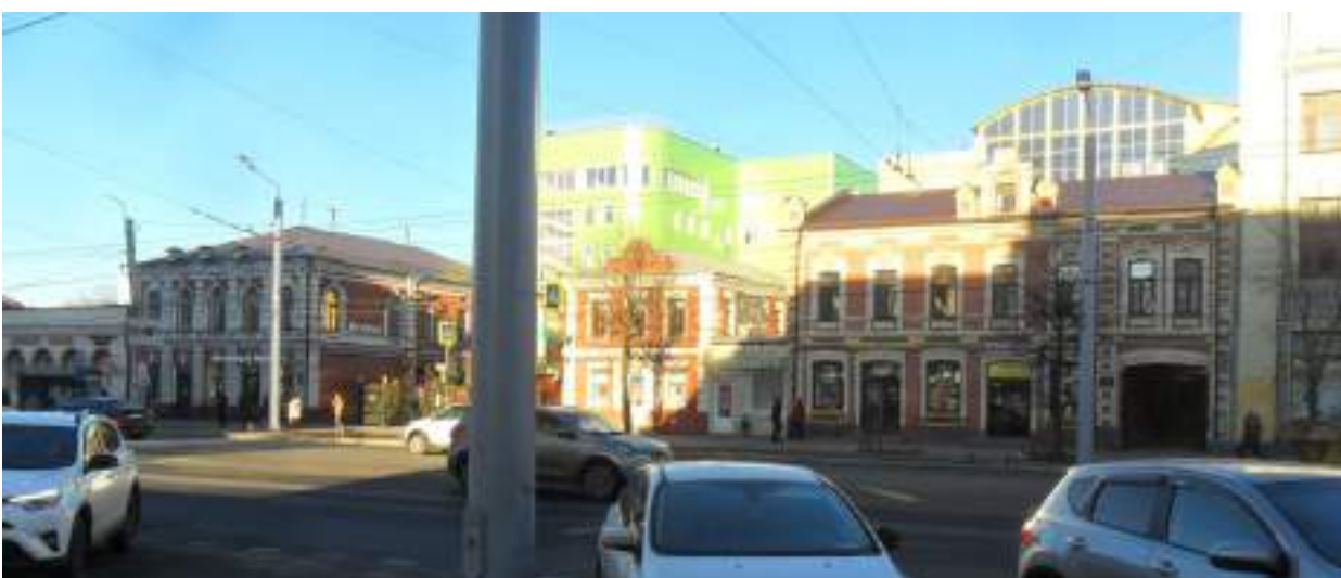
Фото 4. Общий вид северной стороны проспекта в центральной части Справа – дом № 20, далее – 22, 26 и пр. Сзади исторической застройки доминируют новые диссонирующие здания
