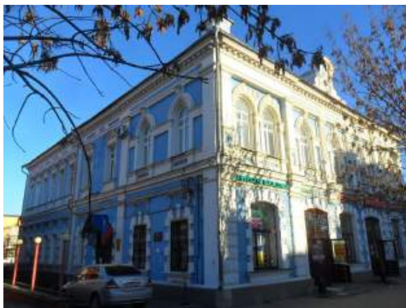
Фото 23. Дом № 6. Главный и боковой фасады.
