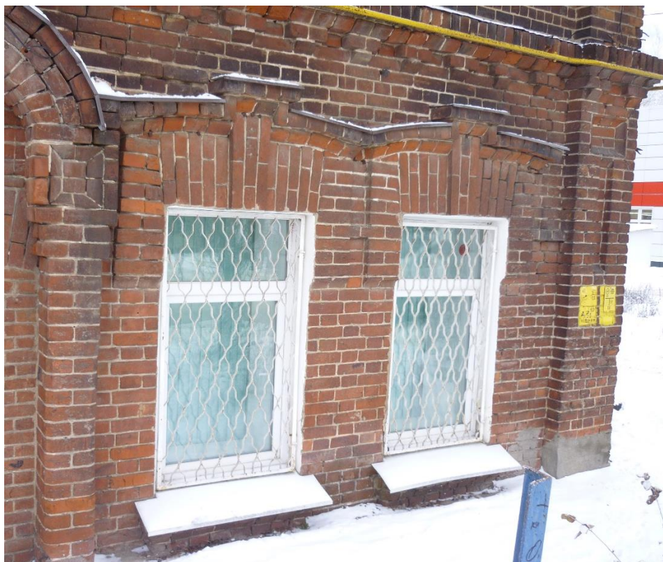
5. Окна первого этажа
