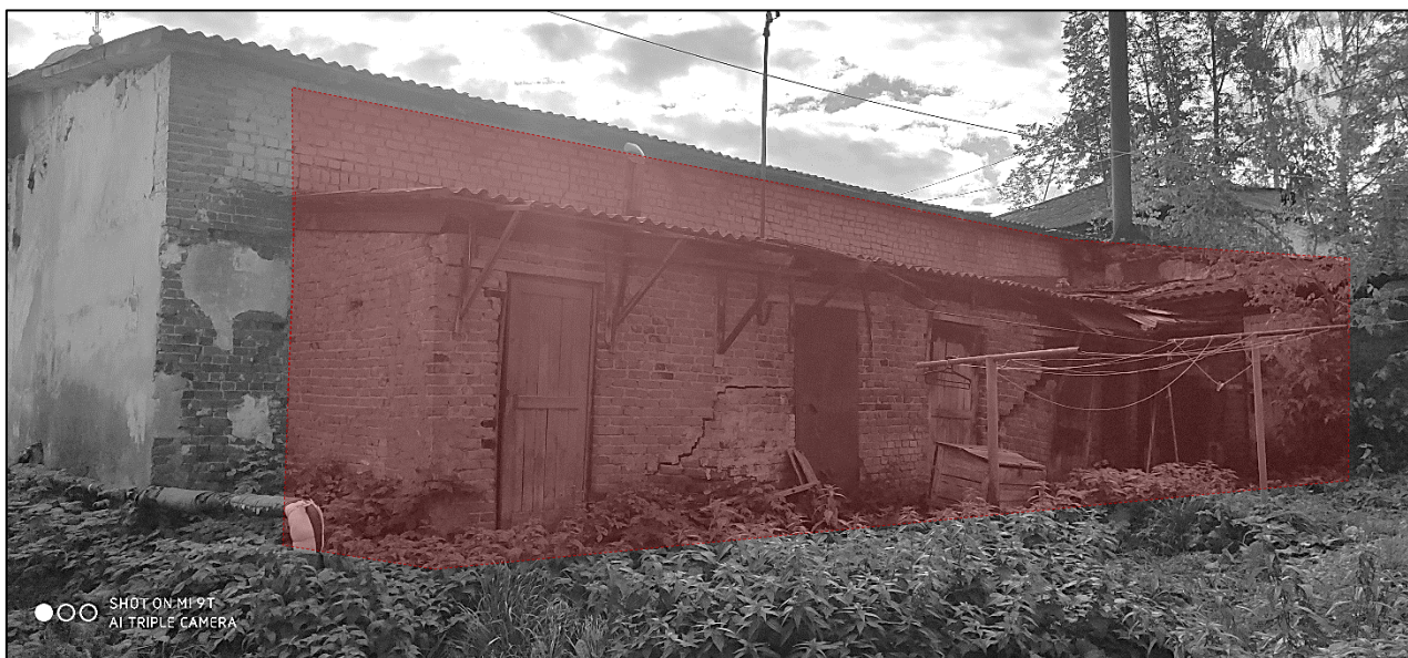
Рис. 2 Кирпичные пристройки, подлежащие реконструкции
