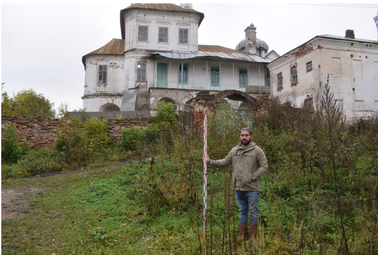
Рис. 10. Ивановская область, Лежневский район, п. Лежнево, газификация жилого дома по ул. Октябрьской, 4. Вид на Троице-Знаменскую церковь с северо-северо-запада, от газифицируемого дома № 4 по ул. Октябрьской.
