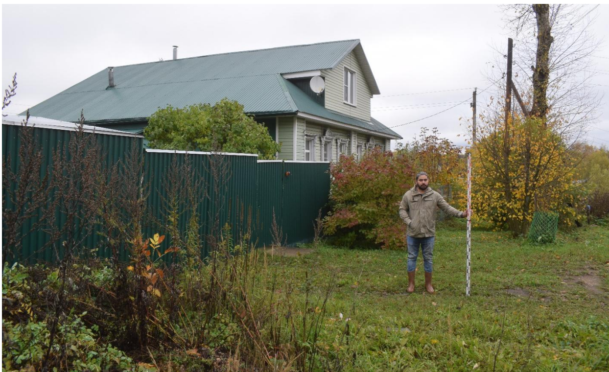
Рис. 9. Ивановская область, Лежневский район, пос. Лежнево, газификация жилого дома по ул. Октябрьской, 4. Общий вид с юга.
