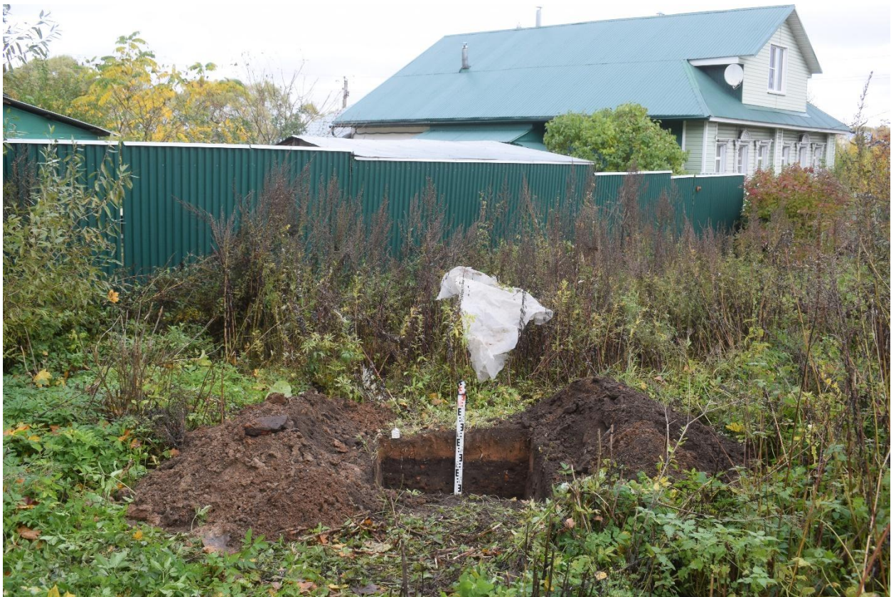
Рис. 13. Ивановская область, Лежневский район, пос. Лежнево, газификация жилого дома по ул. Октябрьской, 4. Общий вид с юга выкопанного шурфа.
