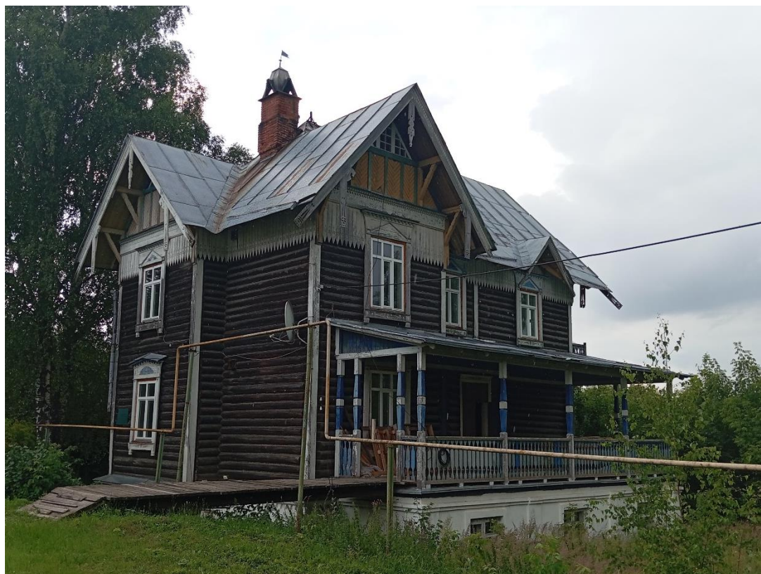
Фото 1. Общий вид здания
