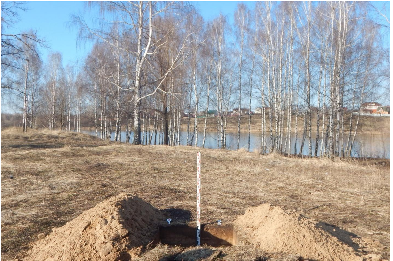
Рис. 18. Иваново, мкр. «Видный», улично-дорожная сеть. Общий вид выкопанного шурфа № 2 с юга.
