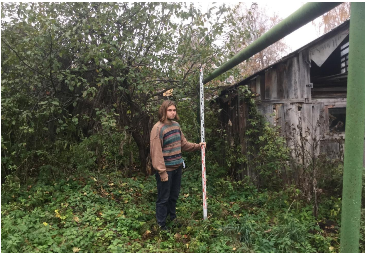
Рис. 13. Ивановская обл., г. Плѣс, ул. Советская, 71. Общий вид с востока обследованного участка.
