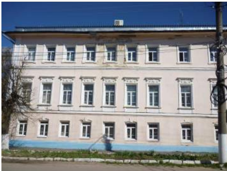
3. Жилой дом. Главный южный фасад
