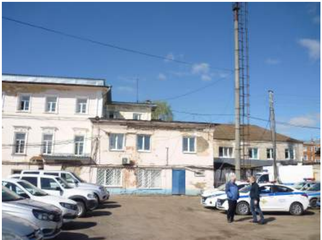
7. Жилой дом. Восточный фасад.
