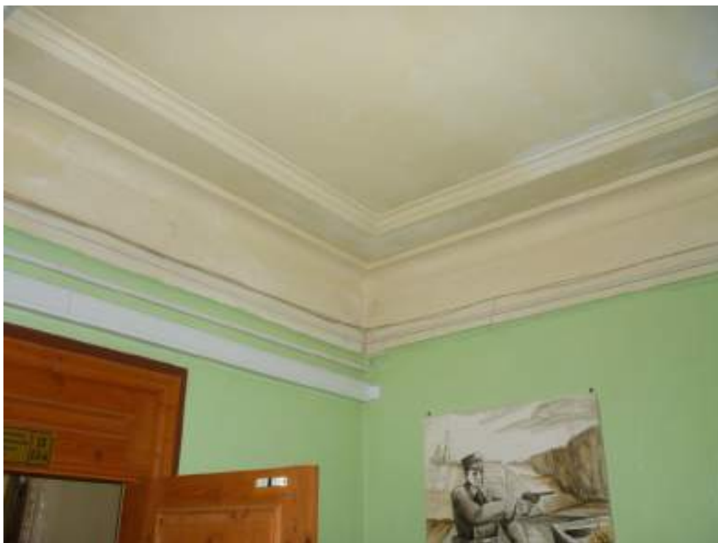
15. Жилой дом. Профилированные карнизы в помещении на 2-м этаже.
