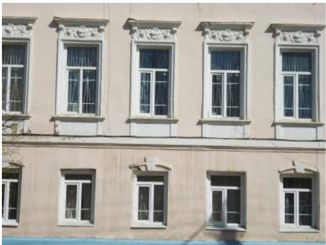
8. Жилой дом. Фрагмент южного фасада
