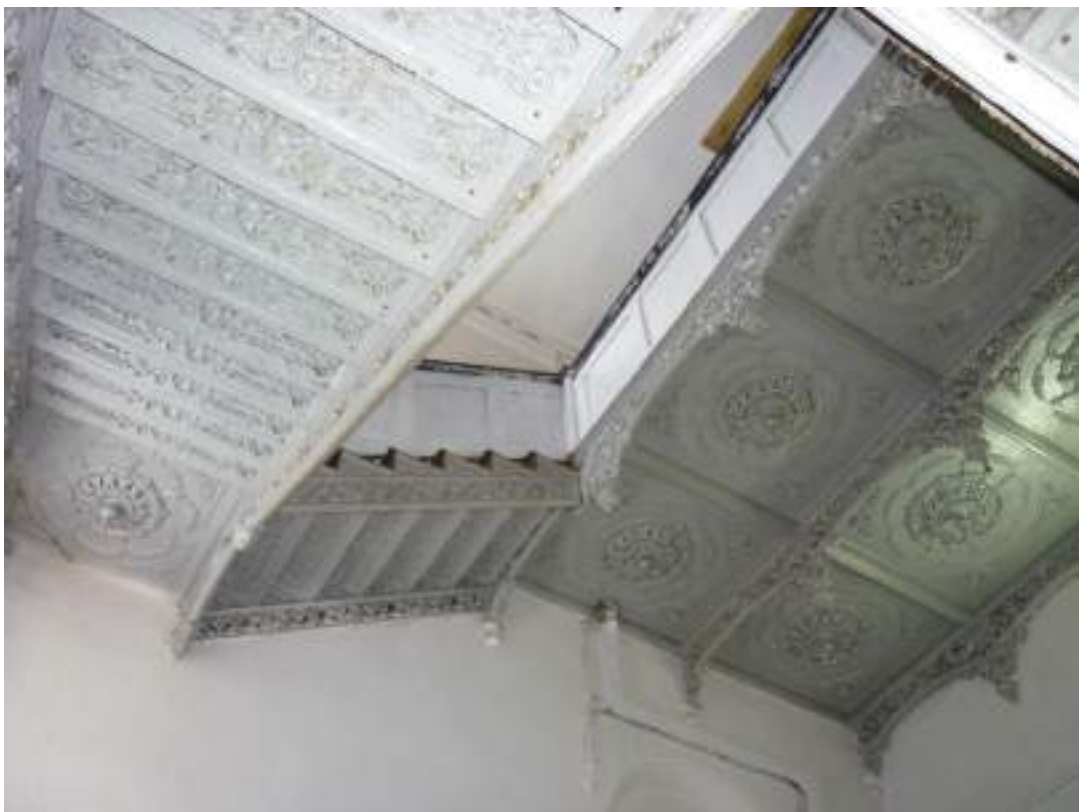
10. Жилой дом. Междуэтажная лестница. Вид снизу
