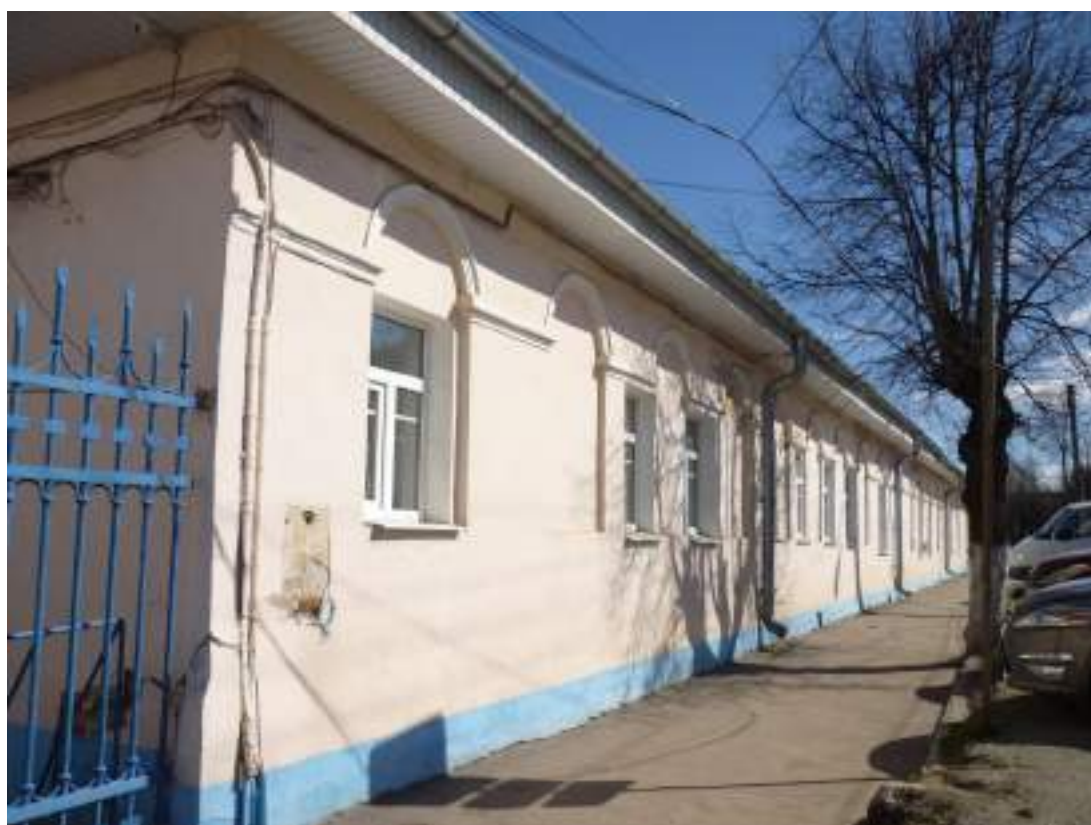
20. Служебный корпус. Уличный фасад. Вид с юго-запада
