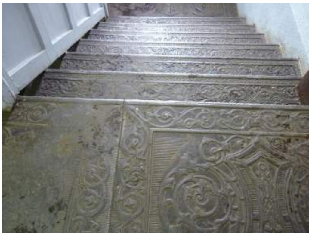
12. Жилой дом. Междуэтажная лестница. Вид сверху
