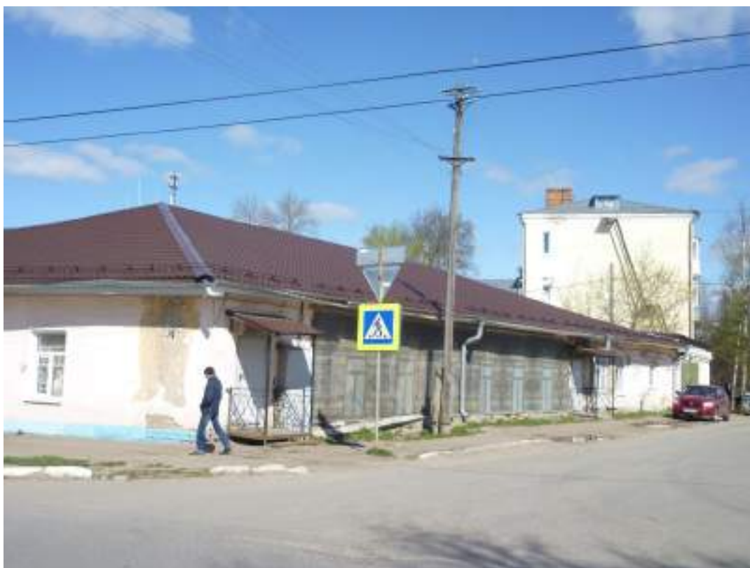
21. Служебный корпус. Уличный фасад. Вид с юго-востока
