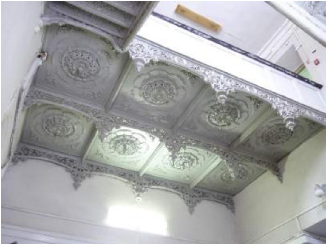
9. Жилой дом. Междуэтажная лестница. Вид снизу
