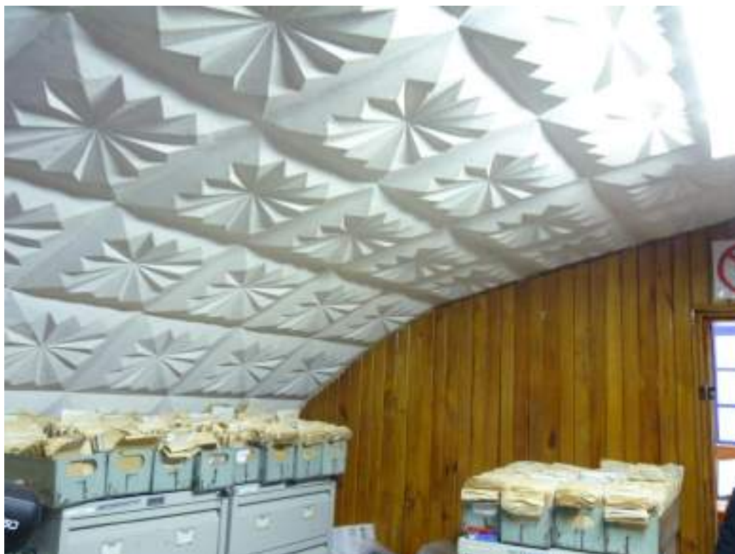
14. Жилой дом. Своды в северо-западном помещении на 1-м этаже.
