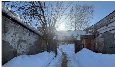
Ф.9. Объект капитального ремонта, 03.2026 г.
