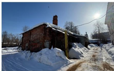
Ф.5. Объект капитального ремонта, 03.2026 г.
