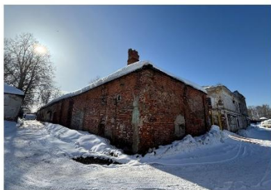
Ф.4. Объект капитального ремонта, 03.2026 г.
