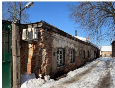
Ф.2. Объект капитального ремонта, 03.2026 г.
