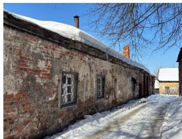
Ф.3. Объект капитального ремонта, 03.2026 г.
