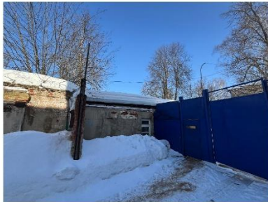
Ф.10. Объект капитального ремонта, 03.2026 г.
