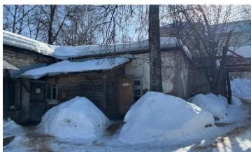
Ф.8. Объект капитального ремонта, 03.2026 г.
