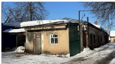
Ф.1. Объект капитального ремонта, 03.2026 г.
