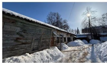
Ф.6. Объект капитального ремонта, 03.2026 г.
