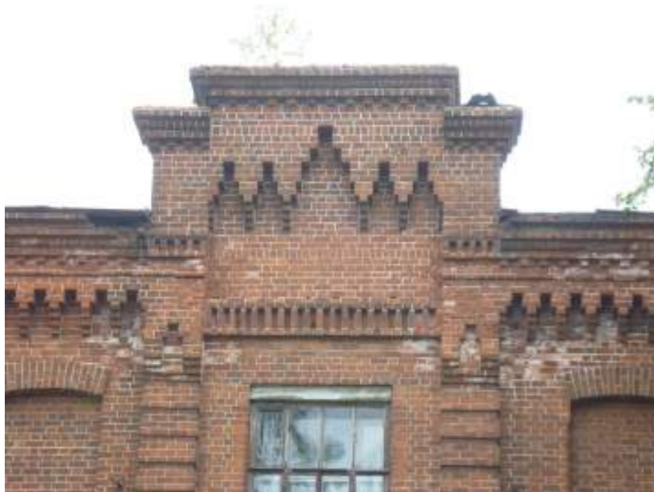
5. Фрагмент бокового фасада.
