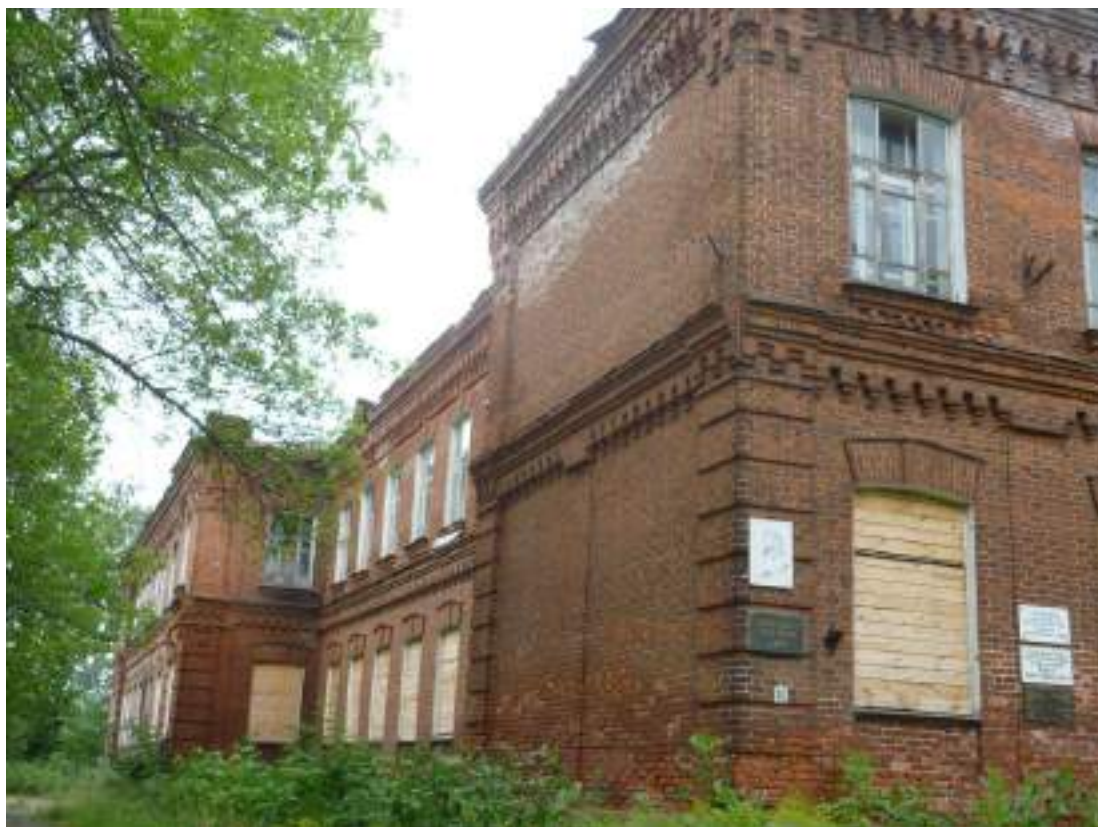
15. Вид с северо-запада
