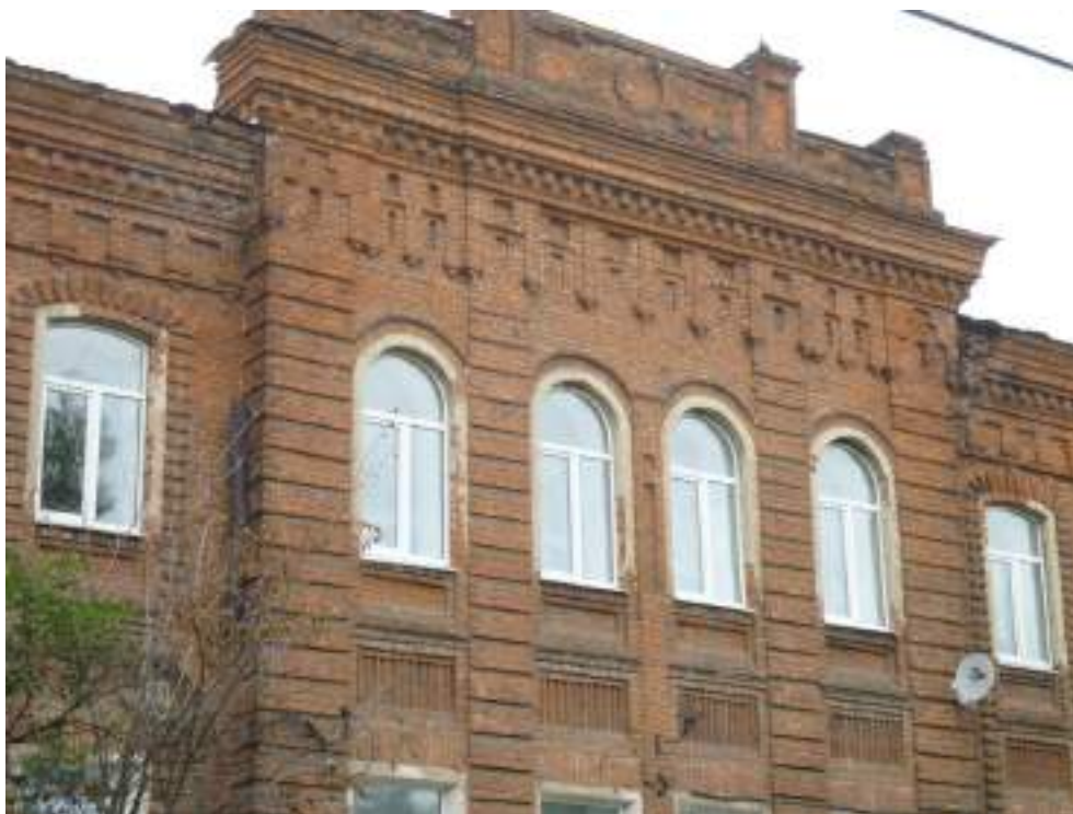
6. Фрагмент главного фасада.
