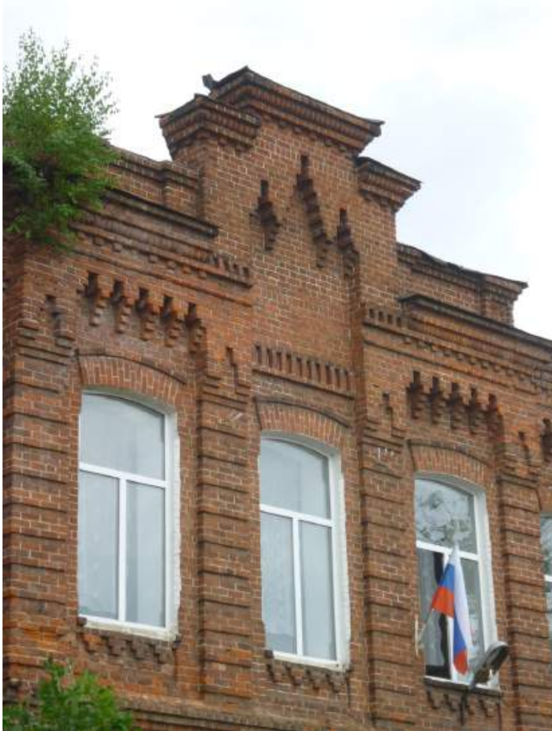
3. Фрагмент главного фасада
