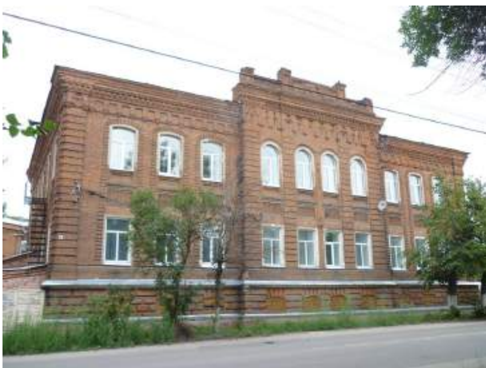
7. Главный фасад. Вид с востока
