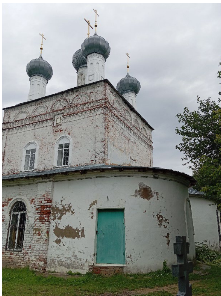
Фото 5. Вид на основной четверик храма с юго-востока.
