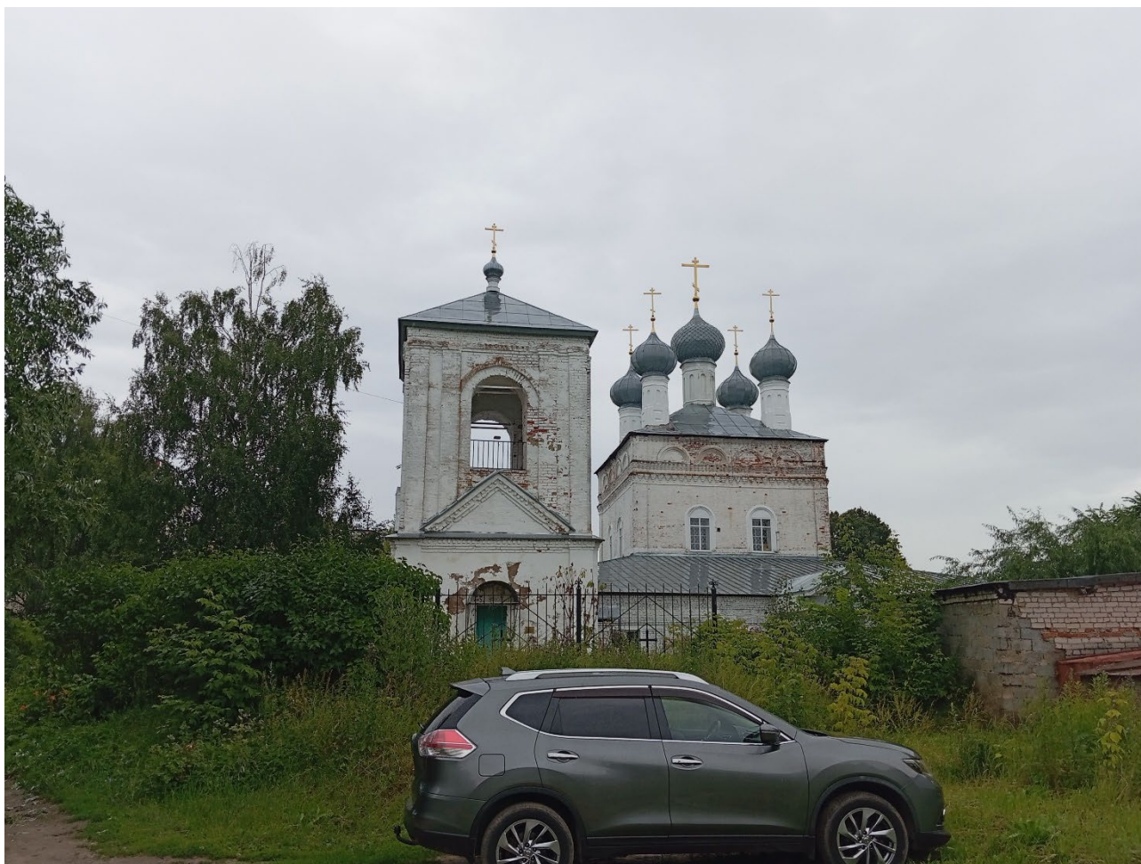
Фото 1. Церковь Сретения. Вид с запада.
