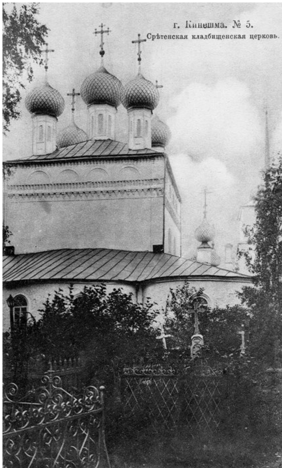
Фото 11. Фотография церкви начала XX века. Источник – интернет. Виден снесенный 3-й ярус колокольни, шпиль. Декор храма в основном сохранился.
