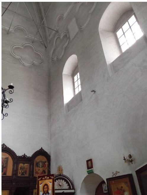
Фото 9. Стены основного четверика.
