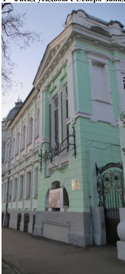
Фотография 2 – Фасад усадьбы с Северо-Восточной стороны
